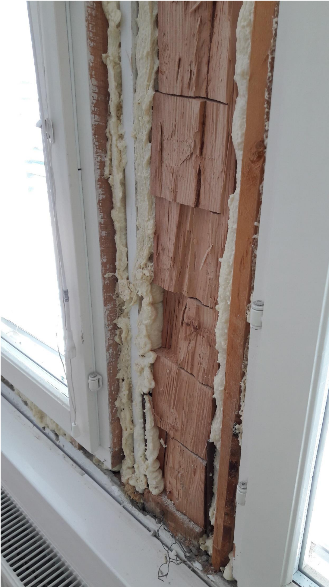
Kolotut pilarikannattajat vaihdettiin rakennesuunnittelijan ohjeiden mukaan.
