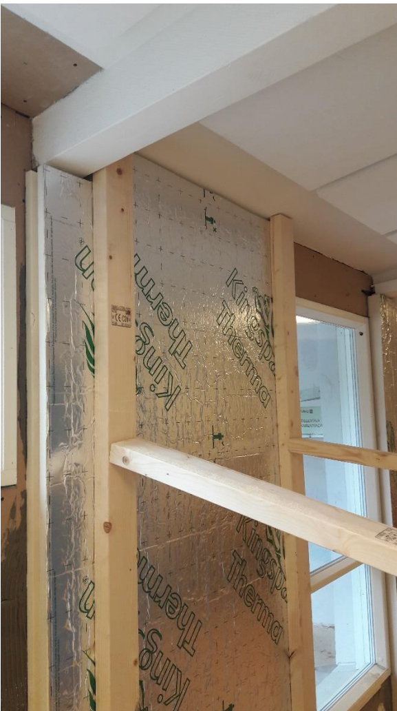
Uretaanilevyjen paikalle laittaa.
