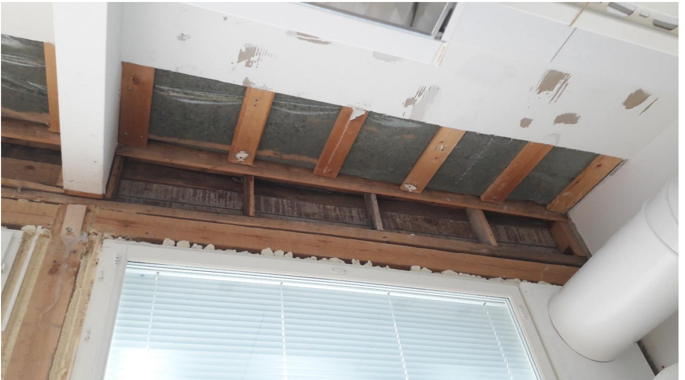
Luokkahuoneen ikkunan yläpuolinen seinä. Käytetty vanhaa muottilautaa rakenteena. Rakenne uusittiin.
