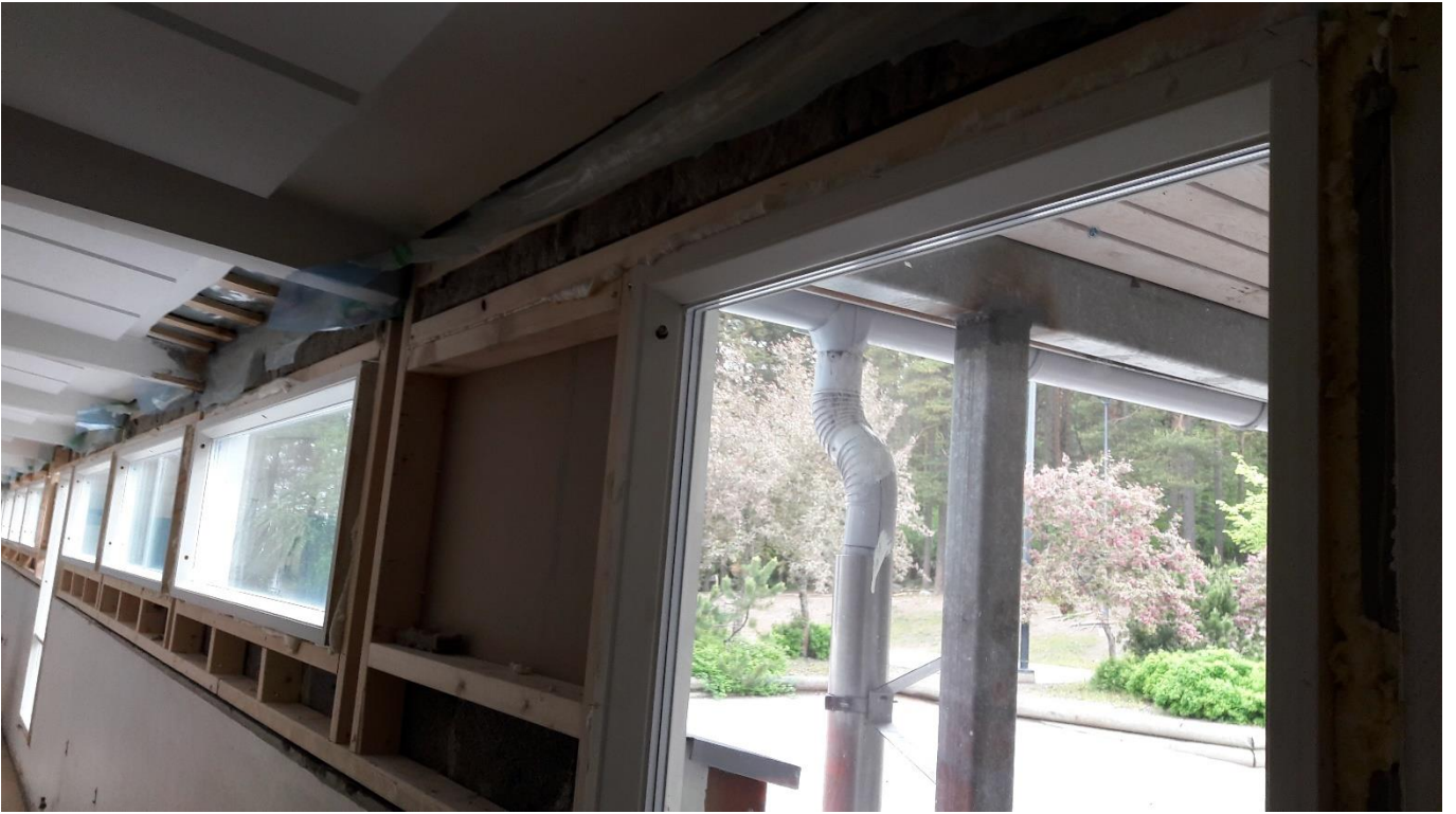
Käytäväseinän uusi runkorakenne.
