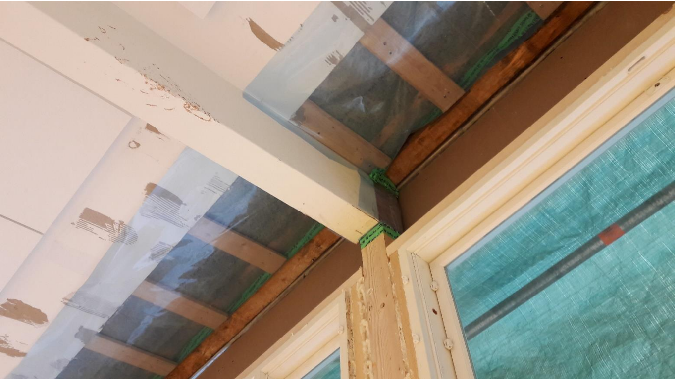
Luokkahuoneen ikkunan yläpuolinen seinä; höyrynsulku kannattajan ympäriltä sekä uusi levyrakenne.
