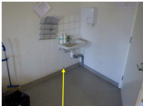
Materiaalinäytteen M-3 ottokohta.
