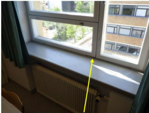
Materiaalinäytteen M-4 ottokohta.
