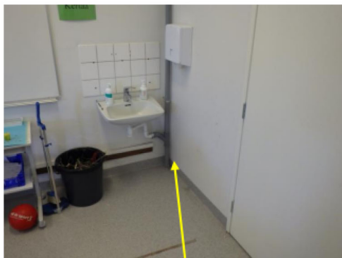
Materiaalinäytteen M-7 ottokohta.
