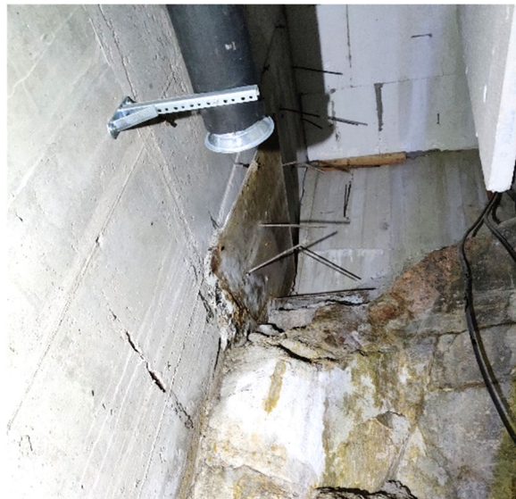
Kuva 5.19. Kallion ja kellarin sekä 1 kerroksen seinän välissä on tyhjää tilaa, jonka ilma on tunkkainen. Tilaan pääse sadevesiä kallion pintaa pitkin. Tilassa on paikoin kosteusvaurioitunutta orgaanista materiaalia. Tilaan on asennettu koneellinen tuuletus.
