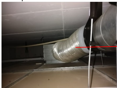
Kuva 6.5. Tilassa 4115 tuloilmakanava on toteutettu osittain taipuisasta alumiiniputkesta (nuoli), joka estää kanavan nuohouksen. Kanavan sisäpinnalla on pölykertymää.
