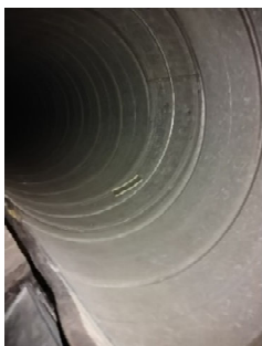
Kuva 6.3. TK101 1 kerroksen runkokanava, joka on aistinvaraisesti puhdas. Kuvassa näkyy kanavan teippinäyte KK10, jossa ei todettu poikkeavia määriä mineraalikuituja.
