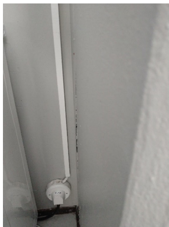
Kuva 5.7. Ulkoseinän pilariliittymien pellitykset ovat paikoin irronneet.
