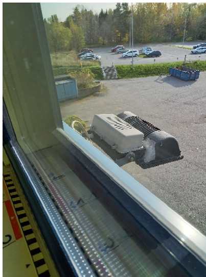
Kuva 5.10. Tilan 2118 ulkoseinässä on pihavalaisin (vasen kuva). Valaisimen sähköjohdon läpivienti sisätiloihin ei ole tiivis, mikä on havaittavissa merkkisavulla (oikea kuva).
