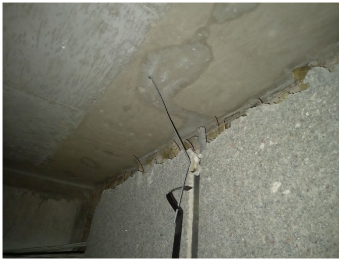
Kuva 5.16. Käytävän 2103 osalla väliseinänä on vanha ulkoseinä, jossa on mineraalivillaeriste. Eristeestä otetussa materiaalinäytteessä ei todettu poikkeavaa mikrobikasvua. Eristetilasta voi kulkeutua mineraalikuituja sisäilmaan.
