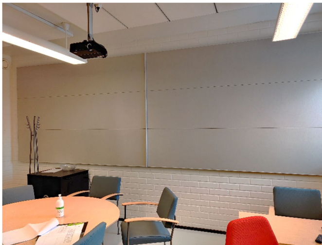
Kuva 6.16. Tilassa 4123 olevista seinän akustiikkalevyistä vapautuu pistävää hajua. Myös tilassa 2114 on samanlaisia levyjä.
