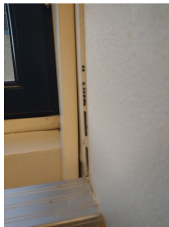
Kuva 5.7. Ulkoseinän pilariliittymien pellitykset ovat paikoin irronneet.
