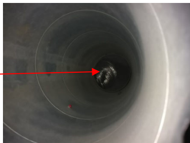
Kuva 6.5. Tilassa 4115 tuloilmakanava on toteutettu osittain taipuisasta alumiiniputkesta (nuoli), joka estää kanavan nuohouksen. Kanavan sisäpinnalla on pölykertymää.
