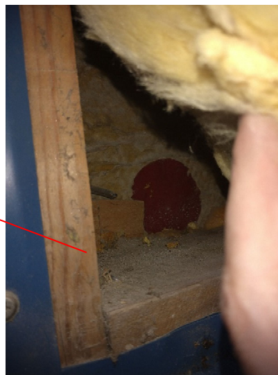
Kuva 5.2. Liikuntasalisiiven ikkunanauhojen umpiosien lämmöneristeitä ei ole uusittu XPS-levyiksi. Rakenteessa ei myöskään havaittu höyrönsulkumuovia.
