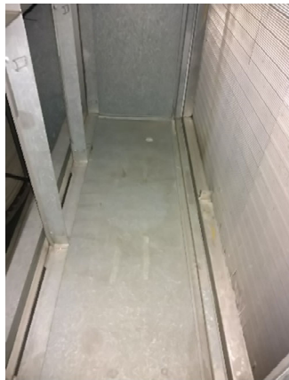
Kuva 6.1. TK101 lämmityspatteri. Koneissa ei havaittu aistinvaraisesti merkittävästi likaa.
