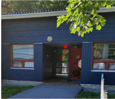
Kuva 4.3. Tuulikaapin 126 ulkoseinä on katoksen yläpuolella olevaa ullakotilaa vasten
