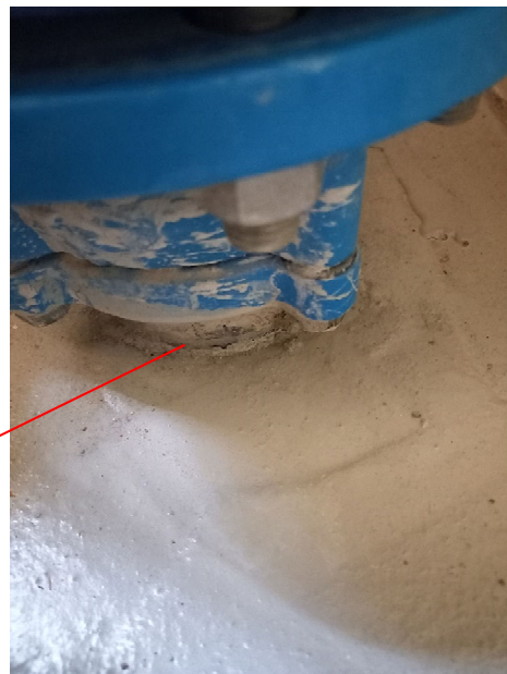
Kuva 4.2 Tuulikaapin 157 vieressä olevaan tekniseen tilaan kulkeutui merkkiainetta vesipostin läpiviennistä (punainen ympyrä). Lattia on pinnoitettu epoksilla, vesijohdon läpivienti on kuitenkin tiivistämättä.
