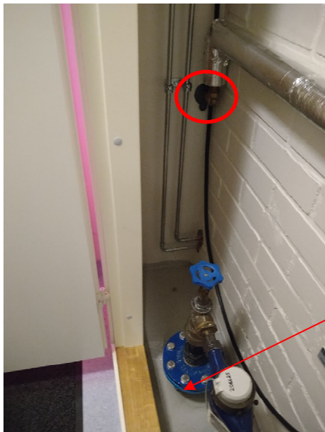
Kuva 4.2 Tuulikaapin 157 vieressä olevaan tekniseen tilaan kulkeutui merkkiainetta vesipostin läpiviennistä (punainen ympyrä). Lattia on pinnoitettu epoksilla, vesijohdon läpivienti on kuitenkin tiivistämättä.
