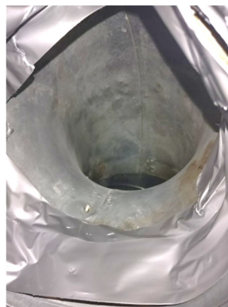
Kuva 5.5. Tilan 104 päätelaitteen sisällä on ilmastointiteippiä, joka kerää pölyä ja voi vaikuttaa ilmavirtaukseen.
