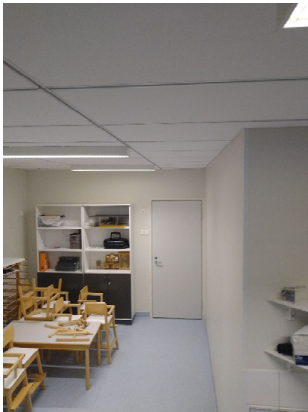
Kuva 5.6. Rakennuksen sisäpinnoilla ei ole selkeitä kuitulähteitä. Akustiikkalevyt ovat kauttaaltaan pinnoitettuja ja ehjiä.
