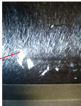
Kuva 5.2. Tuloilmakoneen äänenvaimentimien pinnalla on paikoin irtonaista mineraalivillaa.
