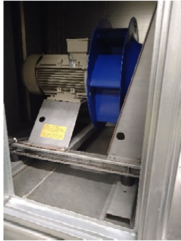
Kuva 5.1. Tuloilmakone oli astinvaraisesti arvioiden puhtas.
