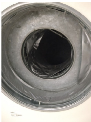
Kuva 5.5. Tilan 104 päätelaitteen sisällä on ilmastointiteippiä, joka kerää pölyä ja voi vaikuttaa ilmavirtaukseen.
