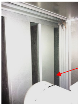
Kuva 5.2. Tuloilmakoneen äänenvaimentimien pinnalla on paikoin irtonaista mineraalivillaa.
