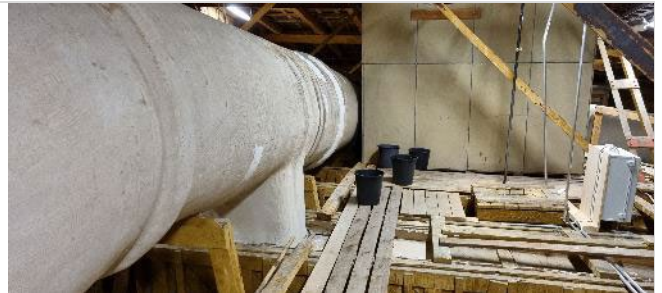
Kuva 98. ...ja osa on asbestieristeisiä.
