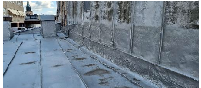
Kuva 108. Pinnoitusta on tehty myös rakennuksen pohjoisnurkassa orkesterilämpöön päällä.
