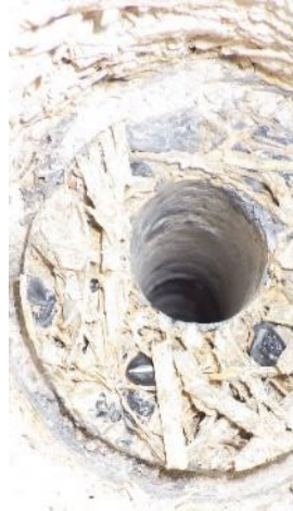
Kuva 57. Kahvion putkikanaalin kohdalla alapohjarakenteessa on avauksen R3 perusteella lastuvillaeriste.
