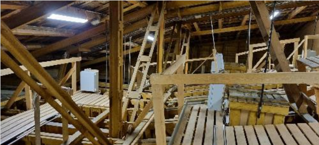
Kuva 95. Kupolin korkeassa ullakkotilassa yläpohjan puu- ja teräsrakenteet olivat aistinvaraisesti arvioituna pääosin hyväkuntoiset.
