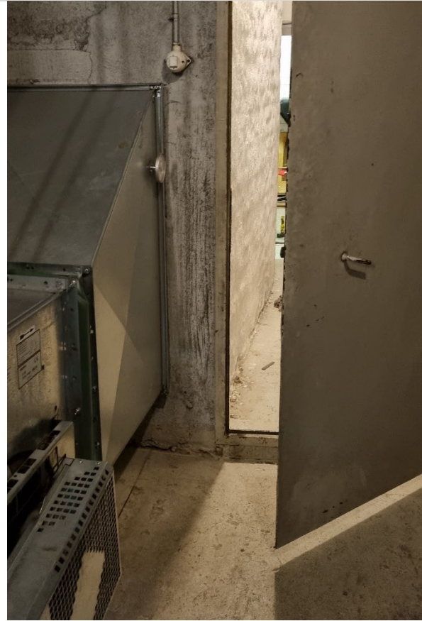
Kuva 135. ...edelleen rakennusaineiseen runkokanavaan.
