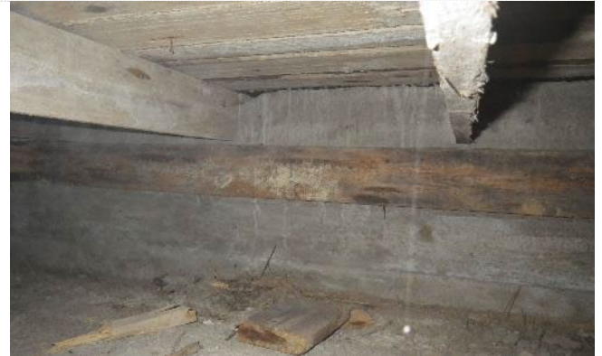
Kuva 62. Alapohjan alalaattapalkiston onteloon on jätetty muottilaudoitusta paikoilleen.
