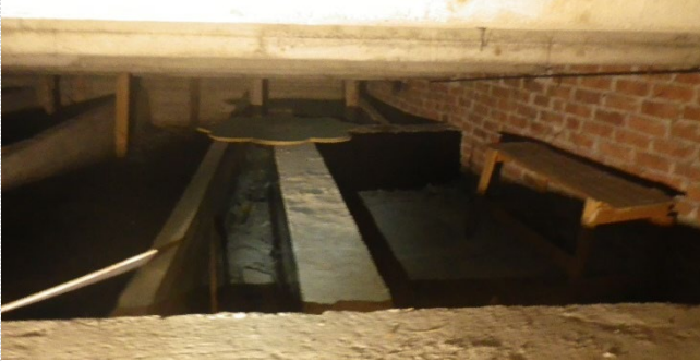
Kuva 68. Kellarin ja 1. kerroksen välinen välipohjarakenne varastosta 148 todettuna.
