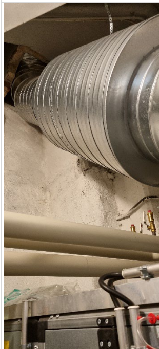
Kuva 129. Koneen TK3 runkokanavassa olevan äänenvaimentimen mineraalivilla on suojattu reikäpellillä ja mahdollisesti kankaalla.
