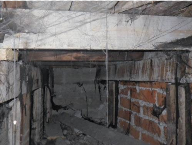
Kuva 70. Ulkoseinään oikeasta reunastaan ulottuva välipohjaontelo muottilaudoituksineen.
