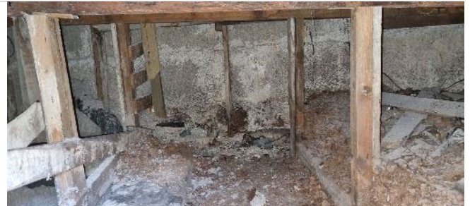
Kuva 102. Yläpohjatilan eristeenä mm. puhallusvillaa ja lastuvillalevyä (pystypinta taka-alalla) ja..
