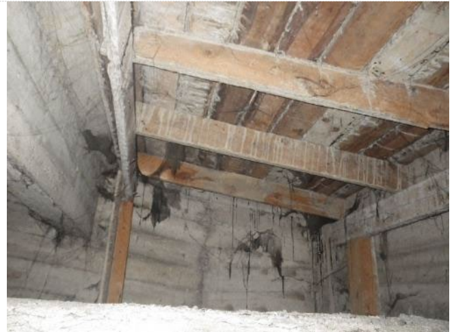
Kuva 71. Aulasta kävelyhalliin johtavan luiskan rakenne (ylälaattapalkisto).
