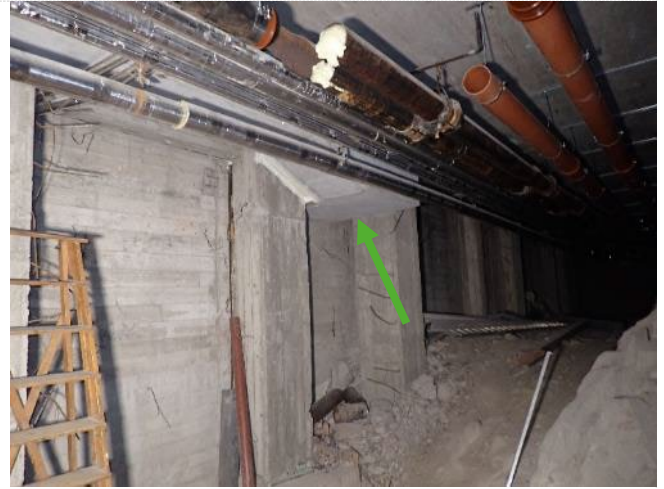
Kuva 24. Koillisseinällä kanaali kääntyy lähtötiedoista poiketen seinän läpi TAI:n tiloihin.
