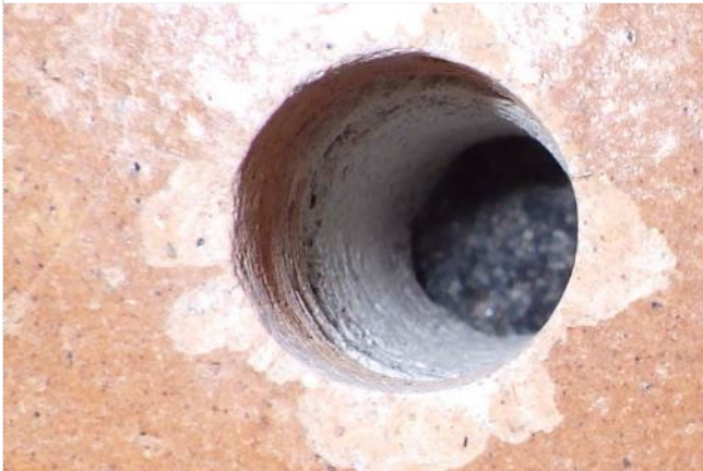
Kuva 64. Rakenneavaus R6 lipunmyynnin alapohjaan.
