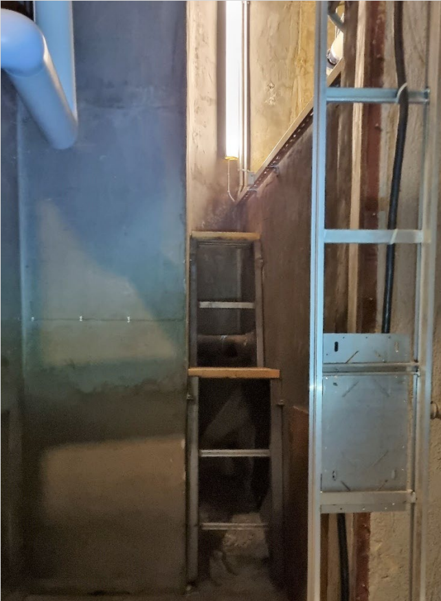
Kuva 134. Kostutinkammioista palautusilmaa sisältävä tuloilma johdetaan puhallinkammioon ja...
