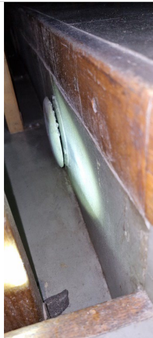
Kuva 123. Tuloilmaa jaetaan salissa katon lisäksi myös penkkien alta.
