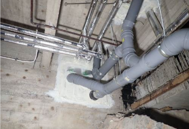
Kuva 27. Yleisö-wc:n kohdalla alapohjarakenteena (sulkutilan katto) on ylälaattapalkkisto, kuvassa oikealla studion alapohjarakenteita.
