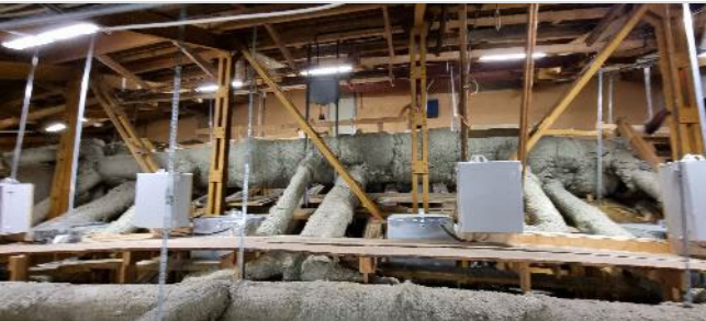
Kuva 97. Ullakkotilassa kulkee runsaasti ilmanvaihtokanavia, joista osa on eristetty päällystämättömällä mineraalivillalla,...
