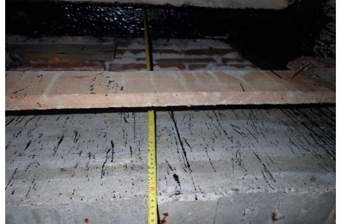
Kuva 28. Studion alapohjan alalaattapalkkisto sekä seinän alaosa.
