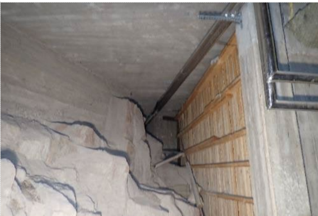
Kuva 25. Hissin "takana" kalliopinta nousee nopeasti. Hissien perustusten muottilaudoitus on jätetty sulkutilaan.
