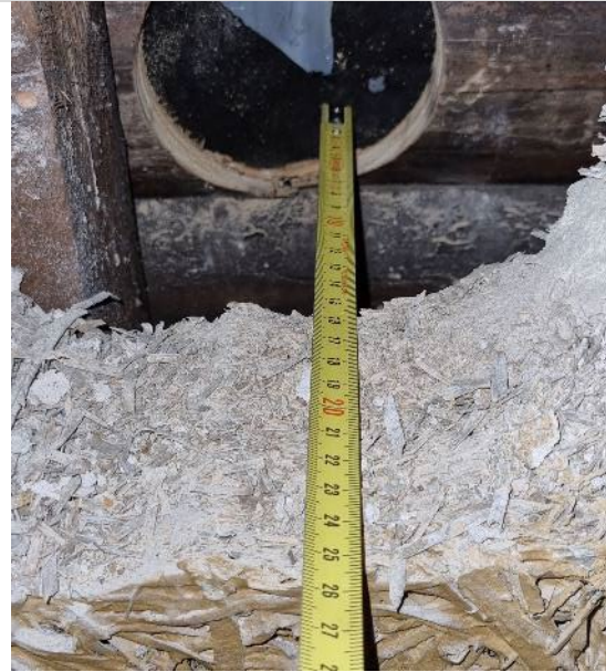
Kuva 100. Lastuvillalevyn ulkopinnassa on ilmarako, laudoitus ja vesikatteen alumiini.
