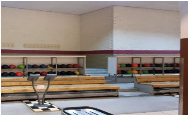
Kuva 76. Kellarin keilahallin ulkoseinät ovat pääosin sisäpuolelta tiiliverhoillut.
