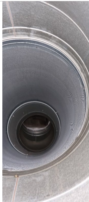
Kuva 129. Koneen TK3 runkokanavassa olevan äänenvaimentimen mineraalivilla on suojattu reikäpellillä ja mahdollisesti kankaalla.
