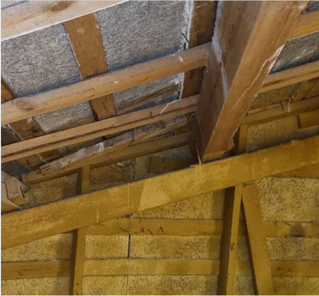
Kuva 99. Kupoliosassa on sisäpuolisena lämmöneristeenä lastuvillalevy.
