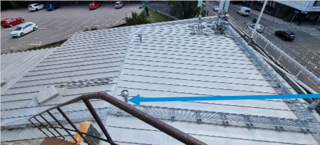
Kuva 105. Lounaanpuoleisella lappeella vesikate on pinnoitettu.
