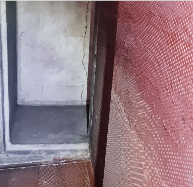
Kuva 136. Myös tuloilman runkokanavan sisäpintana on mineraalivilla, joka on peitetty...
