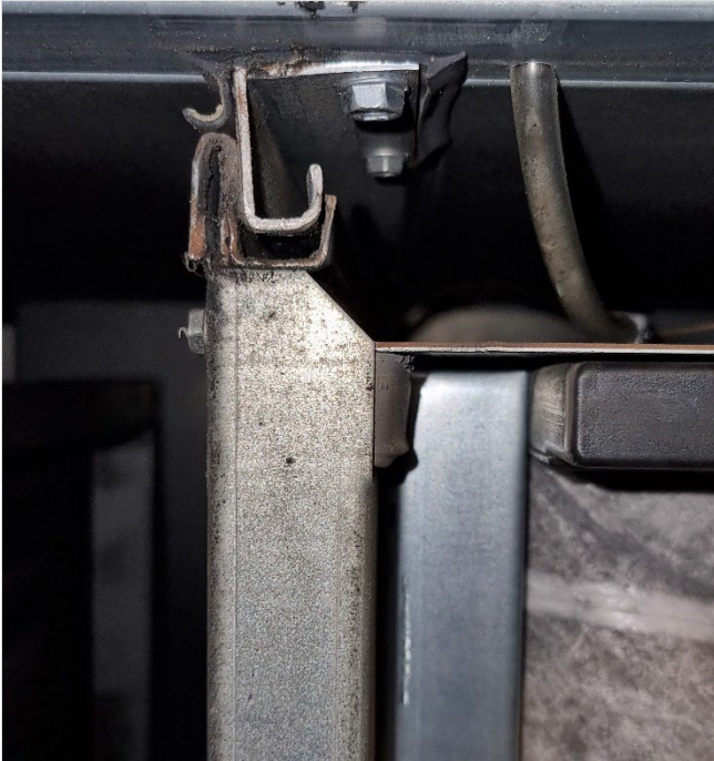
Kuva 127. Koneiden TK1 (kuvassa) ja TK3 suodattimet asennuvat tiiviisti.
