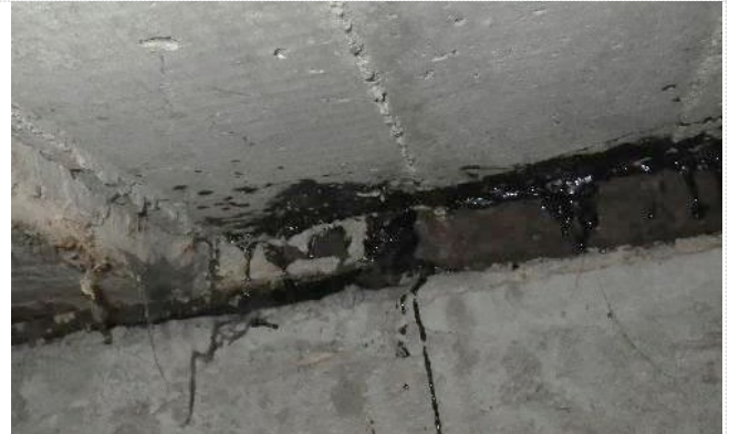
Kuva 73. Pikisivelty korkki palkin ja pintalaatan välissä.
