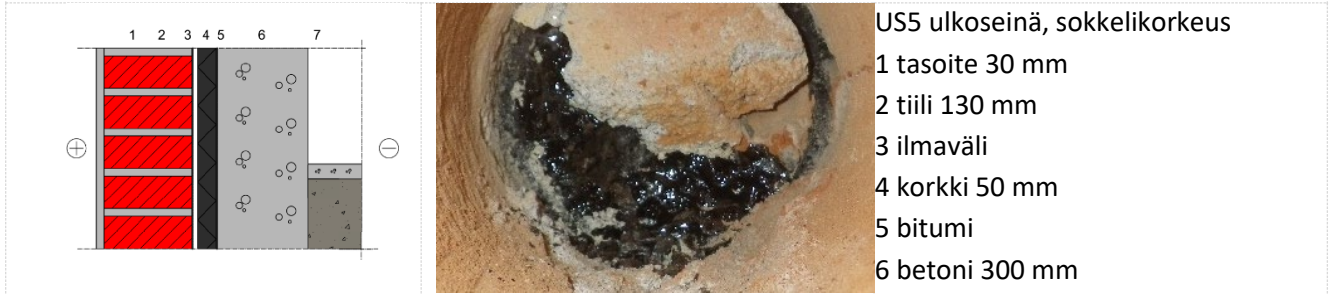
Kuva 83. Sokkelikorkeudella ulkoseinärakenteen lämmöneristeenä on koko rakennuksen alueella korkki.
