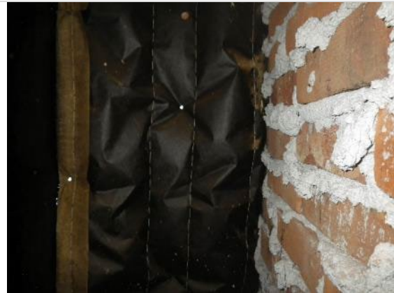
Kuva 94. ...joissa oli tervapaperipinta.
