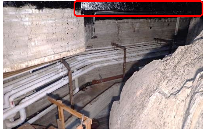
Kuva 34. Sulkutilaa keilahallin luoteispuolelta. Tilassa kulkee runsaasti vanhoja asbestieristeisiä putkia. Punaisella on korostettu 1. kerroksen tilojen 142 ja 127 välinen tasoero.
