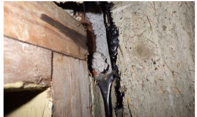
Kuva 77. Keilahallin ulkoseinän tiilimuurauksen takana on ilmarako (tässä kulkuluukun kohdalla täytetty laastilla), piki-sively ja betonimuuri.
