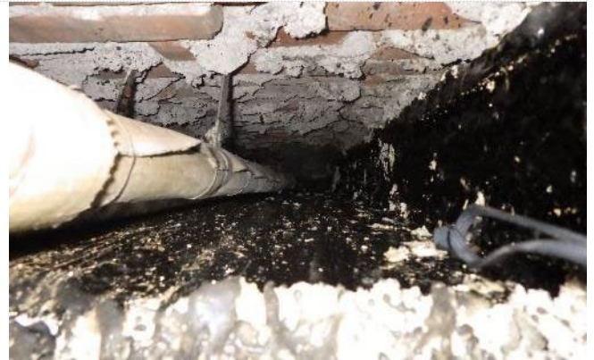
Kuva 40. Seinärakenteen sisällä kulkeva putkikuilu.
