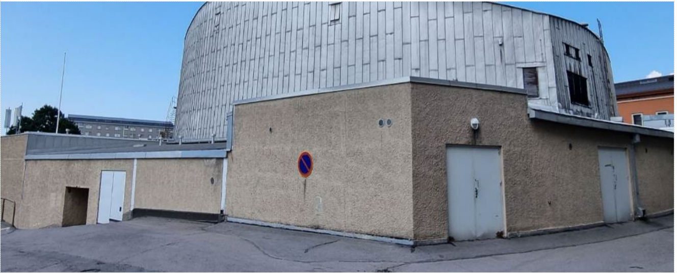
Kuva 4. Sisäpihan puolella maan pinta nousee siten, että osa 2. kerroksen tiloista jää pihakannen alle. Pihakannen päälle on 1997 laajennuksena rakennettu kuvassa etualalla oleva matala varastotila.
