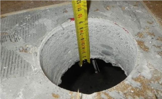
Kuva 61. Rakenneavaus R7 studion 108 alapohjaan sulkutilan päällä.
