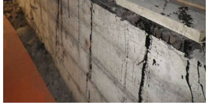
Kuva 69. Alalaattapalkiston palkkien päällä on pikisiveltä korkkia.
