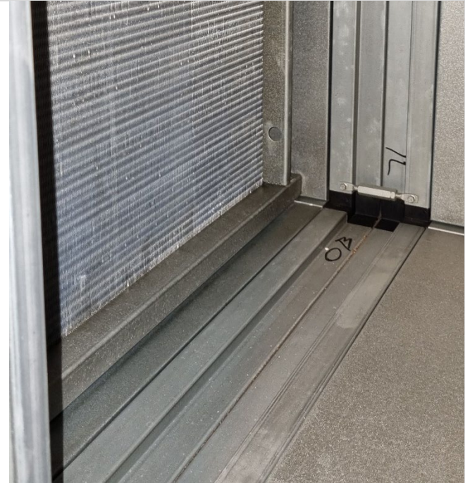
Kuva 128. Koneet TK1 ja TK3 ovat aistinvaraisesti hyväkuntoiset ja puhtaat.
