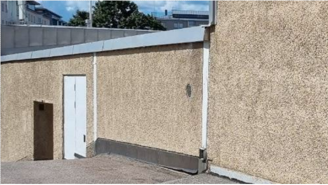
Kuva 16. Sisäpihan puolella kattovedet johdetaan seinustalle ulkoseinään upotetuin syöksyin.
