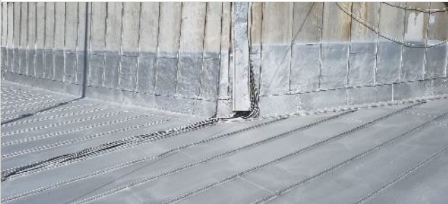
Kuva 107. Pinnoite on nostettu kupolin pystyseinälle.
