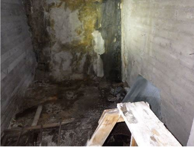
Kuva 43. Keilahallin kabinetin K9 päädyssä oleva, märkään kalliolouhokseen rajoittuva sulkutila.
