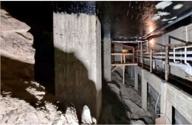
Kuva 33. Kellarin luoteispuolella on korkea sulkutila. Kattona on tilojen 142, 127 ja 125 alapohjan pikisivelty alalaattapalkisto.
