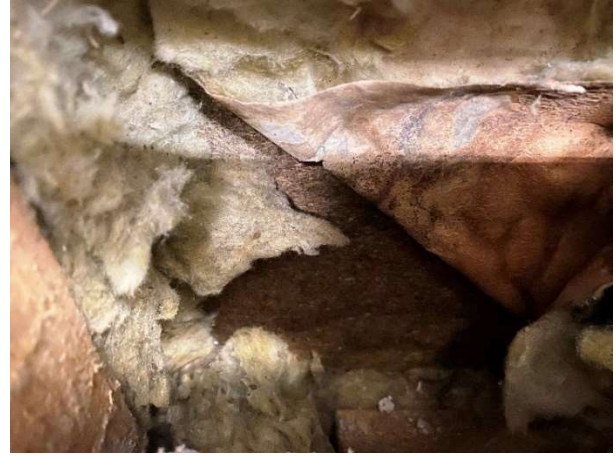
Kuva 12. Paperipintaisen villaeristeen paperissa on kosteusjälkiä (RA.01).
