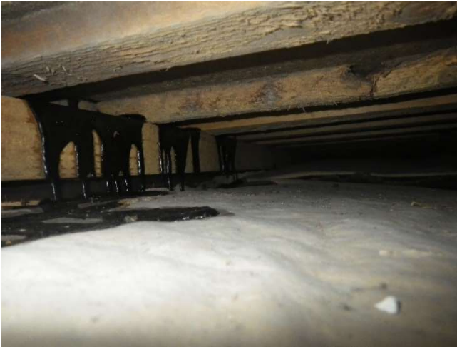
Kuva 22. Yläpohjan tuuletusrakoa RA.04.
