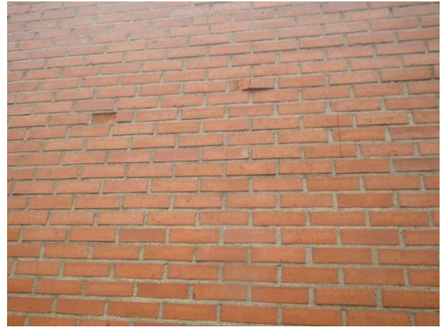
Kuva 9. Pakkasrapautumaa tiilijulkisivussa.
