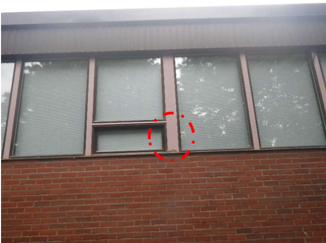
Kuva 6. Ikkunoiden väliosaan tehdyn rakenneavauksen paikka.
