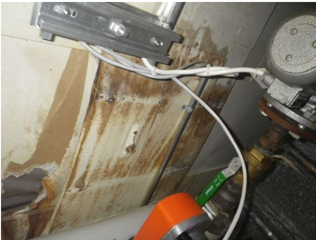
Kuva 24. Vuotojälkiä sisäkatossa.
