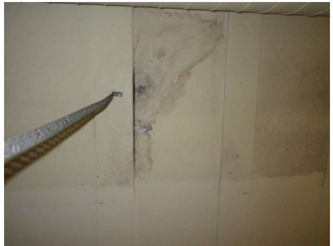
Kuva 25. Vuotojälkiä sisäkatossa.
