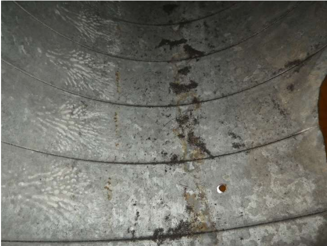
Kuva 32. Irtolikaa tuloilmakanavassa.
