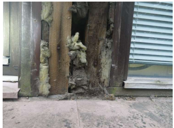
Kuva 7. Rakenneavaus ikkunoiden väliosaan.
