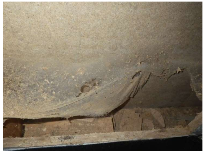
Kuva 18. Väliseinään tehty rakennusavaus (RA.09).
