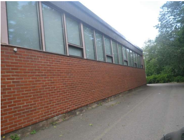
Kuva 1. Rakennuksen etupuolella ja sivustalla on asfaltti.
