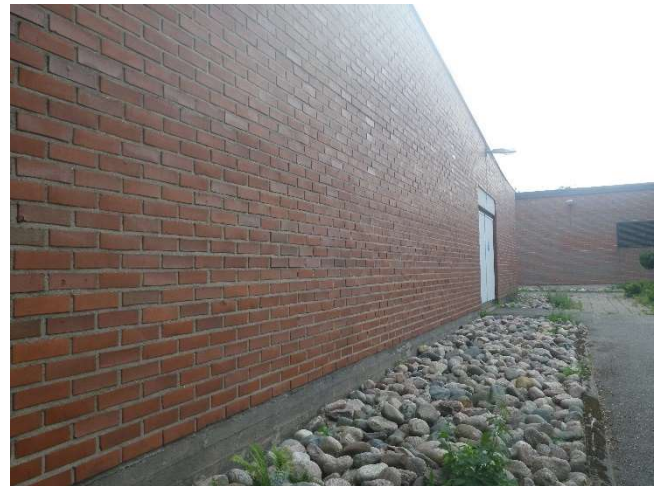
Kuva 2. Rakennuksen takasivuilla on heittokivi.
