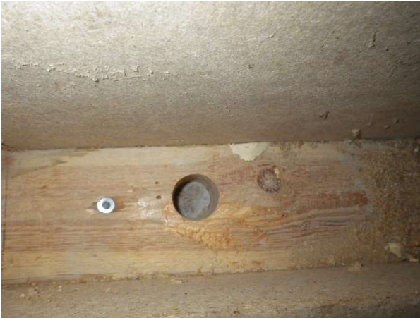
Kuva 19. Alaohjauspuun alapinta on noin 50 mm lattiapinnan alapuolella.
