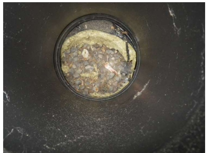
Kuva 27. Vesikaton uusi tuuletuskanava villakerrokseen. Pohjalla näkyy vanhan vesikatteen singeliä.
