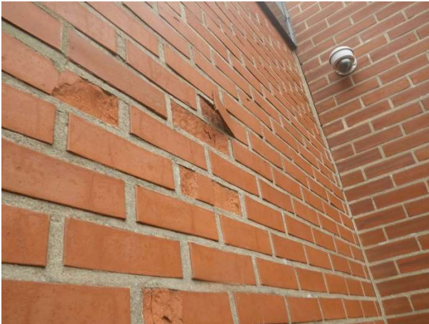
Kuva 8. Pakkasrapautumaa tiilijulkisivussa.
