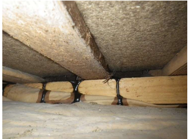
Kuva 23. Yläpohjan tuuletusrakoa RA.04.
