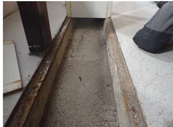
Kuva 15. Kannen alla olevissa teräsrakenteissa on korrosiovaurioita, mutta muita merkittäviä poikkeamia ei havaittu.
