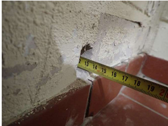
Kuva 98. Rakenneavaus VS1 tehtiin varastotilan 115 ja toisella puolella olevan märkätilan väliseen seinään.
