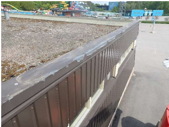
Kuva 136. Hattupeltien pinnoitteet ovat huonokuntoiset.
