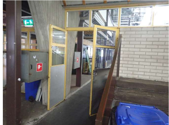
Kuva 94. Kahden jäähallin välissä on teräsrakenteiset ovet.
