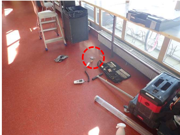
Kuva 28. Rakenneavaus AP1, kahvion edusta.
