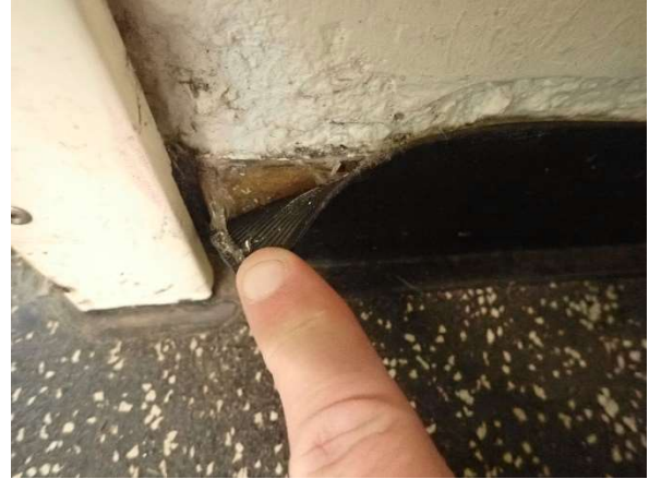
Kuva 37. Muoviset jalkalistat on liimattu, peitelistöjen ympärillä on massaukset ja lattiassa on paksu kumimatto.
