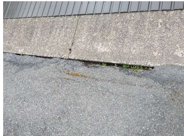
Kuva 176. Asfaltti on vaurioitunut useista kohdista, roskat ja epäpuhtaudet voivat kulkeutua ulkoseinän linjan alle.
