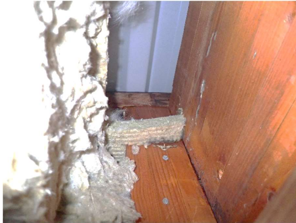
Kuva 154. Rakenneavaus YP1. Uuden vesikaton alle jätetty vanha profiilipelti kuvassa taustalla.
