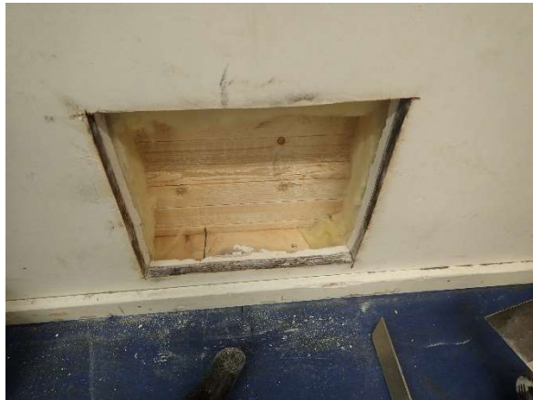
Kuva 106. Rakenneavaus VS3 tehtiin kuntosalin seinään.
