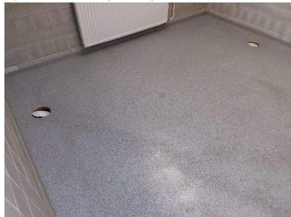
Kuva 21. Märkätilan lattiassa on yhtenäinen pinnote, joka toimii todennäköisesti myös tilan vedeneristeenä.
