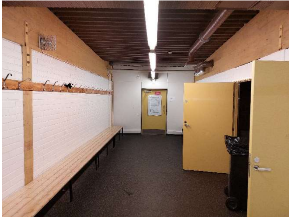
Kuva 87. Pukukopeissa on pääosin kalkkihiiekkatiiliseinät. Seinien yläosissa on liimapuupalkit.
