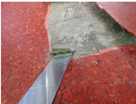
Kuva 29. Muovimaton alla oleva tasoite oli pehmeää ja hajosi käsiteltäessä.
