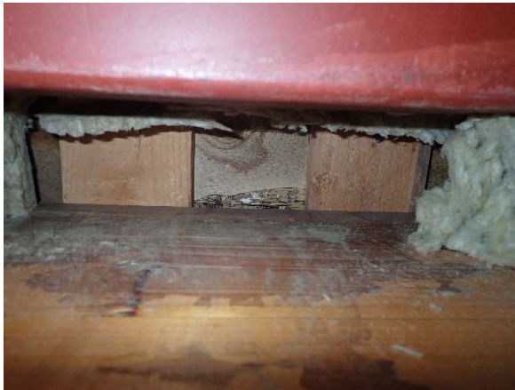
Kuva 162. Rakenneavaus YP3. Taustalla vesikatteen kumibitumikermin alla oleva vanerointi.
