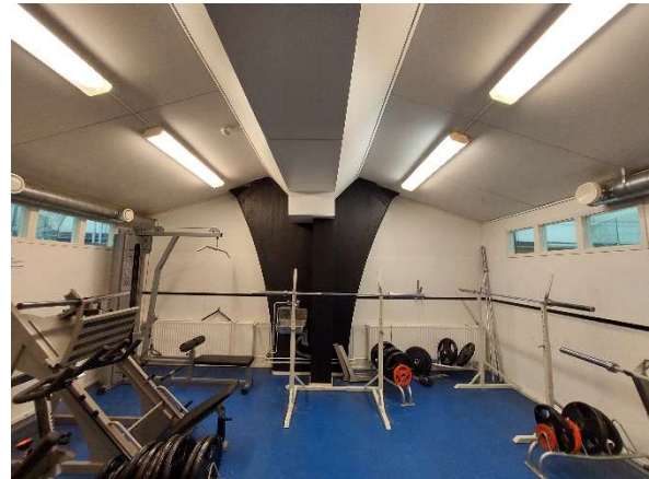
Kuva 90. Kuntosalilla on puurakenteiset seinät. Kuntosali on lämmin tila ja sijaitsee jäähallin puolella.
