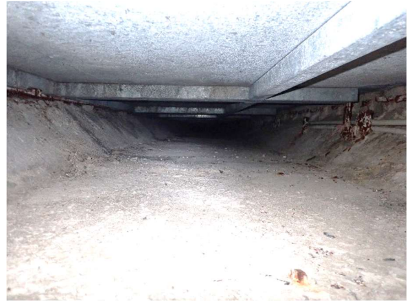
Kuva 13. Kourussa ei havaittu merkittäviä epäpuhtauksia.
