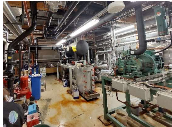
Kuva 27. Teknisen tilan alapohjassa on maali tai vastaava. Lattialla on laitteiston käyttöön liittyviä epäpuhtauksia.
