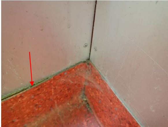
Kuva 18. Muovimaton seinälle nosto on irronnut.
