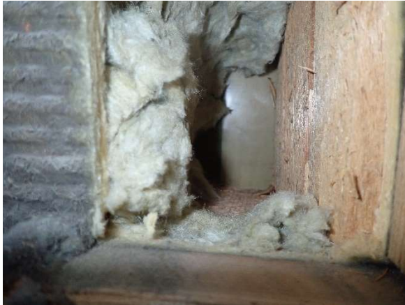
Kuva 76. Rakenneavaus US5. Kylmän ja lämpimän tilan välinen seinä.
