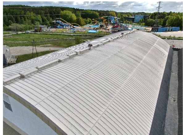
Kuva 125. Jäähallin vesikatto on rivipeltikate. Nykyisen rivipeltikatteen alla on vanha profiilikate. Katolle ei ole kulkua, katolla ei ole huoltosiltoja tai kiinnityspisteitä.
