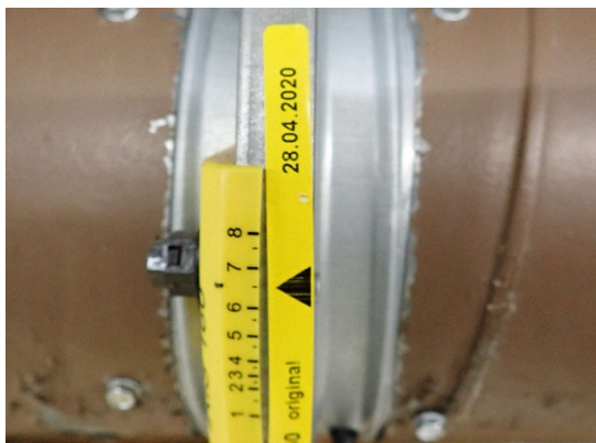
Kuva 192. Osaan ilmanvaihtokanavia on asennettu IRIS-säätöpellit 28.04.2020 jälkeen.
