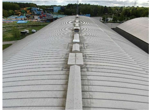
Kuva 127. Katolla on tuuletuskanavat ja savunpoistoluukut.
