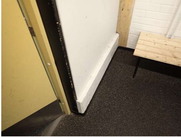
Kuva 79. Pukukopin puolella verhouksena oli vaneri.
