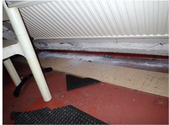
Kuva 19. Varastokoppien betonisissa perusrakenteissa havaittiin halkeilua, pinnoitteen irtoilua ja kohonneita pintakosteuslukemia. Kohonneita pintakosteuslukemia oli myös lattiassa varastojen viistojen ulkoseinien vierellä.
