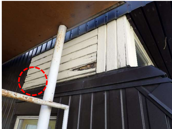
Kuva 80. Rakenneavaus US6. Avaus tehtiin puuverhotulle osuudelle.
