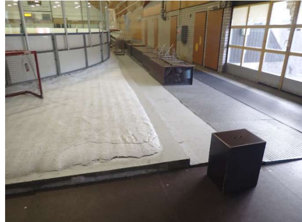
Kuva 7. Jäädetyt alueen ulkopuolella on huoltokäytäviä ja levyillä peitetyjä kouruja.
