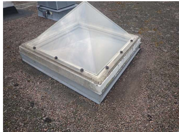
Kuva 143. Kattoikkunan kohdalla ei havaittu selkeää vauriota kumibitumikermissä.
