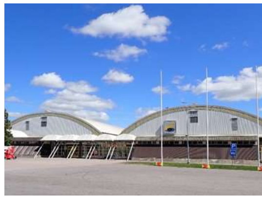
Kuva 191. Raitisilmanotto- ja jäteilmanpoistosäleiköt olivat puhtaat.
