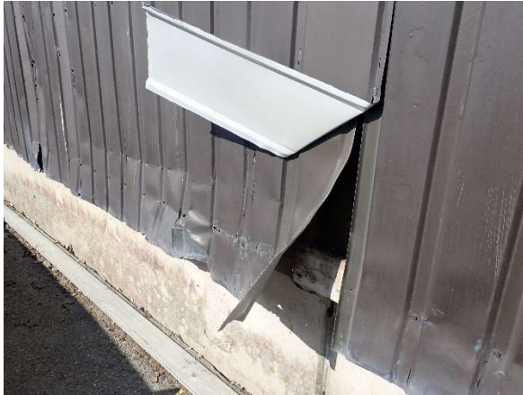
Kuva 68. Rakenneavaus US2 tehtiin idänpuoleiseen päätyyn kohtaan, jossa ulkoverhous oli vaurioitunut.
