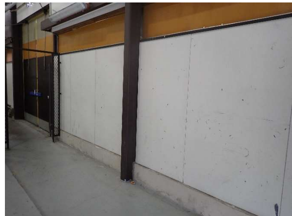
Kuva 61. Hallin ulkoseinien sisäverhouksena on käytetty kuitusementtilevyä erityisesti rakennuksen päädissä.
