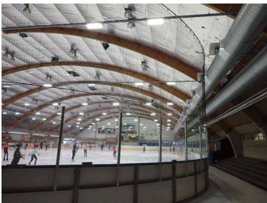
Kuva 190. Jäähallin tuloilma johdetaan kaukalon toisella sivulla. Poistoilma johdetaan poistoilmakoneiden kautta.
