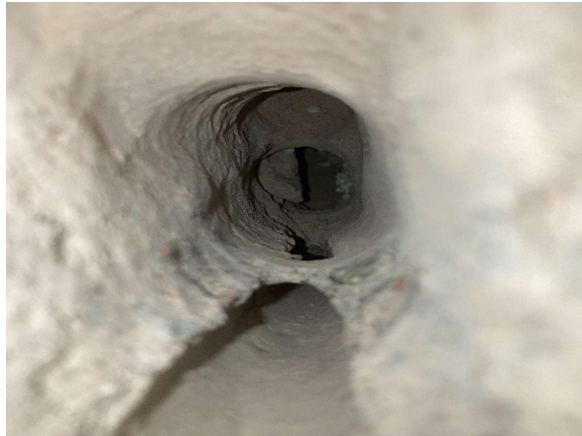
Kuva 31. Rakenneavaus AP1.2, kahvion edusta.
