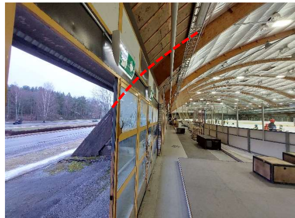
Kuva 59. Liimapuukehät jatkuvat ulkoseinälinjan läpi rakennuksen ulkopuolelle.
