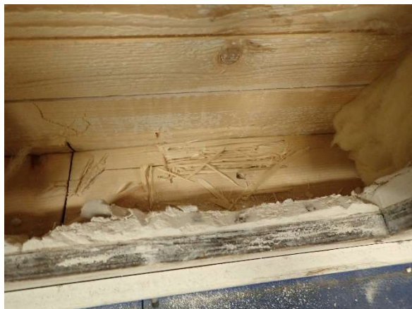
Kuva 107. Kuntosalin seinä on puurakenteinen. Rakenneavauskohdassa ei havaittu vaurioita.
