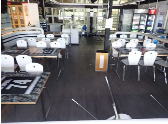
Kuva 24. Kahvion lattiassa on kelluva pintamateriaali. Pintamateriaalin alla on mahdollisesti vanha muovimatto.
