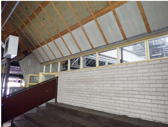
Kuva 89. Jäähallien välissä on kalkkihiiekkatiilirakenne. Seinän yläosassa on teräsrakenteinen ikkunaelementti.
