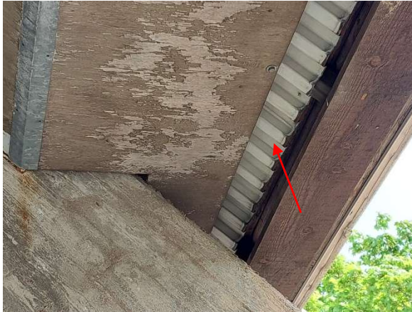
Kuva 126. Vanha profiilikate on nähtävissä räystäiden alta.
