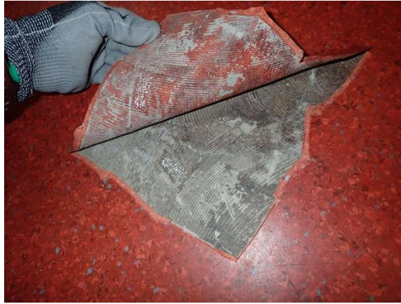
Kuva 40. Viiltomittauskohta VM1. Värimuutoksia tasoitteessa.
