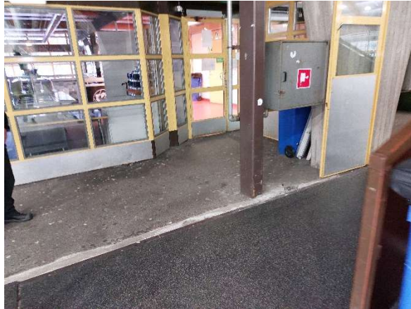
Kuva 93. Kylmän jäähallin ja lämpimän sosiaalitalan välissä on teräsrakenteinen ikkunaelementti ja käyntiovet.
