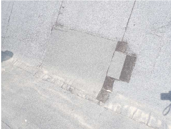
Kuva 132. Vesikattoa on paikkakorjattu.
