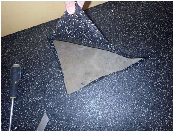
Kuva 34. Pukuhuoneissa on paksu kumimatto, jossa on kumille ominainen haju.
