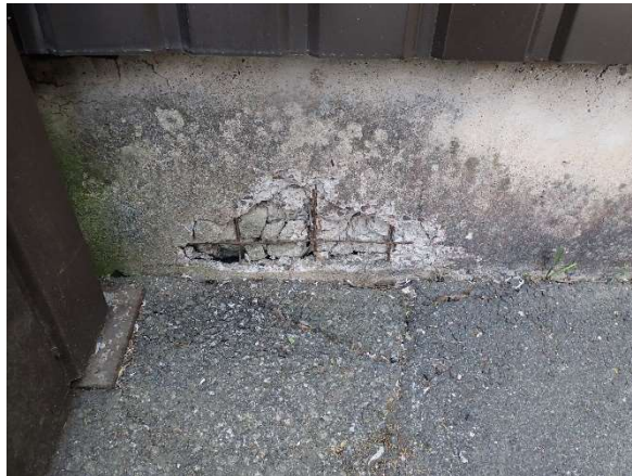
Kuva 73. Rakenneavaus US3. Rakennuksen itäpääty.
