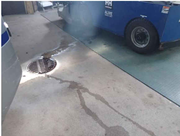
Kuva 8. Jäänhoitokoneiden säilytystilassa on viemäri ja run- sasta koneista tulevaa kosteusrasitusta.
