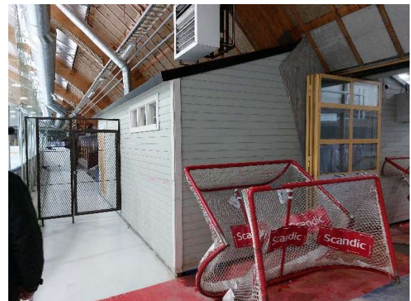
Kuva 108. Kuntosali on lämmitetty puurakenteinen rakennelmä kylmän jäähallin sisällä. Tilassa on koneellinen tulo- ja poistoilmavaihto.
