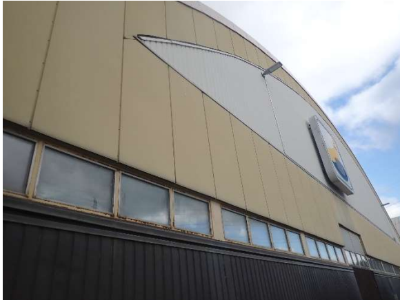
Kuva 44. Jäähallin päätyjen yläosissa on suora pelti ja alaosissa profilipelti. Välissä on teräsrakenteiset ikkunat.
