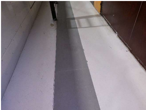
Kuva 14. Kenttien välissä on kapea vanerilla peitetty kouru.
