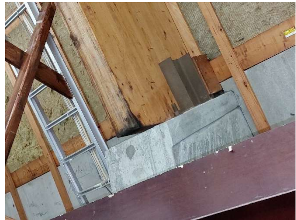
Kuva 117. Liimapuukaaren alanurkassa on kosteuden aiheuttama tummentuma.
