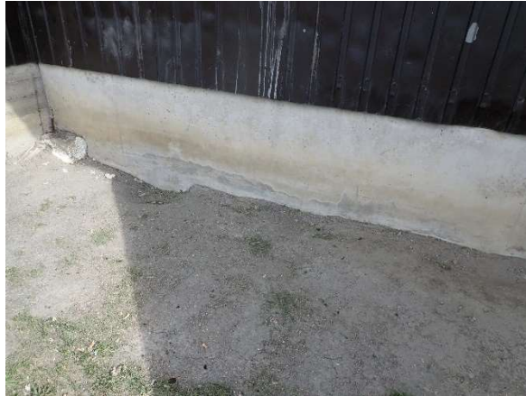
Kuva 183. Sokkelissa olevien jälkien perusteella maanpinta on joko vajonnut tai korkotasoa on muutettu.
