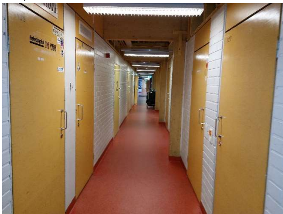
Kuva 91. Sosiaalitilojen pitkällä käytävällä on kalkkihiiekkatiiliseinät ja puurakenteiset ovet.
