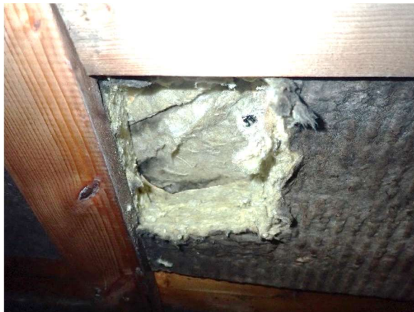
Kuva 166. Rakenneavaus YP5. Avaus tehtiin tarkastamalla rakennetyyppi savunpoistoluukun kohdalta.
