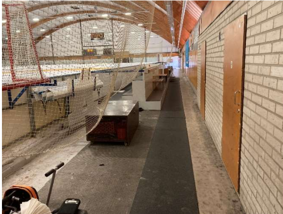
Kuva 12. Rakennuksen molemmilla pitkillä ulkoseinälinjoilla on teräskansilla peitetty kouru.
