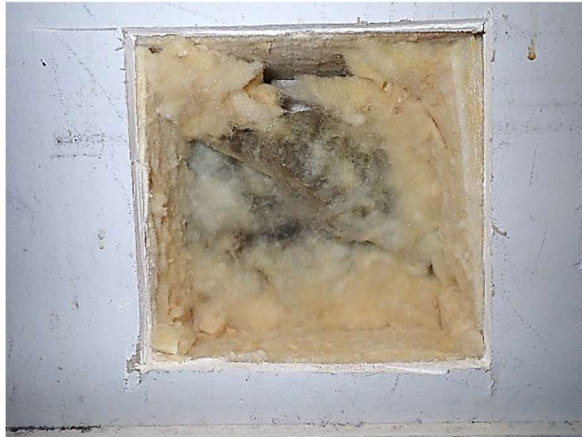
Kuva 101. Rakenneavaus VS2 tehtiin valmentajien tilaan.
