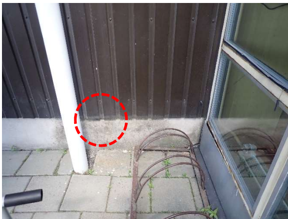
Kuva 70. Rakenneavaus US4 tehtiin kohtaan, jossa sokkeliin ja ulkoseinään on kohdistunut näkyvää kosteusrasitusta.
