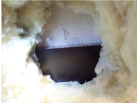
Kuva 104. Seinän alaosassa on vaneri kuitusementtilevyn ulkopinnassa.
