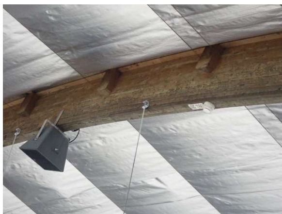
Kuva 112. Liimapuukaarien pinnoilla on runsaasti todennäköisesti mikrobikasvuston aiheuttamia tummentumia.
