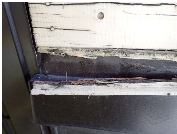
Kuva 81. Puu-ulkoverhous on lahonnut.
