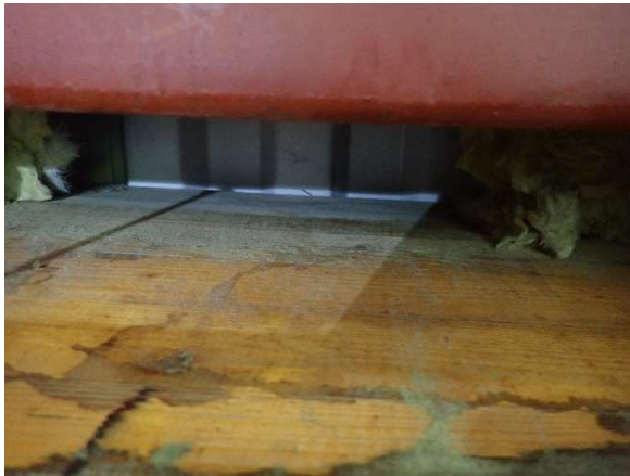
Kuva 171. Rakenneavaus YP6, ulkoseinälinja.
