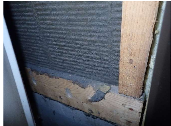
Kuva 78. Pellin takana on vastaava rakenne kuin muissakin ulkoseinissä.
