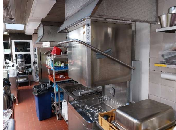
Kuva 25. Keittiön alapohjassa on keraaminen laatta.
