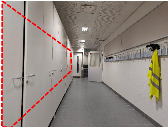
Kuva 29. Käytävän maanvastainen ulkoseinä merkittynä kuvaan.
