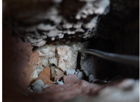
Kuva 41. Rakenneavaus US 2, tekstiilityö 007 luokassa. Lämmöneristeenä ikkunan alapuolisessa osassa on uretaanieriste.
