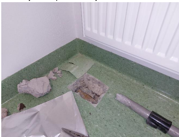
Kuva 78. Rakenneavaus VP1 tehtiin terveydenhoitajan tilaan 107.
