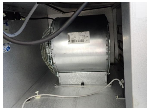
Kuva 112. Puhallinkammiot olivat puhtaat.
