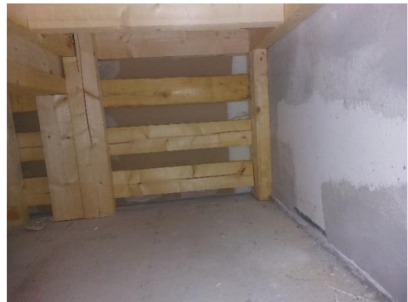
Kuva 95. Rakenneavaus PORRAS1: Porrask rakenne on puurakenteinen. Portaan alaosan alueella on todennäköisesti maanvastaista ulkoseinärakennetta.
