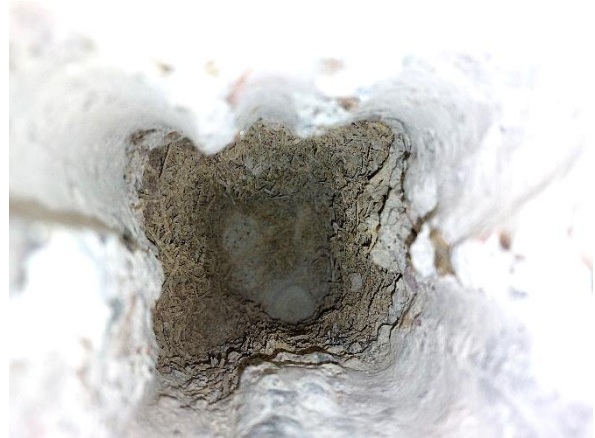
Kuva 46. Rakenneavaus US 2, tekstiilityö 007 luokassa. Lämmöneristeinä on sementtilastuvillalevy, jossa havaittiin materiaalinäytteen suoraviljelyssä heikko viite vauriosta.
