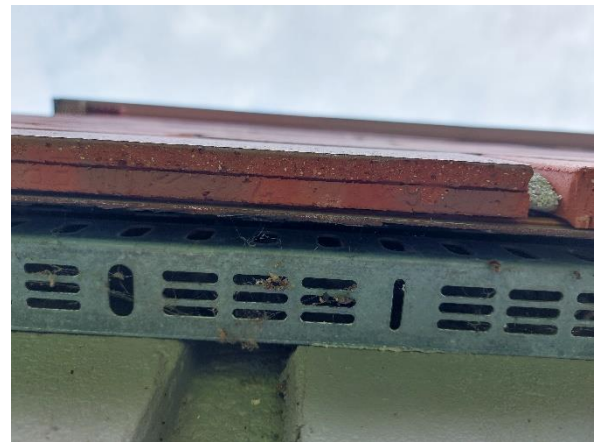
Kuva 63. Julkisivujen alkuperäinen tiiliverhous on ha- vaintojen perusteella uusittu tiililaattajulkisivuksi.
