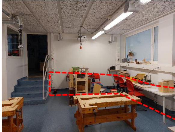
Kuva 31. Puutyöluokan 008 ulkoseinät ovat alaosistaan maanvastaisia ulkoseinärakenteita.
