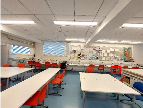
Kuva 45. Rakenneavaus US 2, tekstiilityö 007 luokassa. Rakenteen toteutustapa tarkastettiin kuvaan merkityiltä alueelta.
