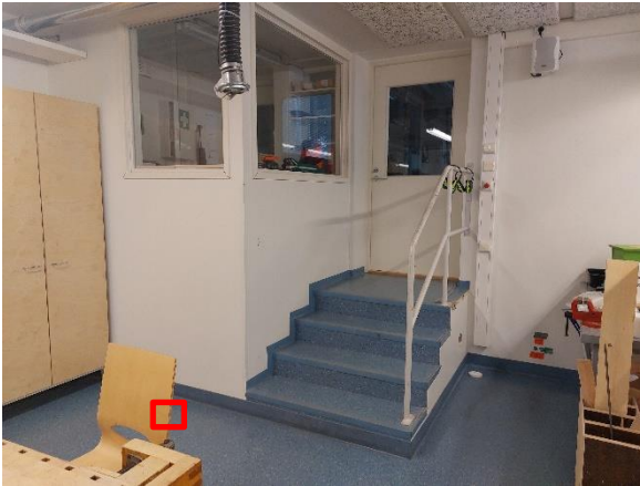
Kuva 17. Rakenneavaus AP2 tehtiin kuvaan merkittyyn kohtaan rakenteen keskialueelle.
