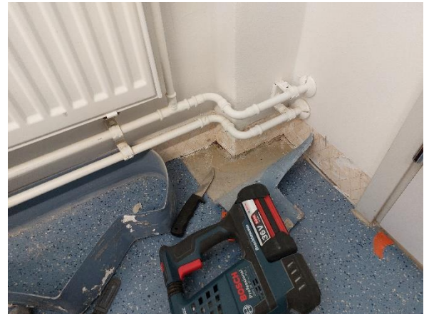
Kuva 14. Rakenneavaus AP1 tehtiin alapohjarakenteeseen ulkoseinän ja pilarin liitokseen.
