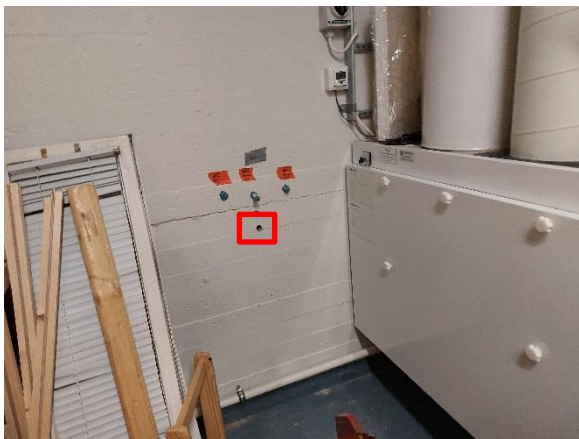
Kuva 37. Rakenteen toteutustapa tarkastettiin varaston 006 alueelta kuvaan merkitystä kohdasta.
