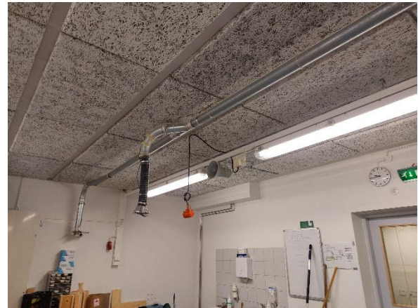
Kuva 72. Puutyöluokan 008 sisäkatto on maalattu ja sisäkaton pintaan on kiinnitetty akustiikkalevyjä, jotka ovat sementtilastuvillarakenteisia.
