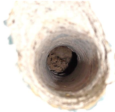
Kuva 46. Rakenneavaus US 2, tekstiilityö 007 luokassa. Lämmöneristeinä on sementtilastuvillalevy, jossa havaittiin materiaalinäytteen suoraviljelyssä heikko viite vauriosta.
