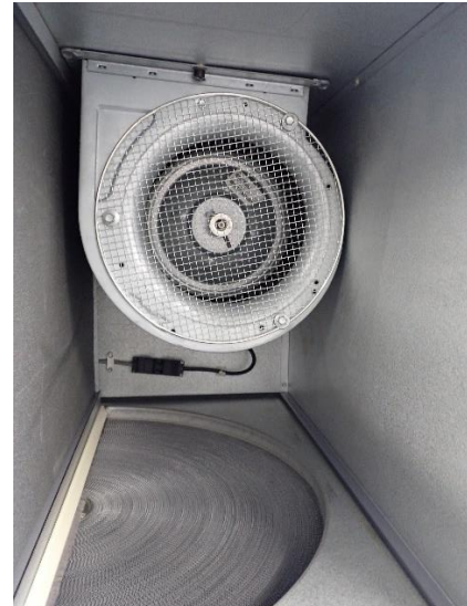
Kuva 110. Puhallinkammiot ja LTO-kiekkko olivat melko puhtaat.
