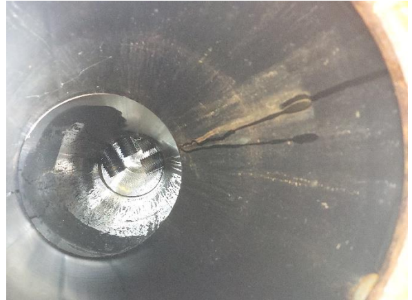
Kuva 101. Pääosin salaojien tarkastuskaivoissa havaittiin vettä.
