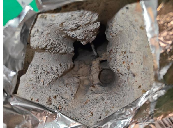
Kuva 87. Rakenneavaus VP3. Rakenne on massiivibetonirakenteinen, eikä se sisällä herkästi vaurioituvia materiaaleja.
