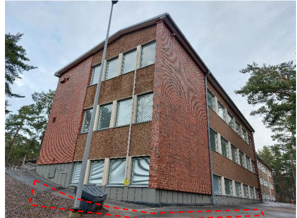
Kuva 32. Varaston 006, tekstiilityön 007 ja puutyö 008 luokan ulkoseinärakenteet ovat osittain maanvastaisia
