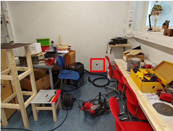
Kuva 47. Rakenneavaus US 4, puutyö 008 luokassa. Rakenteen toteutustapa tarkastettiin kuvaan merkityiltä alueelta.
