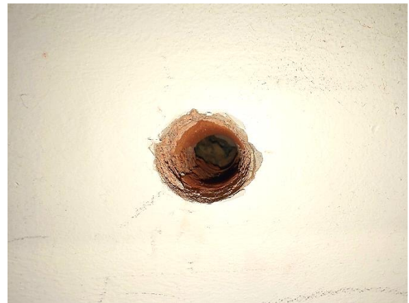
Kuva 51. Rakenneavaus US5, puutyö 008 luokassa. Lämmöneristeenä on mineraalivillaeriste.
