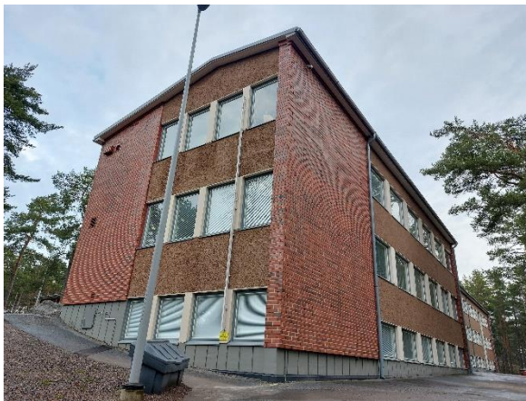
Kuva 62. Rakennuksen julkisivut ovat paikoin rapattuja ja paikoin tiililaattapintaisia.
