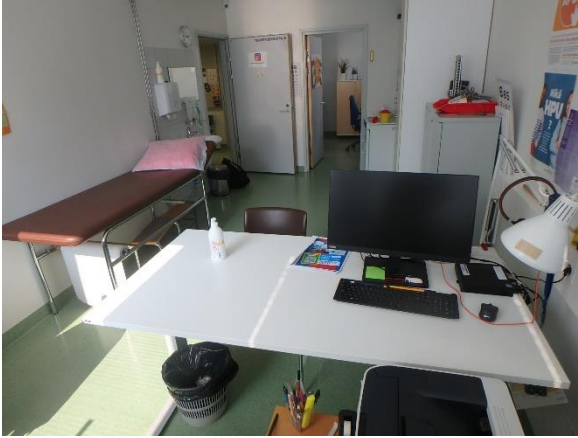
Kuva 75. Välipohjarakenteen päällysteenä on muovimatto. Kuva terveydenhoitajan huoneesta 107.
