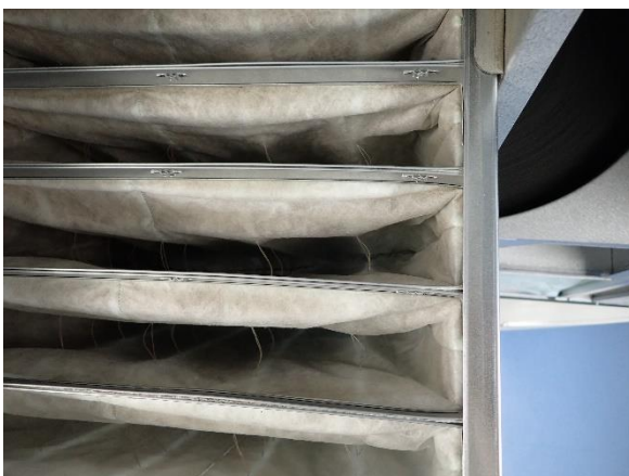
Kuva 111. Suodattimet olivat melko puhtaat.
