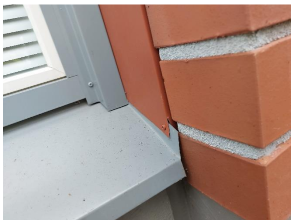
Kuva 35. Ikkunoiden pellitykset on havaintojen perusteella toteutettu asianmukaisesti.
