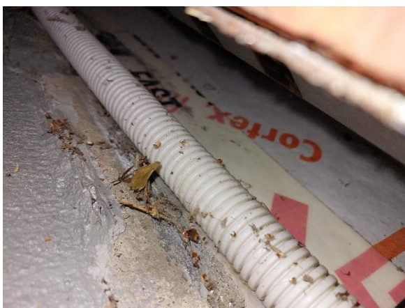
Kuva 64. Tiiliverhouksen takana havaittiin tuuletusrako ja tuulensuojaeristeeksi asennettu kivivillaeriste.
