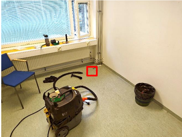
Kuva 86. Rakenneavaus VP3 tehtiin oppilashuollon alueelle toimistoon 133. Avauskohta on merkitty kuvaan punaisella.
