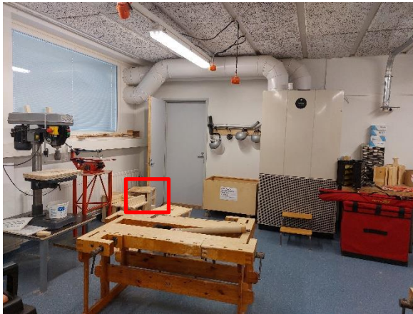
Kuva 13. Rakenneavaus AP1 tehtiin puutyöluokkaan 008 kuvaan merkitylle alueelle.
