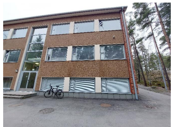
Kuva 65. Yleiskuva toisen kerroksen julkisivusta.
