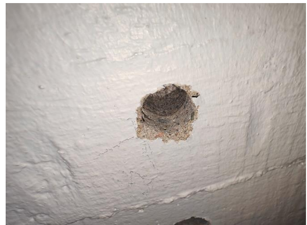
Kuva 38. Rakenneavaus US1. Rakenne on massiivibetonirakenteinen.
