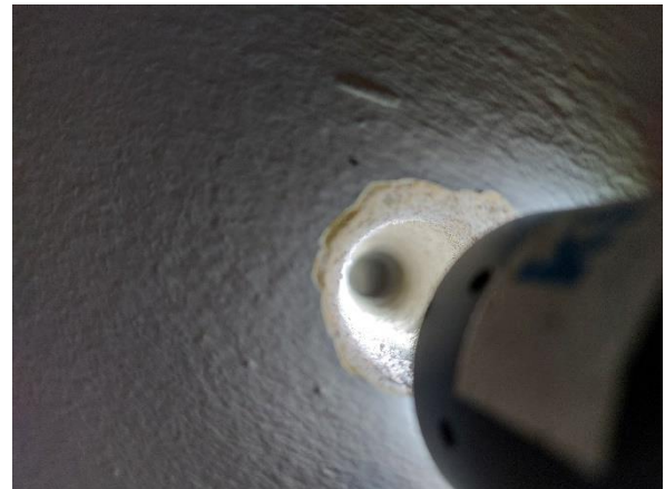
Kuva 69. Rakenne on kevytbetonirakenteinen, eikä rakenne sisällä herkästi vaurioituvia materiaaleja.
