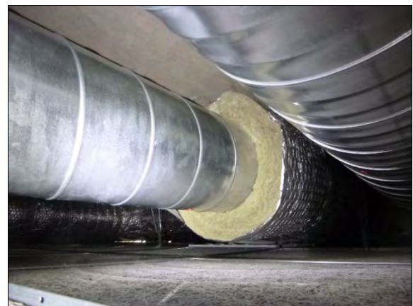
Kuva 47. Alaslaskujen yläpuolella on avoimia mineraalivillapintoja.
