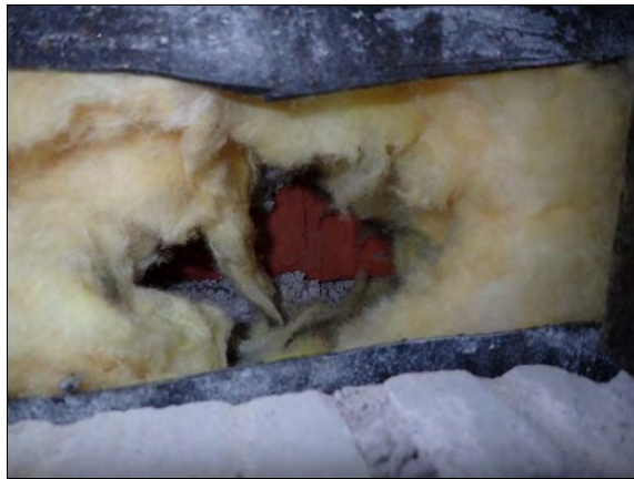
Kuva 82. Ulkoseinän rakenneavaus 2 liikuntasalissa 181.
