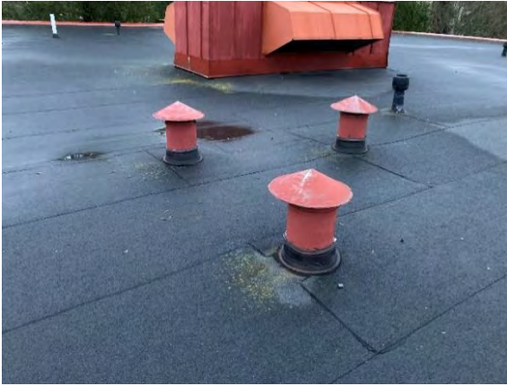
Kuva 153. Vesikatteen läpivientejä.
