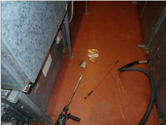
Kuva 59. Rakenneavaus VP 3 tehtiin IV-konehuoneen välipohjarakenteeseen.
