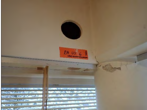
Kuva 95. Ulkoseinän rakenneavaus 6 musiikkiluokassa huoneessa 221.
