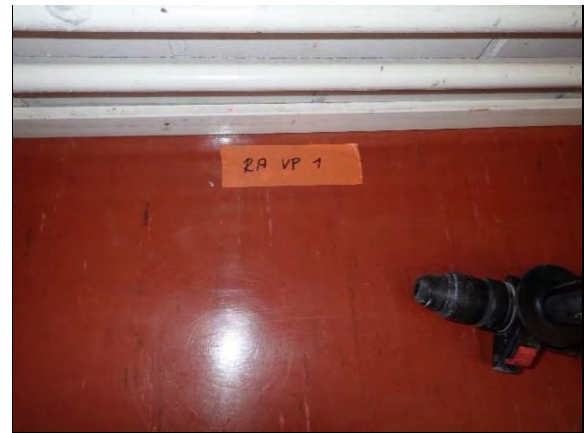
Kuva 54. Väli-pohjan päällysteenä on muovimatto
