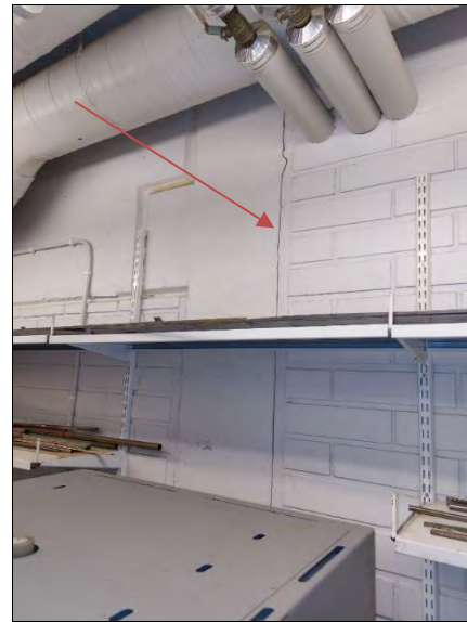
Kuva 129. Halkeama väliseinässä.
