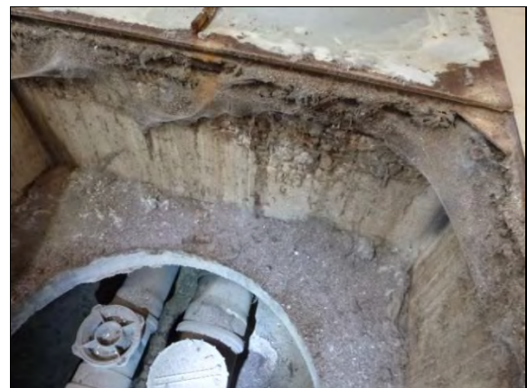
Kuva 12. Yleiskuva tilan 165 alapohjan luukun alapuolista rakenteesta.
