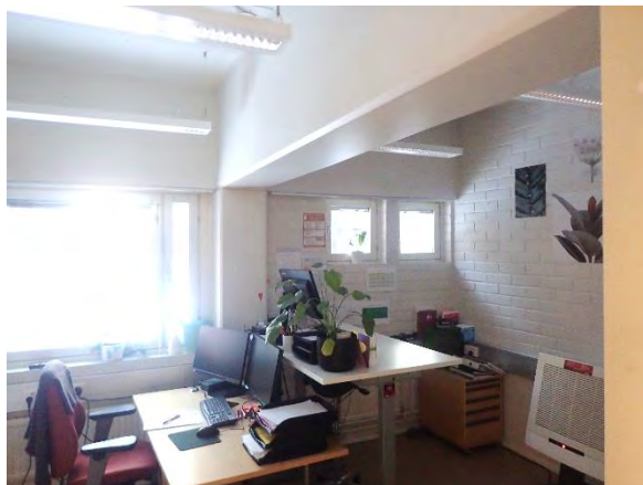
Kuva 188. Rehtorin huoneen jakaa katto palkki, jolla on merkittävä vaikutus ilmanliikkuvuuteen.
