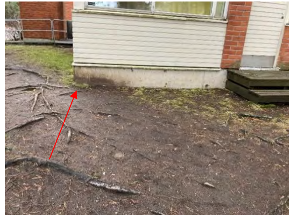
Kuva 185. Sokkelirakenteissa kosteusjälkiä.
