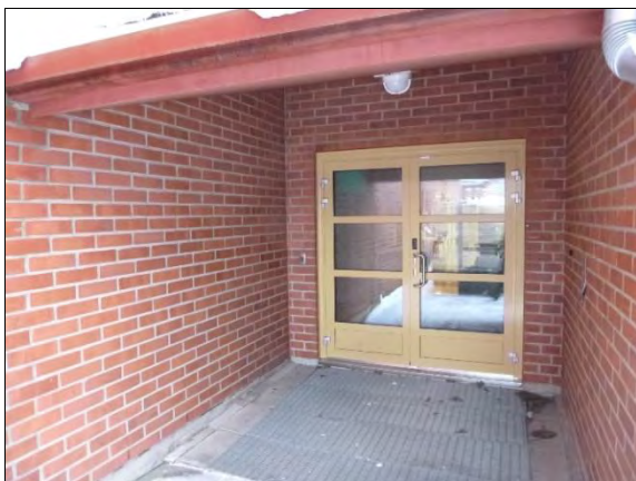
Kuva 64. Uusittu alumiiniulko-ovi.
