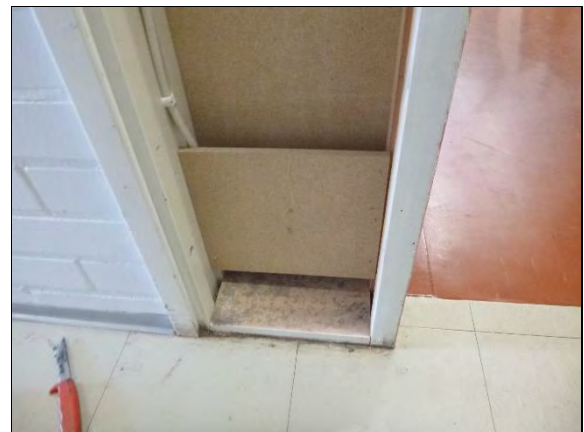
Kuva 140. Yleiskuvaa avauksesta VS 3. Kotelon pohjalla pölyä.
