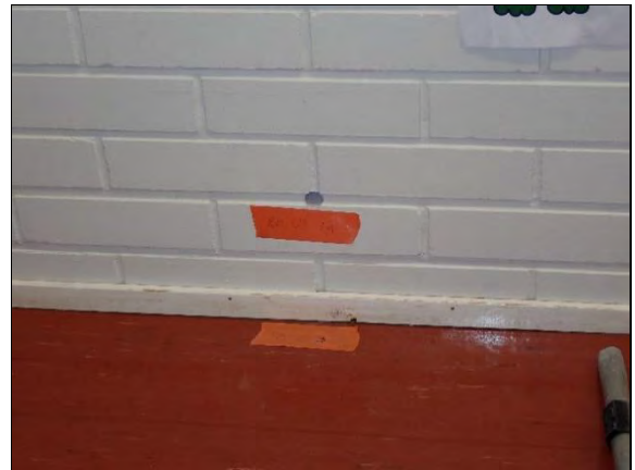
Kuva 85. Ulkoseinän rakenneavaus 12 luokassa 245.
