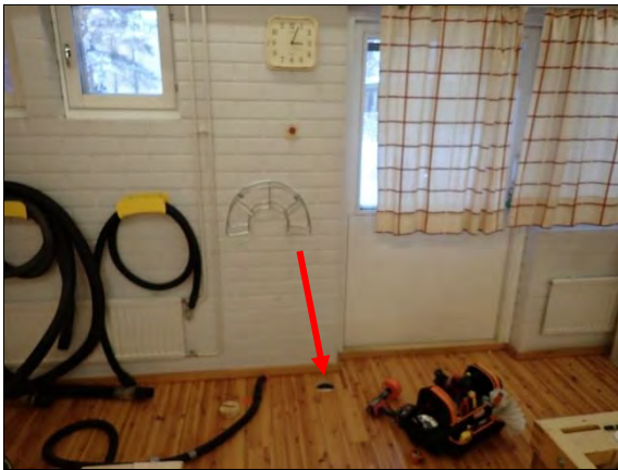
Kuva 23. Rakenneavaus AP 2 tehtiin teknisen työn luokkaan.
