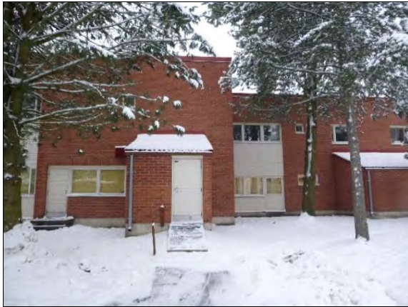
Kuva 60. Julkisivut ovat pääosin tiilimuurattuja. Paikoin ikkunoiden alapuolella on puuverhoiltuja alueita. Sokkeli on betonirakenteinen.
