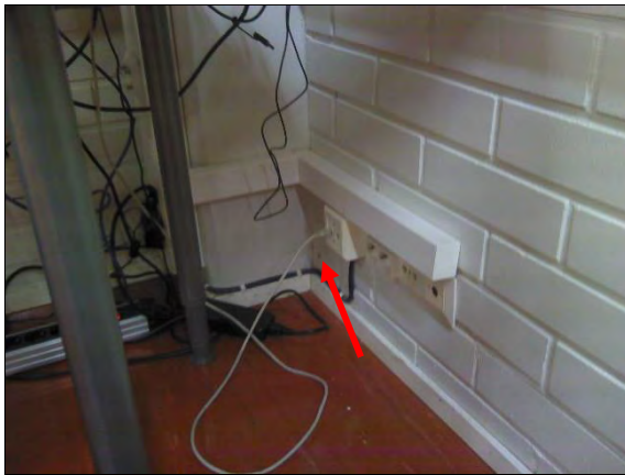
Kuva 116. Halkeama luokkatilan tiilimuurauksessa.
