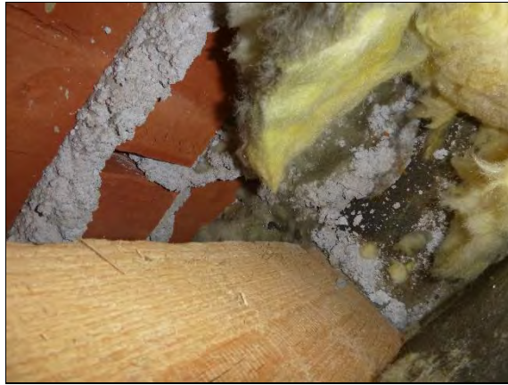
Kuva 102. Ulkoseinän rakenneavaus 14 liikuntasalissa 181.
