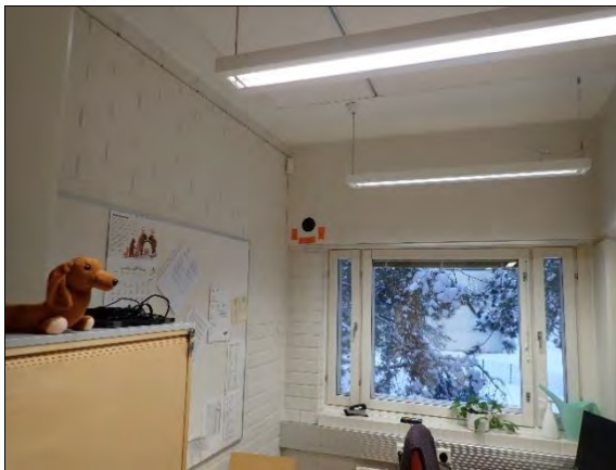
Kuva 97. Ulkoseinän rakenneavaus 13 huoneessa 212.
