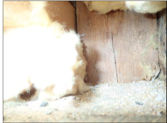
Kuva 91. Yleiskuvaa avauksesta US 1.
