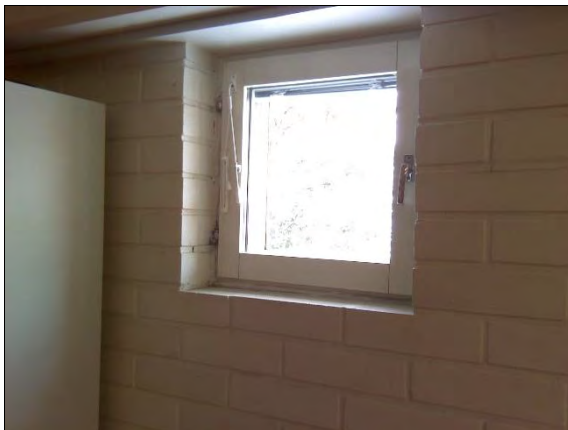
Kuva 120. Ikkunan liitosta tiilimuuraukseen on tiivistetty elastisella massalla.
