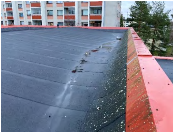
Kuva 149. Yleiskuva liikuntasalin vesikatosta.
