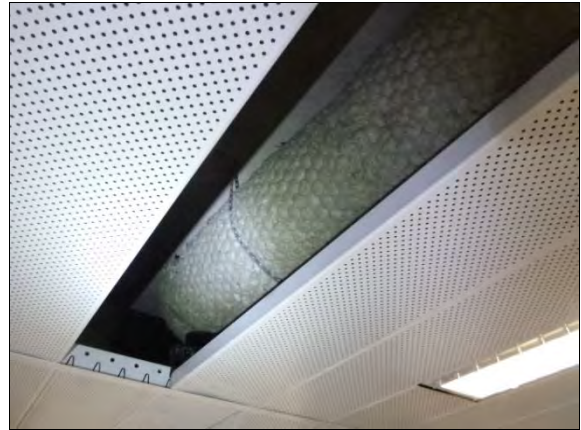
Kuva 49. Alaslaskujen yläpuolella on avoimia mineraalivillapintoja, tila 169.
