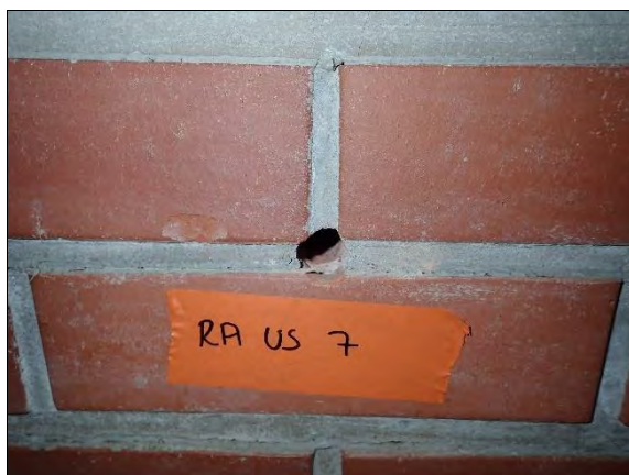
Kuva 86. Ulkoseinän rakenneavaus 7 huoneessa 209.
