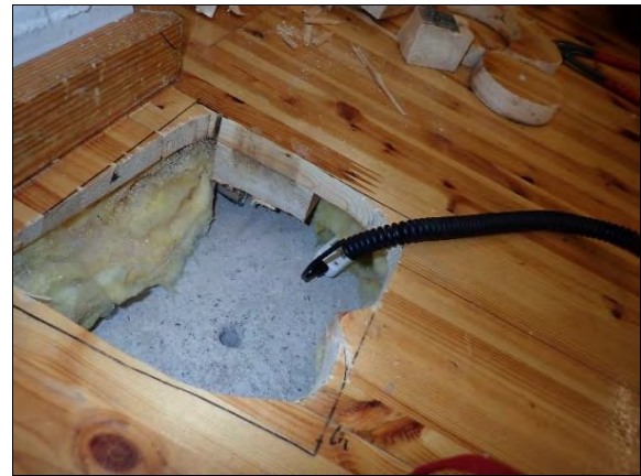
Kuva 24. Rakenneavaus AP 2: Lattialaudoituksen alla on runko ja mineraalivilla.
