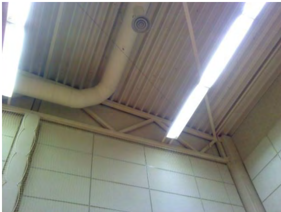
Kuva 172. Liikuntasalin päädyn yläpohja.
