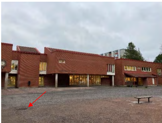
Kuva 176. Rakennuksen ympäristö on pääosin sorapinnalla, jossa on yksittäisiä sadevesikaivoja.
