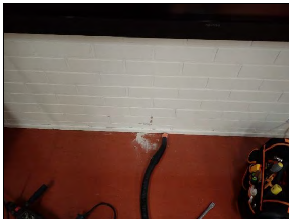
Kuva 142. Väliseinäavaus VS 4 tehtiin luokkahuoneeseen 177.
