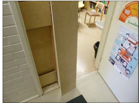
Kuva 138. Yleiskuvaa avauksesta VS2.
