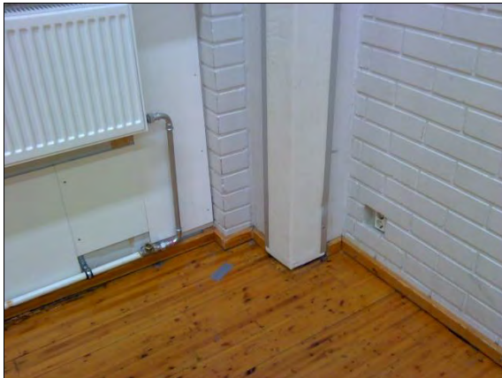
Kuva 114. Liikuntasalin rakenteissa ei havaittavissa merkittäviä halkeamia.
