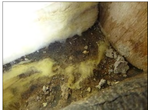
Kuva 93. Ulkoseinän rakenneavaus 15 luokassa 173.
