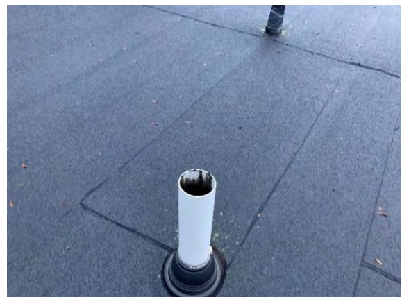
Kuva 152. Vesikatteen läpivientejä.
