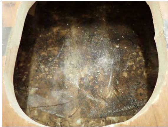
Kuva 30. Rakenneavaus AP 6 tehtiin keskelle liikuntasalia.
