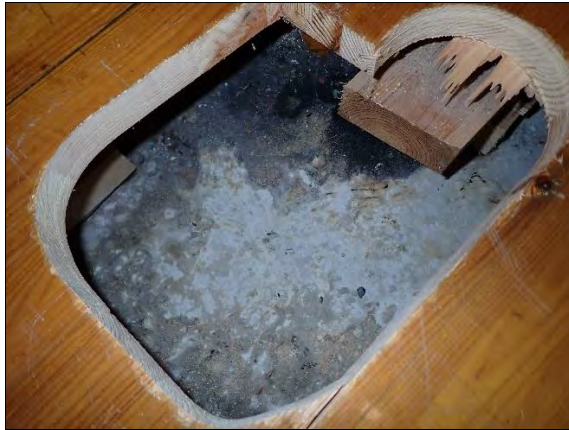
Kuva 28. Rakenneavaus AP 4 tehtiin liikuntasaliin ulkoseinän viereen.
