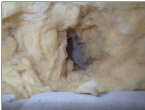
Kuva 92. Ulkoseinän rakenneavaus 9 varastossa 220.
