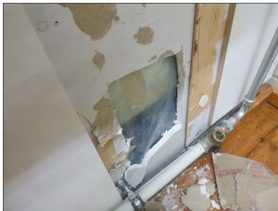
Kuva 100. Ulkoseinän rakenneavaus 14 liikuntasalissa 181.
