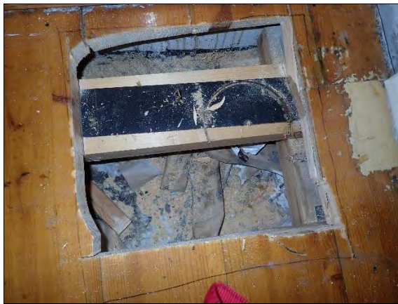
Kuva 26. Rakenneavaus AP 7 tehtiin liikuntasalin ulkonurkkaan.
