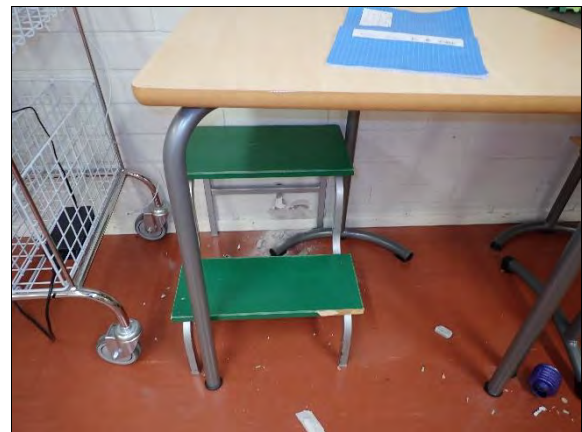
Kuva 143. Poraus tuli läpi luokkahuoneeseen 176. Seinän paksuus tiilen verran 130 mm.
