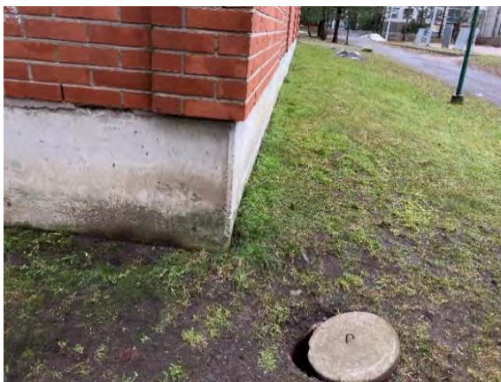
Kuva 180. Rakennuksen länsipuolella havaittiin salaojien tarkastuskaivoja.
