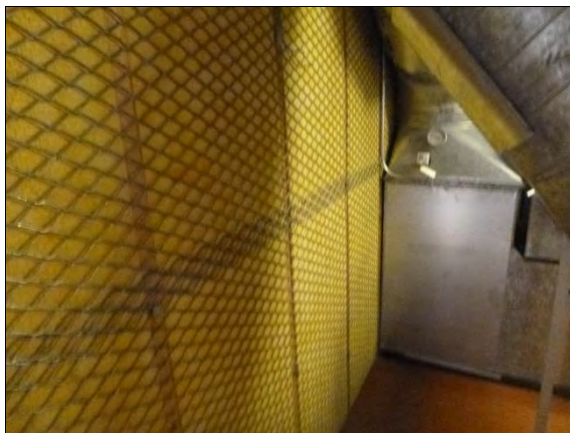
Kuva 130. Ilmanvaihtokonehuoneen väliseinässä näkyvää villaa.
