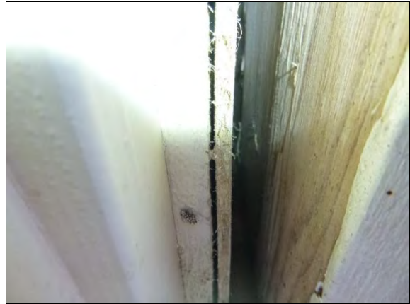
Kuva 67. Puuverhoilun taustan tuuletusrakoa.
