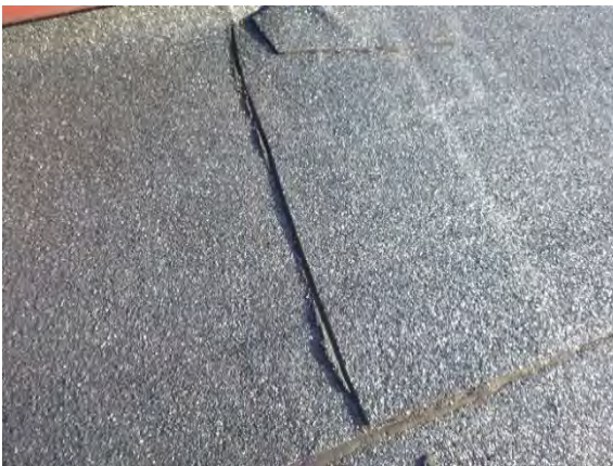
Kuva 163. Kermien saumoissa ei havaittu vaurioita.
