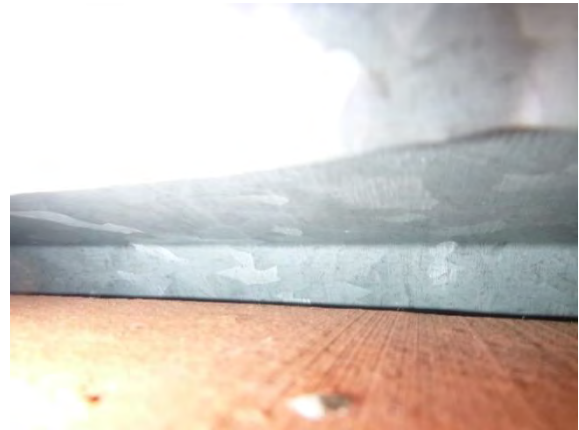
Kuva 156. Kirjasto huoneen vesikatteen reuna-alueen pellitys on tiilimuurauksessa kiinni
