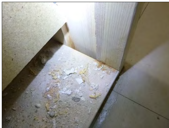
Kuva 139. Kotelonpohjalla rakennusjätettä.
