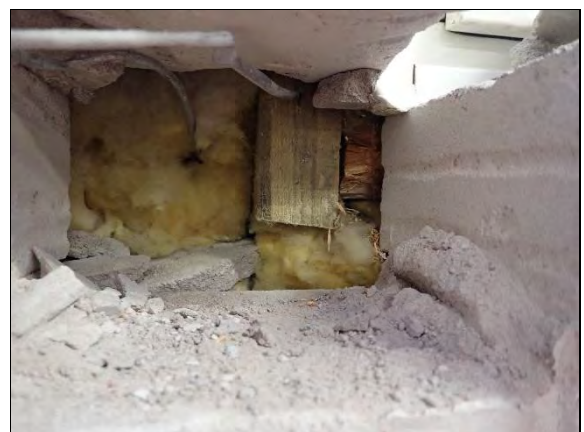
Kuva 87. Ulkoseinän rakenneavaus 4 huoneessa 243.
