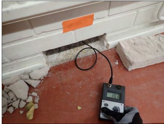
Kuva 90. Ulkoseinän rakenneavaus 1 huoneessa 177.
