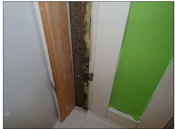
Kuva 83. Ikkunaliitoksen rakenneavaus (US 10 + IKK) luokassa 177. Liitos ilmanpitävyyden suhteen avoin.
