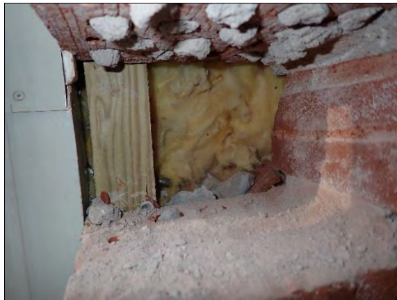
Kuva 84. Ulkoseinän rakenneavaus 11 ruokasalissa 154.
