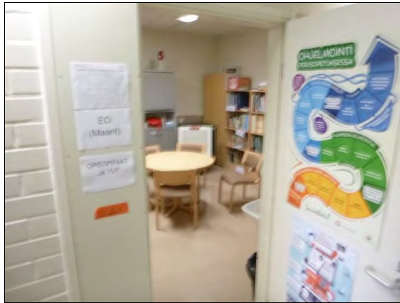
Kuva 137. Väliseinäavaus VS2 tehtiin erityisopetusluokan oven viereiseen kotelointiin.
