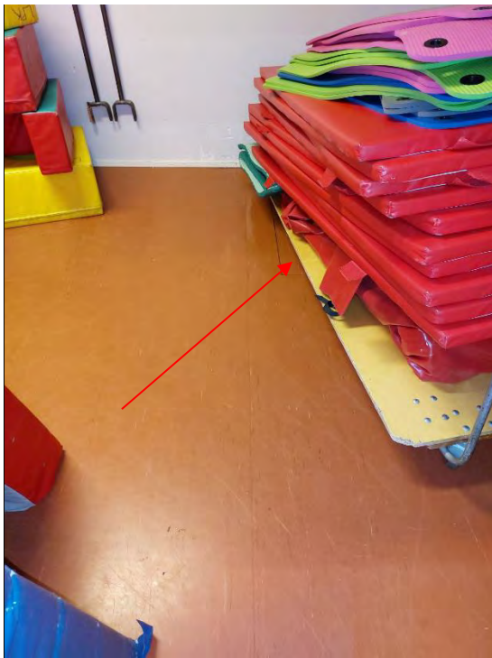
Kuva 5. Luukku liikuntasalin varastossa 107.
