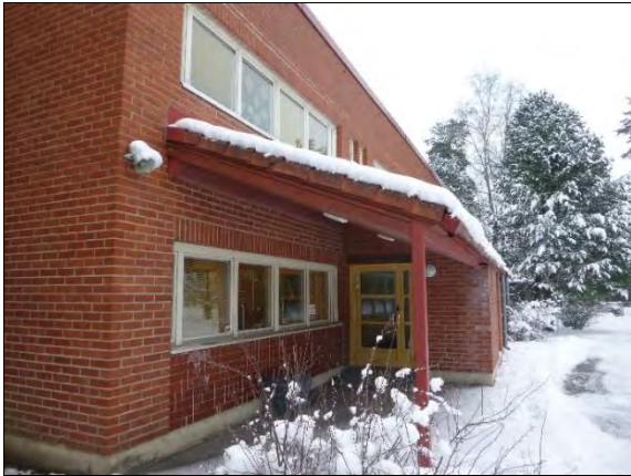
Kuva 72. Julkisivu on laatoitettu ikkunoiden alta.
