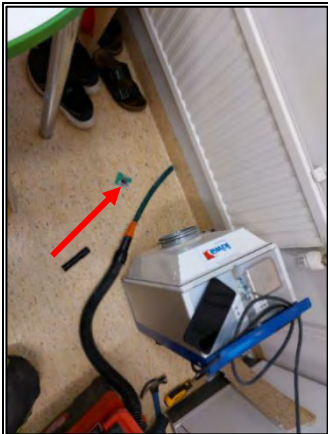
Kuva 20. Rakenneavaus AP 3 tehtiin huoneeseen 130.
