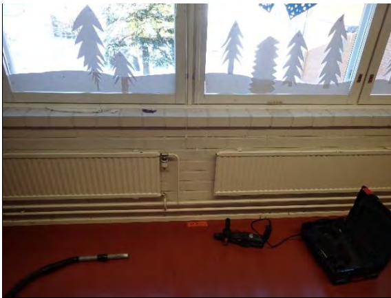
Kuva 53. Rakenneavaus VP 1 tehtiin luokan 242 väli-pohjarakenteeseen.
