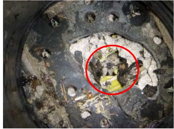
Kuva 160. Vesikaton tuuletusputken kohdalla tuuletusaukko on toteutettu kevytsorakerrokseen asti.
