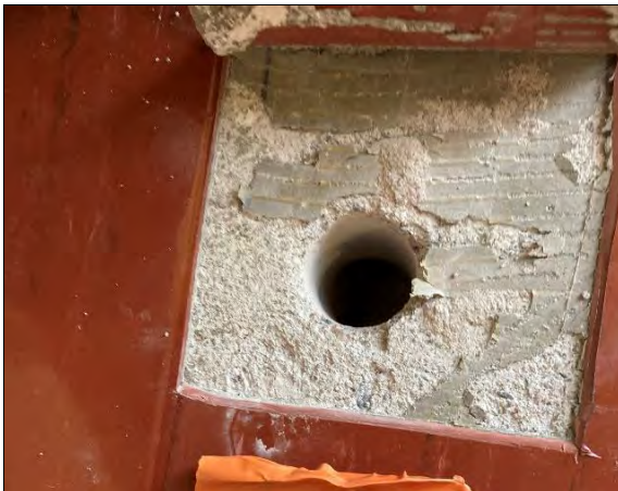
Kuva 56. Rakenneavaus VP 2 tehtiin Musiikkiluokan 221 välipohjarakenteeseen.
