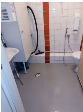
Kuva 17. Iltapäiväkerhon WC:n lattiapinnoitteena on maali.
