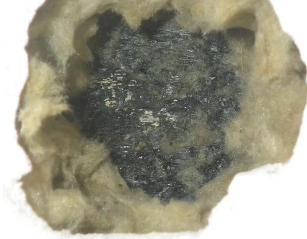
Kuva 68. Seinän lämmöneristeenä on mineraalivillaa ja betoniulkokuoren sisäpinnassa on ohut bitumisively.
