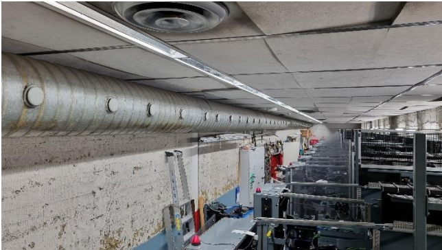
Kuva 113. Keilaradan katon iäkkäät akustiikkalevyt sekä tekniikkakäytävän seinän villalevyt toimivat teollisen mineraalikulitujen lähteinä.
