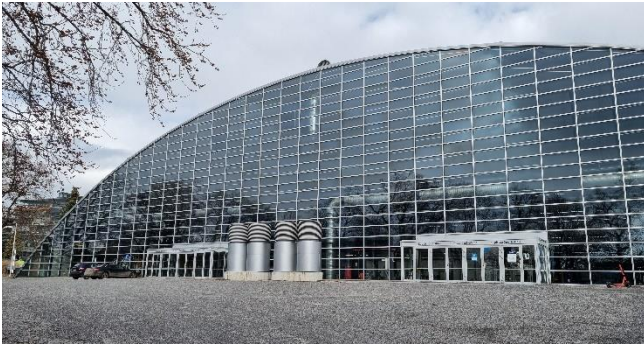
Kuva 3. Yleisurheiluhallin (kenttäkerros) lasijulkisivu lounaan suuntaan. Rakennuksen yläpohja on kaareva, ylimmällä kohdalla kulkee katon tuuletuskanava.
