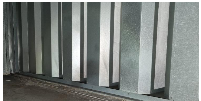
Kuva 136. Äänenvaimennin on siisti ja kuitujen irtoaminen on estetty.
