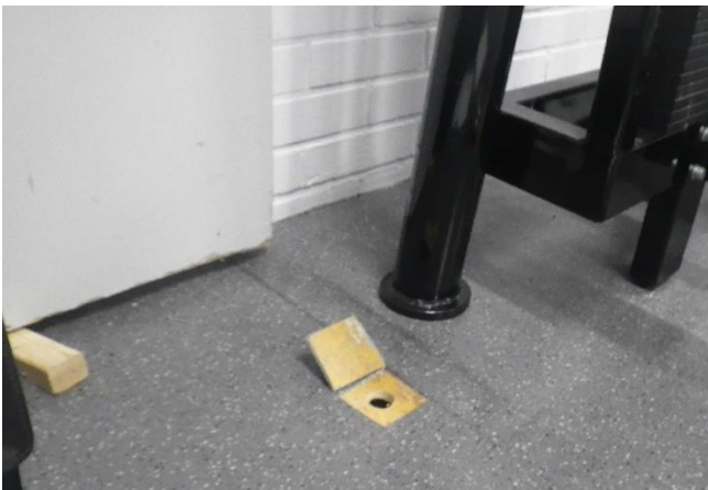
Kuva 41. Kuntosalin O37 alapohjarakenne tarkastettiin asennuslattian vaneriin tehdyn avauksen R27 kautta.
