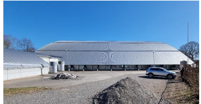
Kuva 4. Luoteen puolella urheiluhallin vesikatto ulottuu lähes maan pinnan tasalle. Vasemmassa reunassa olevan juoksuputken ulkoseinät ovat peltikasetteja.
