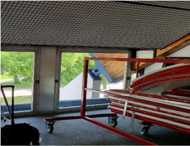
Kuva 78. Urheiluhallin kaakkoispäädyn ulkoseinänä on avattavat ikkunat, joiden välissä on molemmin puolin pellitetyt umpiosat.
