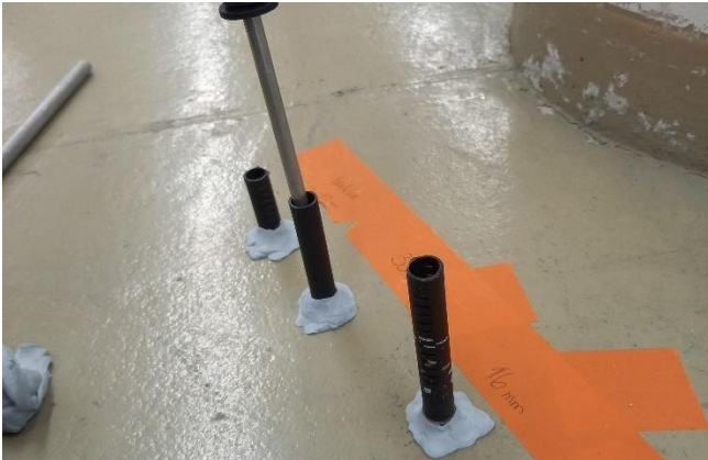
Kuva 28. Porareikämittauksissa reiät porattiin, putkitettiin, puhdistettiin imuroimalla ja tulpattiin 20.6.2022.
