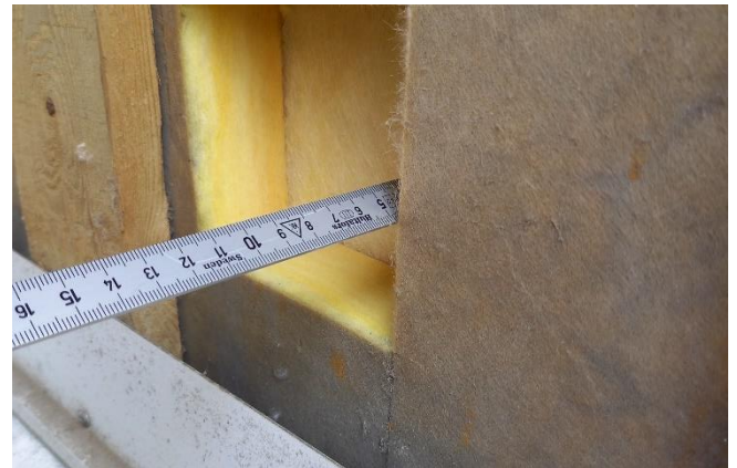
Kuva 77. Rakenne vastasi täysin suunnitelmissa esitettyä.
