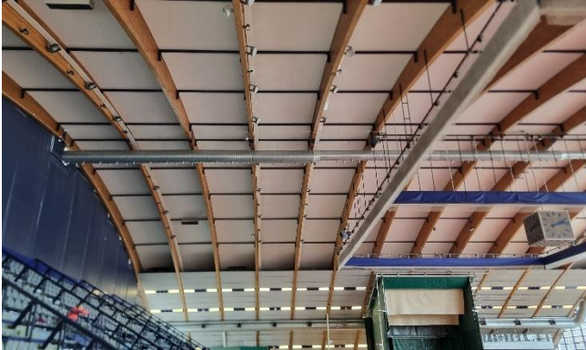
Kuva 88. Rakennuksen yläpohja on puurunkoinen. Kummassakin päädyssä on alas laskettu akustointilevytyks.
