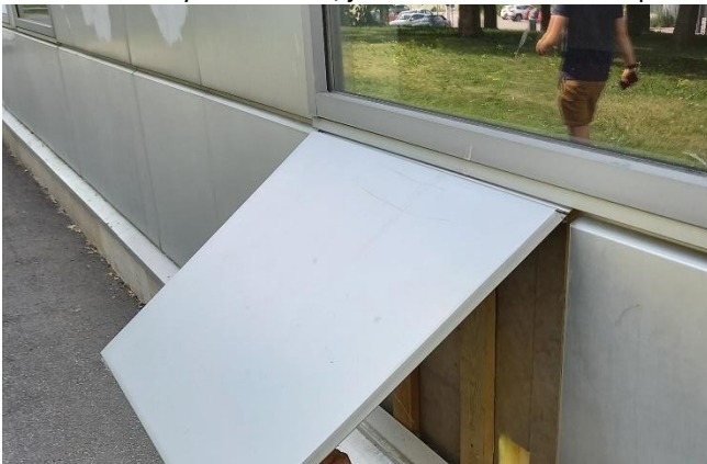
Kuva 76. Juoksuputken ulkoseinärakenne tarkastettiin ulkokautta.
