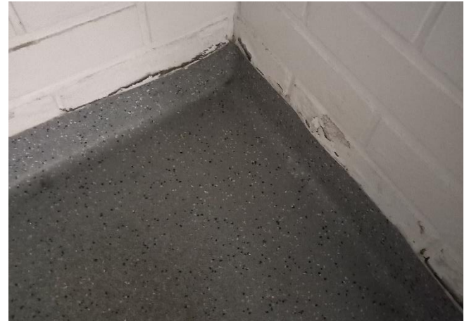
Kuva 21. Kosteusjälkiä WC-tilassa 073.
