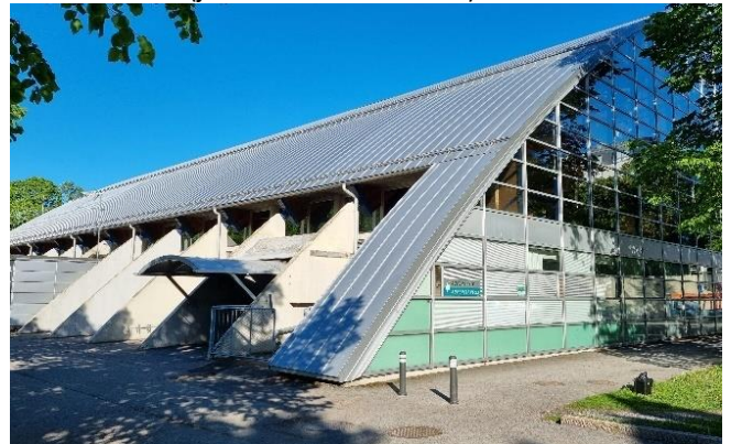
Kuva 9. Koillisen ja kaakon puolella pihan asfaltointi ulottuu ulkoseinälinjalle.
