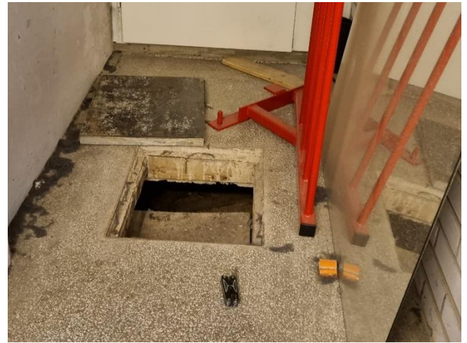
Kuva 63. Ikkunapuhalluksen tuloilmakanava kulkee kuntosalin 037 kohdalla rakennuksen alapohjassa, josta se nousee portaikon alareunassa ylös kenttätason lattiarakenteisiin.
