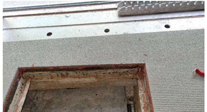
Kuva 140. Koneelta TK2 otetaan tuloilma myös koillisen puoleisen seinustan ikkunapuhallukseen.
