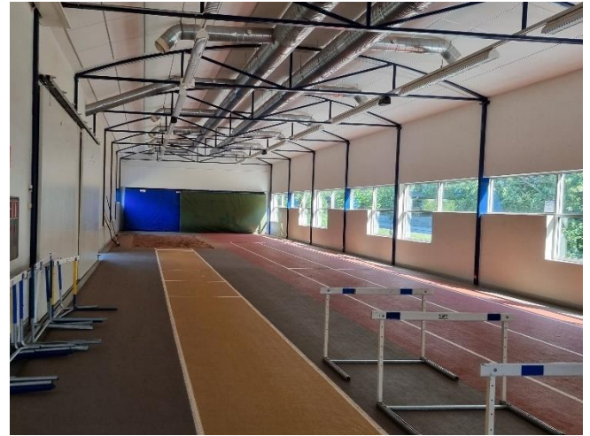
Kuva 53. Juoksuputken lattiassa ei havaittu poikkeavaa kosteutta eikä poikkeavaan kosteusrasitukseen viittavia jälkiä.
