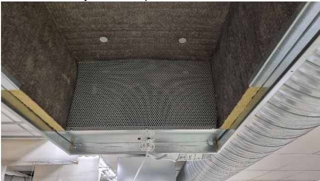
Kuva 117. Ampumaradan tuloilman päätelaitteissa oli pinnoittamatonta mineraalivillaa.
