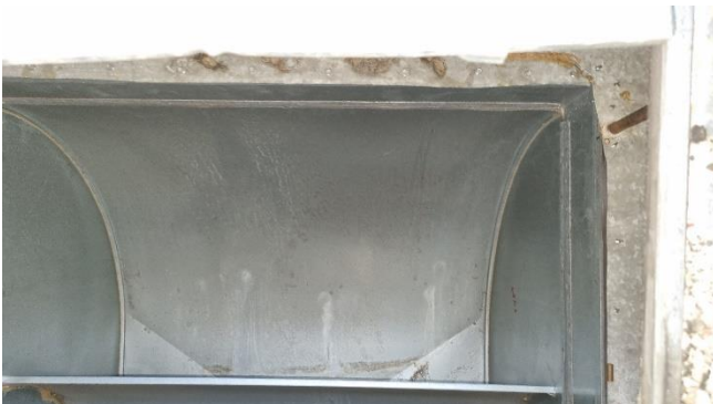
Kuva 141. Tuloilmakanava tulee IV-konehuoneesta 001 kenttäkerrokseen juuri kuvan 140 tarkastusluukun kohdalta
