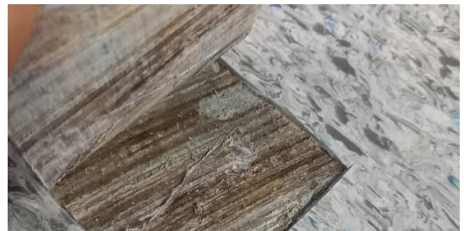
Kuva 27. Myös viillossa V12 liimassa oli selvä värimuutos ja liimatilasta havaittiin mikrobiperäistä hajua.
