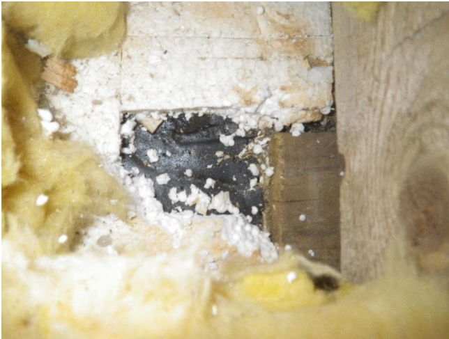
Kuva 46. Eteisen 107 asennuslattian alla oli lämmöneristeenä mineraalivillaa (M1) ja ohut EPS-levy, jonka alla betoni- laatan pinnassa runsaasti PAH-yhdistettä sisältävä bitumisely.
