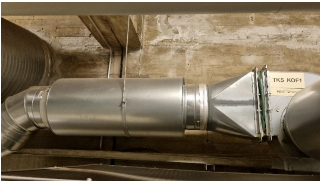
Kuva 147. Kierrätysilmakone TK5 KOF1
