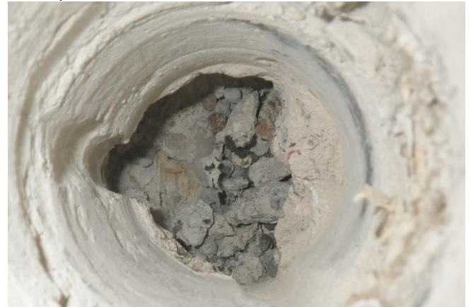
Kuva 51. WC-tilan ja siivouskomeron alapohjassa oli täyttömaan päällä kevytsoraeristys.
