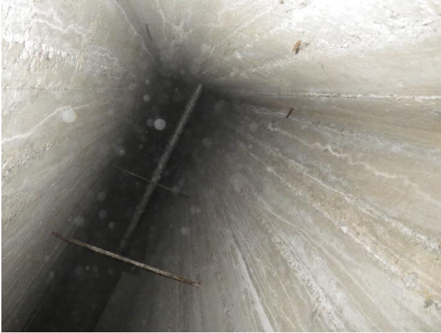
Kuva 82. Porrashuoneiden keskellä on betonirakenteiset pystykuilut.
