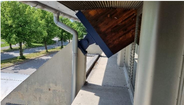
Kuva 104. Kaakkoispäädyn pukuhuoneet ulottuvat kenttäkerroksen ulkoseinälinjan ulkopuolelle.
