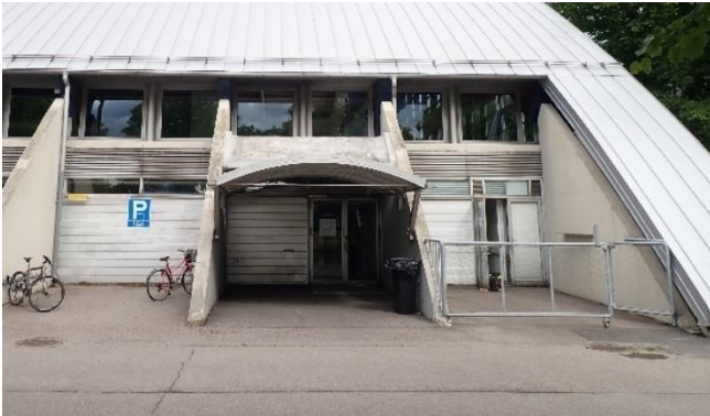
Kuva 74. Kaakon puoleisessa päädyssä pohjakerroksen ulkoseinät ovat kevytrakenteisia, julkisivumateriaalina on pelti.
