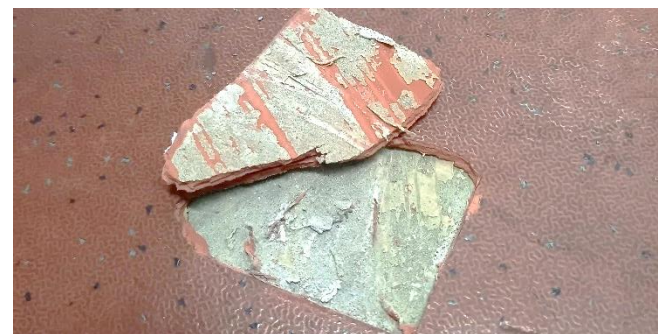
Kuva 31. Kuntosalin 052 iäkäs matto oli erittäin hauras, mikä saattoi vaikuttaa jonkin verran pintakosteushavaintoihin ja viiltomittausten tuloksiin.
