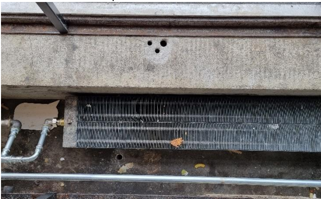
Kuva 58. Patterisyvennyksen pohjan ja sokkelihalkaisun rakenne ja eristemateriaalit tarkastettiin rakenneavauksin.
