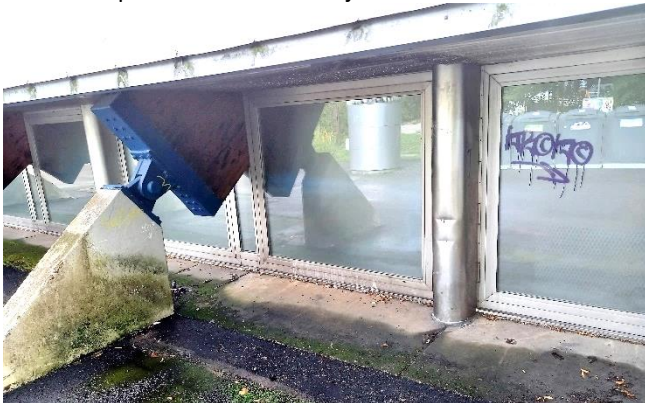
Kuva 8. Luoteen puolella piha-alue on asfaltoitu, räystään alla pihakannen päällä on betonilaatoitus.
