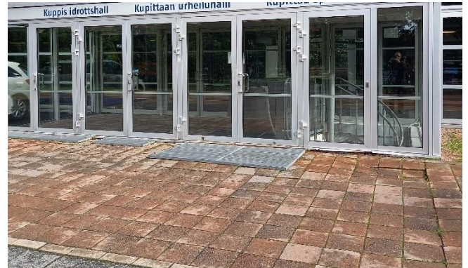
Kuva 11. Ilmanvaihtokonehuoneiden päällä oleva pihakansi on päällystetty betonilaatoituksella pääovien edustalla.
