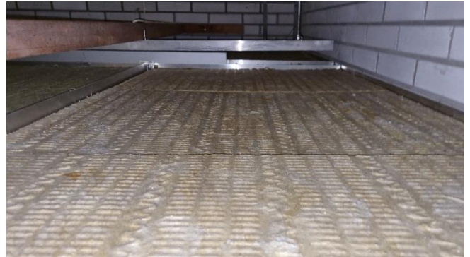
Kuva 114. Katon vanhat akustiikkalevyt ovat yläpuolelta pinnoittamattomat.
