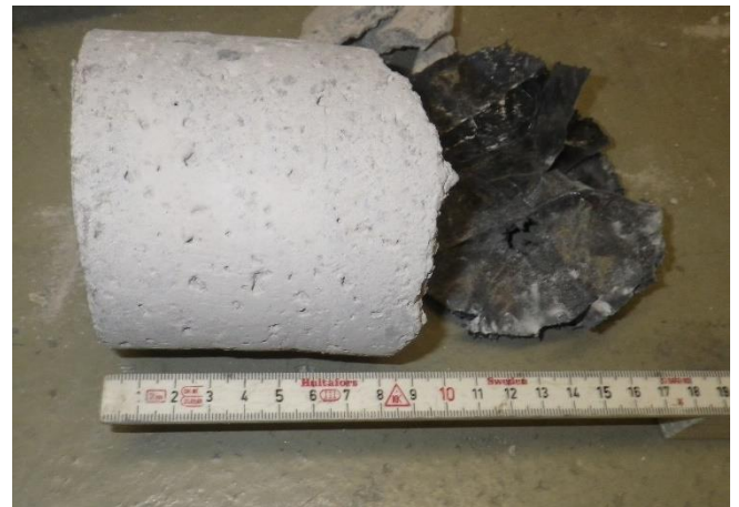
Kuva 36. Avauksen R3 pintalaatta ja sen alla ollut muovi.
