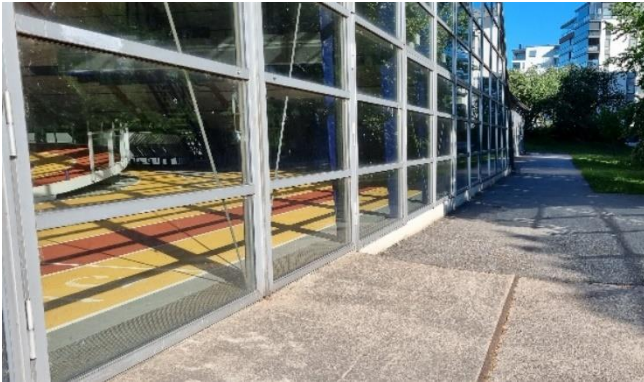
Kuva 10. Koillisen puolella pohjoispäädyssä piha on asfaltoitu, maanpinta on lähes kenttäkerroksen lattian tasossa.
