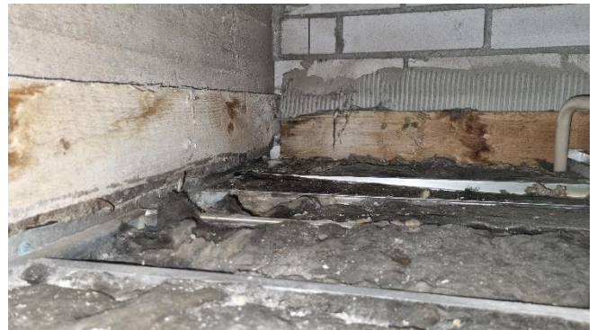
Kuva 116. Keittiön alakaton päällä olevaa likaantunutta villaa.
