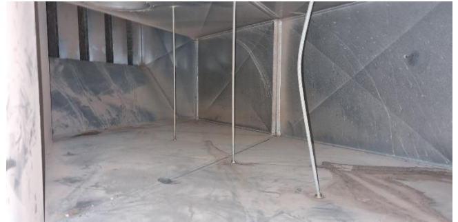
Kuva 138. Koneen päälle tuleva kierrätysilmakanava on likainen.
