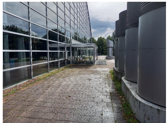
Kuva 101. IV-konehuoneet sijaitsevat pääovien edustalla olevan pihakannen alla.
