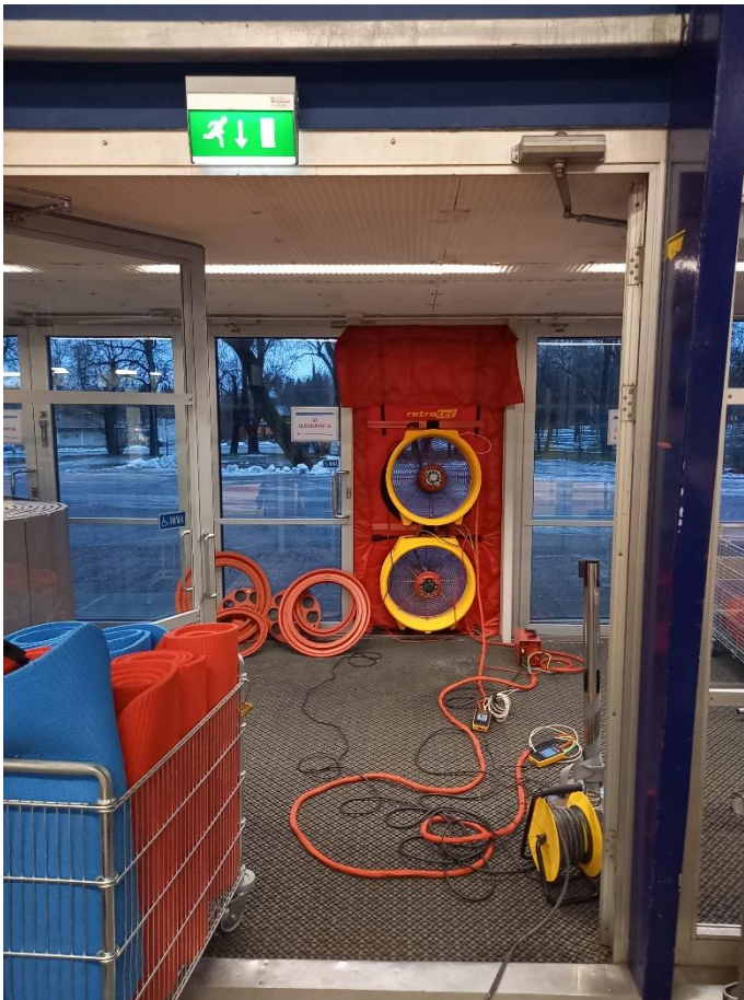
Kuva 1. Alipaineistuslaitteisto asennettuna lounaissivun ulko-oveen.
