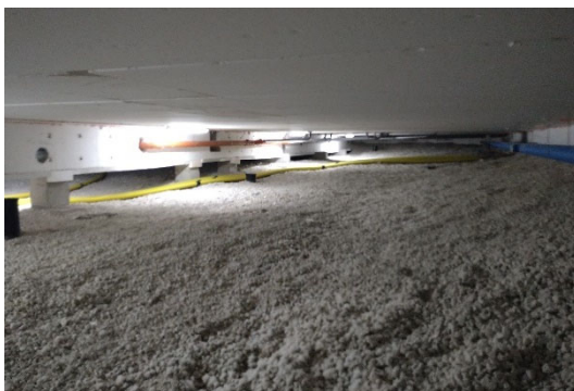
Kuva 1.3. Ryömintätila on aistinvaraisen arvioinnin perusteella toteutettu suunnitelmien mukaisesti ja tuulettuu hyvin.
