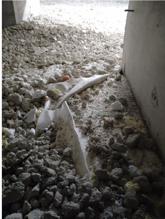
Kuva 1.5. Ryömintätilan pohjalla oli suunnitelmien mukaisesti suodatinkankaan päällä kevyt-betonimurskekerros.
