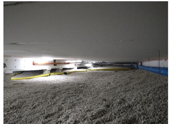
Kuva 3.4. Ilman kulkeutumisesta ryömintätilan eri osien välillä oli huolehdittu palkeissa olevin aukoin ja palkin alle jätetyin ilmaraoin.
