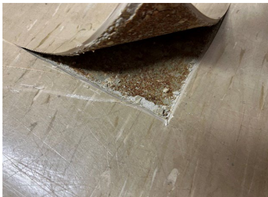
Kuva 1. Luokan 231 muovimaton liima on kovettunut.
