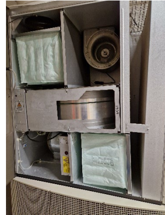
Kuva 4. Ilmanvaihtokoneet ja suodattimet olivat puhtaat. Suodattimet vaihdetaan kaksi kertaa vuodessa.
