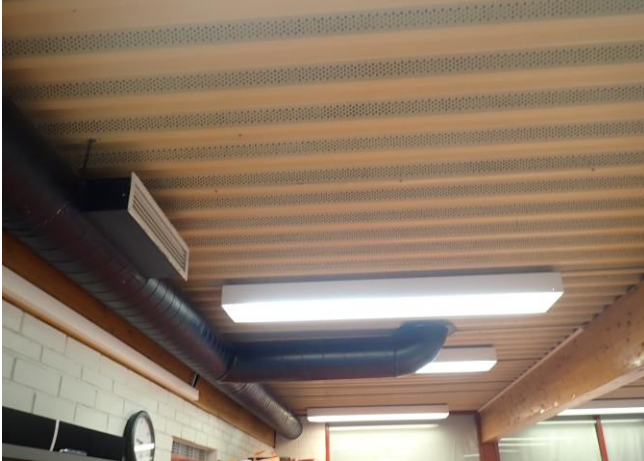
Kuva 1. Tilan katossa poimulevyt
