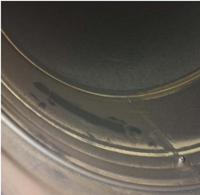
Kuva 4. Näytteenottoaikka KK3, kanavassa pölyä.
