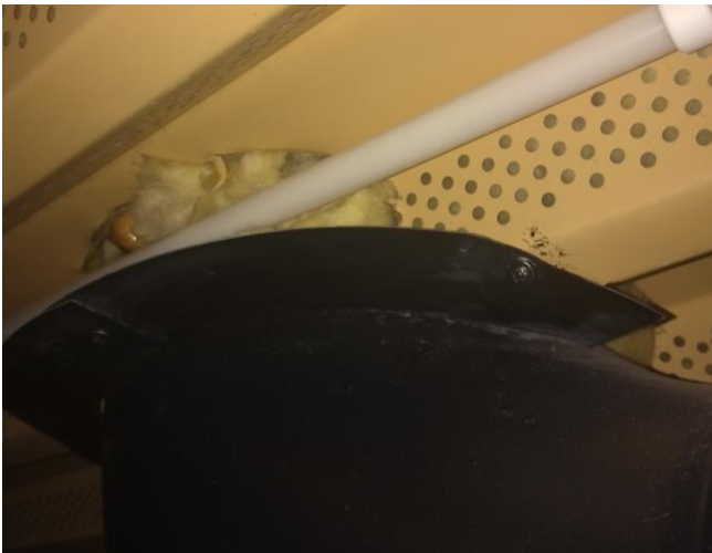
Kuva 3. IV-kanavan läpiviennissä mineraalivillaa ja uretaan-ia.
