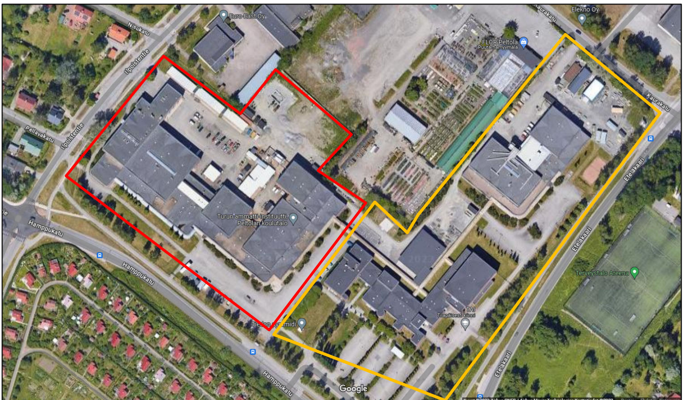
Kuva 1. Tutkimuskohteena oleva B-osa on esitetty punaisella alueella ilmakuvassa. Koulun muut osat on esitetty oranssilla alueella.
