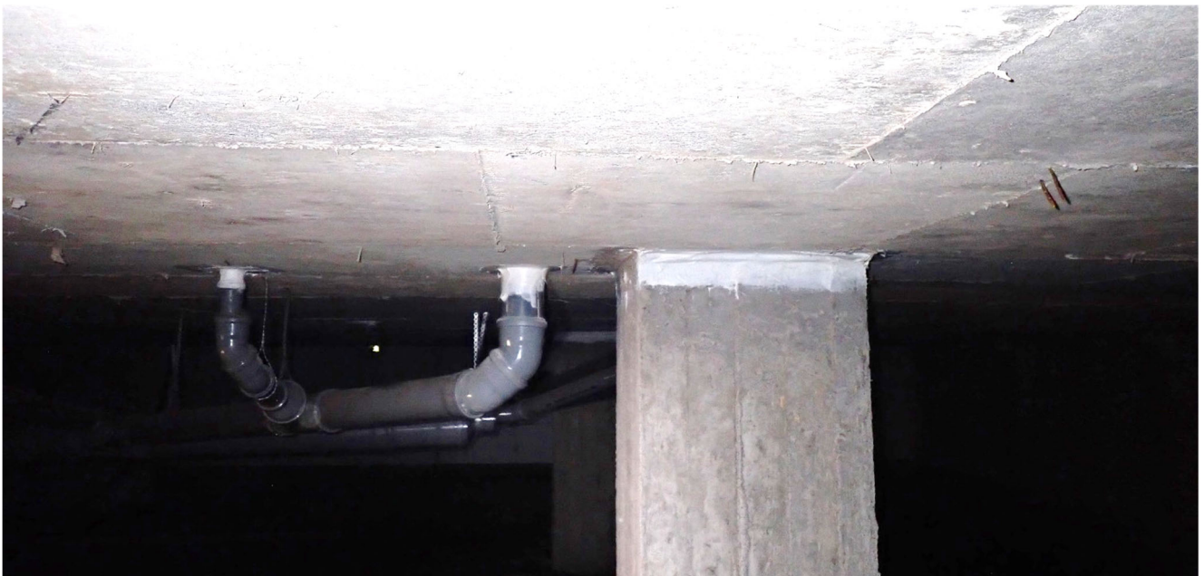
Kuva 17. Alapohjan läpi tulevien viemäriputkien läpiviennit sekä pilareiden liittymät on tiivistetty. Tiivistykset näyttivät huolellisesti tehdyiltä.
