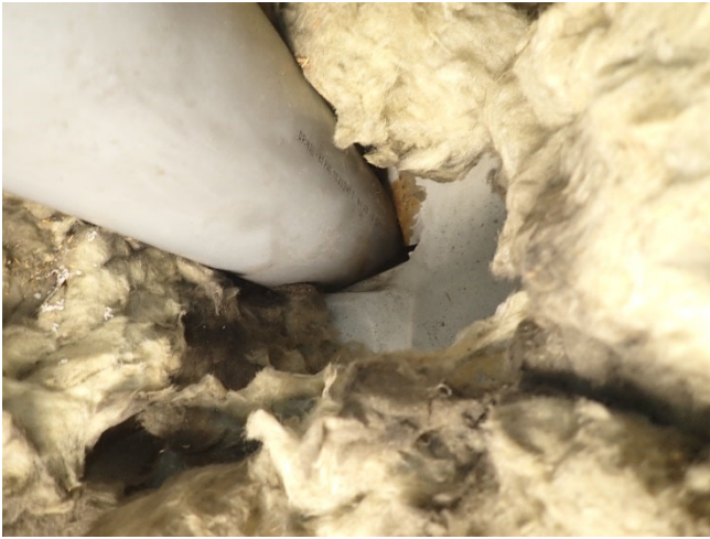
Kuva 41. ja kuva 42. Yläpohjan läpiviennit eivät ole tiiviit.
