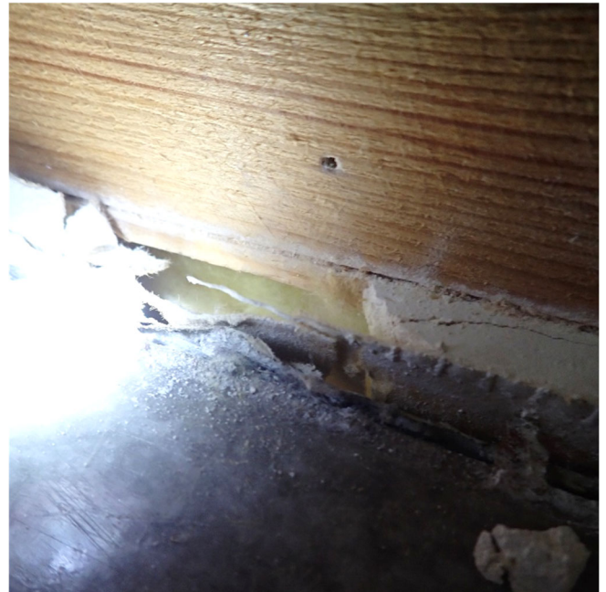
Kuva 36. Alkuperäinen väliseinä, joka alkaa alalaatalta ja tilkkeenä on mineraalivillaa.
