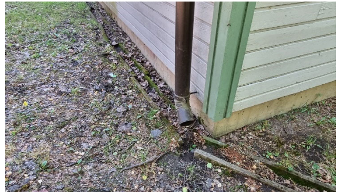
Kuva 9. Betonikouruja rakennuksen pohjoissivulla. Kouruissa on runsaasti puiden lehtiä.
