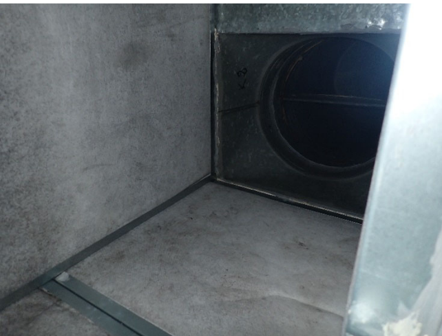
Kuva 52. Äänenvaimentimena tuloilmakoneessa TK01 oli dacron-tyyppistä kangaspintaista materiaalia
