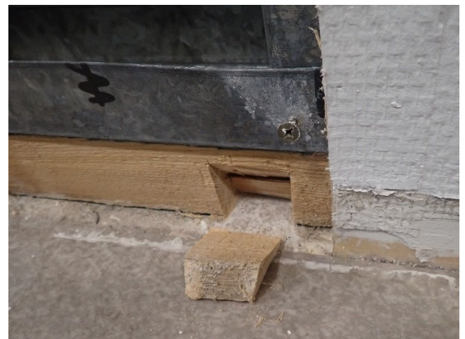
Kuva 34. Pintalaatan päältä alkava väliseinä, jossa metalliranka on alaohjauspuun päällä.
