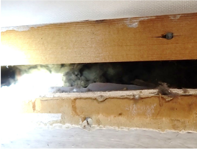
Kuva 29. Ikkunalistan irrotuksen jälkeen näkyy tilkevälieristeenä mineraalivillaa ja höyrynsulkumuovin yläreuna.
