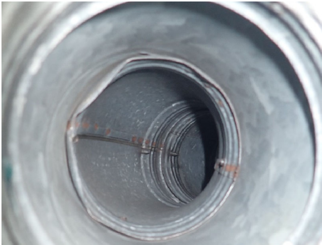
Kuva 48. Kanavissa ei havaittu runsasta pölykertymää
