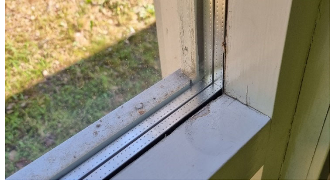
Kuva 7. Kiinteät ikkunat ovat lämpölasia ja ikkunarunko puuta.
