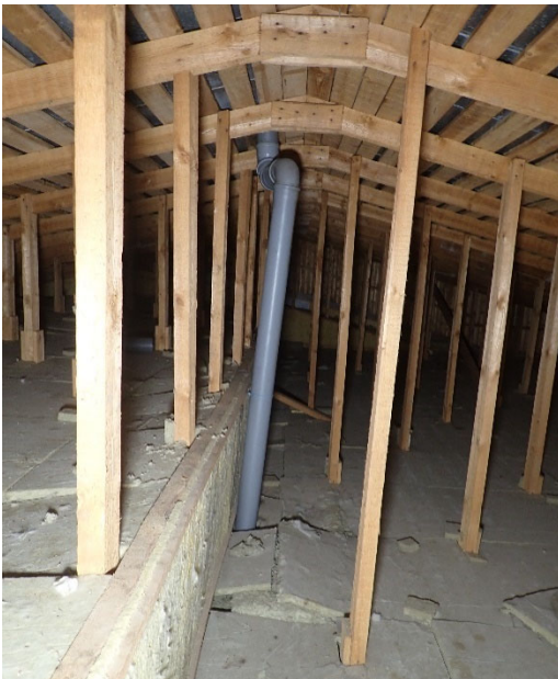
Kuva 39. Yläpohjassa LVI-kanaalit muodostavat suunnitelmien mukaisesti eri tasoja. Viemärin tuuletusputket yms. ovat eristämättömiä. Kuvan putken viereltä on otettu materiaalinäyte M37.
