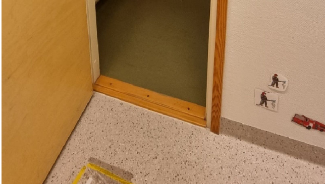
Kuva 6. Käytävillä lattiamatot on vaihdettu, wc- ja varastotiloissa on monin paikoin alkuperäisen näköinen vihreä lattiamatto.
