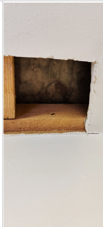
Kuva 18. Yläpohjan rakenneavaus huoneen 138 puolelta.
