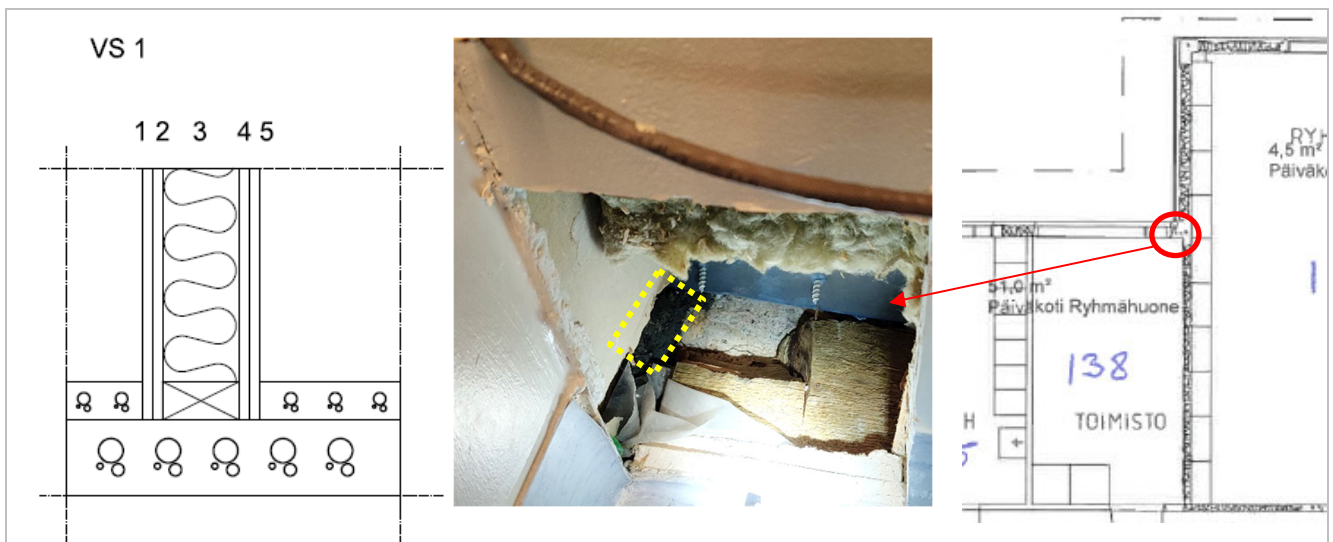
Kuva 14. Tilan 119 vastainen puurunkoinen väliseinä on kantava, jossa alaohjauspuu lähtee ontelolaatan päältä. Alaohjauspuun alla ei ole kapillaarikatkoa. Eristeenä on mineraalivillaa. Ulkonurkkaan tehdystä avauksessa esiintyi mikrobiperäistä hajua. Ikkunaseinän höyrünsulku (kirkas) päättyy ennen tilan 119 höyrünsulkua (sininen), jolloin niiden väliin jää seinärungon levyinen ilmavuotoreitti (keltainen katkoviiva).
