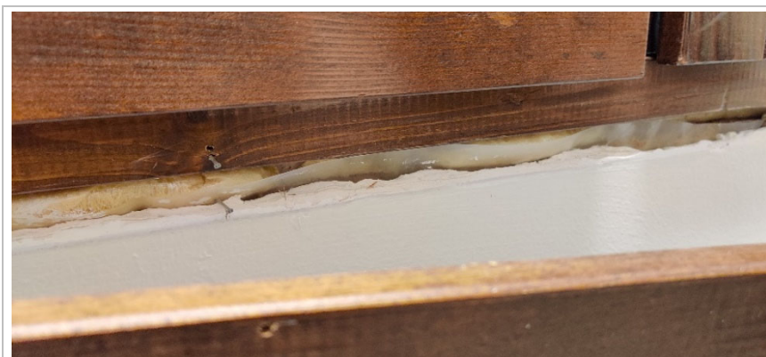
Kuva 13. Ikkunoiden tilkevälieristeet ovat uretaanivaahtoa. Ulkoseinän höyrinsulkua ei ole teipattu ikkunakarmeihin. Lämpökuvauksessa ei kuitenkaan todettu merkittäviä ilmavuotoja.
