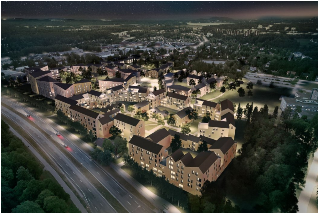
Kuva 48. Kaupunginpuutarhan alueen havainnekuva (Kuva: UKI Arkkitehdit Oy, Arkkitehdit MY Oy ja HIMLA arkkitehdit Oy, 2020).
