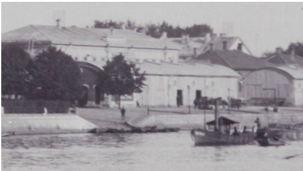
Kuvassa näkyy tavarasuojan eteläpuoleinen pääty ja alkuperäiset aukotukset. Nykyisen ikkunan paikalla on ilmeisesti ollut ovi tai korkea ikkuna, ovi on ollut hieman erilainen. Niiden yläpuolella on ollut vaalea kaaridetilji. Kuvaaja N. Hauvonen, 1895. TKM. Kuvaa on rajattu, kuva alkuperäisellä rajauksella sivulla 10.
