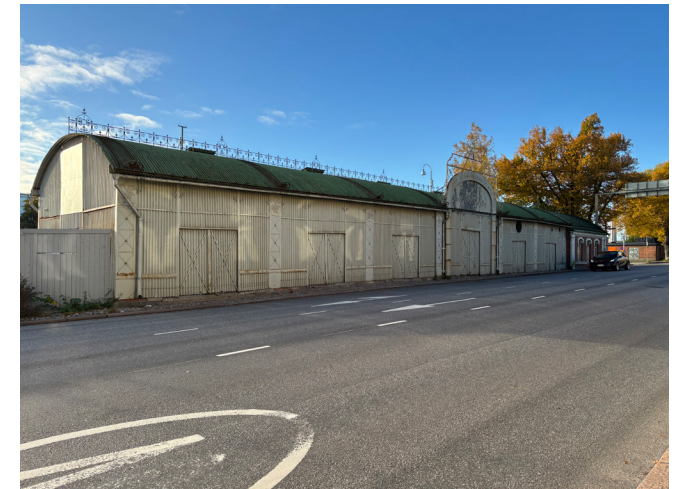
5. Rakennuksen vierustalla Linnankadun ajorataa vasten rajaa ainoastaan kapea kaistale mukulakiveystä.
