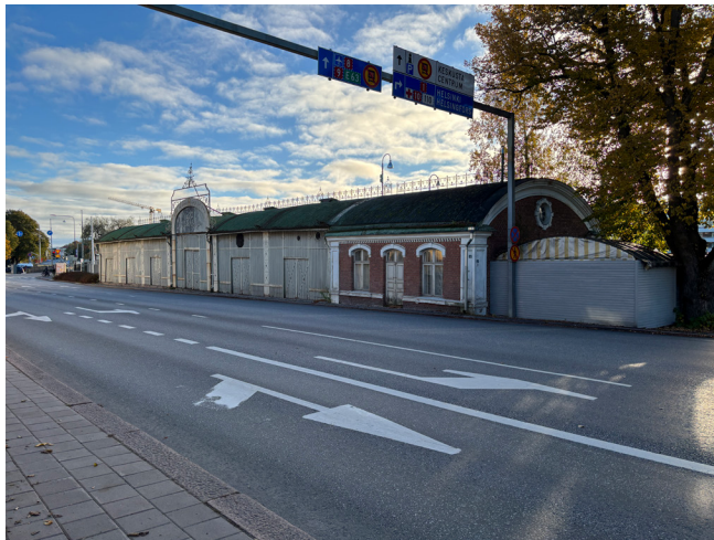
3. Tiilirakenteisen osan julkisivu Linnankadulle on alkuperäinen. Ovi ei ole käytössä ja se on peitetty sisäpuolelta. Kulku ovesta olisi lähes suoraan ajoradalle. Aikaisemmin vieressä kulki jalkakäytävä.
