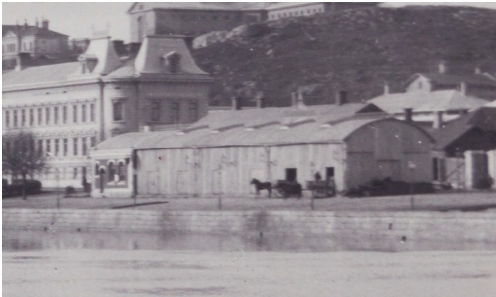
Tavarasuoja rajattuna arviolta 1890-luvun lopun valokuvassa. Kuvassa erottuu tiilirakenteisen osan joen puoleiset ikkunat ja ovi. Varasto-osassa näkyy hyvin joenpuoleiset ovet ja kattoikkunat. Kuvaaja N. Hauvonen. TKM. Kuvaa on rajattu, kuva alkuperäisellä rajauksella sivulla 3.
