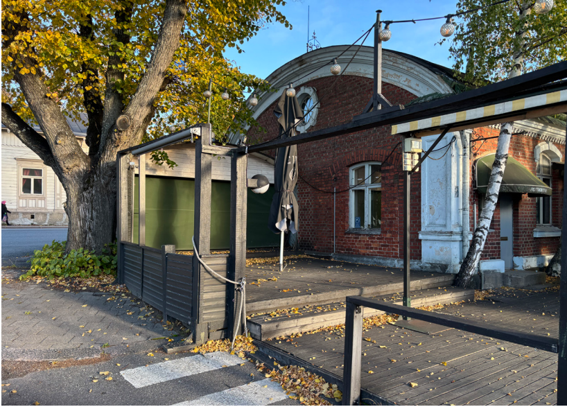
6. Rakennuksen lounaispuolen päädyn alaosan aukotusta on muutettu, todennäköisesti 1920- ja 1930-luvuilla. Julkisivuissa näkyy muutosten jälkiä. 1890-luvun valokuvan perusteella ikkunan kohdalla oli ovi ja viereinen ovi oli hieman eri kohdassa, niiden yläosa oli samankaltainen rapattu kaaridetelji kuin muissa aukoissa. Nykyään terassirakennelmat peittävät julkisivuja.
