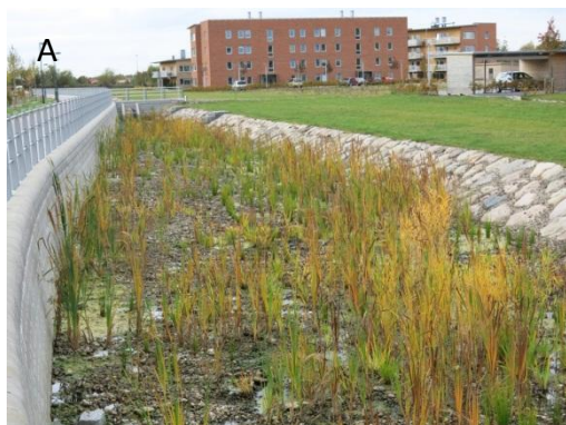
Kuva 25 A) Esimerkki Malmölaisesta eroosiosuojatusta avouomasta ja tulvatasanteesta. Tulvatasanteen levyes 30 m. B) Saukonojan painauma (Kuvat: Leena Sänkiäho)
