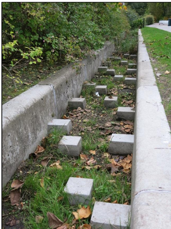
Kuva 10 Avokanava ja vikerpainanne hulevesien johtamiseen (Kuvat Leena Sänkiaho)
