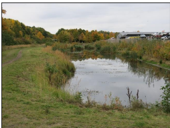
Kuva 11 Hulevesilampi, jossa pysyvä vedenpinta ja hulevesikosteikko (Kuvat Leena Sänkiaho)
