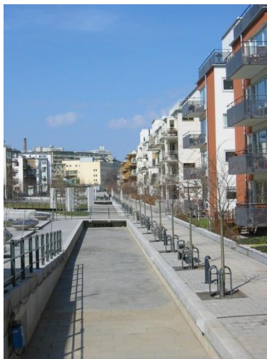
Kuva 21 Hulevesien johtamista maanpäällisissä kanavissa, Hammarby-Sjöstad Tukholma (Kuva Elina Kataja)
