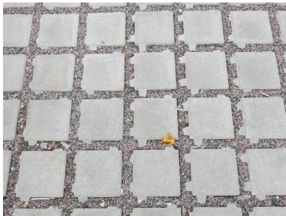
Kuva 8 Viherkattokasveja ja läpäisevä kivetys (Kuva: Leena Sänkiäho)
