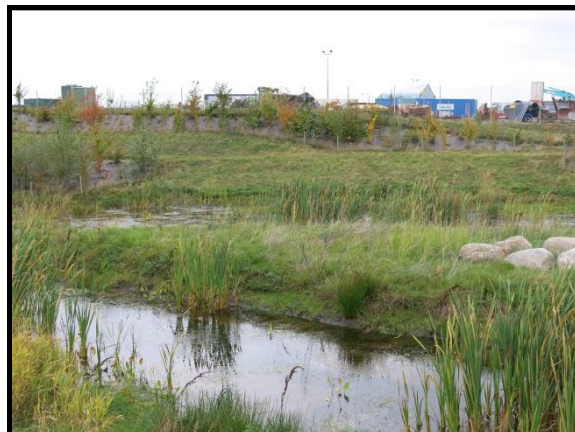
Kuva 11 Hulevesilampi, jossa pysyvä vedenpinta ja hulevesikosteikko (Kuvat Leena Sänkiaho)
