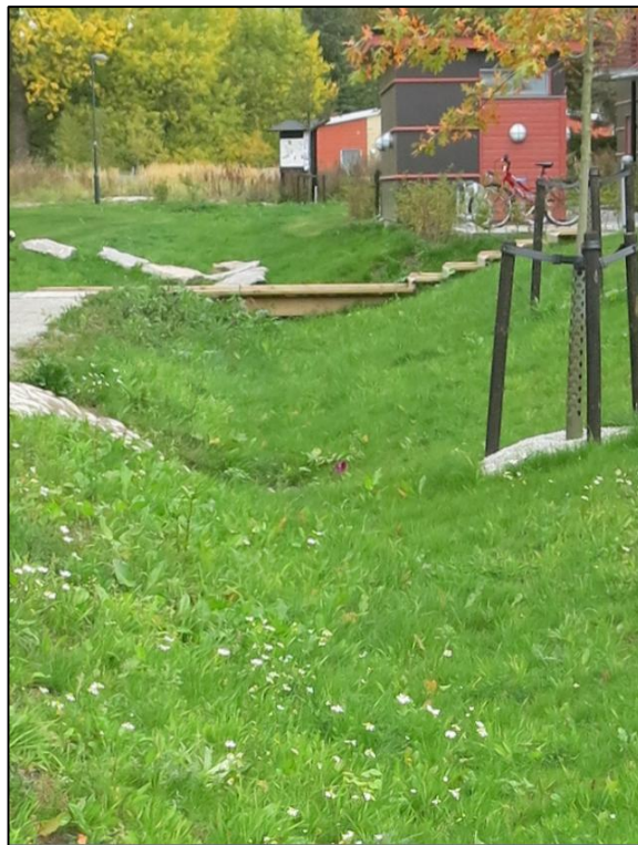
Kuva 10 Avokanava ja vikerpainanne hulevesien johtamiseen (Kuvat Leena Sänkiaho)
