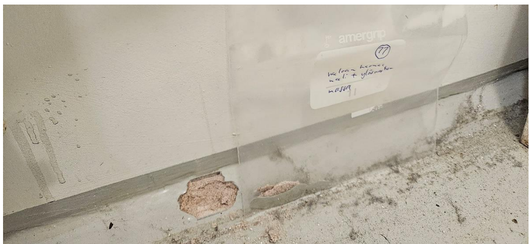
Kuva 28. Vaaleanharmaa maali ja ylösnoston massa ( näyte 11 ) eivät sisällä asbestia.
