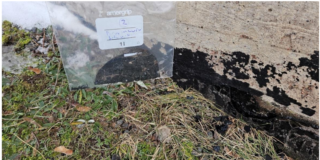
Kuva 19. Perusmuurin vedeneriste, bitumisively/-huopa ( näyte 2 ) ei sisällä asbestia
