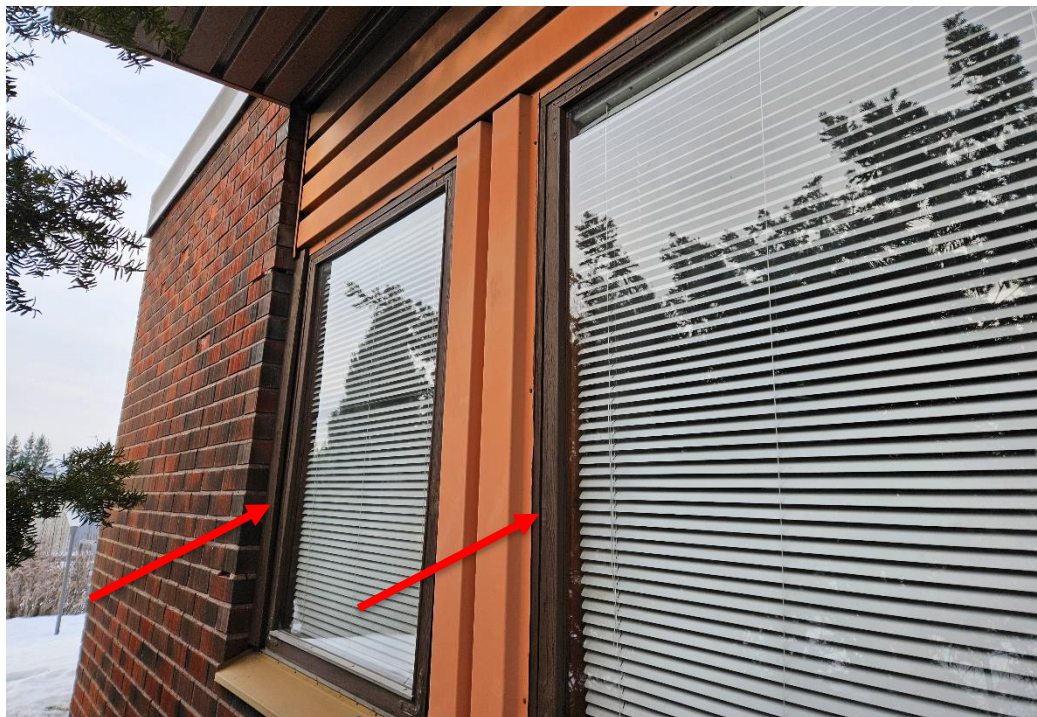
Kuva 24. Puuikkunoiden maalit ( näyte 7 ) eivät sisällä asbestia
