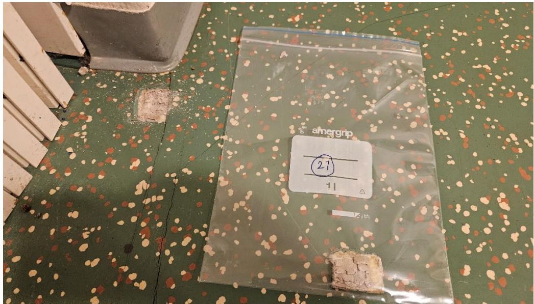
Kuva 33. Vihreä pilkullinen muovimatto + keltainen liima + harmaa tasoite ( näyte 21 ) eivät sisällä asbestia.
