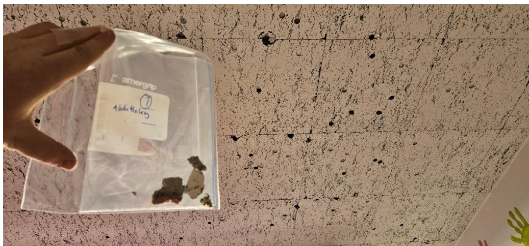
Kuva 18. Alkuperäinen alakattolevy (näyte 1) ei sisällä asbestia.
