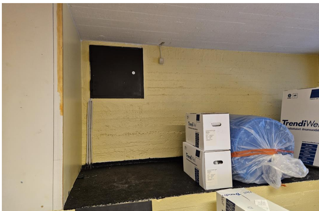
Kuva 17. Öljysäiliötilan paloluukku. Paloluukussa ja sen karmeissa voi olla asbestipitoisia materiaaleja.
