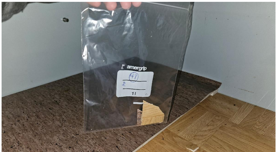
Kuva 46. Kylmiön tasojen muovimatot ( näyte 41 ) eivät sisällä asbestia.
