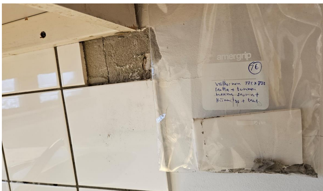
Kuva 9. Valkoinen laatta 150x150 mm + tummanharmaa saumalaasti ja vaaleanharmaa ta-soite / kiinnitysaine ( näyte 16 ). Asbesti on vaalean harmaassa tasoitteessa / kiinnitysai-neessa.
