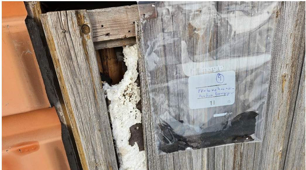
Kuva 26. Vesikaton IV-konehuoneen luukun tervapaperit ( näyte 9 ) eivät sisällä asbestia.
