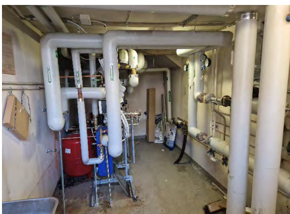
Kuva 22. Yleiskuva lämmönjakuhuoneen alapohjarakenteesta.
