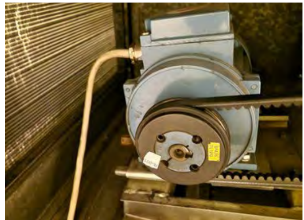
Kuva 183. Hihnapyörä on liian iso hihnaan nähden.
