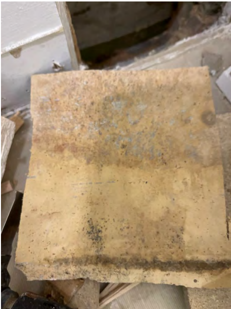
Kuva 74. US2, vanhan tapetin taustalla havaittiin mikrobikasvustoon viittaavaa tummentumaa.
