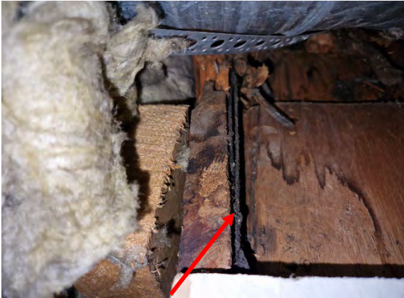
Kuva 143. Toisen vanhemman rakennuksen entisen ulkoseinän, nykyisen väliseinä rakenteisiin jätettyjä ulkoverhousrakenteita (kermi, ulkovuoraus)
