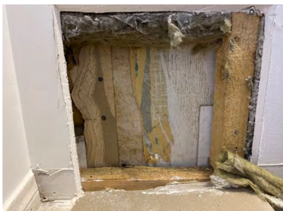
Kuva 70. US1, mineraalivillan takaa löydettiin 5-6 kerrosta vanhaa tapettia.
