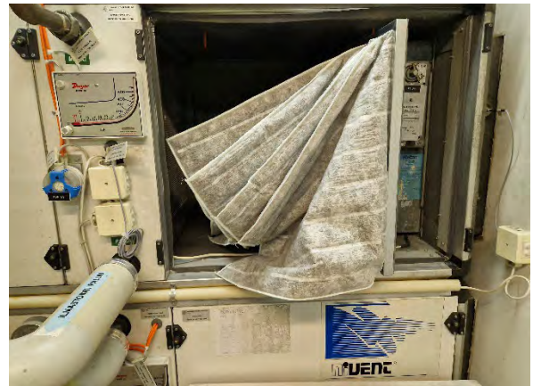
Kuva 181. Suodattimet olivat vielä melko puhtaat.
