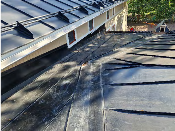
Kuva 169. Yleiskuva laajennusosan liitoskohdan toteutuksesta.
