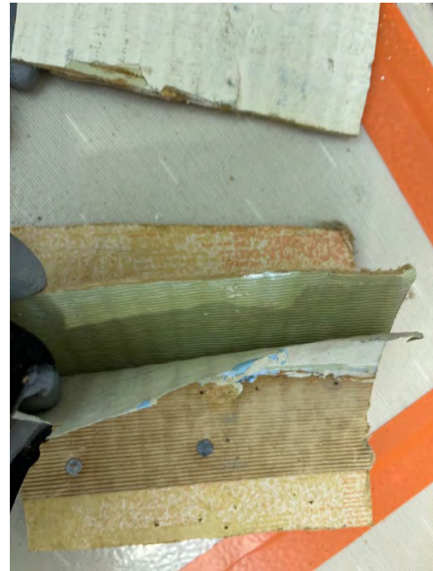
Kuva 97. Rakenteessa tapetti- ja levykerroksia.
