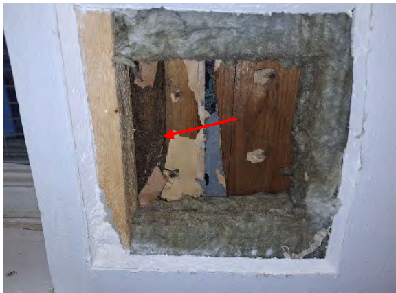
Kuva 101. IKK1, pellavarive eristeenä ikkunan ja karapuun välissä.
