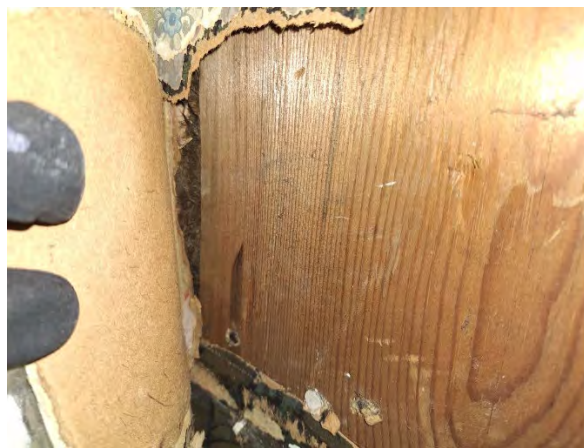
Kuva 88. US5, noin 200 mm leveä pystyhirsi.
