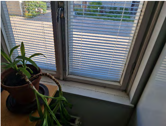
Kuva 108. Ikkunoiden ympäristän toteutusta.
