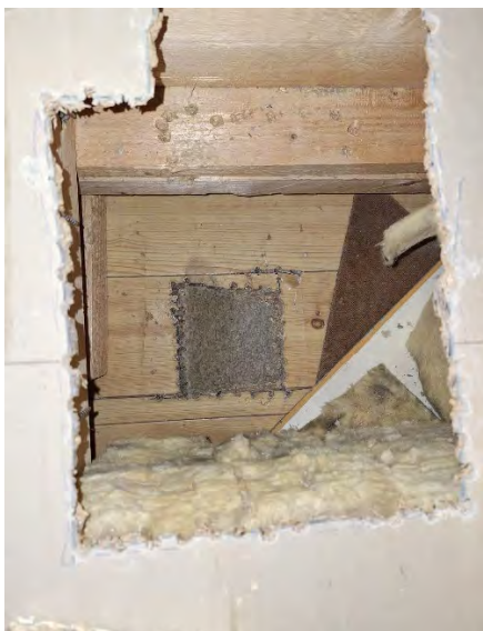
Kuva 51. Rakenneseavaus AP7 yhteydessä löydettiin useampi muovimattokerros.
