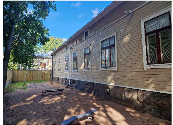
Kuva 59. Vanhemman rakennuksen julkisivua.
