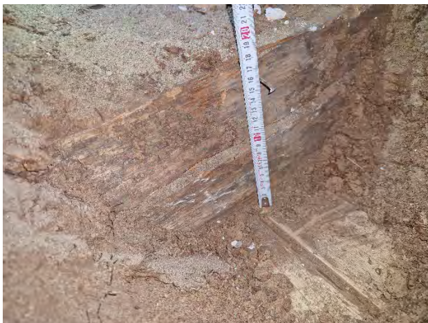
Kuva 173. Rakenneavaus YP4 eristepaksuus sekä aluslaudoitus.
