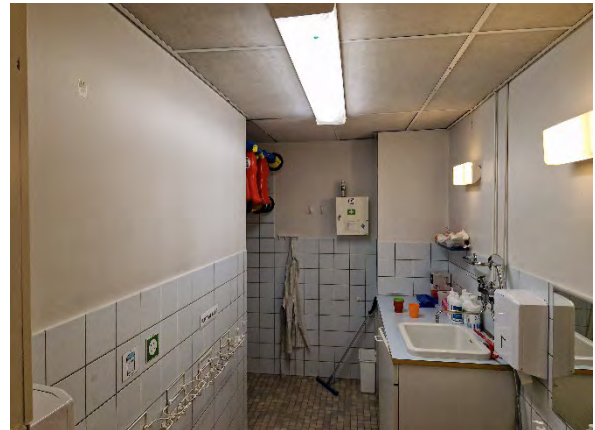
Kuva 136. Yleiskuva laatoitettujen tilojen pintarakenteista.
