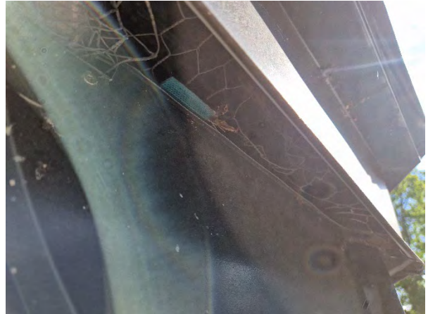
Kuva 170. Laajennusosan keskellä oleva rakenne toimii tuuletushormina.
