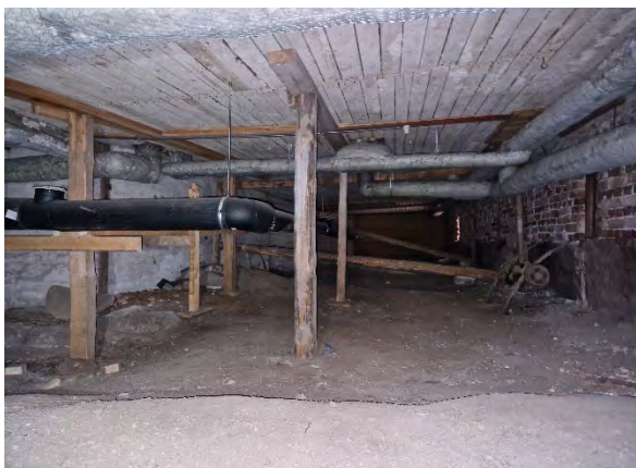
Kuva 10. Vanhempien osien ryömintätilojen toteutukset ovat lähes yhtenäisiä.
