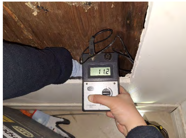
Kuva 149. Rakenneavauksen yhteydessä mitattu alaohjauspuun kosteus piikkimittarilla.
