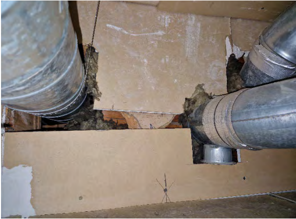
Kuva 141. Väliseinän läpivientien toteutusta vanhempien rakennusten osalta.
