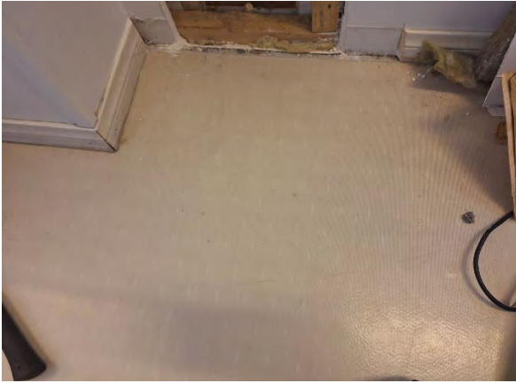
Kuva 36. AP4, alkutilanne ennen rakenneavausta.
