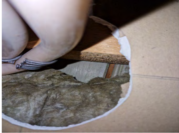
Kuva 160. Vanhempien rakennusten kattopaneelien alapuolelle on asennettu lisälämmöneristys ja kipsilevyrakenne.
