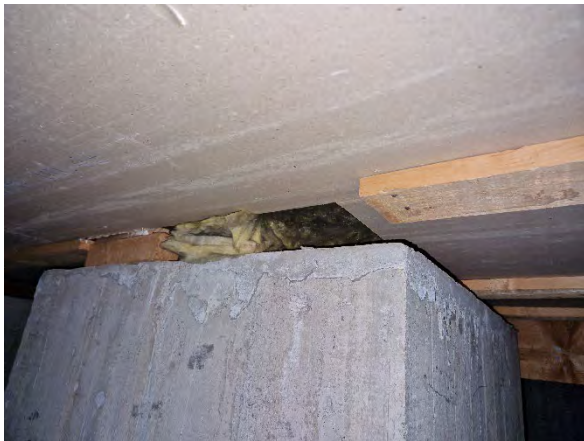
Kuva 120. Laajennusosan katon kannatuspilarin kohdan rakenne on avoin alustatilaan.
