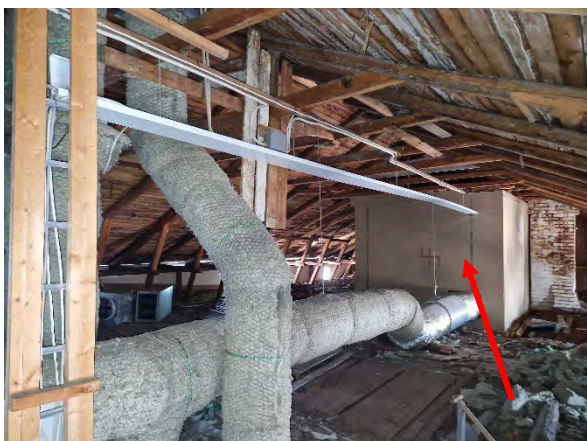
Kuva 155. Yläpohjatiloihin on lisätty ilmanvaihtokonehuonetiloja.
