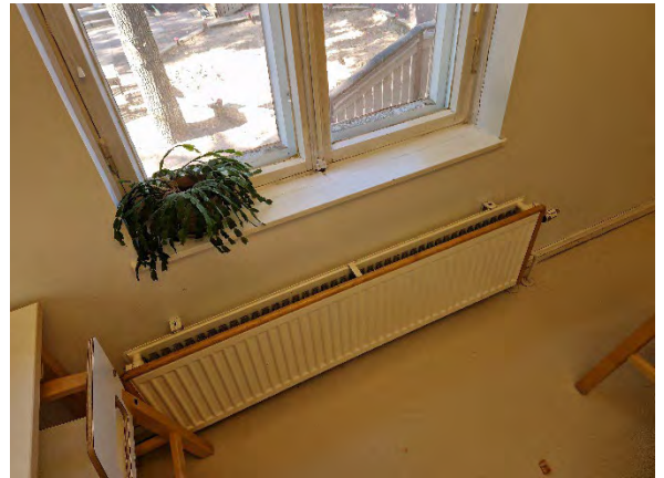
Kuva 67. Ulkoseinien sisäpinnat ovat maalattupintaista kipsilevyä.
