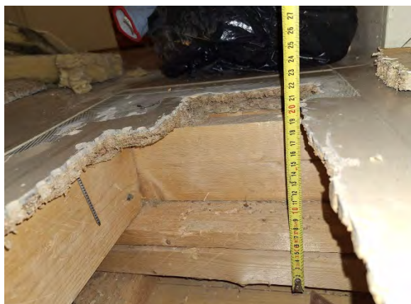
Kuva 50. AP7, lastulevyn alapuoliset koolaukset.
