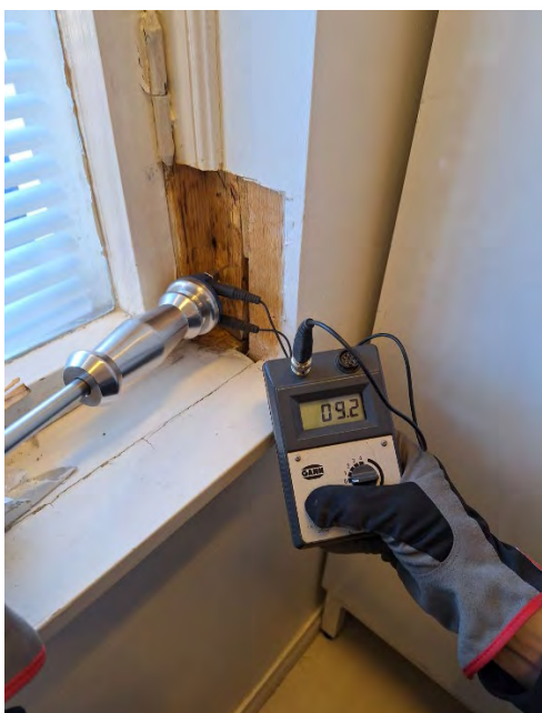
Kuva 106. IKK2, koolauspuusta tarkastettiin kosteuspitoisuus piikkikosteusmittarilla.
