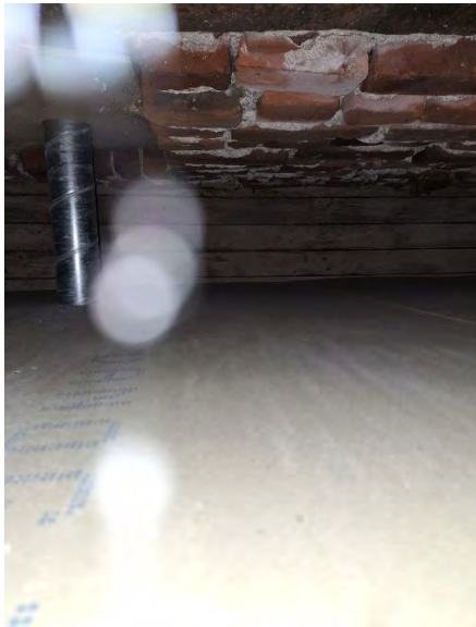
Kuva 83. Rakenneavaus US4, seinärakenteen ja perusmuurin välinen ilmaväli.
