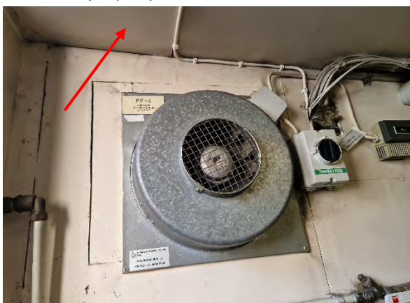
Kuva 116. Lämmönjakohuoneen välipohjan pintarakenteena on kipsilevytyks.
