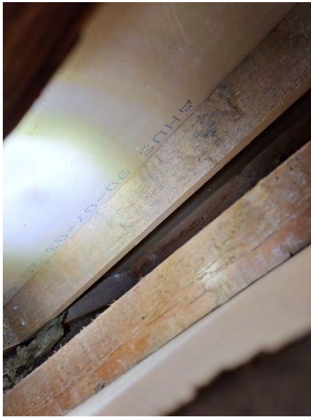
Kuva 152. VS2, seinärakenne avauskohdasta sivulle päin.
