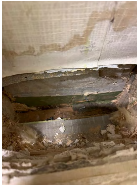
Kuva 75. Tapetissa havaittiin kosteusjälkiä.
