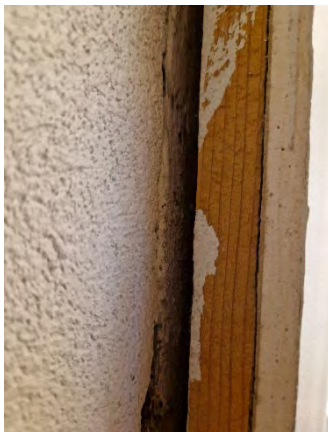
Kuva 139. Vanhempien rakennusten väliseinärakenteet ovat sisäverhousrakenteiden taustalta avoimia takkojen kohdalla.
