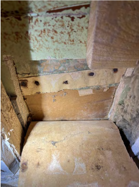
Kuva 72. US2, ensimmäisen lastulevyn takaa löytyi useampi kerros vanhaa tapettia.
