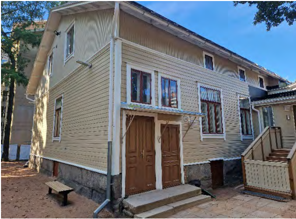
Kuva 58. Käsityöläiskadusta kauempana olevan vanhemman rakennuksen julkisivua.
