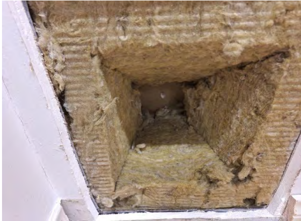
Kuva 76. Rakenneavaus US3, höyrynsulkupaperin takana oleva mineraalivillaaeristekerros.
