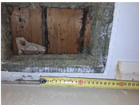
Kuva 89. Rakenneavaus US6, alkuperäinen hirsirunko. Hirren leveys n. 100 mm.
