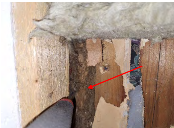
Kuva 98. Rakenneavaus IKK1. Rakenneavaus tehtiin ikkunan ja ulkoseinän liittymään.
