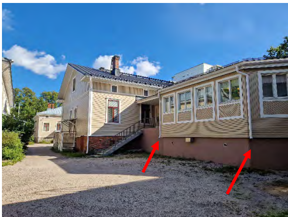
Kuva 174. Yleiskuva keittiön sisäänkäynnin luota. Piha-alueet ja sokkelin vierustalla sorastus. Sadevedet ohjataan suoraan rakennuksen seinustalle.
