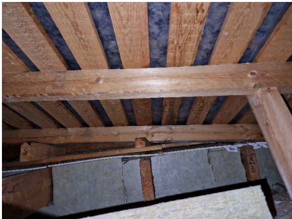
Kuva 161. Yleiskuva laajennusosan yläpohjan tuuletustilasta.
