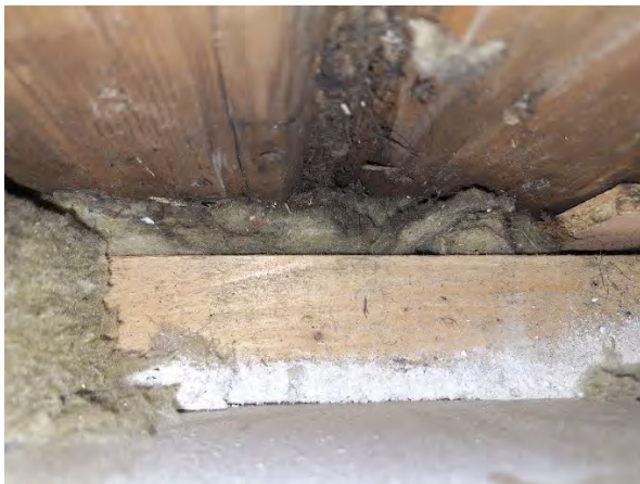
Kuva 90. US6, sisäpuolisen koolauksen alaohjauspuu.
