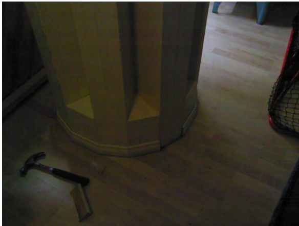
Kuva 131. Laajennusosan katon kannatuspilarin rakennetta.
