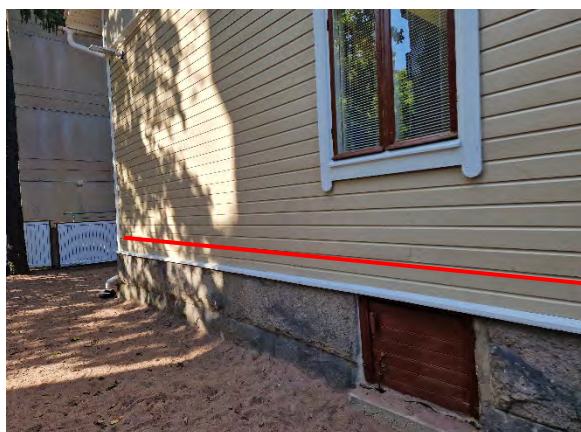
Kuva 21. Vanhempien osien alapohjan sijaitsee maanpintaan nähden korkealla, kuvassa viitteellinen sijainti punaisen viivan kohdalla.
