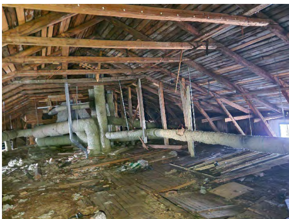
Kuva 156. Yleiskuva Käsityöläiskadusta kauempana olevan rakennuksen yläpohjatilasta.
