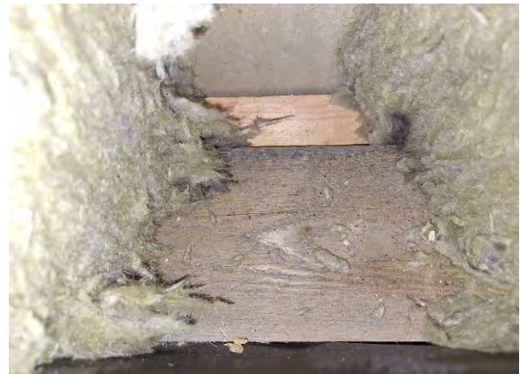
Kuva 78. Rakenneavauskohta US3. Runko 150 mm ja 50 mm eristekerros ulkopuolella.
