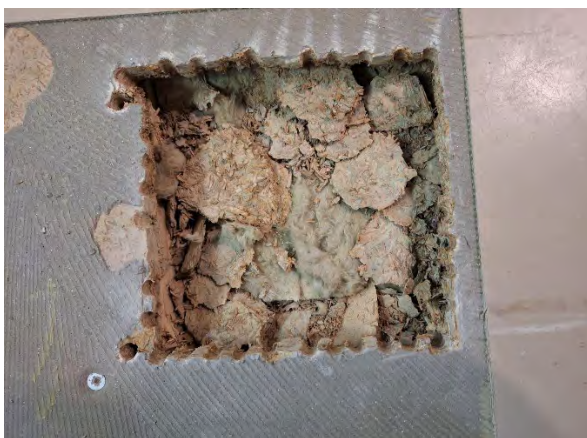
Kuva 129. Rakennearaus VP3 lastulevy murenevaa.
