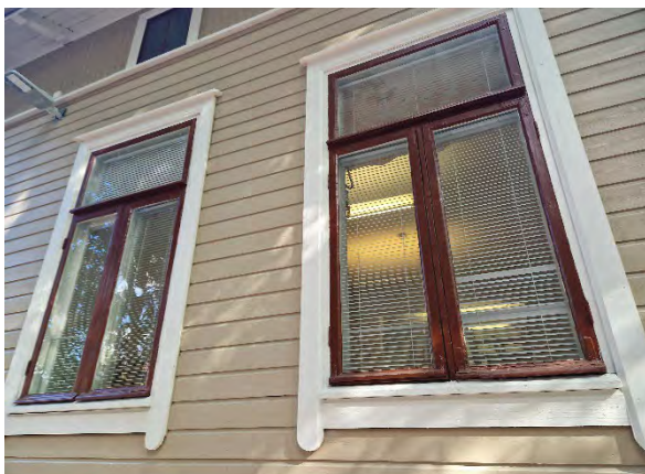
Kuva 64. Yleiskuva vanhempien rakennusten ikkunoista.
