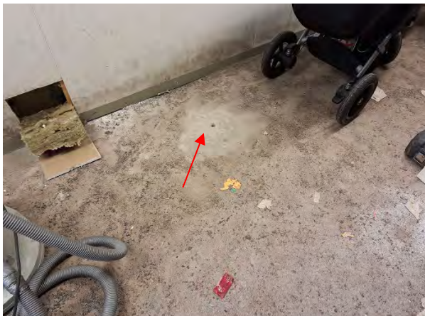
Kuva 28. Rakenneavauskohta AP1 kellarin lastenvaunuvarastossa.
