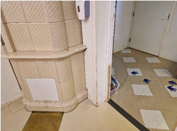
Kuva 2. Yleiskuva vanhempien osien lattiapinnoitteista.
