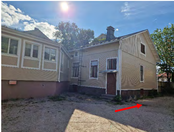
Kuva 176. Piha-alueella havaittiin muutama sadevesikaivo.
