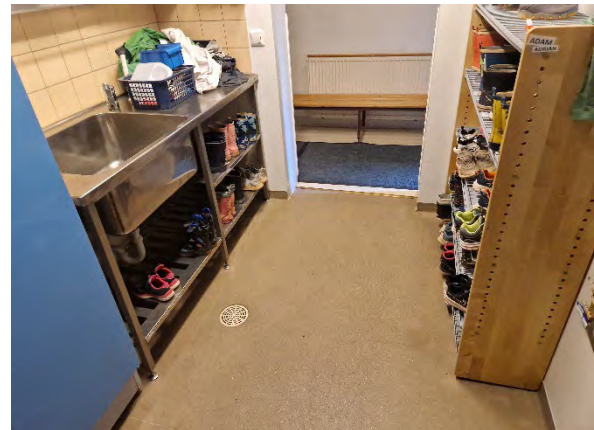
Kuva 5. Kuivaushuonetilojen lattiapintoina on muovimattoa.
