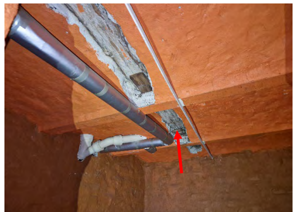
Kuva 11. Ryömintätiloissa on sisäilmaltaan ummehtuneita kellaritiloja ja osittain alapohjaa vasten oleva rappaus on pudonnut paljastaen puurakennetta. Toisen rakennuksen kellaritiloissa on rappaamatonta tiiliholvia.
