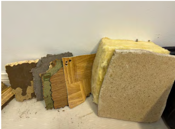
Kuva 34. VP1, rakenneavauksen yhteydessä puretut rakennekerrokset.
