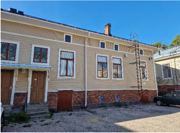
Kuva 56. Käsityöläiskatua lähempänä olevan rakennuksen julkisivua.
