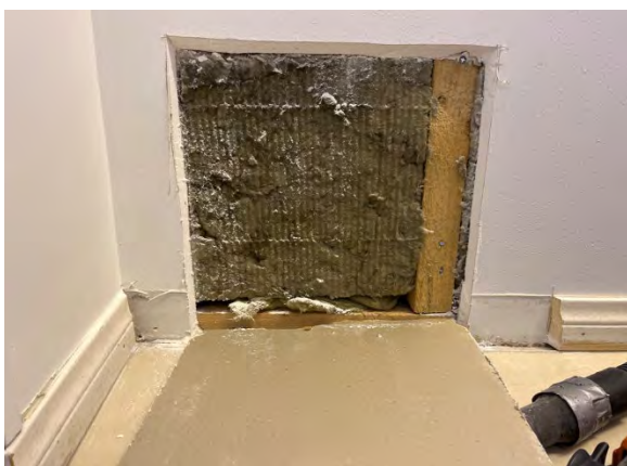
Kuva 69. US1, kipsilevyn takana puukoolaus sekä mineraalivilla.
