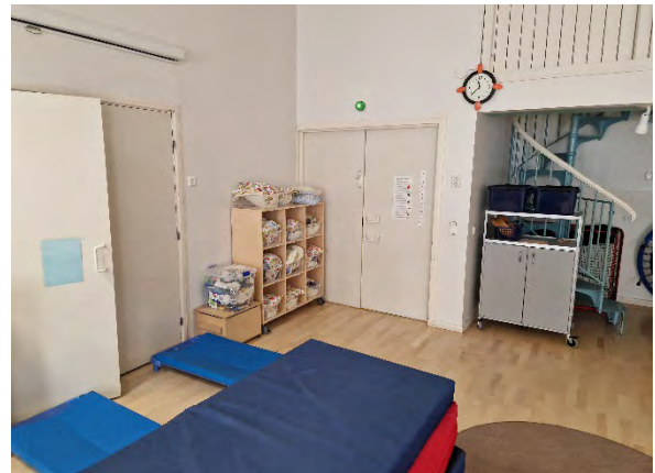
Kuva 138. Yleiskuva laajennusosan väliseinärakenteista.
