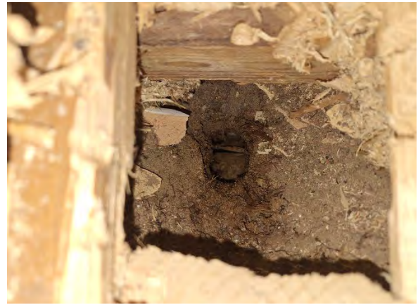
Kuva 39. AP4, alimman lankkulattian alla havaittiin sahanpurueriste sekä hiekkatäyttö, jonka alla oli sammal-/turvetäyttö.
