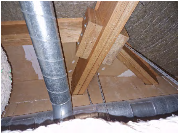
Kuva 162. Laajennusosan vesikaton kannatusrakenteita.
