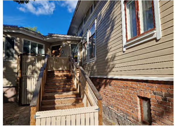
Kuva 57. Vanhemman rakennuksen ja laajennusosan julkisivurakenteita.
