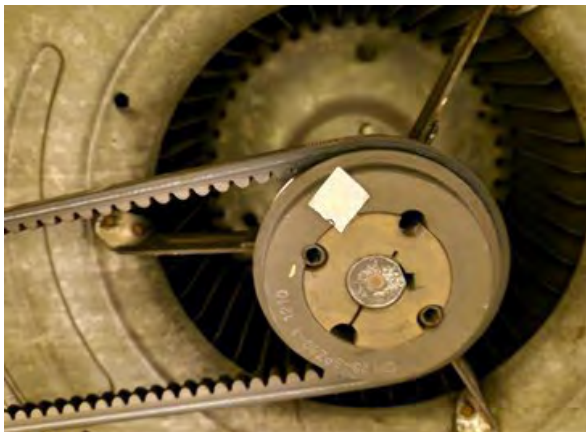
Kuva 182. Hihnapyörä on liian pieni hihnaan nähden.
