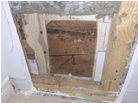
Kuva 68. Rakenneavaus US1, tapettikerrosten takana alkuperäinen hirsirunko.
