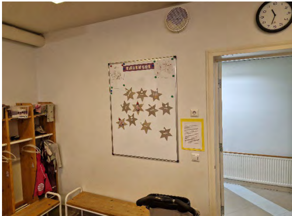
Kuva 135. Yleiskuva vanhempien rakennusten väliseinärakenteista.
