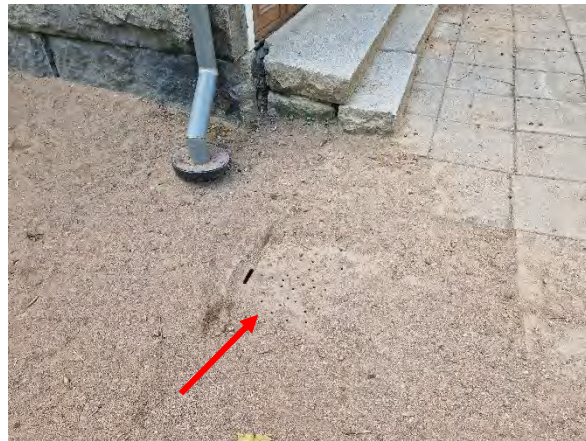
Kuva 179. Sadeveden ritaläkaivo hiekan peitossa.
