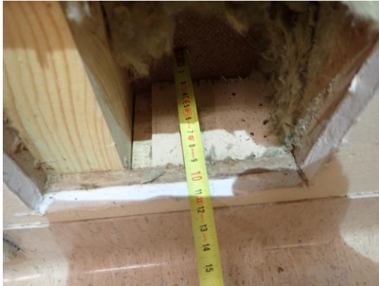
Kuva 149. Rakenneavaus R23. Avaus tehtiin B-osan luokkatilan OT3 käytävän puoleisen väliseinän alaosaan. Rakenneavauksesta otettiin näyte N8 (mineraalivilla) mikrobianalyyysiin. Näytteessä ei esiintynyt mikrobikasvustoa.
