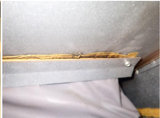
Kuvat 307 ja 308. Yleiskuvat tuloilmapuhaltimesta ja sen puhallinkauluksen liitoksesta. Kauluksen liitoksen tiivistyksessä havaittiin vähäisiä vuotojälkiä. Vastaava havainto tehtiin poistoilmapuhaltimen osalta.
