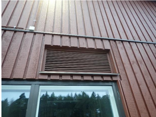
Kuvat 343 ja 344. Yleiskuvat ilmanvaihtokoneiden ulkoilmanotoista. Vasemmassa kuvassa on B-osan tuloilmakoneen ulkoilmasäleikkö ja oikeassa kuvassa C-osan ilmanvaihtokoneen ulkoilmasäleikkö.
