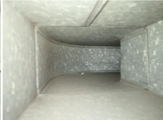
Kuvat 355 ja 356. Yleiskuvat 70-luvulta olevasta tuloilmakäytössä olevasta suorakaidekanavasta. Kanavassa oli havaittavissa hieman pölyä.
