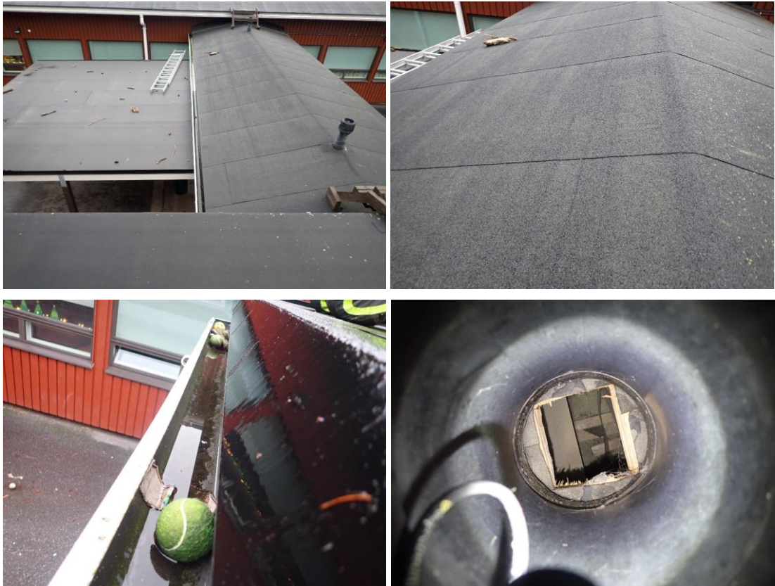
Kuvat 203, 204, 205 ja 206. B- ja C-osan välinen yhdyskäytävä ja sisäänkäynnin katos. Katteessa on havaittavissa vähäistä pinnan halkeilua ja sammal- tai jäkäläkasvustoa. Sisäänkäyntikatoksen sadevesikouru oli tukossa tennispalloista. Pallot poistettiin tutkimuksen yhteydessä. Yläpohjatila tuulettuu räystäiden ja harjatuuletusventtiilien kautta. Havaintojen perusteella vanha vesikattorakenne on paikoillaan ja siihen on tehty tuuletusaukkoja.
