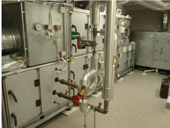
Kuvat 322 ja 323. Yleiskuvat ilmanvaihtokoneesta TK04 ja sen rakennusautomaation käyttöpaneelista. Käyttöpaneeli ei havaintojen perusteella toiminut.
