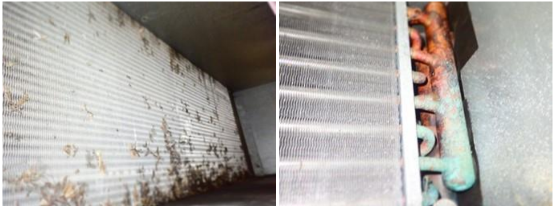
Kuvat 316 ja 317. Yleiskuvat lämmityspatterista suodattimen puolelta ja tuloilmapuhaltimen puolelta. Suodattimen puolella oli paljon kuolleita hyönteisiä patterin pinnalla, ja puhaltimen puolella havaittiin pinnallista hapettumaa kupariputkissa.
