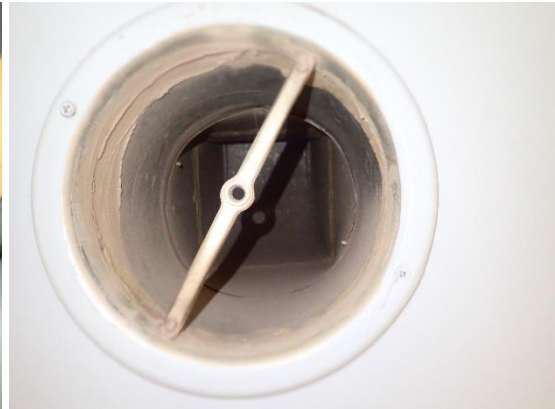
Kuvat 357 ja 358. Yleiskuvat 70-luvulta olevasta poistoilman lautasventtiilistä ja poistoilmakanavasta. Poistoilmakanava jatkuu muunnososan jälkeen suorakaidekanavana. Kanavassa oli havaittavissa hieman pölyä.
