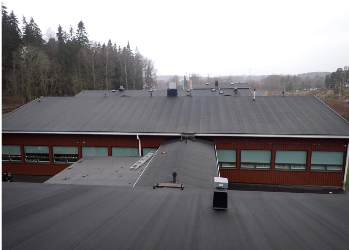
Kuva 162. Yleiskuva rakennuksen C-osan vesikatolta kuvattuna länteen.
