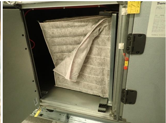
Kuvat 324 ja 325. Yleiskuvat esisuodattimen suodatinosasta ja hienosuodattimesta. Suodatinosat olivat siistikuntoiset, eikä niissä havaittu kosteuden aiheuttamia jälkiä.
