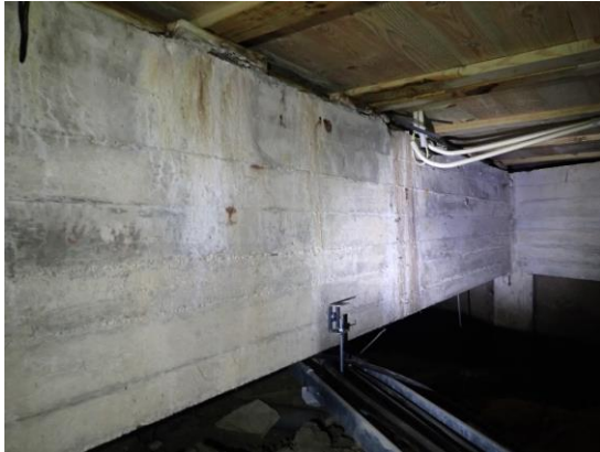
Kuvat 46 ja 47. Keittiötilan astioiden palautuspisteen alapuolella rakenteissa havaittiin vanhoja kosteusjälkiä ja paikallisia vaurioita puurakenteissa. Puunkosteus piikkikosteusmittarilla mitattuna oli hieinan muuta alapohjan puurakenteita korkeampi (p% 18,5) (muualla ~p% 15–16).
