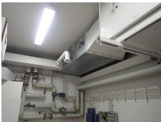
Kuvat 347 ja 348. Yleiskuvat 70-luvulta olevaan ilmanvaihtokanavistoon uusituista äänenvaimennusosista. Vasemmassa kuvassa äänenvaimennettu tuloilman kokoojakammio-/kanava. Oikeassa kuvassa on uusittu kanava - äänenvaimennin.
