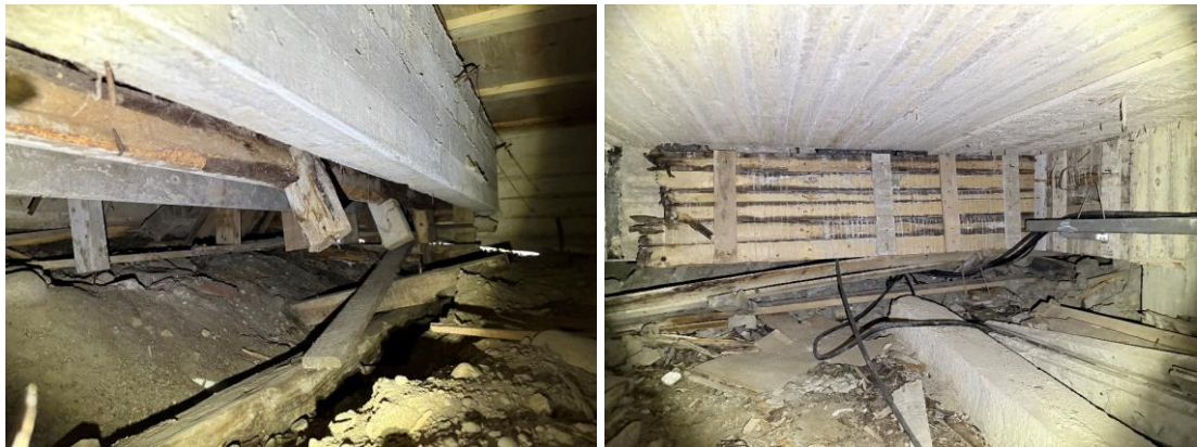
Kuvat 44 ja 45. Ryömintätilassa havaittiin paikoin vanhoja muottilauoituksia (lähinnä ulkoportaiden alapuolella).
