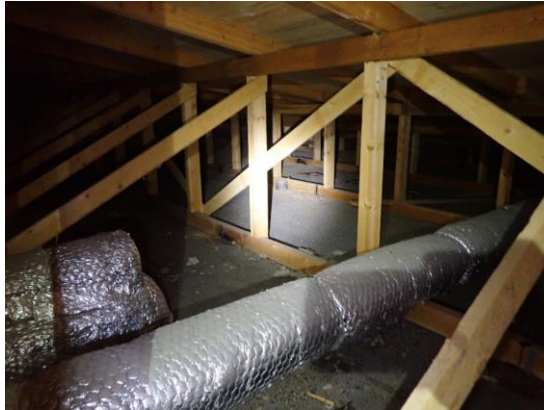
Kuvat 234 ja 235. Yleiskuvat yläpohjatilasta vanhan vahtimestarin asunnon yläpuolelta. Yläpohjatila tuulettuu räystääiden ja harjatuuletusventtiilien kautta. Vanhaan vesikattorakenteeseen on tehty tuuletusaukkoja.
