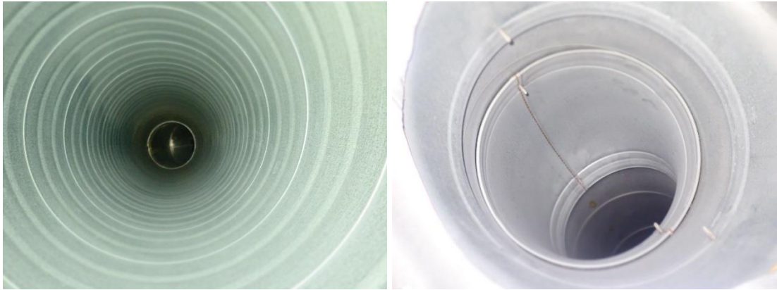
Kuvat 367 ja 368. Yleiskuvat ruokalan rakennusosan ilmastovaihdon tulo- ja poistoilmakanavista. Kanavat olivat silmämääräisesti lähes puhtaat.
