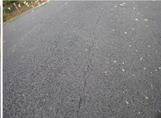
Kuvat 254 ja 255. Yleiskuva vesikatolta. Vesikatteenä on todennäköisesti rakentamivuodelta peräisin oleva bitumikermikate. Katteessa on havaittavissa vähäistä pinnan halkeilua.
