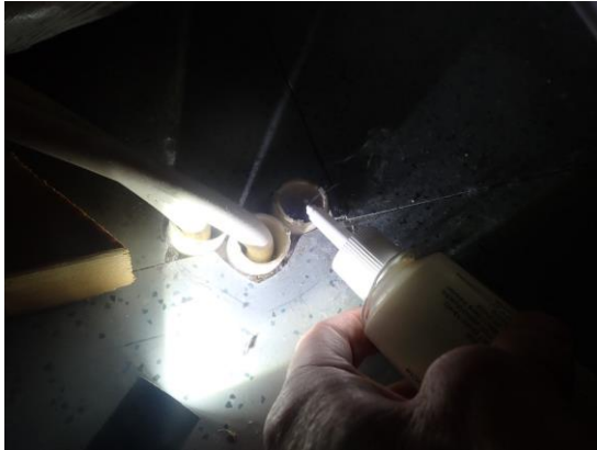
Kuva 60. C-osan Sähkökeskuksen (käytävä 23) alapohjaläpiviennissä havaittiin merkkisavutarkaste- luissa ilmavirtausta sisätiloihin päin.
