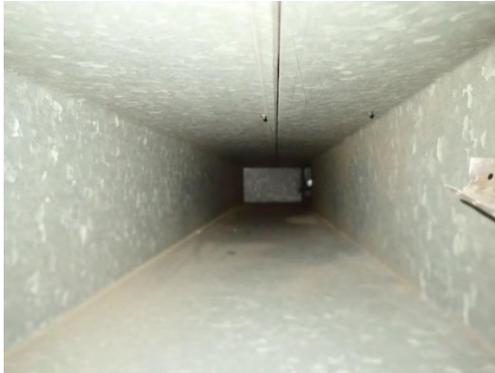
Kuvat 355 ja 356. Yleiskuvat 70-luvulta olevasta tuloilmakäytössä olevasta suorakaidekanavasta. Kanavassa oli havaittavissa hieman pölyä.
