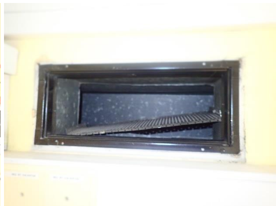
Kuvat 353 ja 354. Yleiskuvat 70-luvun tuloilmasäleiköstä ja sen kytkentäosasta. Asennuskauluksen reikäpelti oli kuvan mukaisesti irti kauluksesta.
