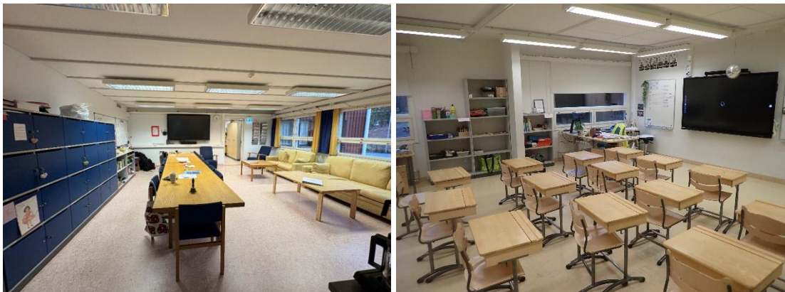
Kuvat 176 ja 177. Sisäkattopintoina A-osan tiloissa on maalattu kipsilevy. Kipsilevypinnalla on mineraalivillaisia akustiikkalevyjä, joiden reunat on suljettu pinnoituksin.
