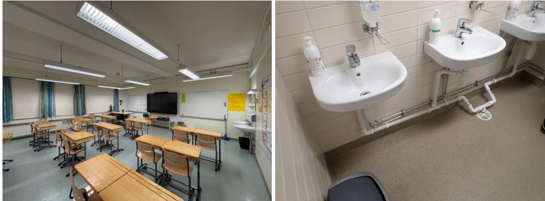
Kuvat 145 ja 146. Väliseinät ovat pääosin maalattuja. WC- ja märkätiloissa on myös keraamista laatoitusta.
