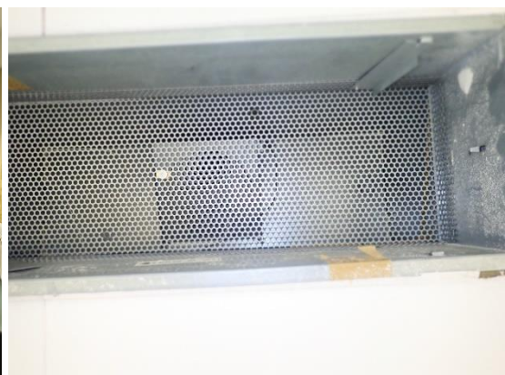
Kuvat 359 ja 360. Yleiskuvat C-osan ilmajaoista ja tuloilmalaitteet tasauslaatikon sisältä (poistoilmalaitteet ovat korostettu keltaisella ja tuloilmalaitteet sinisillä merkinnöillä). Tuloilmalaitteet ovat seinä-asenteisia suutinhajottajia. Ilmajaon arvioidaan toimivan tyydyttävästi, mutta on kriittinen tuloilmalaitteiden suutinasennoille, etteivät ilmavirtaukset törmäile katosta ripustettuihin valaisimiin.
