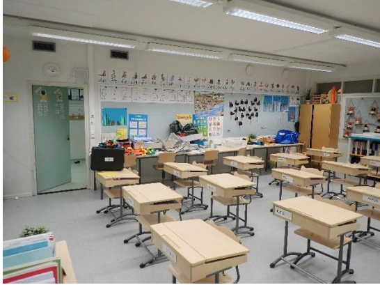
Kuvat 349 ja 350. Yleiskuvat 70-luvulta olevista päätelaitteasennuksista luokkatiloissa. Tuloilmalaitteet ovat käytävän oven yläpuolella ja poistoilmalaitteet lähempänä päätyseinää. Ilmajaosta johtuen tuloilma ei jakaudu ja huuhtelee tasaisesti koko tilan alueelta.
