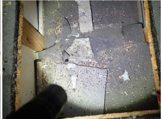
Kuvat 234 ja 235. Yleiskuvat yläpohjatilasta vanhan vahtimestarin asunnon yläpuolelta. Yläpohjatila tuulettuu räystääiden ja harjatuuletusventtiilien kautta. Vanhaan vesikattorakenteeseen on tehty tuuletusaukkoja.
