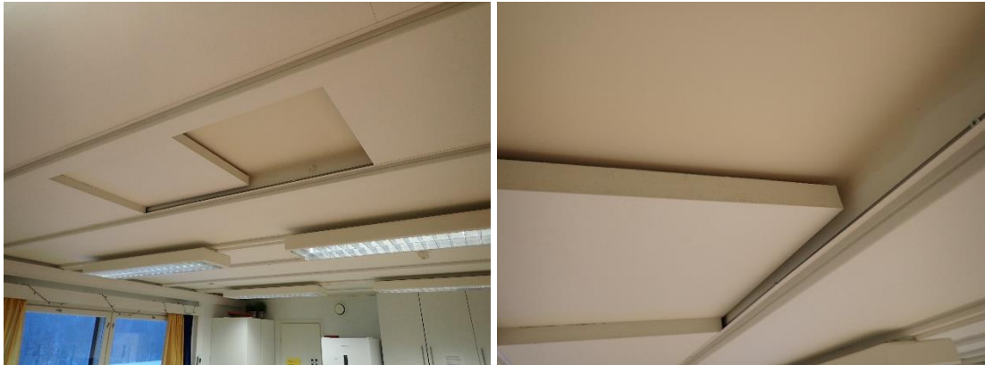
Kuvat 185 ja 186. (AK9). Opettajienhuoneessa alakattorakenteessa on reunoiltaan suljetut akustiikkalevyt.
