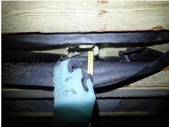
Kuva 48. Alapohjarakenteen lämmöneristepaksuus avauskohdassa R25 on alkuperäisten suunnitelmien mukainen (150 mm).
