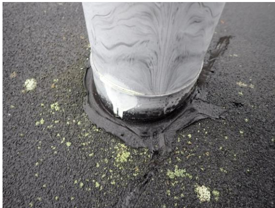
Kuvat 256 ja 257. Vesikaton läpivientejä on paikallisesti tiivistetty jälkikäteen.
