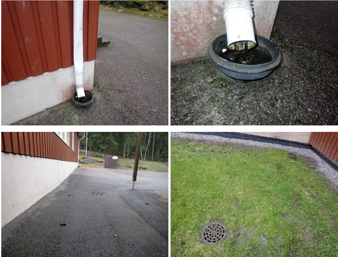
Kuvat 18, 19, 20 ja 21. Kattovedet johdetaan syöksytorvista sadevesijärjestelmään. Paikoin syöksytorvet on todennäköisesti potkittu lommoille. Syöksytorvissa on saattolämmityskaapelit. Piha-alueilla on sadevesi- ja salaojakaivoja.
