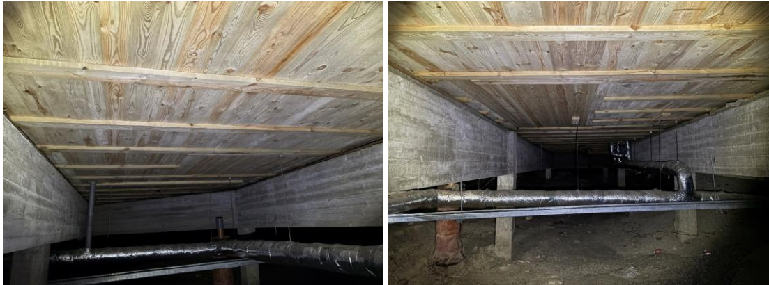
Kuvat 42 ja 43. Muualla alaphjarakenteen alapuolinen laudoitus on pääosin hyväkuntoinen, viitteitä vaurioista ei havaittu.
