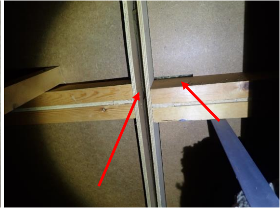
Kuvat 191 ja 192. (AK12). A-osalla alakattotilassa on runsaasti pölyä ja avoimia mineraalivillaisia putki- ja IV-kanavaeristeitä. Yläpohjarakenteen elementtiliitoksessa on havaittavissa solumuovikaista. Yläpohjarakenteen mineraalivilla näkyy kuitulevyreunan takana.
