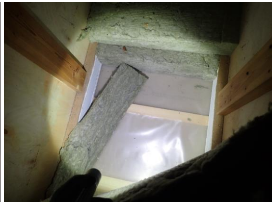
Kuvat 170 ja 171. Yläpohjatilassa rakennusosan keskialueella vanha vesikate ja aluslaudoitus on purettu. Puretulla alueella lämmöneristeet ja höyrynsulkumuovi on osin uusittu. Muualla yläpohjarakenne on alkuperäinen.
