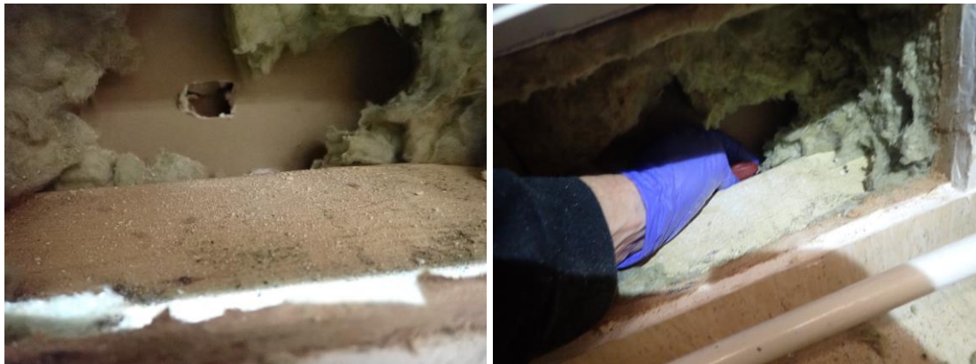
Kuvat 108 ja 109. Rakennusaukko R9 US tehtiin B-osan luokkatilan OT3 ulkoseinän alaosaan. Rakennusaukosta otettiin näyte N7 (mineraalivilla). Mineraalivillassa ei esiintynyt mikrobikasvustoa. Ulkoseinän ja alapohjan lämmöneristetilojen välillä on ilmayhteys.
