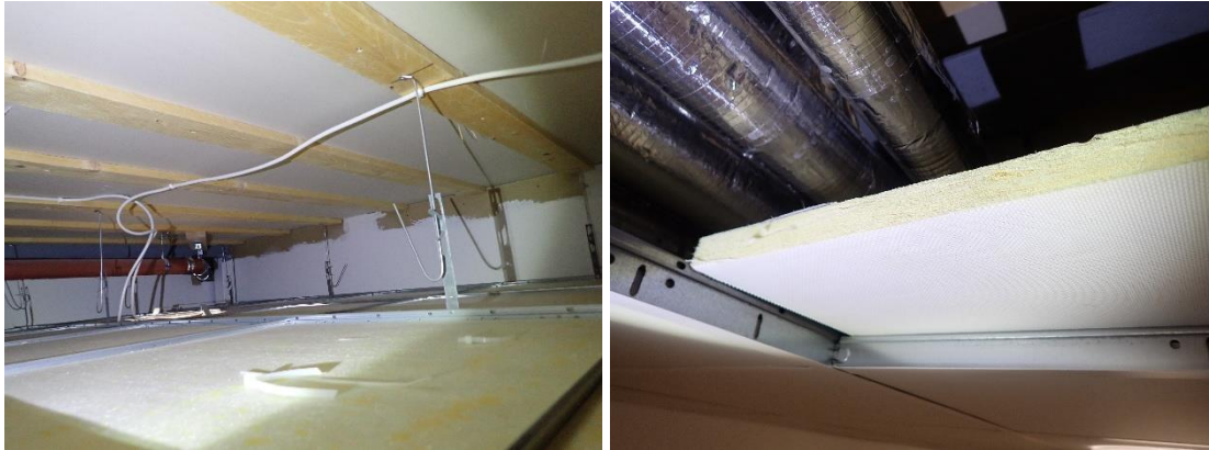
Kuvat 155 ja 156. Ruokalaosalla käytävän t-lista alakatoissa on reunoiltaan avoimet mineraalivillalevyt (AK17 ja AK18).
