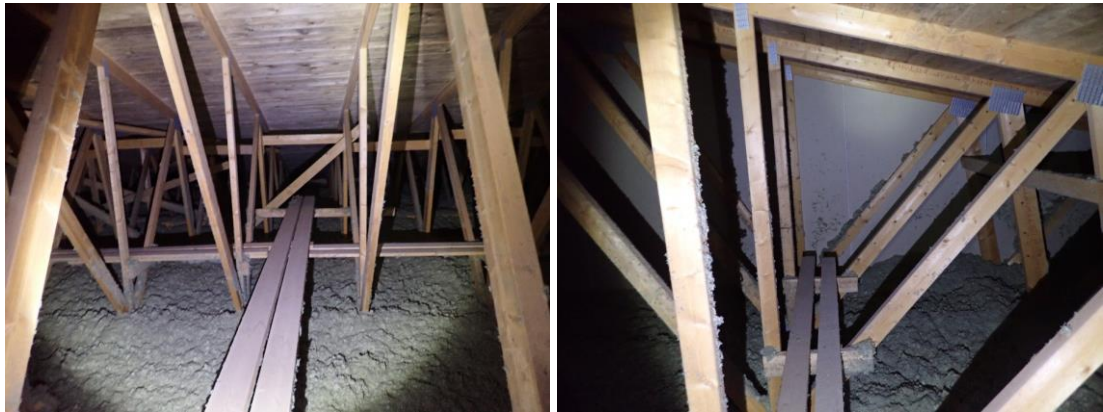
Kuvat 260 ja 261. Yleiskuva yläpohjatilasta. Yläpohjatila on jaettu palo-osastoihin kipsilevykatkoilla.
