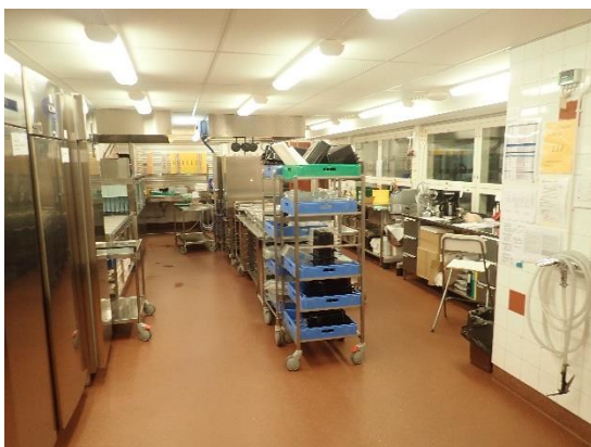
Kuvat 363 ja 364. Koulun keittiöissä oli ammattikeittiötason rasva- ja kondenssihuuvat, sekä syrjäyttävän ilmanvaihdon piennopeuslaite.
