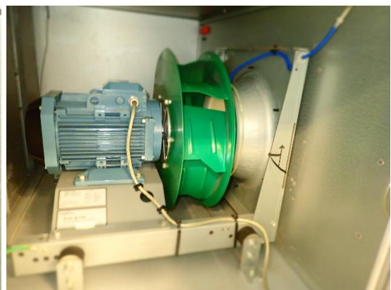
Kuvat 326 ja 327. Yleiskuvat LTO:sta ja tuloilmapuhaltimesta. LTO ja molemmat puhaltimet olivat hyväkuntoiset.
