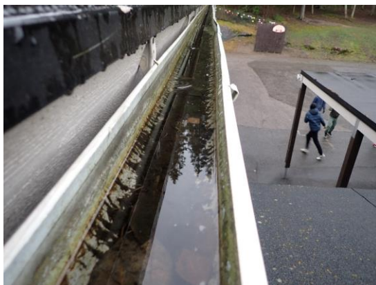
Kuvat 258 ja 259. Sadevesikouruissa on koko rakennuksen osalla yleisesti kallistus- ja kiinnityspuutteita. Paikoin sadevesikourut ovat vääntyneet joko lumen tai päälle astumisen takia. Vesi makaa sadevesikouruissa monin paikoin.
