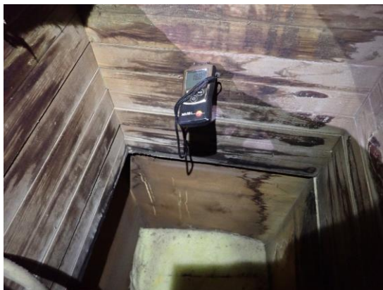
Kuvat 236, 237, 238 ja 239. Vanhan vahtimestarin asunnon yläpuolella yläpohjatilassa on kaksi vanhaa käytöstä poistettua ilmanvaihtokanavaa, joiden ummistus on puutteellinen. Sisäilman kosteus kondensoituu yläpohjatilassa puurakenteiden pintaan.
