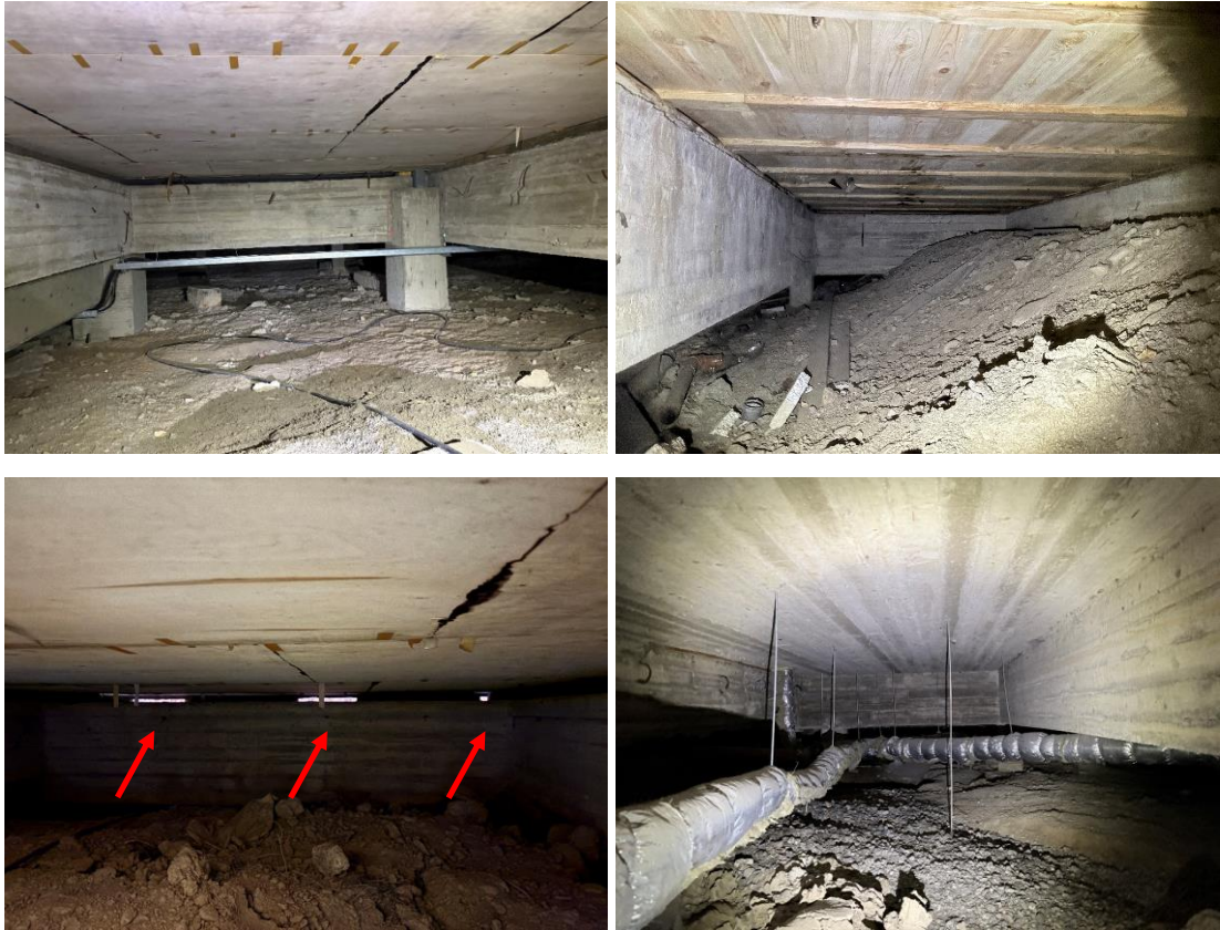
Kuvat 36, 37, 38 ja 39. Yleiskuvat ruokalaosan ryömintätilasta. Vanhan juhlasalin kohdalla alapohjarakenne poikkeaa hieman muualla olevasta puuelementtirakenteisesta alapohjarakenteesta. Ryömintätila tuuletuu reuna-alueilla sokkelipalkin ja ulkoseinärakenteen alaosan välissä olevien aukkojen kautta (nuolten osoittamat kohdat). Keittiön kohdalla alapohjarakenne on betonirakenteinen.
