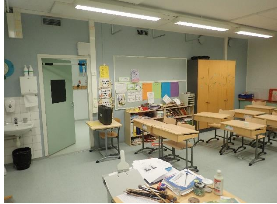
Kuvat 349 ja 350. Yleiskuvat 70-luvulta olevista päätelaitteasennuksista luokkatiloissa. Tuloilmalaitteet ovat käytävän oven yläpuolella ja poistoilmalaitteet lähempänä päätyseinää. Ilmajaosta johtuen tuloilma ei jakaudu ja huuhtelee tasaisesti koko tilan alueelta.
