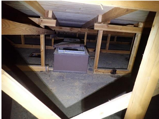
Kuvat 234 ja 235. Yleiskuvat yläpohjatilasta vanhan vahtimestarin asunnon yläpuolelta. Yläpohjatila tuulettuu räystääiden ja harjatuuletusventtiilien kautta. Vanhaan vesikattorakenteeseen on tehty tuuletusaukkoja.
