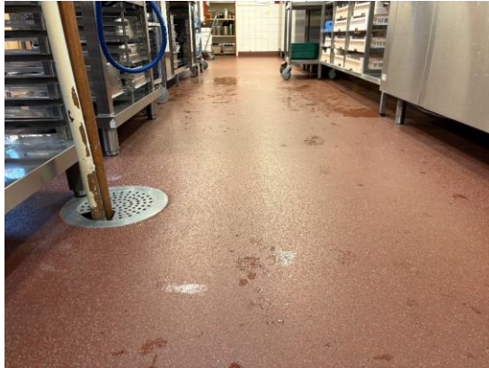
Kuvat 33 ja 34. Keittiössä (tila 20) ja wc-tiloissa on märkätilan muovimattoa.
