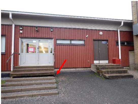
Kuvat 10, 11, 12 ja 13. Paikoin sorastus sokkelin vierustalta valuu sokkelipalkin alitse ryömintätilaan. Länsipäädyn sisäänkäynnin portaan ovat painuneet alaspäin. Betoniportaiden alapuolinen täyttö valuu myös ryömintätilaan.
