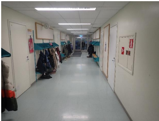
Kuva 268. C-osan käytävätiloissa on t-lista-alakatto ja akustiikkalevytys.
