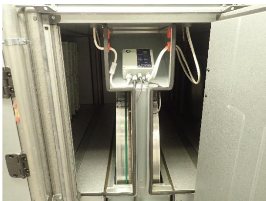
Kuvat 326 ja 327. Yleiskuvat LTO:sta ja tuloilmapuhaltimesta. LTO ja molemmat puhaltimet olivat hyväkuntoiset.
