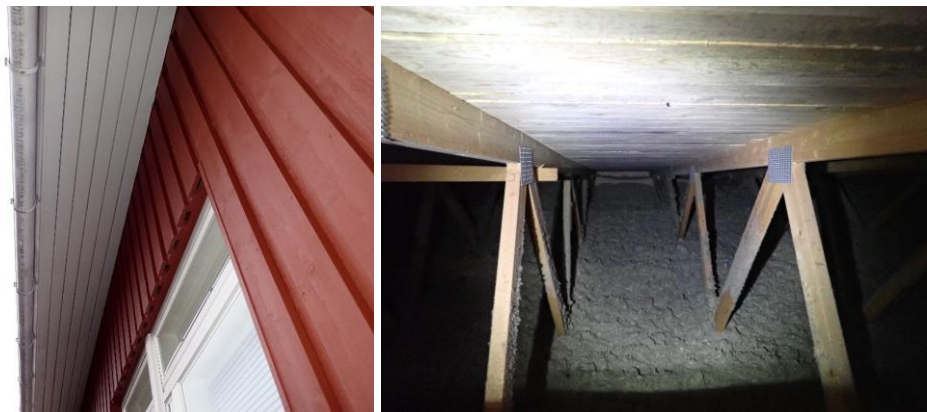
Kuvat 262 ja 263. Yläpohjatila tuulettuu räystäiden ja harjatuuletusventtiilien kautta. Räystäällä on tuulenohjaimet.
