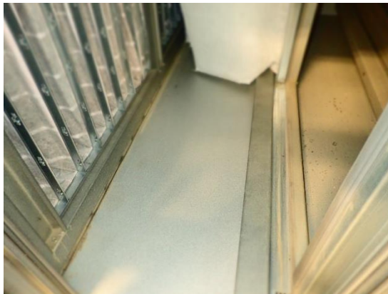
Kuvat 324 ja 325. Yleiskuvat esisuodattimen suodatinosasta ja hienosuodattimesta. Suodatinosat olivat siistikuntoiset, eikä niissä havaittu kosteuden aiheuttamia jälkiä.
