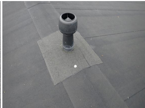
Kuvat 256 ja 257. Vesikaton läpivientejä on paikallisesti tiivistetty jälkikäteen.
