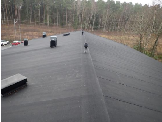
Kuvat 254 ja 255. Yleiskuva vesikatolta. Vesikatteenä on todennäköisesti rakentamivuodelta peräisin oleva bitumikermikate. Katteessa on havaittavissa vähäistä pinnan halkeilua.
