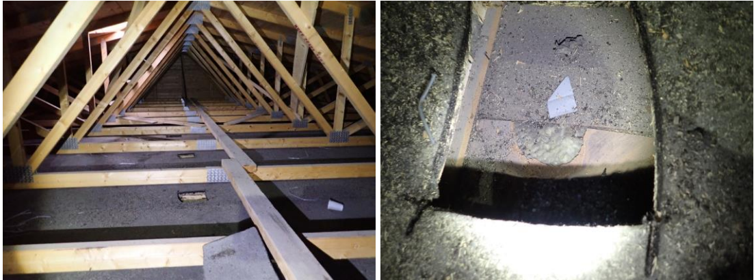
Kuvat 231 ja 232. Yleiskuvat yläpohjatilasta vanhan juhlasalin kohdalta. Yläpohjatila tuulettuu räystäiden ja harjatuuletusventtiilien kautta. Vanhaan vesikattorakenteeseen on tehty tuuletusaukkoja.
