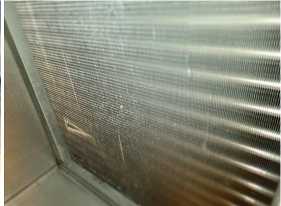
Kuvat 305 ja 306. Yleiskuvat LTO:n moottorista ja lämmityspatterista. LTO:n ja lämmityspatterin kennon olivat hyväkuntoiset ja puhtaat. LTO:n moottori on muita koneen osia uudempi.
