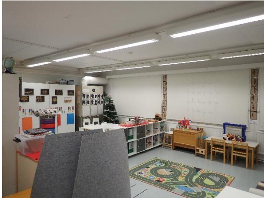
Kuvat 351 ja 352. Yleiskuvat tilakohtaisilla ilmanvaihtokoneilla varustettujen opetustilojen ilmajaosta. IV-kone puhalltaa tuloilmaa koneen alaosasta ja imee poistoilmaa koneen yläosasta. Tilojen yleisilmanvaihdon päätelaitteet oli tulpattu. Vasemman kuvan tilassa tuloilma törmää iv-koneen edessä olevaan hyllykköön, eikä jakaudu tilan alueelle. Oikeassa kuvassa iv-koneen edessä ei ole isoja esteitä, mutta koneen läheisyydessä istuva opettaja ja oppilaat voivat kokea tuloilmavirtauksen epämiellyttävä.
