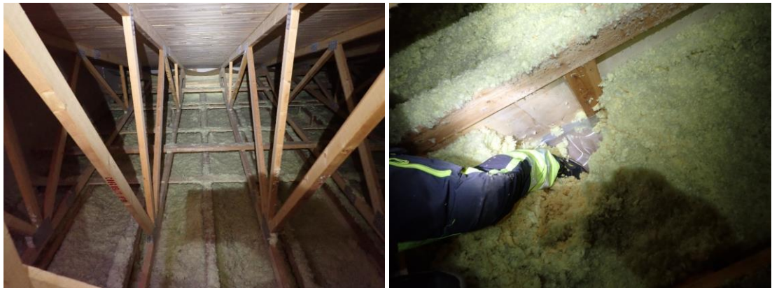
Kuvat 209 ja 210. Yleiskuvat yläpohjatilasta rakennusosalta B. Yläpohjatila tuulettuu räystäiden ja harjatuuletusventtiilien kautta. Räystäällä on tuulenojaimet. Rakennusosalta B vanha vesikate aluslautoineen on purettu kokonaisuudessaan. Höyrynsulkuna on rakennusmuovi ja lämmöneristeenä puhallusvillaa.
