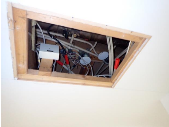
Kuvat 189 ja 190. (AK11). Alakattotilaa ei tilan ahtauden takia päästy tarkastelemaan tarkemmin. Tarkastusluukussa on vähän vanhoja kosteusjälkiä.
