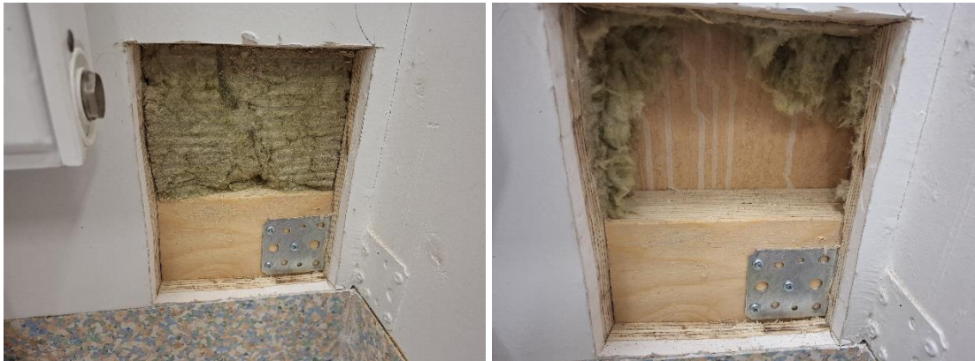
Kuvat 119 ja 120. Rakenneavaus R21 ruokalaosan luokassa 20. Avauksessa ei havaittu viitteitä kosteudesta.
