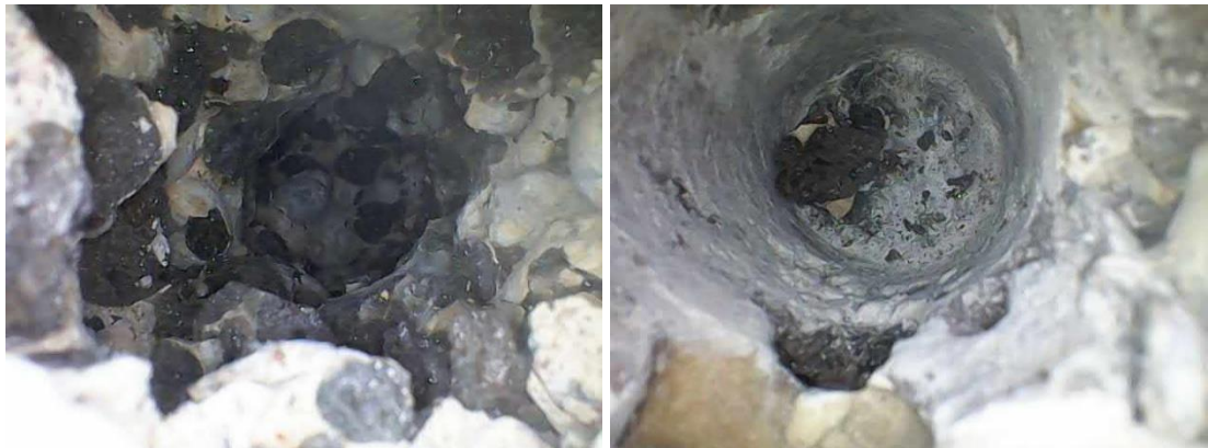
Kuvat 25 ja 26. Keittiön tuulikaapin 104 alapohjarakenteen poraus P4.
