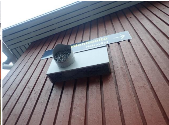
Kuvat 345 ja 346. Vasemman kuvan ulkoilmalaitteen arvioidaan olevan A-osan tuloilmakoneen ulkoilmalaitte. Oikeassa kuvassa on yleiskuva tilakohtaisen ilmanvaihtokoneen yhdistelmä ulkoilmalaitteesta.
