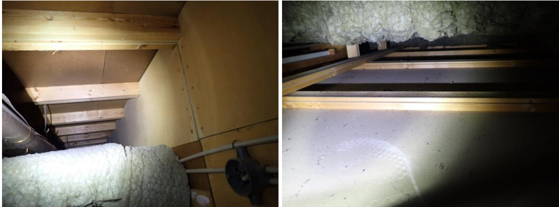
Kuvat 221 ja 222. (AK7) B-osan käytävällä alakattotilassa on runsaasti pölyä ja avoimia mineraalivillaisia putki- ja IV-kanavaeristeitä.
