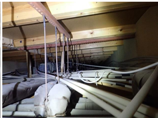
Kuvat 193 ja 194. (AK13) Yläpohjarakenteen alapinnassa on havaittavissa vanhoja vesikaton vuotojälkiä. Alakattotilassa on runsaasti pölyä.
