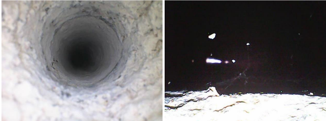
Kuvat 27 ja 28. Lämmönjakohuoneen alapohjarakenteen poraus P5.
