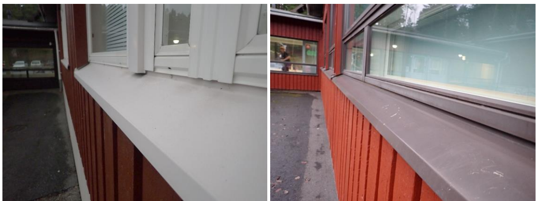
Kuvat 136 ja 137. Ikkunoiden vesipellityksissä ei havaittu puutteita. Sisä- ja ulkopuolen maalipinnat ovat yleisesti hyvässä kunnossa.
