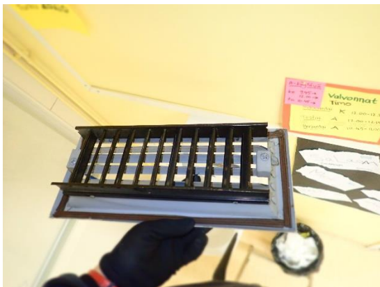
Kuvat 353 ja 354. Yleiskuvat 70-luvun tuloilmasäleiköstä ja sen kytkentäosasta. Asennuskauluksen reikäpelti oli kuvan mukaisesti irti kauluksesta.
