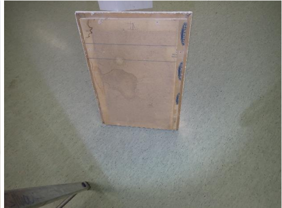
Kuvat 189 ja 190. (AK11). Alakattotilaa ei tilan ahtauden takia päästy tarkastelemaan tarkemmin. Tarkastusluukussa on vähän vanhoja kosteusjälkiä.
