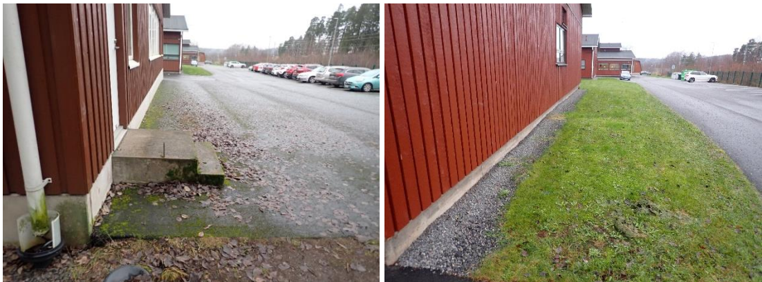
Kuvat 6 ja 7. Parkkipaikan puoleinen piha-alue (pohjoinen) on pääosin asfaltoitu. Paikoin on myös nurmialueita. Nurmialueiden ja sokkelin välissä on sorastus.
