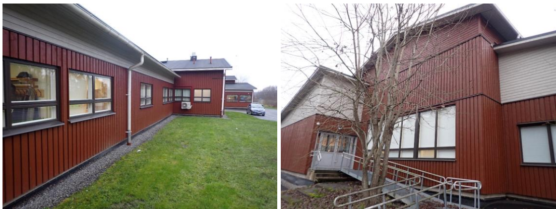
Kuvat 82 ja 83. Yleiskuvat julkisivuista.
