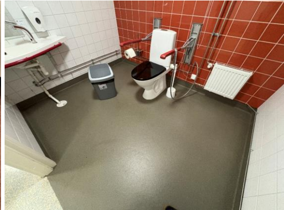
Kuvat 33 ja 34. Keittiössä (tila 20) ja wc-tiloissa on märkätilan muovimattoa.
