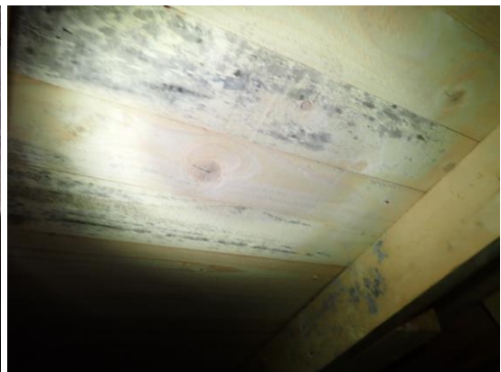
Kuvat 236, 237, 238 ja 239. Vanhan vahtimestarin asunnon yläpuolella yläpohjatilassa on kaksi vanhaa käytöstä poistettua ilmanvaihtokanavaa, joiden ummistus on puutteellinen. Sisäilman kosteus kondensoituu yläpohjatilassa puurakenteiden pintaan.
