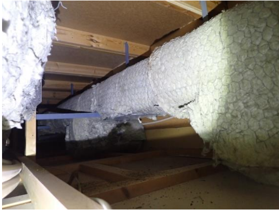
Kuvat 191 ja 192. (AK12). A-osalla alakattotilassa on runsaasti pölyä ja avoimia mineraalivillaisia putki- ja IV-kanavaeristeitä. Yläpohjarakenteen elementtiliitoksessa on havaittavissa solumuovikaista. Yläpohjarakenteen mineraalivilla näkyy kuitulevyreunan takana.
