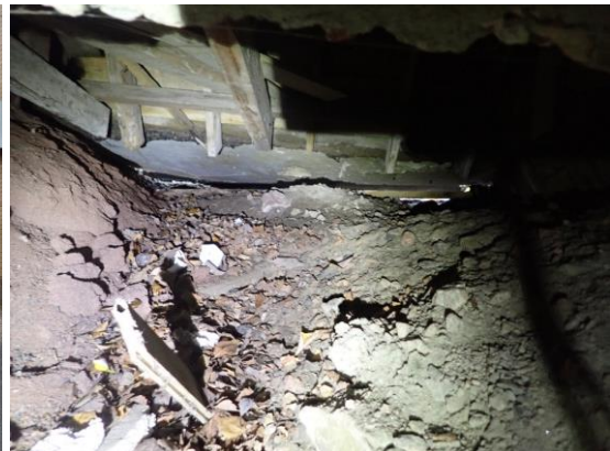
Kuvat 10, 11, 12 ja 13. Paikoin sorastus sokkelin vierustalta valuu sokkelipalkin alitse ryömintätilaan. Länsipäädyn sisäänkäynnin portaan ovat painuneet alaspäin. Betoniportaiden alapuolinen täyttö valuu myös ryömintätilaan.
