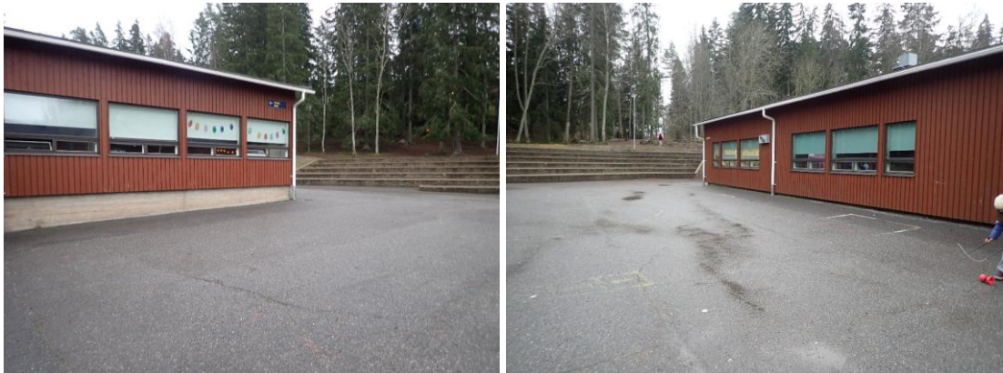
Kuvat 4 ja 5. Sisäpihan puoleinen piha-alue (etelä) on pääosin asfaltoitu.
