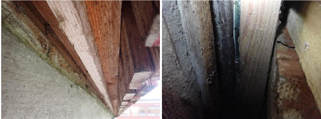
Kuvat 90 ja 91. Julkisivuverhoilun tuuletuksessa ei havaittu puutteita.
