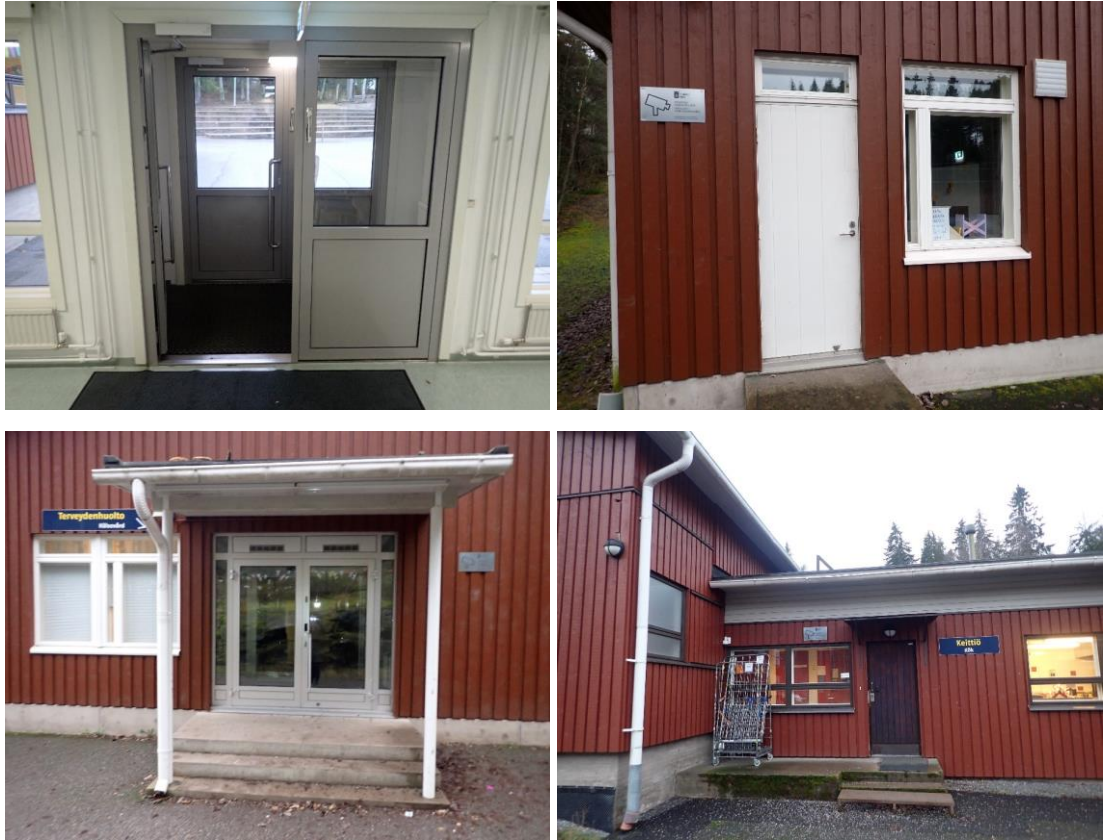
Kuvat 132, 133, 134 ja 135. Yleiskuvia rakennuksen ulko-ovista.
