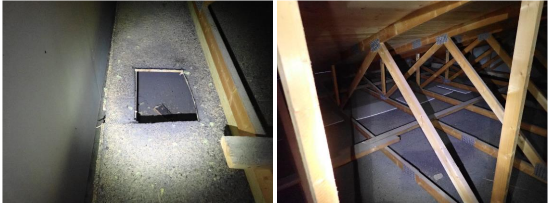
Kuvat 172 ja 173. Reuna-alueilla vanhat vesikatto- ja yläpohjarakenteet ovat jäljellä ja niihin on tehty tuuletusaukot. Tuuletusaukot on osittain suljettu kipsilevypaloin.
