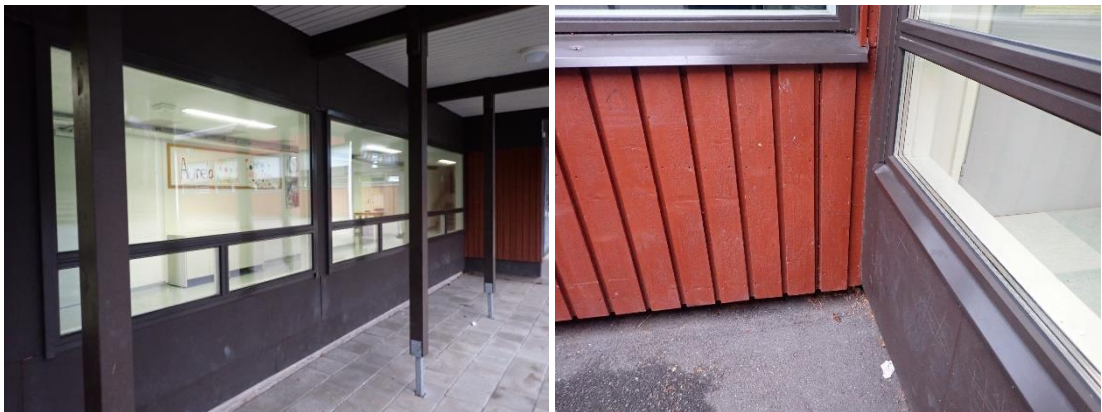
Kuvat 92 ja 93. A-osan ulkokatoksen alapuolinen ulkoseinä sekä B- C-osien välisen yhdyskäytävän ulkoseinä on eteläpuolelta verhoiltu vanerilevyillä.
