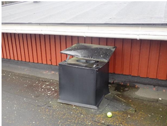
Kuvat 345 ja 346. Vasemman kuvan ulkoilmalaitteen arvioidaan olevan A-osan tuloilmakoneen ulkoilmalaitte. Oikeassa kuvassa on yleiskuva tilakohtaisen ilmanvaihtokoneen yhdistelmä ulkoilmalaitteesta.
