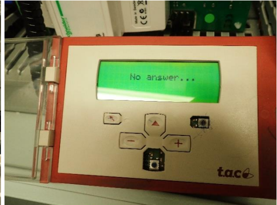
Kuvat 322 ja 323. Yleiskuvat ilmanvaihtokoneesta TK04 ja sen rakennusautomaation käyttöpaneelista. Käyttöpaneeli ei havaintojen perusteella toiminut.
