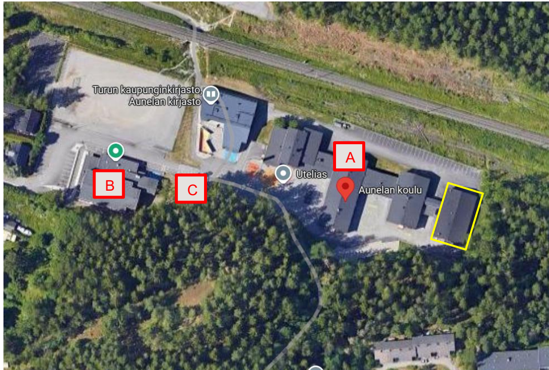
Kuva 1. Ilmakuva Aunelan koulusta (lähde: Google Maps). Eri rakennukset on merkitty kuvaan punaisiin laatikoihin. A koulurakennus, B palloiluhalli, C talousrakennus (ulkoiluvälinevarasto, pihavarasto). Koulurakennuksen vuonna 2000 rakennettu lisäosa on rajattu keltaisella viivalla.
