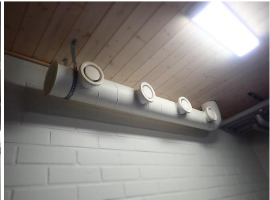
Kuvat 135 ja 136. Yleiskuvat pukuhuoneen tulo- ja poistoilmalaitteista. Katossa ovat tuloilmahajottajat ja katosta alaslasketussa kanavassa poistoilmaventtiilit.
