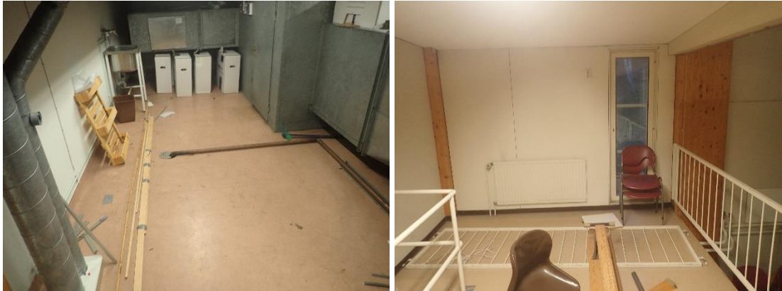
Kuvat 93 ja 94. Välipohjarakenteen pintamateriaalina on muovimatto sekä IV-konehuoneessa että parvella.
