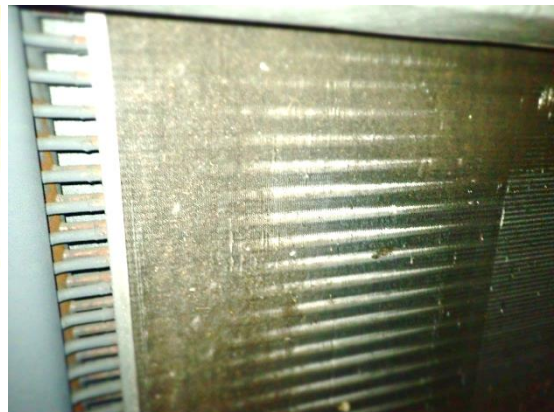
Kuvat 124 ja 125. Yleiskuvat lämmityspatterista. Lämmityspatteri oli suodattimien puolelta selvästi likaantunut.
