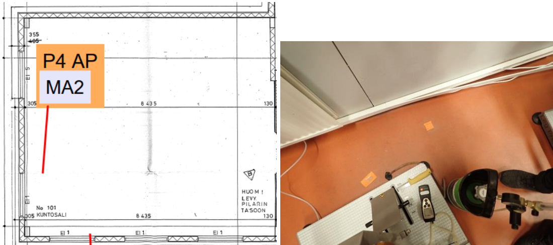
Kuvat 29 ja 30. Merkkiainekoe MA2 kuntosalissa 101. Alapohjan eristetilaan syötettyä merkkiainekaasua ei havaittu syöttökohdan (MA2) lähellä olevan maanvastaisen ulkoseinän alaosissa.
