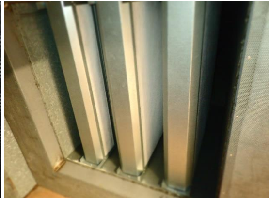
Kuvat 128 ja 129. Yleiskuvat äänenvaimennuskaseteista ja äänenvaimennetusta kammio-osasta. Äänenvaimennusmateriaalit olivat hyväkuntoiset, eikä niissä havaittu mahdollisia kuitulähteitä.
