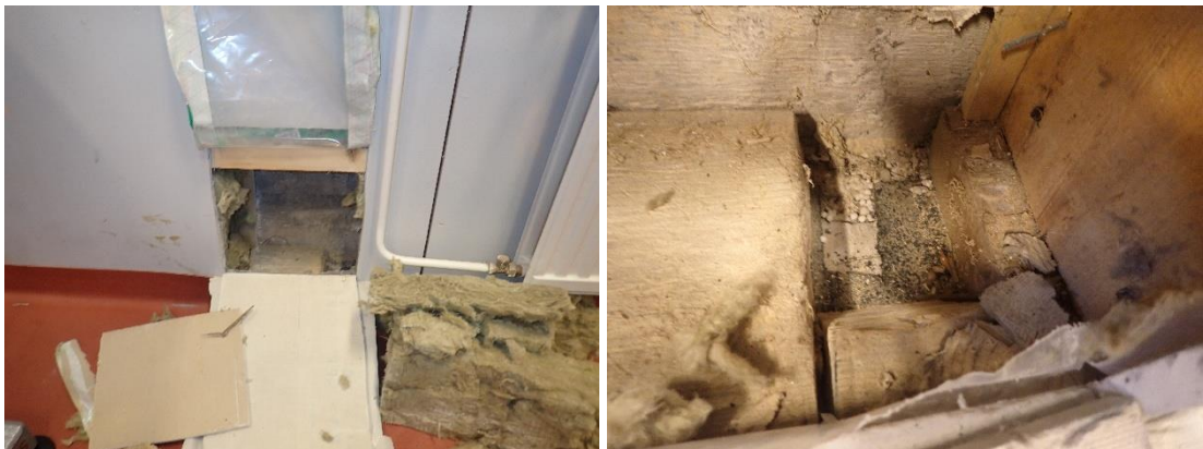
Kuvat 76 ja 77. Rakenneavaus R11 tehtiin kuntosalin idän puoleiselle alaosaan maanvastaiselle ulkoseinälle. Avauksesta otettiin näyte N3 (mineraalivilla) mikrobianalyyysiin. Näytteessä ei havaittu mikrobikasvustoa.
