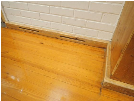
Kuvat 22, 23 ja 24. Kuntosalin lattiassa on muovimatto ja liikuntasalissa on puulattia. Liikuntasalin puukorokelattia tuulettaa jalkalistoissa olevien tuuletusaukkojen kautta.
