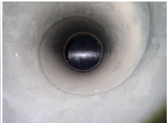
Kuvat 137 ja 138. Yleiskuvat poistoilmakanavista. Kanavien havaittiin olevan hieman pölyntyneet, poistoilmaventtiilien havaittiin olevan puhtaita. Yksittäisten poistoilmäsäleikköjen havaittiin olevan pinnoilta pölyntyneet.
