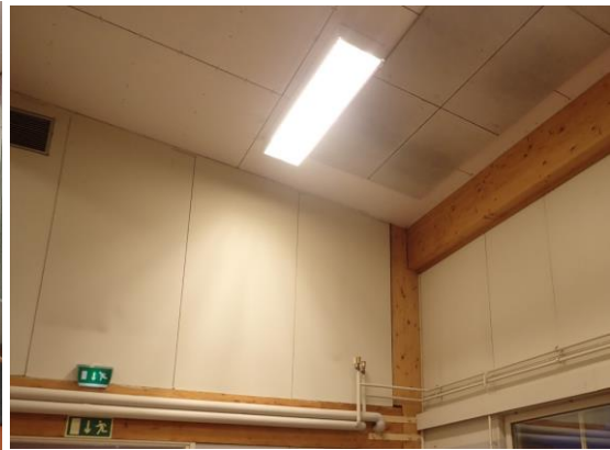
Kuvat 89 ja 90. Väliseinät ovat osin puhtaaksi muurattuja ja maalattuja kalkkihiekkatiiliseiniä ja osin puurunkoisia levyseiniä.
