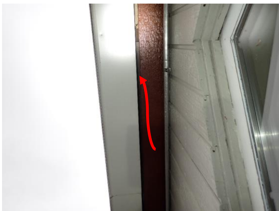
Kuvat 110 ja 111. Yläpohjatilat tuulettuvat räystäällä olevien rakojen ja harjatuuletusventtiilien kautta.
