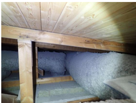
Kuvat 115 ja 116. Paikoin yläpohjan lämmöneristystä on lisätty puhallusvillaeristeellä pukuhuoneiden yläpuolisilla alueilla.
