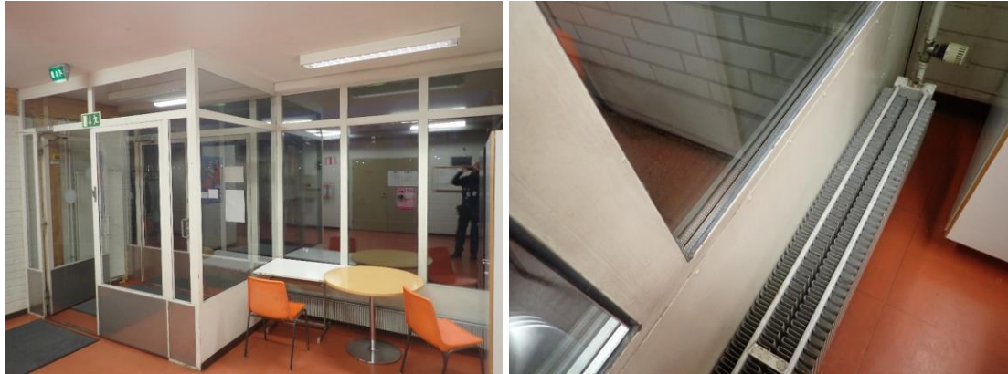
Kuvat 82 ja 83. Aulatilissa ikkunat ovat teräsrakenteisia kolmelasisia umpiolasielementti-ikkunoita. Ulko-ovet ovat lasiaukollisia teräsovia.
