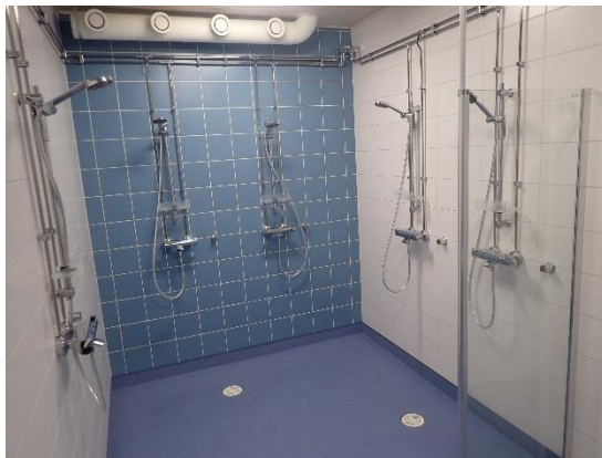
Kuva 91. Suihkutiloissa väliseinillä on myös keraamista laatoitusta.
