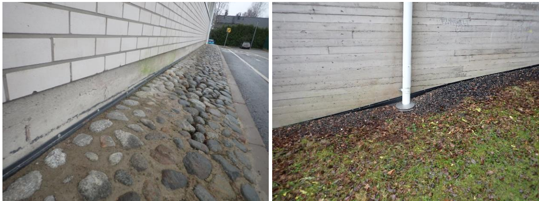
Kuvat 9 ja 10. Sokkelissa on perusmuurilevy.
