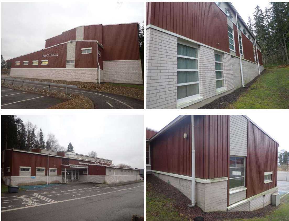
Kuvat 38, 39, 40 ja 41. Yleiskuvia rakennuksen julkisivusta.
