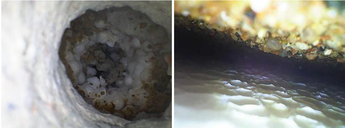
Kuvat 15 ja 16. Yleiskuvat alapohjarakenteesta porauksessa P4.
