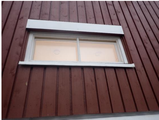
Kuvat 78 ja 79. Rakennuksen ikkunat ovat puurakenteisia MSE-tyyppin sisään-aukeavia kaksipuitteisia ja kolmelasisia ikkunoita, joiden sisäpuutteessa on kaksilasinen umpiolasielementti.
