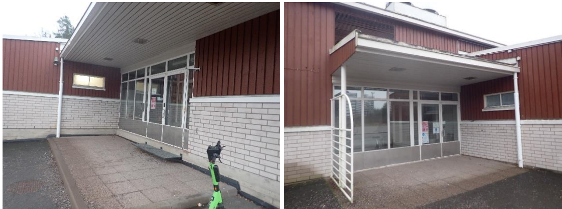
Kuvat 84 ja 85. Yleiskuvat ulko-ovista.
