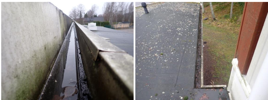
Kuvat 105 ja 106. Paikoin sadevesikouruissa on paljon orgaanista roskaa (etelä) ja paikoin vesi makaa kouruissa kallistuspuutteiden takia.
