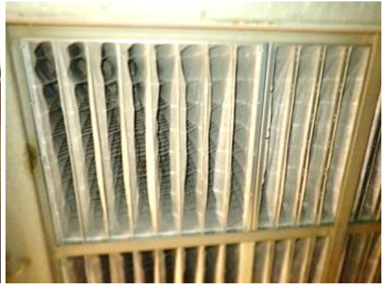
Kuvat 122 ja 123. Yleiskuvat tuloilman suodatinseinästä. Suodattimet olivat hieman likaantuneet.
