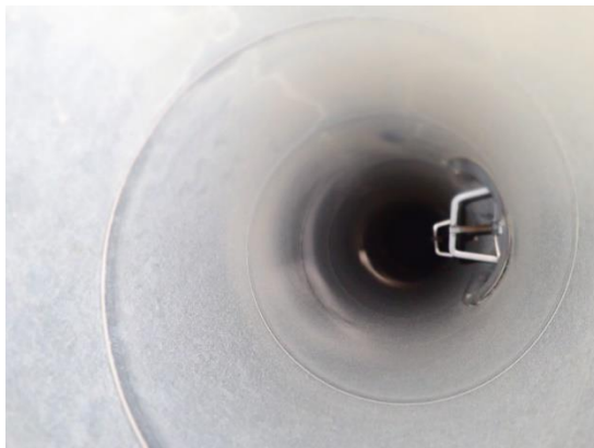
Kuvat 137 ja 138. Yleiskuvat poistoilmakanavista. Kanavien havaittiin olevan hieman pölyntyneet, poistoilmaventtiilien havaittiin olevan puhtaita. Yksittäisten poistoilmäsäleikköjen havaittiin olevan pinnoilta pölyntyneet.
