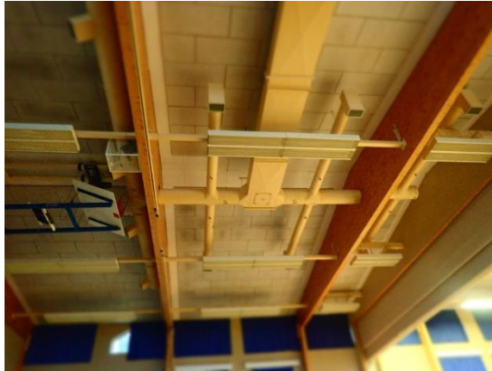
Kuvat 133 ja 134. Yleiskuvat liikuntasalin tulo- ja poistoilmalaitteista. Katossa ovat tuloilmalaitteet, ja seinällä on tulo- ja poistoilmalaitteita.
