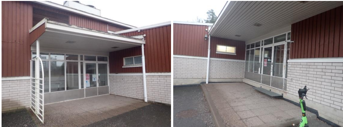
Kuvat 7 ja 8. Sisäänkäyntikatosten alla on betonilaatoitus.
