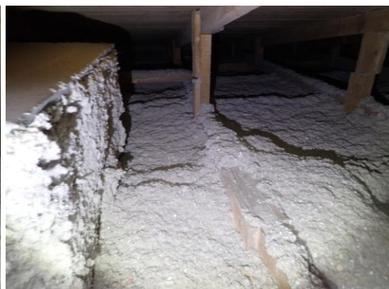
Kuvat 115 ja 116. Paikoin yläpohjan lämmöneristystä on lisätty puhallusvillaeristeellä pukuhuoneiden yläpuolisilla alueilla.
