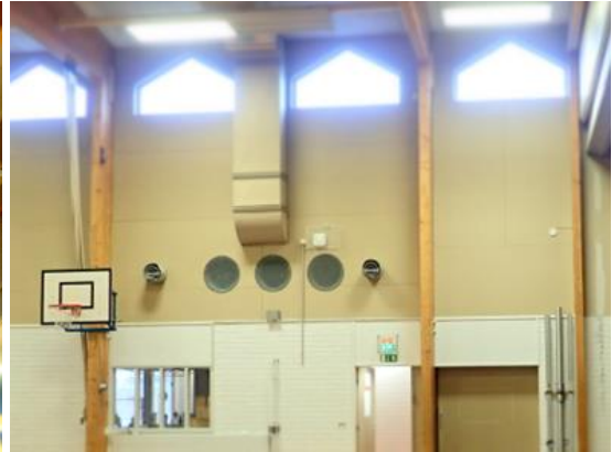
Kuvat 133 ja 134. Yleiskuvat liikuntasalin tulo- ja poistoilmalaitteista. Katossa ovat tuloilmalaitteet, ja seinällä on tulo- ja poistoilmalaitteita.
