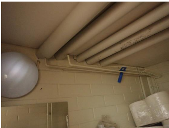
Kuvat 95, 96 ja 97. Välipohjarakenteen toteutus tarkastettiin puhelinrelehuoneen avoimen sisäkaton kautta ja rakenne on suunnitelmien mukainen. Muissa tiloissa välipohjarakenteen alapinnassa on maalattu sisäverhouslevy.
