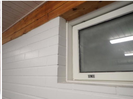
Kuvat 78 ja 79. Rakennuksen ikkunat ovat puurakenteisia MSE-tyyppin sisään-aukeavia kaksipuitteisia ja kolmelasisia ikkunoita, joiden sisäpuutteessa on kaksilasinen umpiolasielementti.
