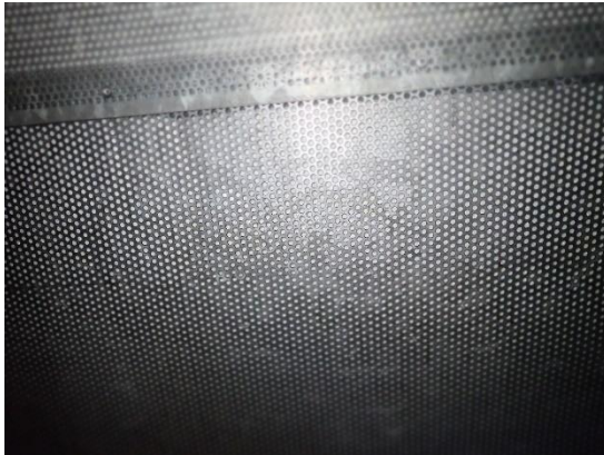
Kuvat 128 ja 129. Yleiskuvat äänenvaimennuskaseteista ja äänenvaimennetusta kammio-osasta. Äänenvaimennusmateriaalit olivat hyväkuntoiset, eikä niissä havaittu mahdollisia kuitulähteitä.
