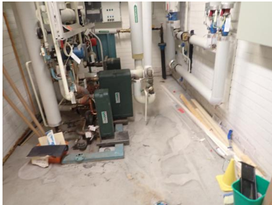
Kuva 25. Lämmönjakohuoneessa lattia on betonipinnalla.
