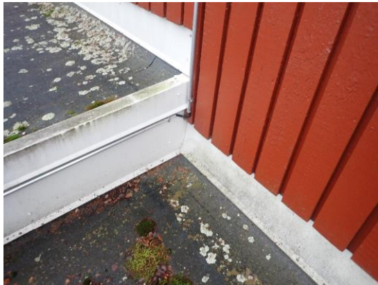
Kuvat 113 ja 114. Reuna-alueiden pellityksissä ei havaittu puutteita.
