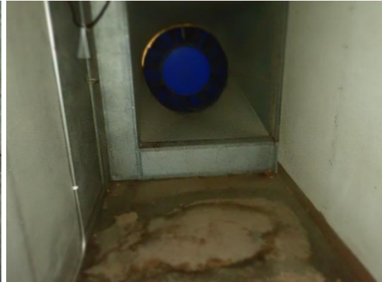
Kuvat 126 ja 127. Yleiskuvat tulo- ja poistoilmapuhaltimesta. Poistopuhaltimen osalta havaittiin poikkeava käyntiääni. Useissa kammio-osissa havaittiin vanhoja kosteusjälkiä. Ulkoilmakammio oli varustettu viemäröinnillä.
