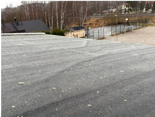
Kuvat 108 ja 109. Katteessa havaittiin yksittäisiä kupruja ja katteen pinnassa on yleisesti vähäistä sammal- tai jäkäläkasvustoa. Eteläpuolen lappeen reuna-alueella sammal- ja jäkäläkasvustoa on paljon.
