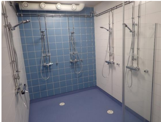
Kuvat 19, 20 ja 21. Pukuhuone ja suihkutilat wc-tiloineen ovat pinnoiltaan hyvässä kunnossa.
