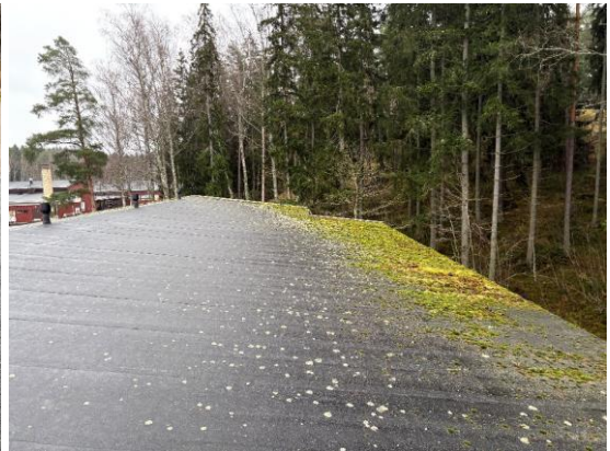
Kuvat 108 ja 109. Katteessa havaittiin yksittäisiä kupruja ja katteen pinnassa on yleisesti vähäistä sammal- tai jäkäläkasvustoa. Eteläpuolen lappeen reuna-alueella sammal- ja jäkäläkasvustoa on paljon.
