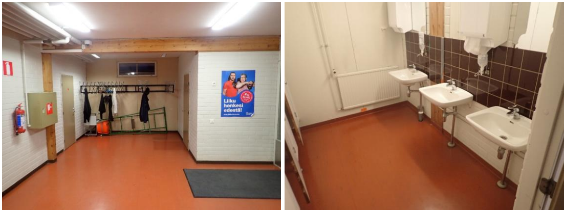
Kuvat 17 ja 18. Palloiluhallin käytävätiloissa on pääosin vinyylilaatoitus, paikoin on myös muovimattoa. Märkätiloissa on märkätilan muovimattoa.
