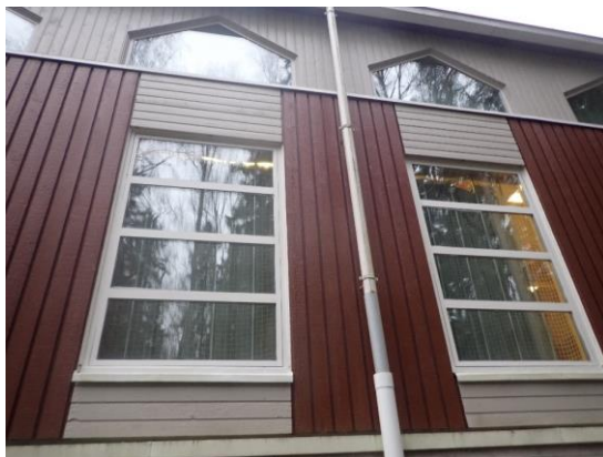
Kuvat 80 ja 81. Liikuntasalissa ikkunat ovat teräsrakenteisia kolmelasisia umpiolasielementti-ikkunoita.
