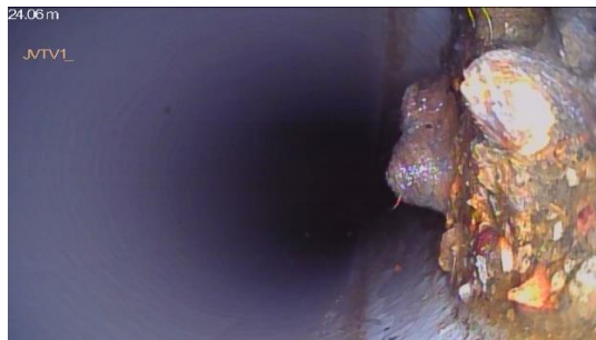
Kuvat 141 ja 142. Vasemmalla kuva linjasta JTV1, linjan pohjalla olevasta hiekkakertymästä, johon on jäänyt viemärijätettä kiinni. Oikealla kuva linjasta SVTV3, esimerkkikuva linjassa havaitusta aaltolusta.
