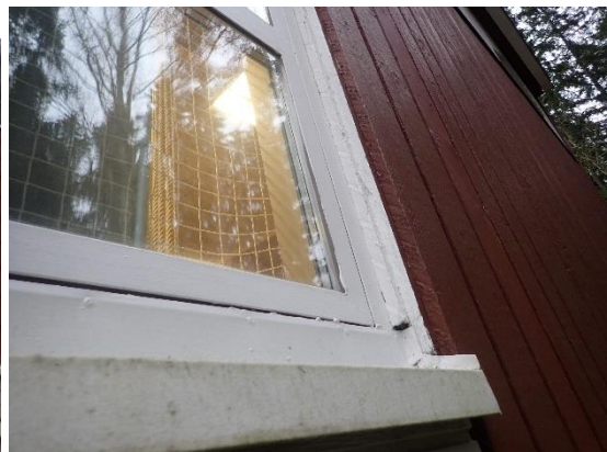
Kuvat 80 ja 81. Liikuntasalissa ikkunat ovat teräsrakenteisia kolmelasisia umpiolasielementti-ikkunoita.
