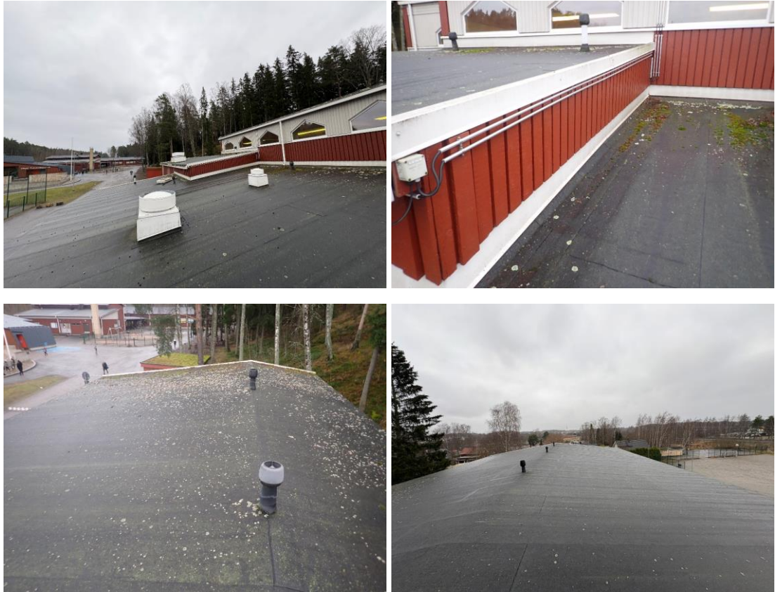
Kuvat 101, 102, 103 ja 104. Yleiskuvia vesikatolta.
