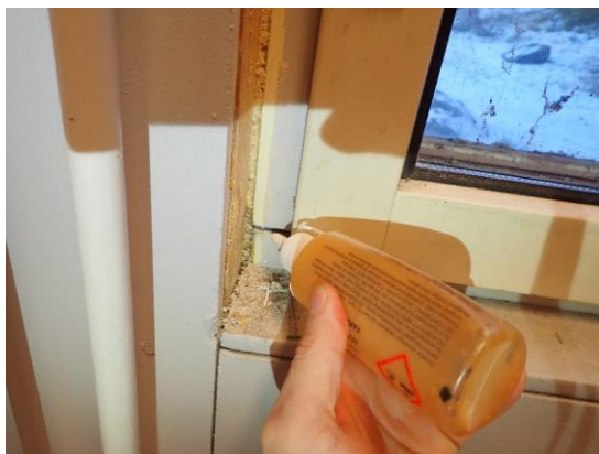
Kuva 63. Ikkuna-ulkoseinäliittymän avaus (R10) kuntosalissa 101. Höyrynsulkumuovin reuna on Ilves-levyn takana. Ikkuna-ulkoseinäliittymässä on polyuretaanivaahdotus. Merkkisavutarkasteluissa ikkuna - ulkoseinäliittymässä todettiin vähäistä ilmavuotoa
