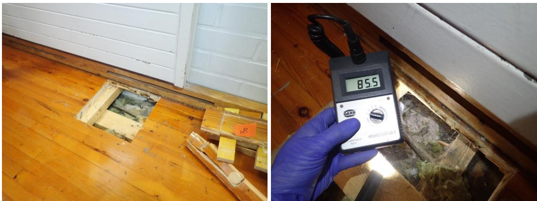
Kuvat 33 ja 34. Rakenneavaus R6. Puukorokelattian korkeus on noin 200 mm. Rakenteessa on betonilaatan yläpinnassa bitumisively ja 50 mm mineraalivillaeristys. Rakenneavauksesta otettiin materiaalinäyte N7 (mineraalivilla) mikrobianalyysiin. Näytteessä ei havaittu mikrobikasvustoa.
