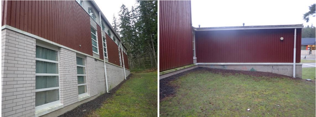
Kuvat 42 ja 43. Liikuntasalin ja kuntosalin ulkoseinärakenteet itäpäädyssä ovat osin maanvastaisia betonirakenteita.
