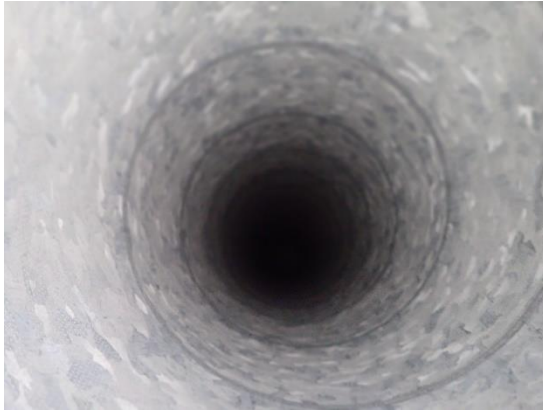
Kuva 139. Yleiskuvat tuloilmakanavasta. Tuloilmakanavien havaittiin olevan lähes puhtaat.
