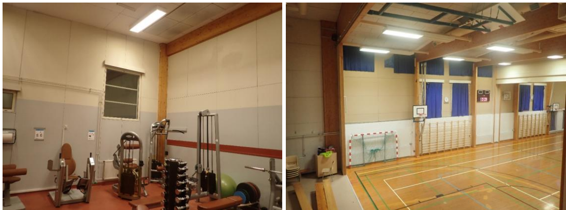
Kuvat 50 ja 51. Ulkoseinät ovat sisäpinoilta alaosista pääosin puhtaaksi muurattuja ja maalattuja kalkkihiekkatiiliseiniä. Rakennuksessa on myös puurunkoisia palo-ilves-levyillä verhoiltuja maalattuja ja maalaamattomia seiniä.
