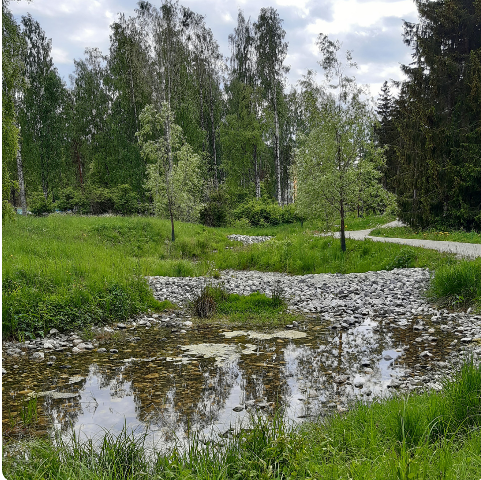
Sedimentation basin in Pääskynvuorenrinne, Turku. Photo: Anna Räisänen
