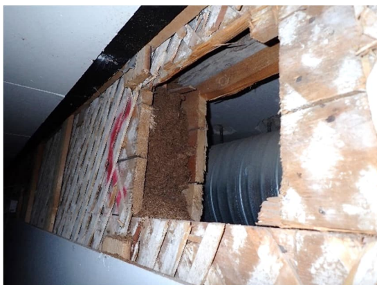
Kuva 150. Luokan 417 käytävään rajautuva väliseinä. Alakaton avaus R9.
