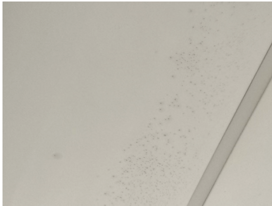
Kuvat 273 ja 274. Luokan 417 alakaton avaus R8 tehtiin kohtaan, jossa alakattolevyn alapinnassa havaittiin runsaasti mustia pisteitä. Alakaton takana olevassa kipsilevykatoissa ei havaittu kosteusjälkiä.
