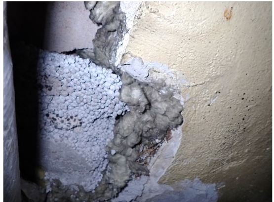
Kuvat 197 ja 198. Ruokailutilan 028 alakaton avaus R28. Huoneen kattotasoite lohkeilee paikoitellen isosti ja välipohjan läpiviennit ja paikkakohdat ovat osin epätiivittä.
