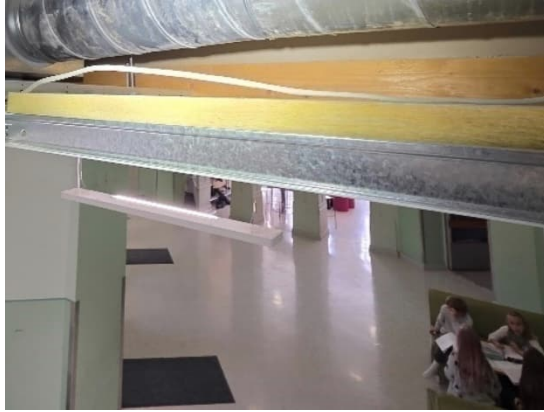
Kuvat 195 ja 196. Mineraalivilla-alakattojen reunat ja leikkauspinnat olivat osin käsittelemättä.
