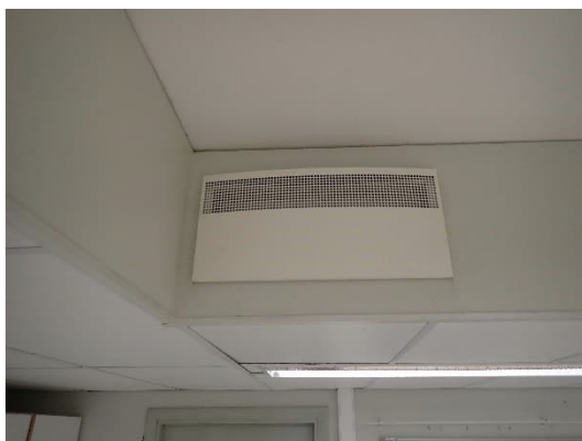
Kuvat 354 ja 355. Luokkatilassa 101 havaittiin tuloilman seinähajottajat. Toisessa tilan hajottajista havaittiin mittaus- ja säätöosan olevan pois paikaltaan. Tuloilmalaitteiden äänenvaimennusmateriaalit olivat polyesteriä.
