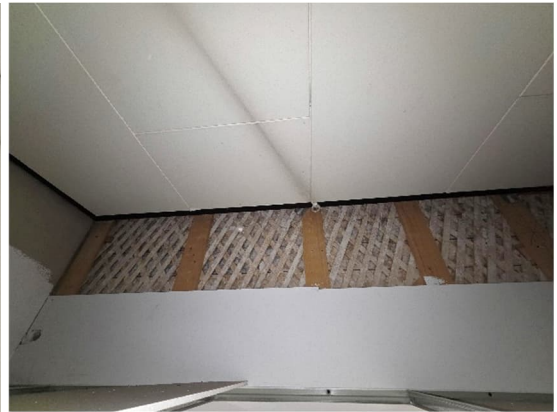
Kuvat 273 ja 274. Luokan 417 alakaton avaus R8 tehtiin kohtaan, jossa alakattolevyn alapinnassa havaittiin runsaasti mustia pisteitä. Alakaton takana olevassa kipsilevykatoissa ei havaittu kosteusjälkiä.
