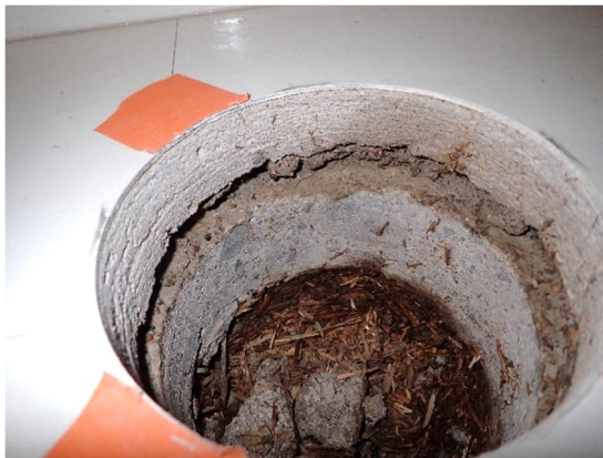
Kuvat 159 ja 160. Alkuperäisen osan välipohjan ylälaattapalkistoa järviruokoeristeellä ja erilaisilla pintakerroksilla. Kuvat ovat avauksista R32 ja R38.
