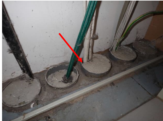
Kuvat 229 ja 230. Sähkökeskusten läpivienneissä havaittiin usean keskuksen kohdalla epätiiveyttä.
