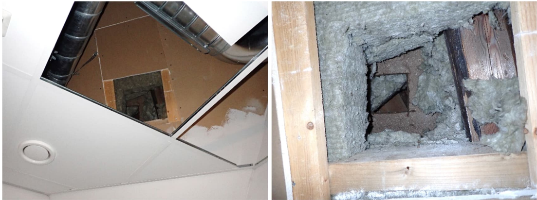
Kuvat 280 ja 281. Rakenneavaus R10. Wc-tilan 416a vinoa yläpohjaa avattiin ja rakenteessa on mineraalivillaa, mutta ei höyrynsulkua.
