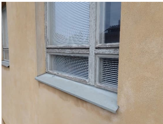
Kuvat 123 ja 124. Laajennusosan ikkunat olivat ulkopuolisilta osin huonokuntoisia. Maalipinnat olivat laajalti vaurioituneet (halkeilleet / lohkeilleet), puumateriaali oli harmaantunut ja halkeillut ja ikkunakittaukset halkeilivat ja lohkeilivat.
