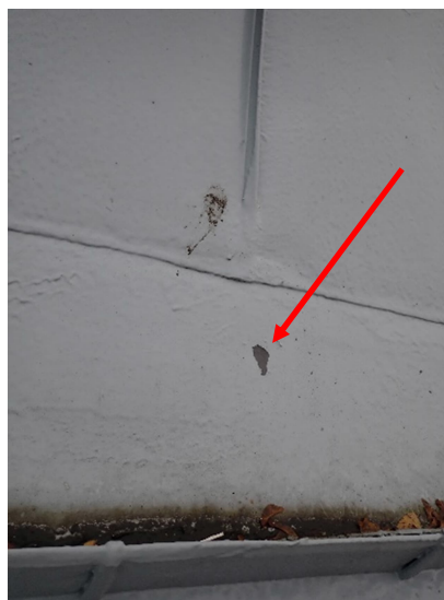
Kuvat 242 ja 243. Peltikatteen pinnoituksessa oli havaittavissa joitakin pieniä alueita, joista pinnoite on irronnut.
