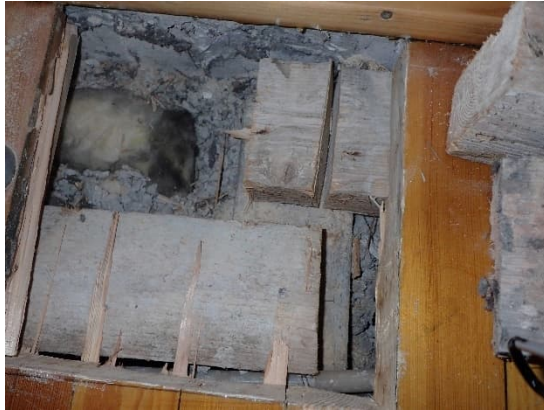
Kuvat 57 ja 58. Liikuntasalin 127 lattia avaus R25. Alapohjan eristeenä oli mineraalivillan lisäksi laastimurskaa ja tiiltä. Mineraalivillassa oli ilmavirtauksiin viittaavaa mustumista ja eristetilassa oli runsaasti hienojakoista pölyä. Lattialaudan alla oli näkyvää mikrobikasvua (soikio).
