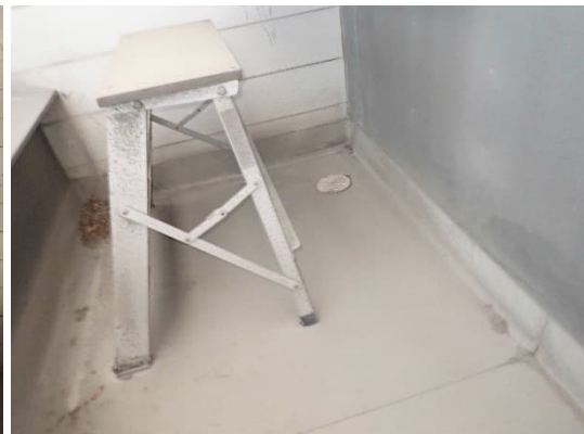
Kuvat 292 ja 293. Yleiskuvat ulkoilmasäleiköstä ulkoilmakammion sisäpuolelta ja ulkoilmakammion pohjalta. Ulkoilmasäleikkö on tavanomainen harvalamellisäleikkö ja kammio on varustettu viemäröinnillä. Lattiasaavutusten kosteuskätkien perusteella, kammioon kertyvä vesi ei ohjautu tehokkaasti lattiakaivolle.
