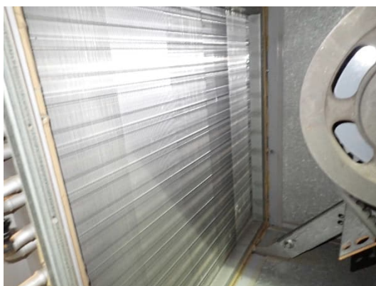
Kuvat 325 ja 326. Yleiskuvat lämmityspatterista ja poistoilmapuhaltimesta. Aistinvaraisen tarkastelun perusteella lämpöpatterin osissa tai tulo- ja poistoilmapuhaltimissa ei havaittu puutteita.
