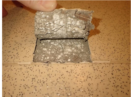
Kuvat 33 ja 34. Pukuhuoneen 040 mittapiste V1 ja pukuhuoneen 041 mittapiste V2. Kummassakin mittapisteessä oli korkeaa suhteellista kosteutta ja näkyvää mikrobikasvua muovimaton alla.
