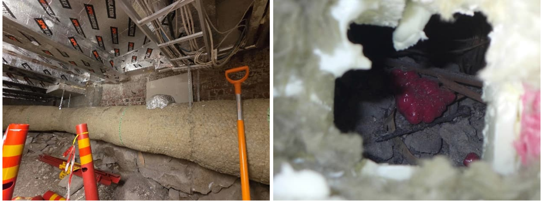
Kuvat 25 ja 26. Rakenneavaus R35 tehtiin näyttämön alustatilaan vievään luukkuun. Näyttämön alla maanpinta oli muuta ryömintätilaa korkeammalla ja pohjalla oli betonimurua ja puusilppua.
