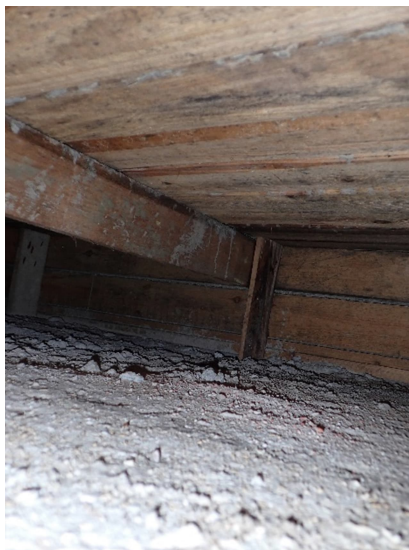
Kuvat 193 ja 194. Luokan 403 välikohdan avaus R46. Muottilaudoissa todettiin mikrobikasvustoa.
