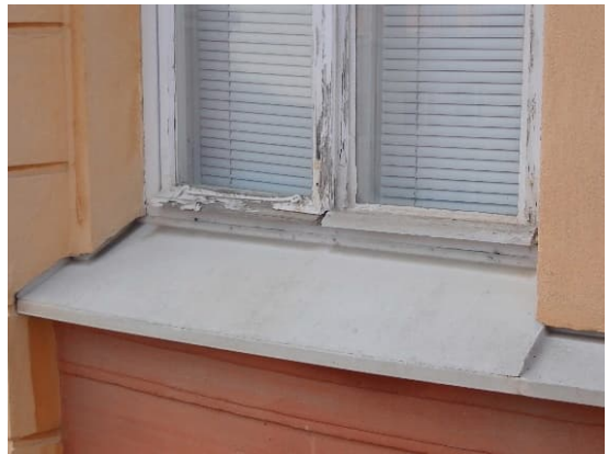
Kuvat 121 ja 122. Alkuperäisen osan korjaamattomien ikkunoiden ulkopuolella olivat huonokuntoisia. Maalipinnat olivat laajalti vaurioituneet (halkeilleet / lohkeilleet), puumateriaali oli harmaantunut ja halkeillut ja ikkunakittaukset halkeilivat ja lohkeilivat.
