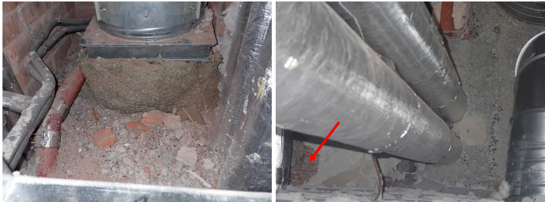
Kuvat 151 ja 152. Luokkien 108 ja 107 toisiaan vastaavat hormit olivat hyvin pölyisiä ja niissä on avointa mineraalivillapintaa. Kuvat ovat luokan 108 avauksesta R33. Läpiviennit on valettu umpeen kevytsorabetonilla. Hormin katossa näkyi hieman vanhaa eristettä (nuoli).
