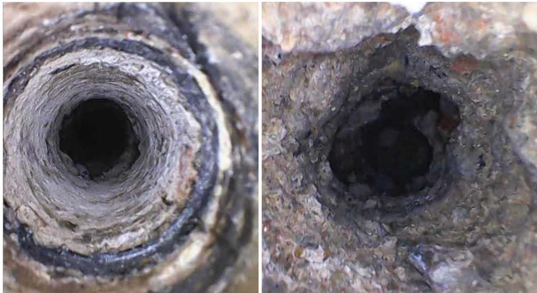
Kuvat 10 ja 11. Vanhan osan alapohjarakenne pukuhuoneessa 040. Rakenteessa ei ole lämmöneristettä ja pikisivelykerros on mahdollisesti paksu. Alapohjan alla on hiekkaa.
