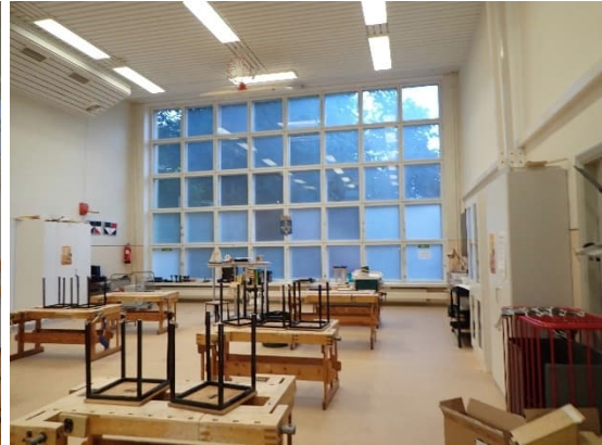
Kuvat 29 ja 30. Liikuntasalin 127 lattia on lauterlattiaa ja teknisentyön luokassa 001 liikuntasalin Pu-lastic-pinnoitteen päälle on asennettu lastulevytytys.
