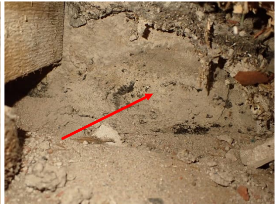
Kuvat 59 ja 60. Liikuntasalin 127 lattia avaus R26. Alapohjan pikisivelyn todettiin jatkuvan seinäpin-nalle, ja seinässä oli rappaus myös lattiarakenteen sisällä (nuoli).
