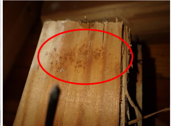
Kuvat 57 ja 58. Liikuntasalin 127 lattia avaus R25. Alapohjan eristeenä oli mineraalivillan lisäksi laastimurskaa ja tiiltä. Mineraalivillassa oli ilmavirtauksiin viittaavaa mustumista ja eristetilassa oli runsaasti hienojakoista pölyä. Lattialaudan alla oli näkyvää mikrobikasvua (soikio).
