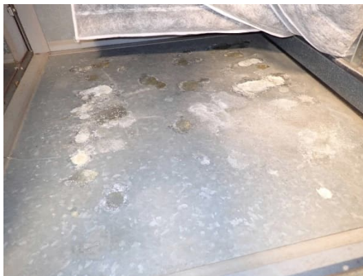
Kuvat 329 ja 330. Yleiskuvat ulkoilman suodatinosan pohjasta, sekä LTO-osan pohjasta. Molempien osien pohjilla havaittiin vanhoja kosteuden aiheuttamia jälkiä.
