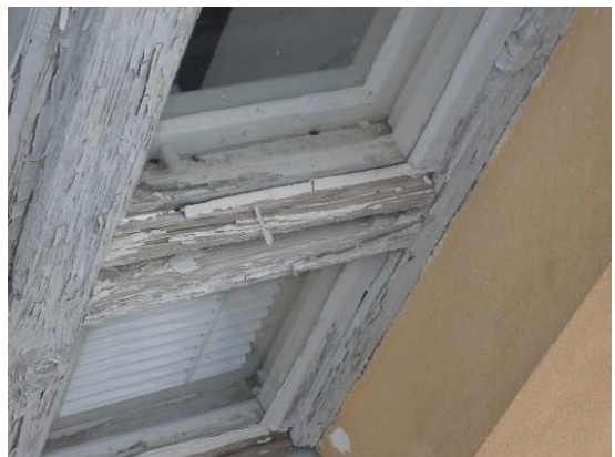
Kuvat 123 ja 124. Laajennusosan ikkunat olivat ulkopuolisilta osin huonokuntoisia. Maalipinnat olivat laajalti vaurioituneet (halkeilleet / lohkeilleet), puumateriaali oli harmaantunut ja halkeillut ja ikkunakittaukset halkeilivat ja lohkeilivat.
