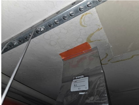
Kuvat 215 ja 216. Tilan 310 avauksen R16 kohdalla havaittiin kosteusjälkiä välipohjan alapinnassa ja mineraalivillalla tilkitty viemärin läpivienti.
