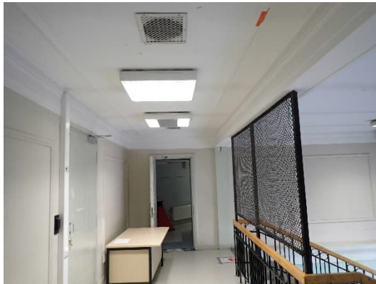
Kuvat 360 ja 361. Yleiskuvat poistoilman päätelaitteista. Porrashuoneessa havaittiin rakennuksen tyyliä mukailevat säleiköt, jotka ovat mahdollisesti painovoimaisen ilmanvaihdon aikaiset. Luokkatiloissa poistoilman päätelaitteet olivat suorakaiteen muotoisia säleiköitä.
