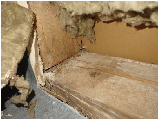
Kuvat 148 ja 149. Wc-tilan 416a väliseinän rakenneavaus R50. Alajuoksussa havaittiin kosteusjälki ja kipsilevyn taustapinnassa värimuutosta.
