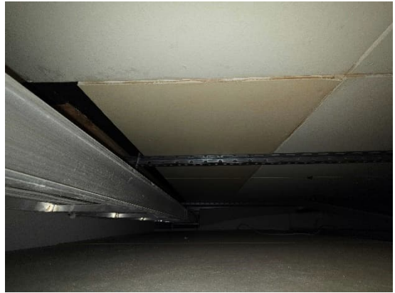
Kuvat 211 ja 212. Käytävän 308 avauksessa R15 havaittiin kosteusjälkiä kaapelihyllyn kannakkeen kohdalla ja vanhojen alakattolevyjen reunoilla.
