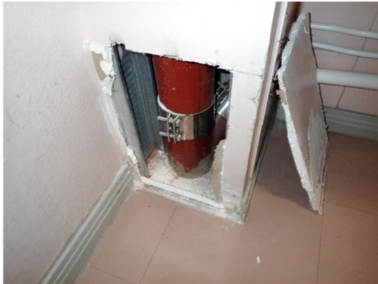
Kuvat 157 ja 158. Luokan 301 koteloinnin avausta R45. Koteloinnin pohjalla havaittiin kosteusjälkiä (nuolet).
