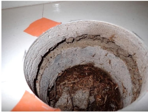
Kuva 181. Tilan 109 välipohjan avaus R32. Kohdassa ei todettu mikrobikasvustoa eristeessä.
