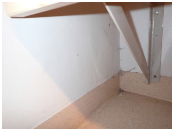
Kuvat 90 ja 91. Muun muassa pukuhuonetilojen 040 ja 041 maanvastaisissa seinissä todettiin kohonneita pintakosteusilmaisimen arvoja ja kupruavaa seinäpintaa.
