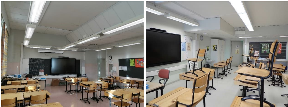
Kuvat 175 ja 176. Vasemmalla alkuperäisen osan luokkahuoneen kattoa ja oikealla laajennusosan.
