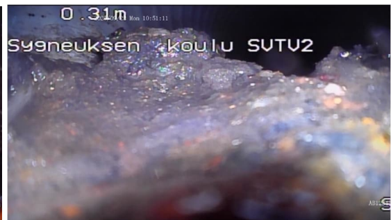
Kuvat 8 ja 9. Vasemmalla kuvauksen SVTV4 linjassa havaittu vierasesine. Oikealla kuvassa SVTV2 esimerkkikuva linjoissa havaitusta hiekkakertymästä.
