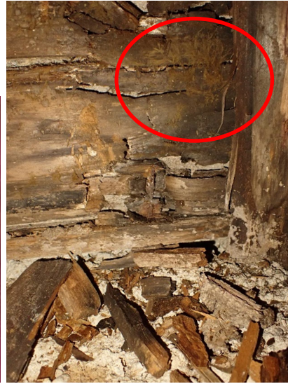
Kuvat 191 ja 192. Tilan 306 välikohdan avaus R43. Muottilaudoissa havaittiin lahoa, värimuutoksia ja rihmaa (ympyrä). Ylälaatan alapinnassa havaittiin myös mahdollista rihmaa, vasemmanpuoleinen kuva.
