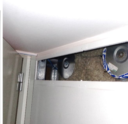
Kuvat 155 ja 156. Pukuhuoneen 040 koteloinnin avausta R70 ja epätiivis väliseinän läpivienti sekä liikuntasalin 127 varaston koteloinnin avausta R30 ja avointa mineraalivillapintaa.
