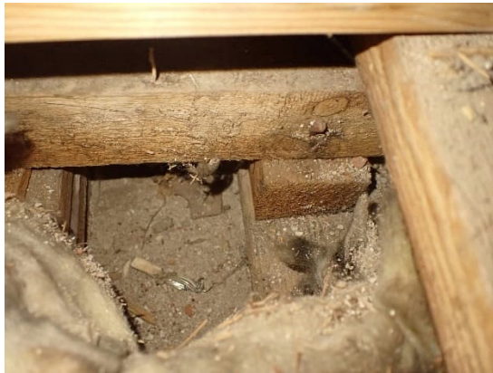
Kuvat 59 ja 60. Liikuntasalin 127 lattia avaus R26. Alapohjan pikisivelyn todettiin jatkuvan seinäpin-nalle, ja seinässä oli rappaus myös lattiarakenteen sisällä (nuoli).
