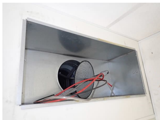
Kuvat 354 ja 355. Luokkatilassa 101 havaittiin tuloilman seinähajottajat. Toisessa tilan hajottajista havaittiin mittaus- ja säätöosan olevan pois paikaltaan. Tuloilmalaitteiden äänenvaimennusmateriaalit olivat polyesteriä.
