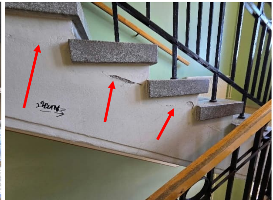
Kuva 163 ja 164. Alkuperäisen osan pääportaikon sivussa havaittua halkeamaa.
