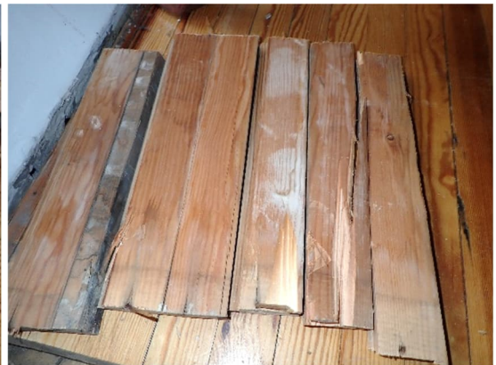
Kuvat 61 ja 62. Rakenneavaus R27. Liikuntasalin varaston lattia avaus R27. Lattialautojen alla oli kosteusjälkiä, mutta puuosissa ei todettu koholla olevaa kosteutta piikkimittarilla.
