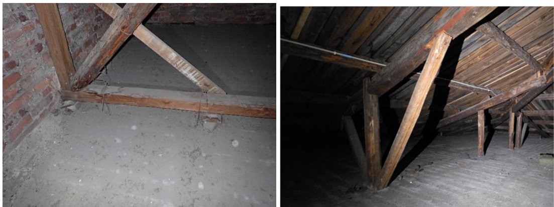
Kuvat 251 ja 252. Vesikaton puurakenteet lähtevät pääosin palopermannon päältä, mutta tilassa 503 ne lähtevät betonirakenteen sisältä (oikeanpuoleinen kuva).
