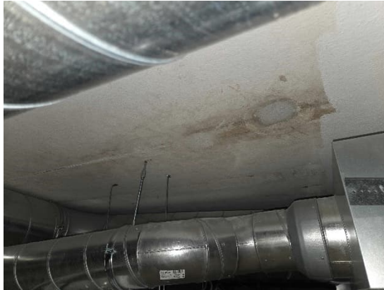
Kuvat 223 ja 224. Luokan 101 avauksessa R6 välipohjalaatan alapinnassa havaittiin vanhoja kosteusjälkiä sekä pinnoittamattomalla mineraalivillalla eristetty ilmanvaihtokanava.
