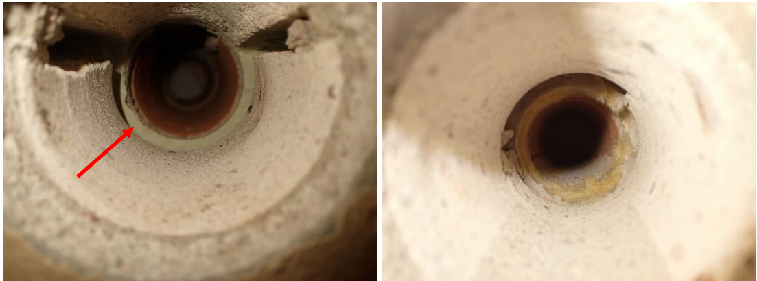
Kuvat 86 ja 87. Laajennusosan tilojen 215 ja 403 ulkoseinän vanhat patterisyyvennykset rakenneavauksissa R40 ja R47. Vasemmanpuoleisessa kuvassa näkyy vanha sisämaali (nuoli). Oikeanpuoleisessa kuvassa näkyy avauksen R47 kahi-tiilen takana oleva mineraalivilla.
