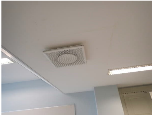
Kuvat 358 ja 359. Yleiskuvat 4.krs aulatilän kattohajottajasta. Hajottajan äänenvaimennuslevyt olivat polyesterilevyjä.
