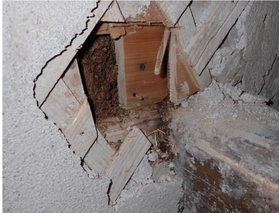
Kuva 89. Alkuperäisen osan luokan 417 sivuvintin ulkoseinärakenne rakenneavauksessa R54. Tikku-rappauksen takana oli laudoitus ja turve-eriste.
