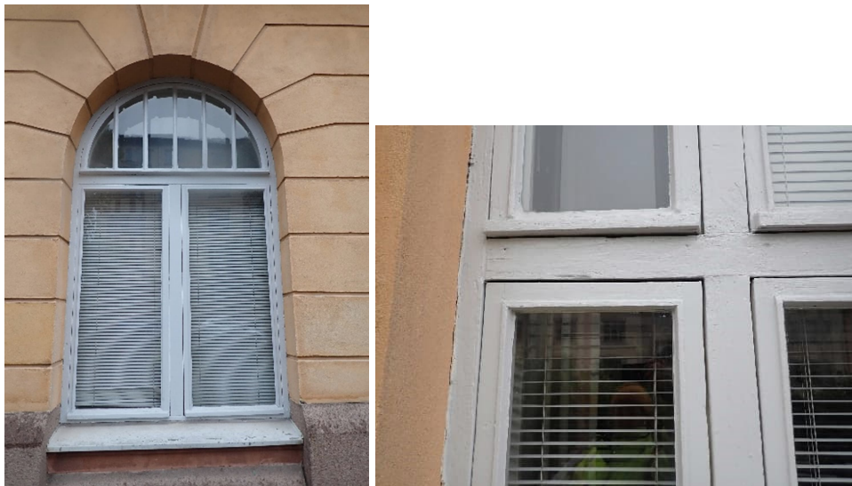
Kuvat 117 ja 118. Kunnostetut ikkunat olivat ulkopuolisilta osin hyväkuntoisia.
