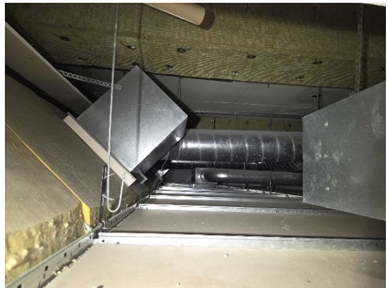
Kuvat 213 ja 214. Luokan 309 avauksessa R17 havaittiin alakaton takana pinnoittamatonta mineraalivillaa.
