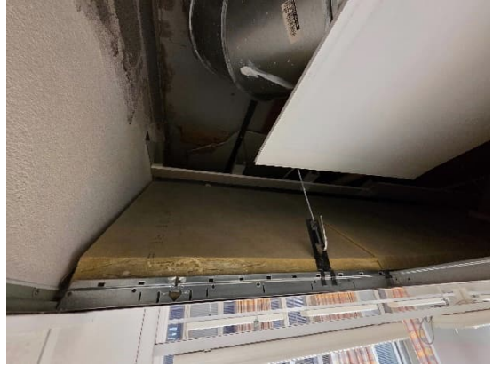
Kuvat 195 ja 196. Mineraalivilla-alakattojen reunat ja leikkauspinnat olivat osin käsittelemättä.
