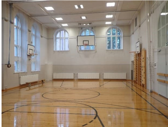
Kuvat 29 ja 30. Liikuntasalin 127 lattia on lauterlattiaa ja teknisentyön luokassa 001 liikuntasalin Pu-lastic-pinnoitteen päälle on asennettu lastulevytytys.
