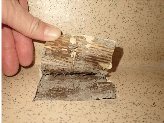
Kuvat 33 ja 34. Pukuhuoneen 040 mittapiste V1 ja pukuhuoneen 041 mittapiste V2. Kummassakin mittapisteessä oli korkeaa suhteellista kosteutta ja näkyvää mikrobikasvua muovimaton alla.
