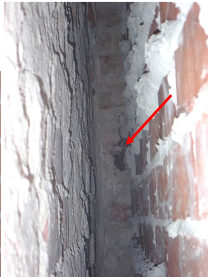
Kuvat 95 ja 96. Ruokailutilan 028 tiilimuurauksen luukun avausta R61. Muurauksessa oli puutappeja (ympyrä) ja ulkoseinän taitteessa oli pikisivelyä noin metrin korkeudella (nuoli).
