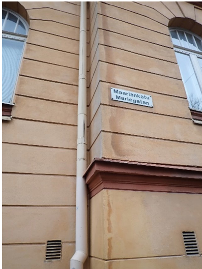
Kuvat 247 ja 248. Syöksytorvien saumat olivat paikoin auenneet.
