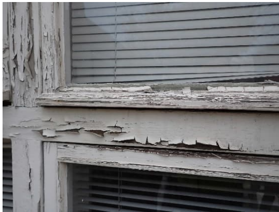
Kuvat 121 ja 122. Alkuperäisen osan korjaamattomien ikkunoiden ulkopuolella olivat huonokuntoisia. Maalipinnat olivat laajalti vaurioituneet (halkeilleet / lohkeilleet), puumateriaali oli harmaantunut ja halkeillut ja ikkunakittaukset halkeilivat ja lohkeilivat.
