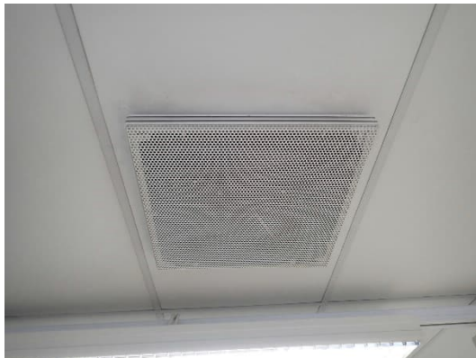
Kuvat 352 ja 353. Yleiskuva luokkatiloissa yleisesti havaitusta tuloilmahajottajasta. Tilassa 417 tuloilmapäättelaitteen tasauslaatikon säätöosan havaittiin olevan pois paikoiltaan. Tasauslaatikoiden äänenvaimennuslevyt olivat kangaspinnoitettut.
