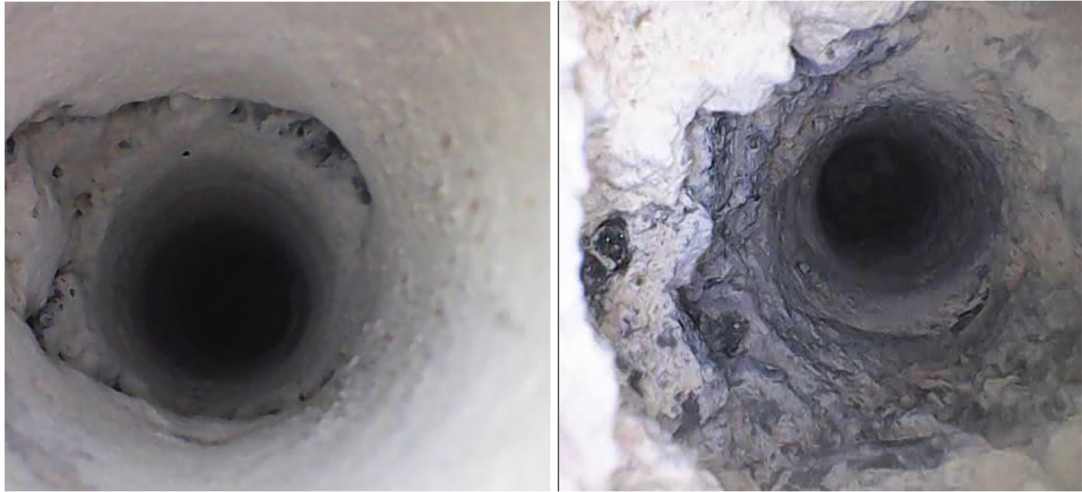
Kuvat 14 ja 15. Keittiön takatilan 017 alapohja porauksissa P23 ja P24. Alapohjassa on todennäköisesti kevytsorabetonia.
