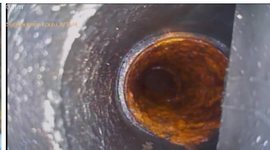
Kuvat 373 ja 374. Vasemmalla kuva tuuletusviemäriinlinjasta JTVT6, jossa putken sisäpinnalla on irronnut ja korroosio syönyt putken materiaalia pinoitteen alta. Oikealla kuva linjasta JTVT4, jossa kerrosten lattiakaivon lähdestä kuvattuna valurautaviemäriinlinjaa, jossa runsaasti korroosiota sisäpinnalla.
