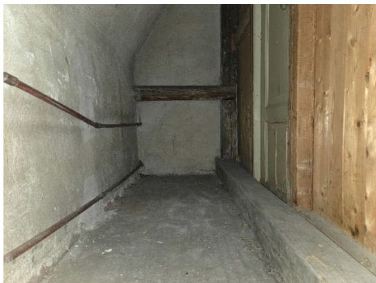
Kuvat 271 ja 272. Sivuvinteissä on vanhoja lämpöjohtoja ja avonaisia hormoneja rakenteissa.
