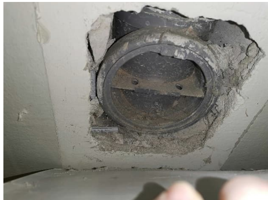
Kuvat 143 ja 144. Hormin umpeen maalattu tarkastusluukku luokassa 108 ja väliseinän sisällä oleva putkikuilu viemäriin wc-tilassa 036, avaus R68.
