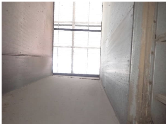
Kuvat 321 ja 322. Yleiskuvat ulkoilmakanavan sisästä ja ulkoilmasuodattimesta. Tuloilmasuodatin ei asetu täysin tiiviisti suodatinkehukseen nähden.
