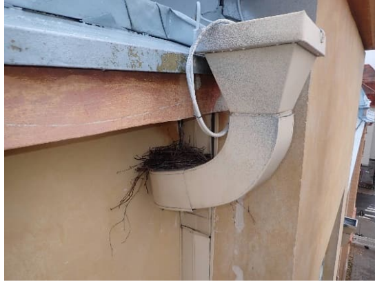
Kuvat 245 ja 246. Alkuperäisessä osassa on pyöreät rungon ulkopuoliset syöksytorvet ja laajennusosalla kantikkaat seinän sisään vedetyt syöksytorvet. Syöksytorvissa on saattokaapelointi.
