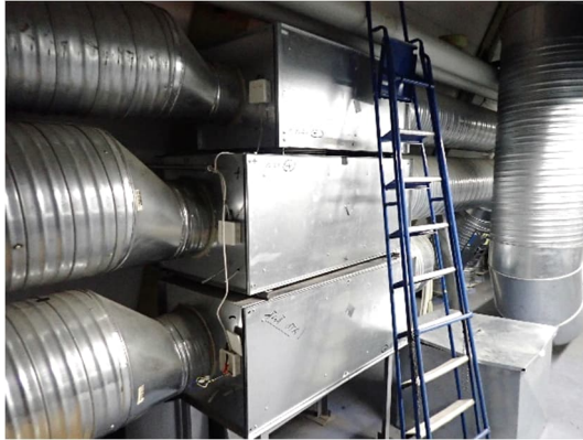
Kuvat 350 ja 351. Yleiskuvat ilmanvaihtokoneen TK10 ilmavirtaussäätimistä, jotka on poistettu käytöstä (käyttäjännite- ja säätöviesti irti kytketty).
