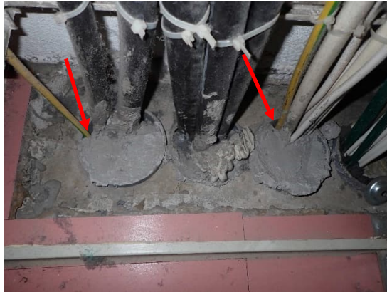
Kuvat 229 ja 230. Sähkökeskusten läpivienneissä havaittiin usean keskuksen kohdalla epätiiveyttä.
