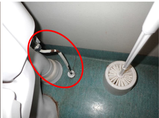
Kuva 288 ja 289. Siivouskomeron 411 vuotava räätipatteri ja wc-tilan vuotava vesijohto.
