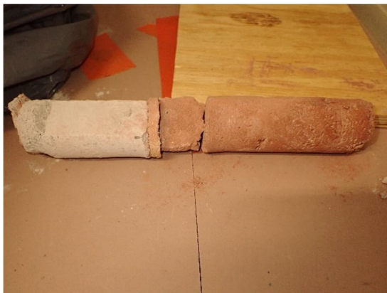
Kuva 88. Laajennusosan tilan 306 ulkoseinän vanha patterisyyvennys rakenneavauksessa R44.
