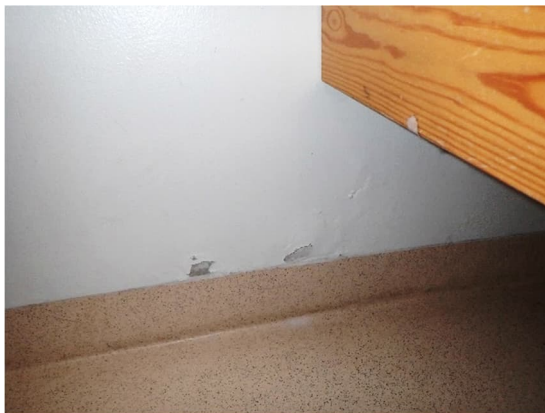
Kuvat 90 ja 91. Muun muassa pukuhuonetilojen 040 ja 041 maanvastaisissa seinissä todettiin kohonneita pintakosteusilmaisimen arvoja ja kupruavaa seinäpintaa.
