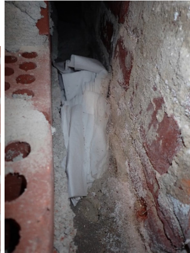
Kuvat 93 ja 94. Ruokailutilan 028 tiilimuurauksen luukun avausta R50. Muurauksen takana oli pölyä ja hämähäkinseittiä sekä roskaa.
