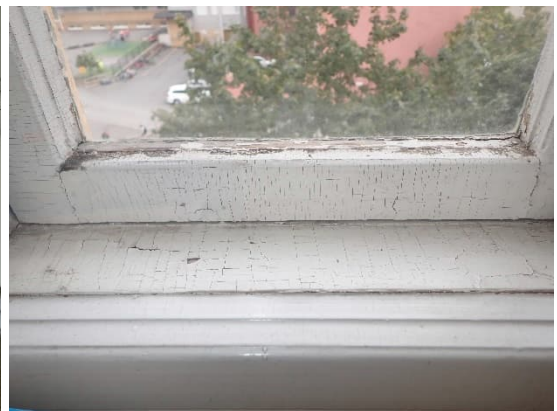
Kuvat 113 ja 114. Alkuperäisen osan ikkunoiden lasivälit olivat vaihtelevassa kunnossa.
