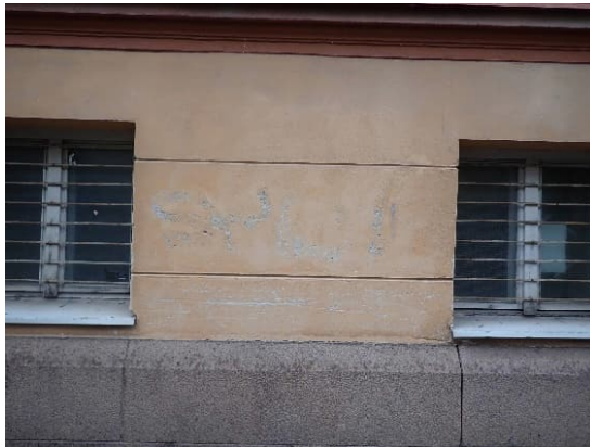
Kuvat 65 ja 66. Rappauksessa esiintyviä yksittäisiä vaurioita, esim. alaosassa mekaanisesta rasituksesta aiheutunut pinnoitteen vaurioituminen sekä yksittäinen rappauksen halkeama.
