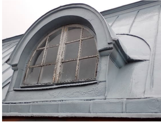
Kuvat 119 ja 120. Kattoikkunat molemmilla puolin rakennusta olivat osin huonokuntoisia.
