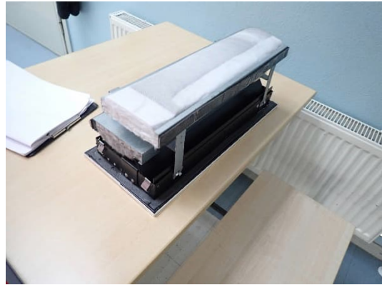
Kuvat 356 ja 357. Yleiskuvat 4.krs käytävälän tuloilman seinähajottajasta. Hajottajan äänenvaimennuslevyt olivat polyesterilevyjä.
