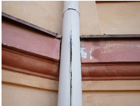
Kuvat 247 ja 248. Syöksytorvien saumat olivat paikoin auenneet.
