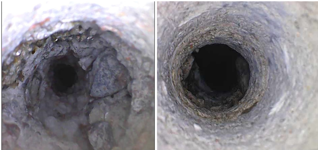
Kuvat 12 ja 13. Vanhan osan alapohjarakenne ruokalassa 028. Keskellä huonetta alapohja on uusittu ja sen eristeenä on EPS (vasemmanpuoleinen kuva). Maanvastaisen seinän vierellä rakenteessa on ohut betonilaatta ilman lämmöneristettä.
