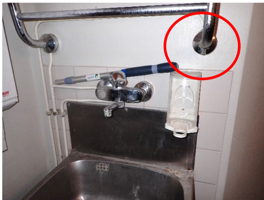
Kuva 288 ja 289. Siivouskomeron 411 vuotava räätipatteri ja wc-tilan vuotava vesijohto.
