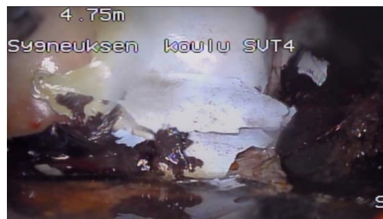
Kuvat 8 ja 9. Vasemmalla kuvauksen SVTV4 linjassa havaittu vierasesine. Oikealla kuvassa SVTV2 esimerkkikuva linjoissa havaitusta hiekkakertymästä.
