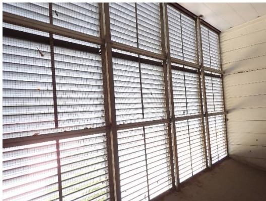
Kuvat 292 ja 293. Yleiskuvat ulkoilmasäleiköstä ulkoilmakammion sisäpuolelta ja ulkoilmakammion pohjalta. Ulkoilmasäleikkö on tavanomainen harvalamellisäleikkö ja kammio on varustettu viemäröinnillä. Lattiasaavutusten kosteuskätkien perusteella, kammioon kertyvä vesi ei ohjautu tehokkaasti lattiakaivolle.
