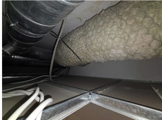
Kuvat 223 ja 224. Luokan 101 avauksessa R6 välipohjalaatan alapinnassa havaittiin vanhoja kosteusjälkiä sekä pinnoittamattomalla mineraalivillalla eristetty ilmanvaihtokanava.
