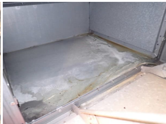
Kuvat 329 ja 330. Yleiskuvat ulkoilman suodatinosan pohjasta, sekä LTO-osan pohjasta. Molempien osien pohjilla havaittiin vanhoja kosteuden aiheuttamia jälkiä.
