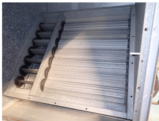
Kuvat 323 ja 324. Yleiskuvat ulkoilman suodatinosan pohjasta, missä havaittiin kosteusjälkiä ja lämmönlähteen peltistä. Vanhoja kosteusjälkiä havaittiin myös LTO-osan pohjalla.
