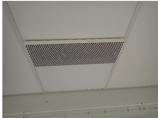
Kuvat 360 ja 361. Yleiskuvat poistoilman päätelaitteista. Porrashuoneessa havaittiin rakennuksen tyyliä mukailevat säleiköt, jotka ovat mahdollisesti painovoimaisen ilmanvaihdon aikaiset. Luokkatiloissa poistoilman päätelaitteet olivat suorakaiteen muotoisia säleiköitä.
