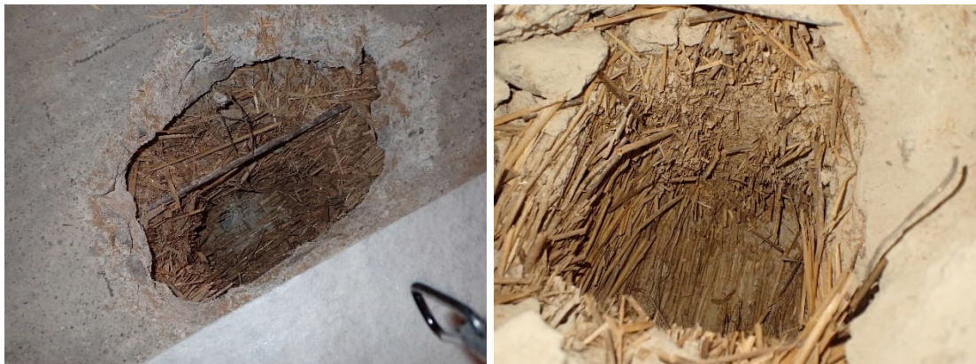
Kuvat 259 ja 260. Alkuperäisen osan yläpohjan avaukset R56 ja R57.
