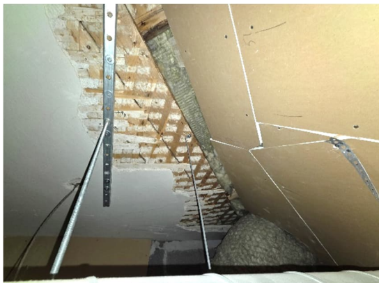
Kuvat 278 ja 279. Wc-tilan 416a avauksessa R10 alaslaskun yläpuolella yläpohjan läpiviennit ja rakenneliittymät olivat epätiivittä.
