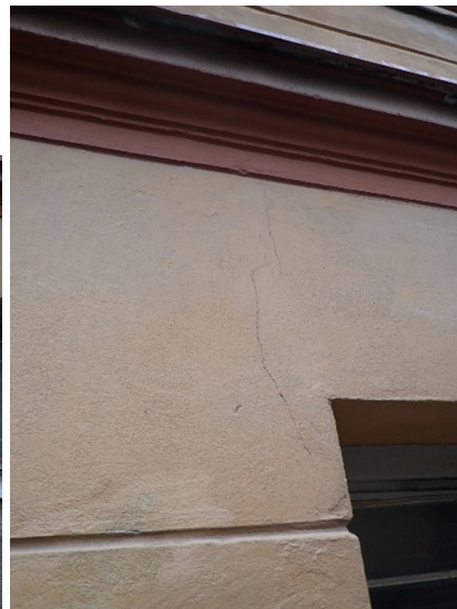
Kuvat 65 ja 66. Rappauksessa esiintyviä yksittäisiä vaurioita, esim. alaosassa mekaanisesta rasituksesta aiheutunut pinnoitteen vaurioituminen sekä yksittäinen rappauksen halkeama.
