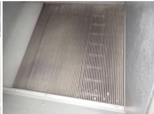
Kuvat 327 ja 328. Yleiskuvat ulkoilman suodattimesta ja suodatinkehystä, suodatin ei asetu tiiviisti kehykseen. Toisessa kuvassa on LTO-kenno, joka on silmämääräisesti hieman pölyyntynyt.
