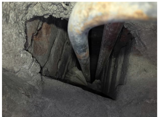
Kuvat 271 ja 272. Sivuvinteissä on vanhoja lämpöjohtoja ja avonaisia hormoneja rakenteissa.
