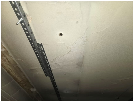
Kuvat 217 ja 218. Luokan 311 avauksien R18 ja R19 kohdalla välipohjan alapinnassa havaittiin laajalti rappauksen irtoilua ja vanhoja kosteusjälkiä. Alakaton takana oli runsaasti pinnoittamatonta mineraalivillaeristettä.
