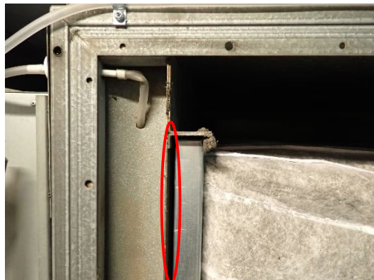
Kuvat 321 ja 322. Yleiskuvat ulkoilmakanavan sisästä ja ulkoilmasuodattimesta. Tuloilmasuodatin ei asetu täysin tiiviisti suodatinkehukseen nähden.
