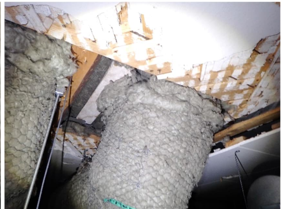
Kuvat 275 ja 276. Luokan 417 alakaton avaus R9 tehtiin laajalle alalle huoneen alakattoon. Alkuperäisen yläpohjan todettiin olevan hyvin epätiivis ilmanvaihtoasennusten kohdalla. Vanhassa rappauspinnassa havaittiin kosteusjälkiä (soikio).
