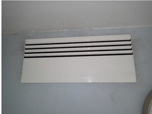
Kuvat 356 ja 357. Yleiskuvat 4.krs käytävälän tuloilman seinähajottajasta. Hajottajan äänenvaimennuslevyt olivat polyesterilevyjä.
