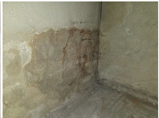
Kuvat 265 ja 266. Luokahuoneen 417 sivuvinttien ulkoseinässä oli kosteusjälkiä. Soikion alueella todettiin koholla olevia pintakosteusilmaisimen arvoja.
