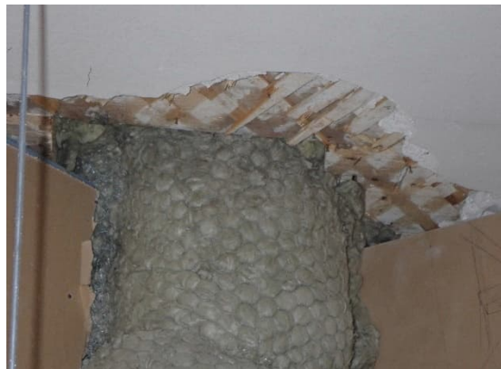
Kuvat 278 ja 279. Wc-tilan 416a avauksessa R10 alaslaskun yläpuolella yläpohjan läpiviennit ja rakenneliittymät olivat epätiivittä.
