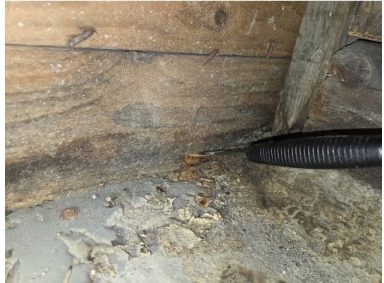
Kuvat 267 ja 268. Vanhoja kosteusjälkiä ja puurakenteen lahoa luokahuoneen 418 isomman sivuvintin kulkuaukon edustalla.
