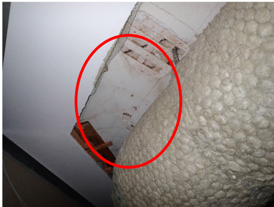
Kuvat 275 ja 276. Luokan 417 alakaton avaus R9 tehtiin laajalle alalle huoneen alakattoon. Alkuperäisen yläpohjan todettiin olevan hyvin epätiivis ilmanvaihtoasennusten kohdalla. Vanhassa rappauspinnassa havaittiin kosteusjälkiä (soikio).
