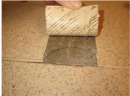
Kuvat 35 ja 36. Pukuhuoneen 041 mittapistet V3 ja V4. Mittapisteessä V3 oli korkeaa suhteellista kosteutta ja näkyvää mikrobikasvua maton alla. Mittapiste V4 oli vertailukohta ja siinä ei todettu koholla olevaa suhteellista kosteutta. Aistinvaraisen arvion perusteella maton alla oli lievä kemiallinen haju.
