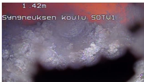
Kuvat 6 ja 7. Vasemmalla kuvauksen SOTV1 linjan kertymää, joka estää linjan toiminnan ja havainnoinnin, onko linja tulpattu. Oikealla kuva kuvauksen SOTV7 linjan aaltoilusta ja täyttöasteesta.
