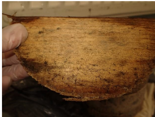
Kuvat 193 ja 194. Luokan 403 välikohdan avaus R46. Muottilaudoissa todettiin mikrobikasvustoa.
