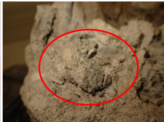
Kuvat 182 ja 183. Luokan 119 välipohjan avaus R31. Ylälaattaa on paikattu ulkoseinän viereltä. Paikkauksen pohjalla olevassa kuituisessa tasoitteessa tai betonissa ei ollut asbestia (ympyrä). Järviruukoeristeessä todettiin mikrobikasvustoa.
