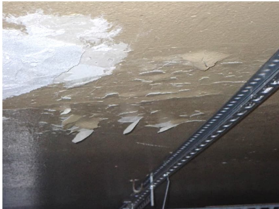
Kuvat 197 ja 198. Ruokailutilan 028 alakaton avaus R28. Huoneen kattotasoite lohkeilee paikoitellen isosti ja välipohjan läpiviennit ja paikkakohdat ovat osin epätiivittä.
