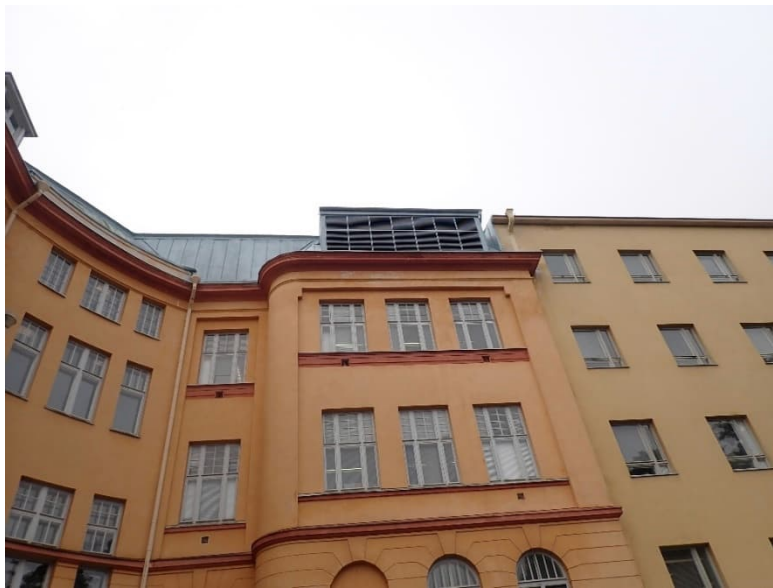
Kuva 291. Kuvassa on koulun ilmanvaihdon ulkoilmasäleikkö, minkä takana on ilmanvaihtokoneiden yhteinen ulkoilmakammio, mistä ulkoilman otot jakautuvat tuloilmakoneille.
