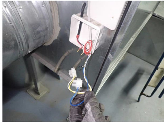
Kuvat 350 ja 351. Yleiskuvat ilmanvaihtokoneen TK10 ilmavirtaussäätimistä, jotka on poistettu käytöstä (käyttäjännite- ja säätöviesti irti kytketty).
