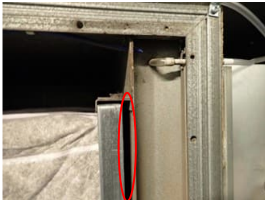
Kuvat 327 ja 328. Yleiskuvat ulkoilman suodattimesta ja suodatinkehystä, suodatin ei asetu tiiviisti kehykseen. Toisessa kuvassa on LTO-kenno, joka on silmämääräisesti hieman pölyyntynyt.
