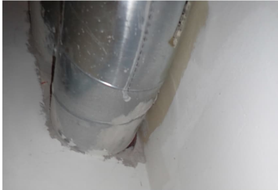
Kuvat 155 ja 156. Pukuhuoneen 040 koteloinnin avausta R70 ja epätiivis väliseinän läpivienti sekä liikuntasalin 127 varaston koteloinnin avausta R30 ja avointa mineraalivillapintaa.
