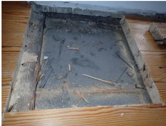
Kuva 18. Liikuntasalin 127 takavaraston alapohja, avaus R27.
