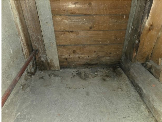
Kuvat 267 ja 268. Vanhoja kosteusjälkiä ja puurakenteen lahoa luokahuoneen 418 isomman sivuvintin kulkuaukon edustalla.
