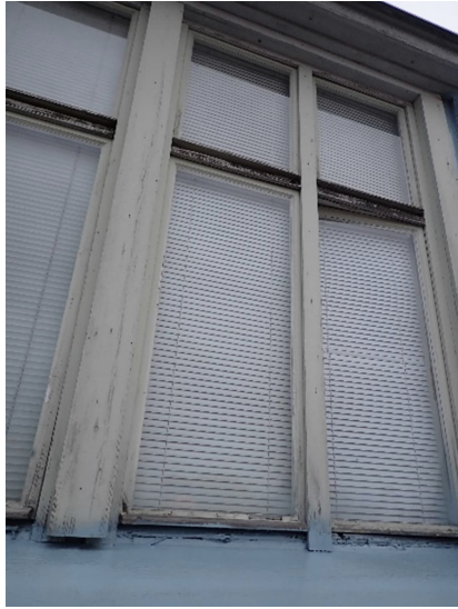
Kuvat 119 ja 120. Kattoikkunat molemmilla puolin rakennusta olivat osin huonokuntoisia.
