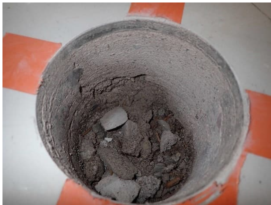
Kuvat 182 ja 183. Luokan 119 välipohjan avaus R31. Ylälaattaa on paikattu ulkoseinän viereltä. Paikkauksen pohjalla olevassa kuituisessa tasoitteessa tai betonissa ei ollut asbestia (ympyrä). Järviruukoeristeessä todettiin mikrobikasvustoa.
