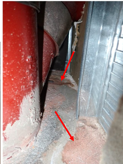
Kuvat 157 ja 158. Luokan 301 koteloinnin avausta R45. Koteloinnin pohjalla havaittiin kosteusjälkiä (nuolet).
