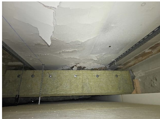
Kuvat 217 ja 218. Luokan 311 avauksien R18 ja R19 kohdalla välipohjan alapinnassa havaittiin laajalti rappauksen irtoilua ja vanhoja kosteusjälkiä. Alakaton takana oli runsaasti pinnoittamatonta mineraalivillaeristettä.
