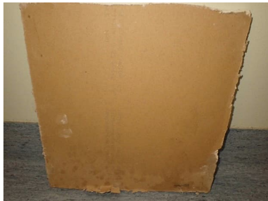
Kuvat 148 ja 149. Wc-tilan 416a väliseinän rakenneavaus R50. Alajuoksussa havaittiin kosteusjälki ja kipsilevyn taustapinnassa värimuutosta.
