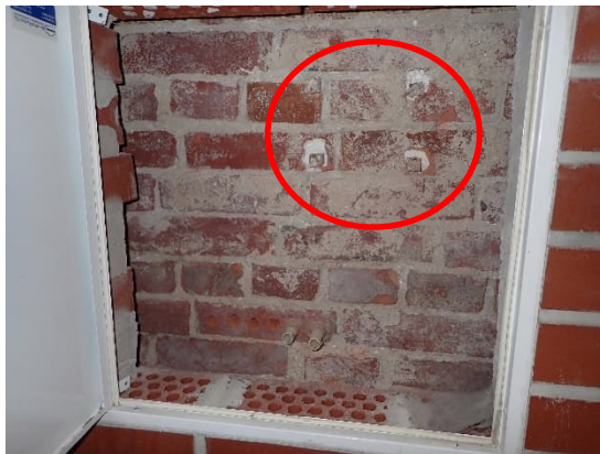
Kuvat 95 ja 96. Ruokailutilan 028 tiilimuurauksen luukun avausta R61. Muurauksessa oli puutappeja (ympyrä) ja ulkoseinän taitteessa oli pikisivelyä noin metrin korkeudella (nuoli).
