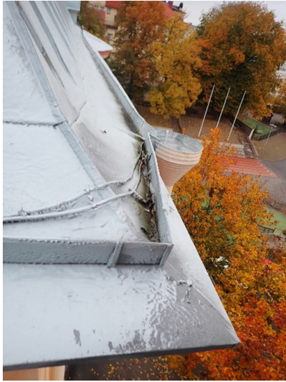
Kuvat 245 ja 246. Alkuperäisessä osassa on pyöreät rungon ulkopuoliset syöksytorvet ja laajennusosalla kantikkaat seinän sisään vedetyt syöksytorvet. Syöksytorvissa on saattokaapelointi.
