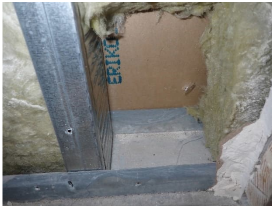
Kuva 147. Tilan 216 väliseinä rakenneavauksessa R42.
