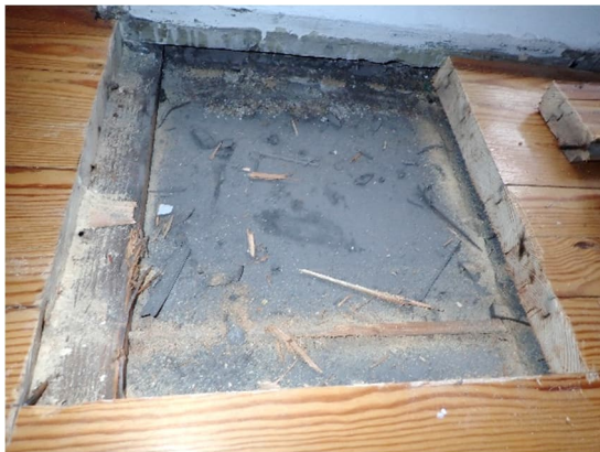
Kuvat 61 ja 62. Rakenneavaus R27. Liikuntasalin varaston lattia avaus R27. Lattialautojen alla oli kosteusjälkiä, mutta puuosissa ei todettu koholla olevaa kosteutta piikkimittarilla.
