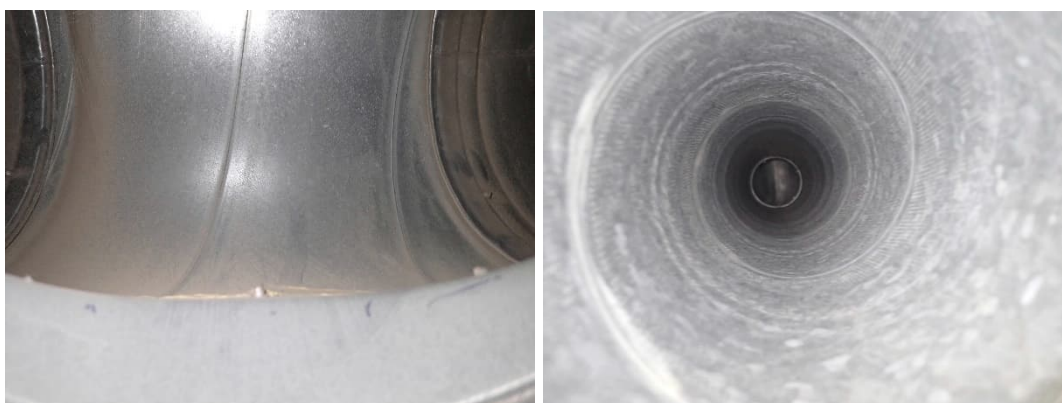
Kuvat 348 ja 349. Yleiskuvat luokka- ja käytävätilojen poistoilman kytchentäkanavien sisäältä. Kanavat olivat hieman pölyiset.
