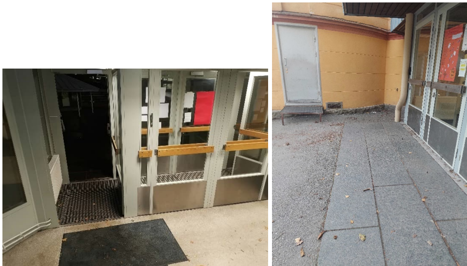
Kuvat 135 ja 136. Metallirakenteisissa ulko-ovissa ei havaittu merkittäviä puutteita.
