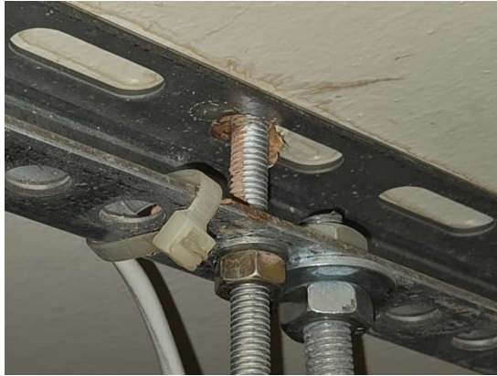
Kuvat 211 ja 212. Käytävän 308 avauksessa R15 havaittiin kosteusjälkiä kaapelihyllyn kannakkeen kohdalla ja vanhojen alakattolevyjen reunoilla.
