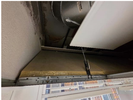
Kuvat 213 ja 214. Luokan 309 avauksessa R17 havaittiin alakaton takana pinnoittamatonta mineraalivillaa.
