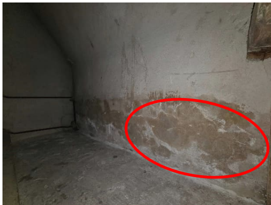
Kuvat 265 ja 266. Luokahuoneen 417 sivuvinttien ulkoseinässä oli kosteusjälkiä. Soikion alueella todettiin koholla olevia pintakosteusilmaisimen arvoja.
