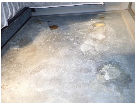
Kuvat 323 ja 324. Yleiskuvat ulkoilman suodatinosan pohjasta, missä havaittiin kosteusjälkiä ja lämmönlähteen peltistä. Vanhoja kosteusjälkiä havaittiin myös LTO-osan pohjalla.
