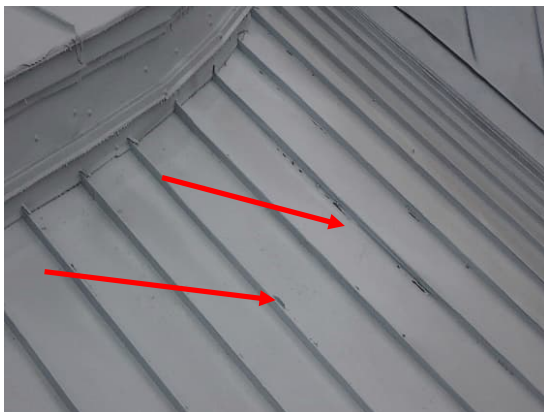
Kuvat 242 ja 243. Peltikatteen pinnoituksessa oli havaittavissa joitakin pieniä alueita, joista pinnoite on irronnut.
