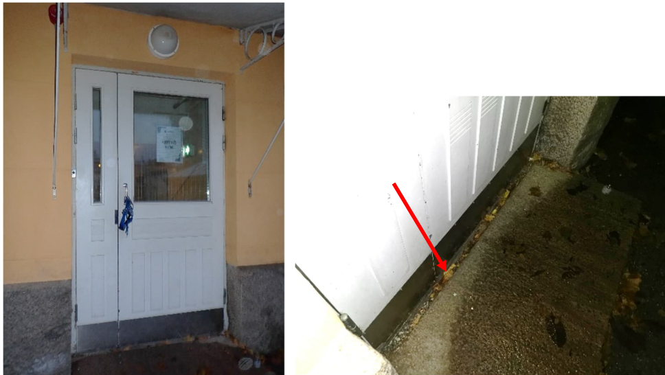
Kuvat 131 ja 132. Keittiön ovi on uusittu ja sen pinnoite oli kulunut ovilehden reunoilta. Oven ja askelman välissä oli iso rako (nuoli).
