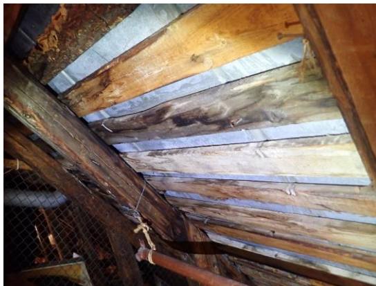
Kuvat 160 ja 161. Ullakkotilassa havaittiin useita vanhoja jo kuivuneita vesikaton vuodoista tai kondensoitumisesta aiheutuneita kosteusvaurioalueita.
