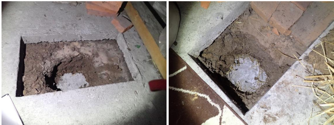
Kuvat 134 ja 135. Yleiskuvat yläpohjarakenteen rakenneavauksesta (R5 YP ja R7 YP).
