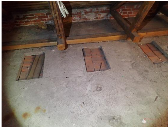
Kuvat 165 ja 166. Pintabetonilaatassa on säännöllisin välein aukkoja (palkkiväleissä), jotka ovat ummistettu pääosin tiilillä. Kulkuväylillä aukot on valettu umpeen.
