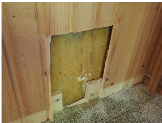
Kuva 59. Rakenneavaus R16 US. Rakenneavaus R16 US tehtiin asunnon 3 kuistin ulkoseinään. Rakenneavauksesta ei otettu näytteitä.
