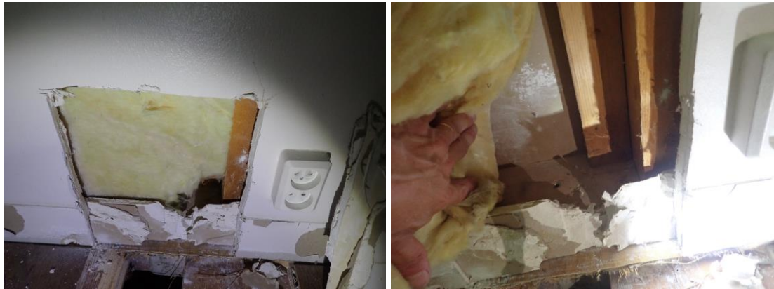
Kuvat 84 ja 85. Rakenneavaus R13 VS. Väliseinärakenteen tarkastus makuuhuoneen puolelta. Rakenneavauksesta otettiin näyte N12 (mineraalivilla) mikrobialyysiin. Näytteessä ei esiintynyt mikrobikasvustoa.
