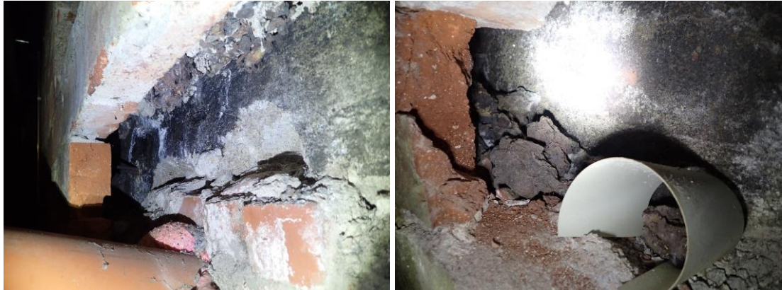
Kuvat 62 ja 63. Rakenneseinäkavat R21 MVS ja R22 MVS tarkastettiin varastotilojen maanvastaisesta seinärakenteesta. Rakenneseinäkavasta ei otettu näytteitä.
