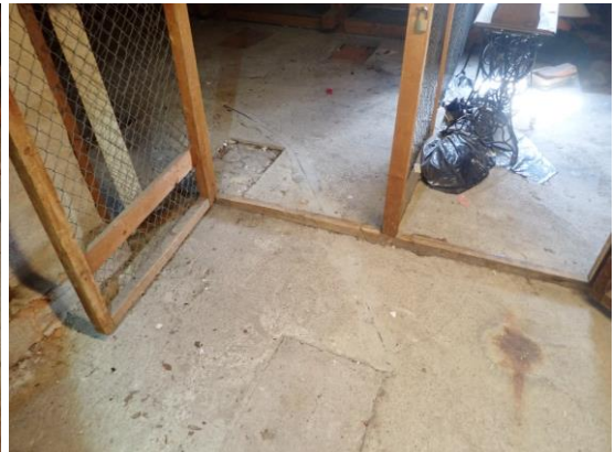
Kuvat 165 ja 166. Pintabetonilaatassa on säännöllisin välein aukkoja (palkkiväleissä), jotka ovat ummistettu pääosin tiilillä. Kulkuväylillä aukot on valettu umpeen.
