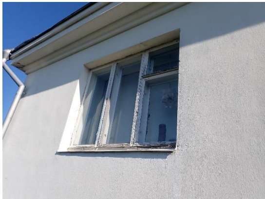
Kuvat 64 ja 65. Asuinkerrosten ikkunat ovat puurakenteisia MSU-tyypin sisään-ulos-aukeavia kaksipuitteisia ja kaksilasisia ikkunoita. Ullakon ikkunat ovat yksipuitteisia ja yksilasisia ikkunoita.
