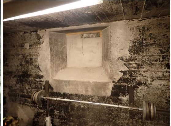
Kuvat 52 ja 53. Kellarikerroksen maanvastaiset seinät ovat ulkokuoreltaan betonia. Seinien sisäpuolella on paikoin tiiliset kuorimuuraukset.
