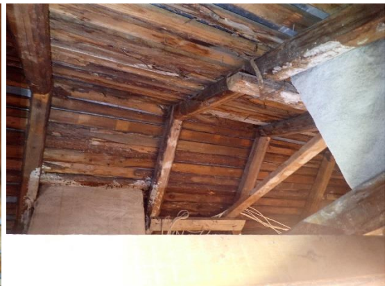
Kuvat 160 ja 161. Ullakkotilassa havaittiin useita vanhoja jo kuivuneita vesikaton vuodoista tai kondensoitumisesta aiheutuneita kosteusvaurioalueita.
