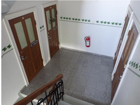
Kuva 107. Porrashuoneiden kohdalla olevat tasanteet ovat betonia. Porrashuoneessa on mosaiikkibetonilaatoitus.
