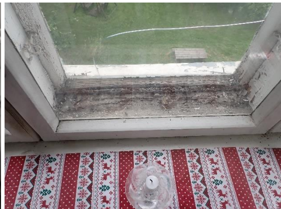
Kuvat 72 ja 73. Ikkunoiden karmien välisien sekä ikkunapokien välisien maalipinnat ovat yleisesti huonossa kunnossa.
