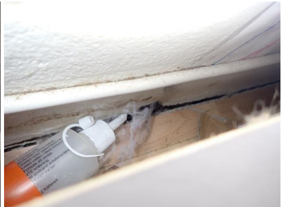
Kuvat 80 ja 81. Kantavan väliseinän ja välipohjarakenteen liittymä ei ole tiivis. Liittymässä havaittiin merkisavutarkastelussa ilmavirtausta sisätiloihin päin.
