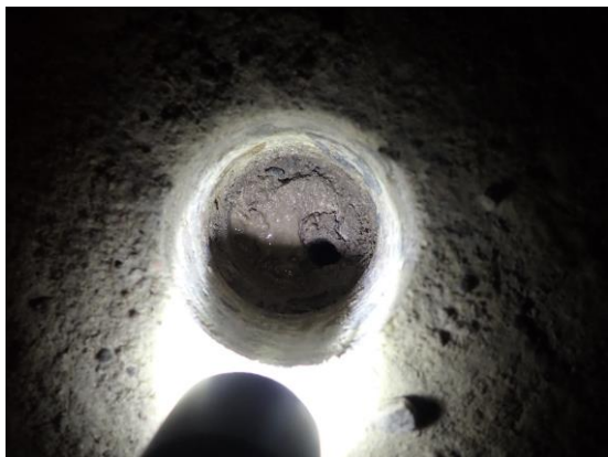
Kuvat 23 ja 24. Rakennearaus R2 AP. Betonilaatan paksuus 40–50 mm. Alapuolinen täyttö on hienorakeista vesimärkää hiekkaa.
