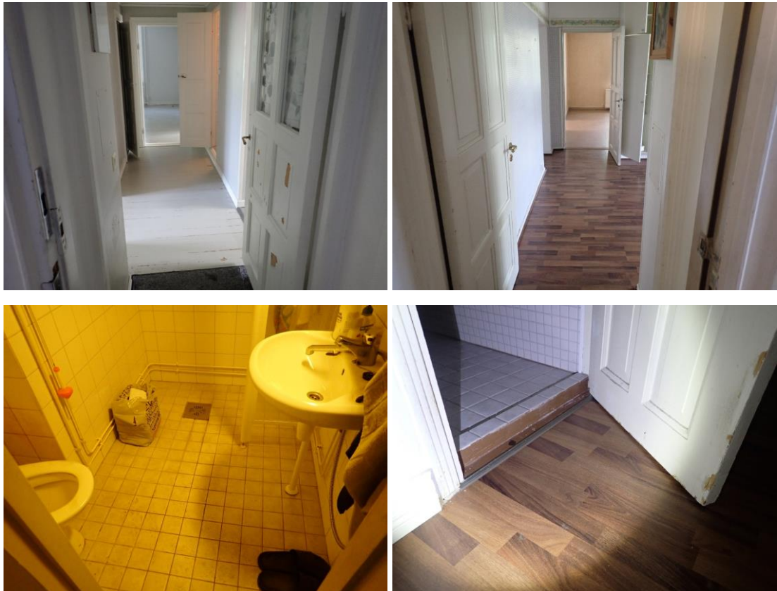
Kuvat 92, 93, 94 ja 95. Yleiskuvat lattiatpinnoista. Märkätiloissa on korotusvalu ja pinnat on laatoitettu.
