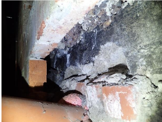
Kuvat 52 ja 53. Kellarikerroksen maanvastaiset seinät ovat ulkokuoreltaan betonia. Seinien sisäpuolella on paikoin tiiliset kuorimuuraukset.
