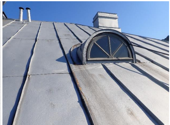
Kuvat 64 ja 65. Asuinkerrosten ikkunat ovat puurakenteisia MSU-tyypin sisään-ulos-aukeavia kaksipuitteisia ja kaksilasisia ikkunoita. Ullakon ikkunat ovat yksipuitteisia ja yksilasisia ikkunoita.
