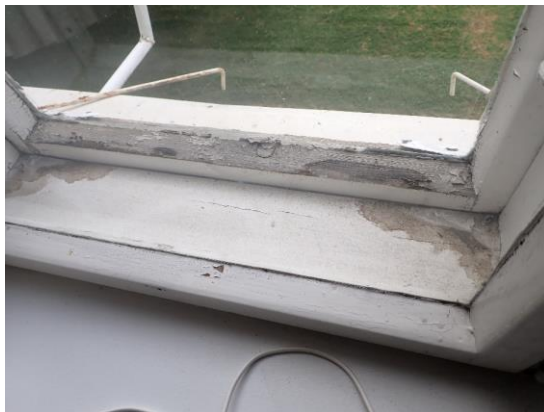
Kuvat 72 ja 73. Ikkunoiden karmien välisien sekä ikkunapokien välisien maalipinnat ovat yleisesti huonossa kunnossa.
