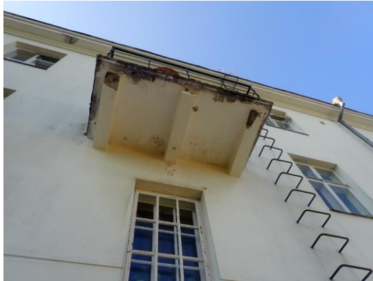
Kuvat 42 ja 43. Parvekkeen alapinnasta irrotettiin tutkimuksen yhteydessä heikosti kiinni olevat lohkeamat.
