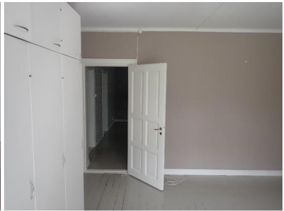
Kuvat 78 ja 79. Kantavat massiivitiiliväliseinät ovat noin 400 mm paksuja, paikoin on myös ei kantavia, ohuempia yhden tiilen väliseiniä. Väliseinät ovat pääosin maalattuja, paikoin tapetoituja.
