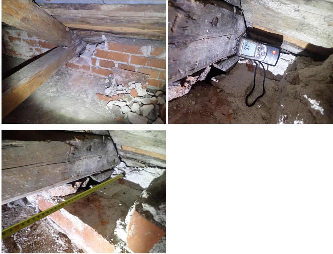
Kuvat 179, 180 ja 181. Rakenneavaus R4 US ullakolle tiiliulkoseinään kattokannattajan viereen asunnon 9 yläpuolelle. Puurakenteet tiiliseinän sisällä olivat kovia ja kuivia.
