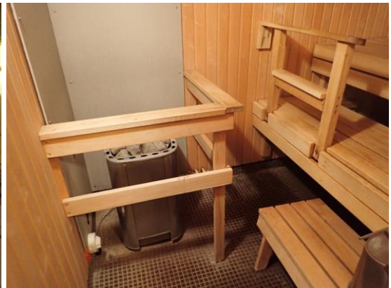
Kuvat 54 ja 55. Talopesulassa maanvastaisella seinällä on alaosassa keraaminen laatoitus, yläosassa rapattu maalipinta. Saunassa ja pukuhuoneessa on puukoolaus ja paneeliverhous.
