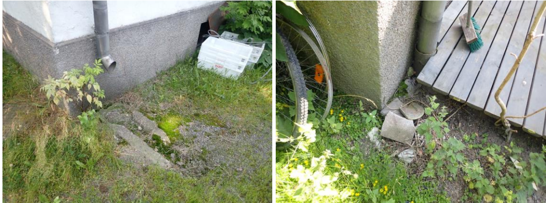
Kuvat 6 ja 7. Kattovedet johdetaan syöksytorvista rakennuksen vierustan betonikouruihin. Takapihan puolella yksi syöksytorvi on mahdollisesti liitetty sadevesikaivoon tai se on johdettu putkella kauemaksi rakennuksen läheisyydestä.
