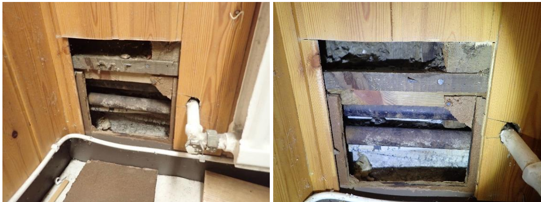
Kuvat 60 ja 61. Rakenneavaus R3 MVS tehtiin saunan pukuhuoneen maanvastaiseen seinärakenteeseen. Rakenneavauksesta otettiin näyte N4 (mineraalivilla) mikrobianalyysiin. Näytteessä ei esiintynyt mikrobikasvustoa.
