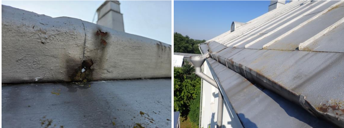
Kuvat 147 ja 148. Jalkarännien läheisyydessä on monin paikoin ruostevaurioita ja reikiä.
