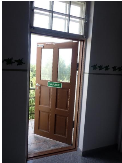
Kuva 71. Porrashuoneen parvekeovi on lasiaukollinen puuovi.
