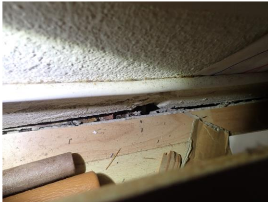
Kuvat 80 ja 81. Kantavan väliseinän ja välipohjarakenteen liittymä ei ole tiivis. Liittymässä havaittiin merkisavutarkastelussa ilmavirtausta sisätiloihin päin.
