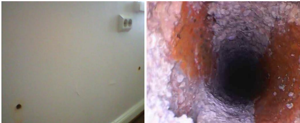
Kuvat 57 ja 58. Yleiskuvat ulkoseinärakenteisiin suoritetuista rakenneporauksista. Rakenneporauksista ei otettu materiaalinäytteitä.
