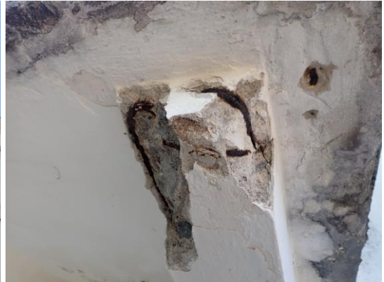
Kuvat 42 ja 43. Parvekkeen alapinnasta irrotettiin tutkimuksen yhteydessä heikosti kiinni olevat lohkeamat.
