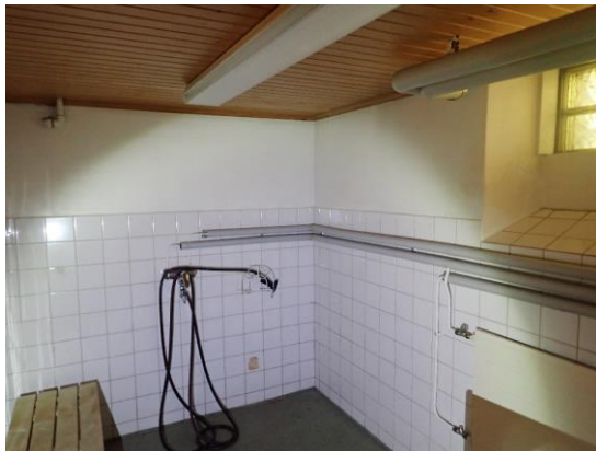
Kuvat 54 ja 55. Talopesulassa maanvastaisella seinällä on alaosassa keraaminen laatoitus, yläosassa rapattu maalipinta. Saunassa ja pukuhuoneessa on puukoolaus ja paneeliverhous.
