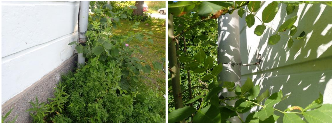
Kuvat 147 ja 148. Jalkarännien läheisyydessä on monin paikoin ruostevaurioita ja reikiä.
