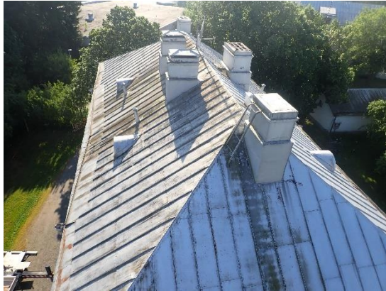
Kuva 153. Yleiskuva vesikaton hormeista, läpivienneistä yms.
