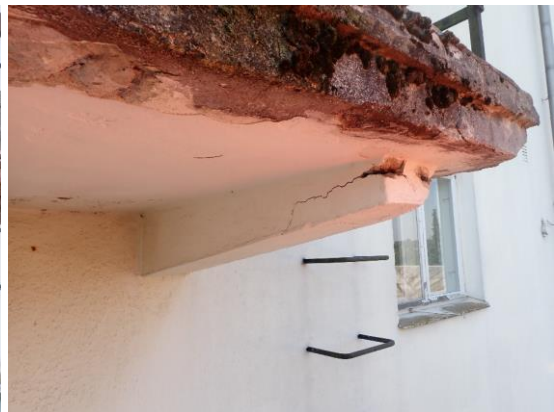
Kuvat 37, 38 ja 39. Räystäällä ja erityisesti räystään nurkissa todettiin pitkälle edenneitä vaurioita ja rappauspinnan lohkeamia. Tutkimuksen yhteydessä heikosti kiinni olevat lohkeamat irrotettiin.
