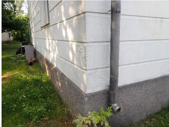
Kuvat 32 ja 33. Julkisivujen maalipinnan hilseilyä esiintyy paikallisesti syöksytorvien läheisyydessä sekä parvekkeen ja sadekatosten läheisyydessä.
