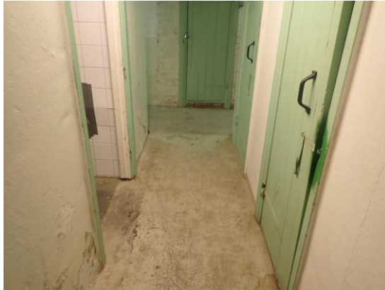
Kuvat 14 ja 15. Kellarissa lattiat pinnat ovat pääosin maalattua tai maalaamatonta betonipintaa. Saunan pukuhuoneessa on muovimatto.
