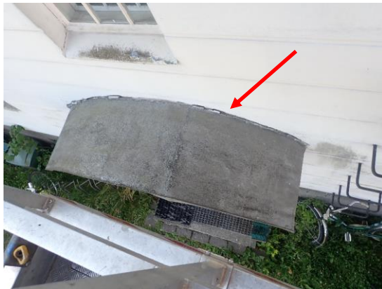
Kuvat 44 ja 45. Porrashuoneen sisäänkäynnin sadekatoksen kiinnitys on pettänyt ja katos on hieman repeytynyt irti julkisivun rappauksesta.
