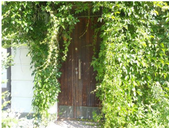
Kuvat 68, 69 ja 70. Porraskäytävän ulko-ovi ja huoneistojen porrashuoneen ovet ovat lasiaukollisia puuovia. Porrashuoneen ulko-ovi on levikkeellinen. Asunnon 3 kuistin ulko-ovi on levikkeellinen umpinainen puuovi.
