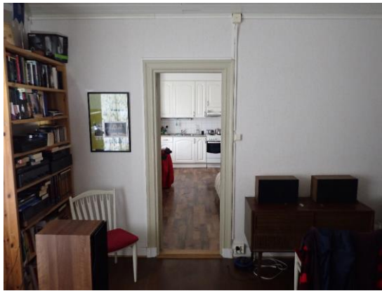
Kuvat 78 ja 79. Kantavat massiivitiiliväliseinät ovat noin 400 mm paksuja, paikoin on myös ei kantavia, ohuempia yhden tiilen väliseiniä. Väliseinät ovat pääosin maalattuja, paikoin tapetoituja.
