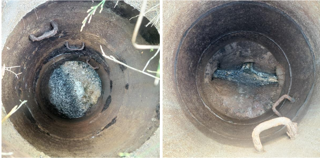
Kuva 9 ja 10. Koilliskulmalla lähempänä rakennusta oleva jätevesikaivo, jossa täyttöä ja koilliskulmalla kauempana rakennusta oleva jätevesien kokoojakaivo.
