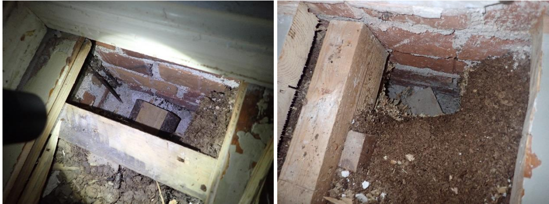
Kuvat 90 ja 91. Yleiskuvat välipohjarakenteen rakenneavauksesta (R10 VP ja R19 VP).
