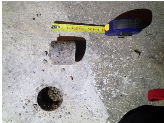
Kuvat 12 ja 13. Yleiskuva alapohjarakenteen rakenneavauksesta (R1 AP). Betonilaatan paksuus vaihtelee välillä 40–65 mm. Paikoin alapuolinen hienorakeinen hiekka on vesimärkää (R2 AP).
