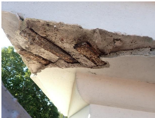
Kuvat 37, 38 ja 39. Räystäällä ja erityisesti räystään nurkissa todettiin pitkälle edenneitä vaurioita ja rappauspinnan lohkeamia. Tutkimuksen yhteydessä heikosti kiinni olevat lohkeamat irrotettiin.
