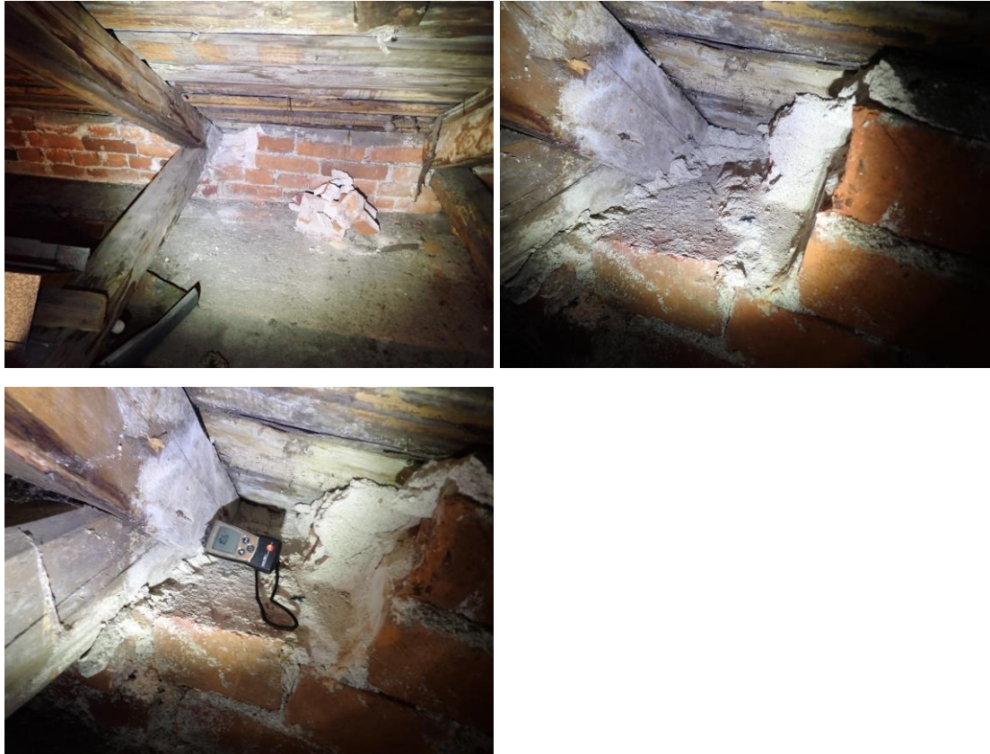
Kuvat 182, 183 ja 184. Rakenneavaus R8 US ullakolle tiiliulkoseinään kattokannattajan viereen asunnon 9 yläpuolelle. Puurakenteet tiiliseinän sisällä olivat kovia ja kuivia.
