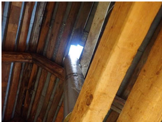
Kuva 159. Ullakkotila tuulettuu yhden harjatuuletusventtiilin kautta, joka on poistoilmanvaihtonputken läpiviennin yhteydessä.
