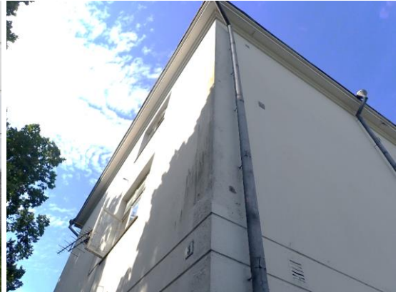
Kuvat 32 ja 33. Julkisivujen maalipinnan hilseilyä esiintyy paikallisesti syöksytorvien läheisyydessä sekä parvekkeen ja sadekatosten läheisyydessä.
