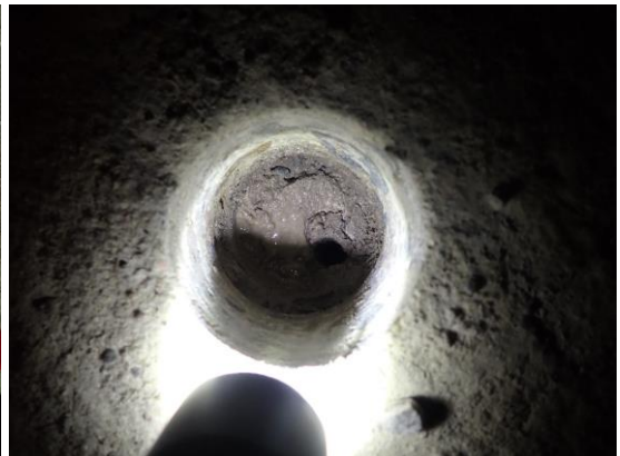
Kuvat 12 ja 13. Yleiskuva alapohjarakenteen rakenneavauksesta (R1 AP). Betonilaatan paksuus vaihtelee välillä 40–65 mm. Paikoin alapuolinen hienorakeinen hiekka on vesimärkää (R2 AP).
