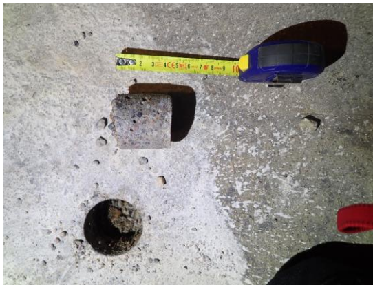
Kuvat 21 ja 22. Rakennearaus R1 AP. Betonilaatan paksuus 40–50 mm. Alapuolinen täyttö on hienorakeista vesimärkää hiekkaa.
