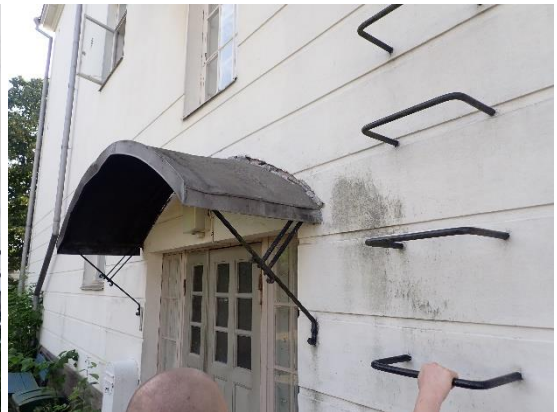
Kuvat 44 ja 45. Porrashuoneen sisäänkäynnin sadekatoksen kiinnitys on pettänyt ja katos on hieman repeytynyt irti julkisivun rappauksesta.
