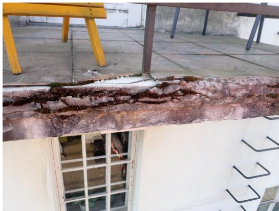
Kuvat 40 ja 41. Parvekelaatta on huonokuntoinen.
