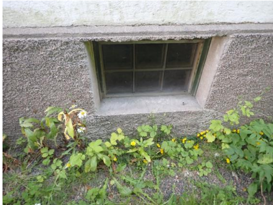
Kuvat 66 ja 67. Kellarin ikkunat ovat lasitillisiä.
