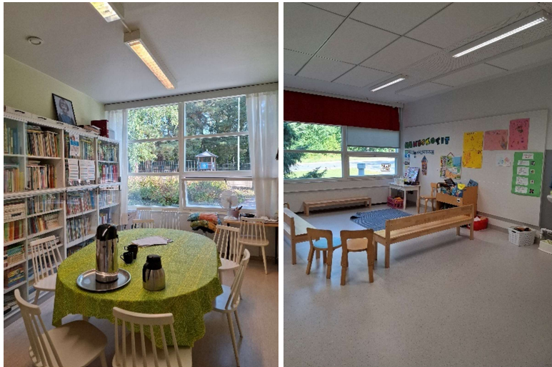
Kuva 10 ja 11. Henkilökunnan kahvihuoneen sisäkatto on kipsilevyä. Muskottien osastolla levytettyyn sisäkattoon on liimattu akustiikkalevyjä, joiden yhteydessä ei havaittu avoimia mineraalivuitupintoja.
