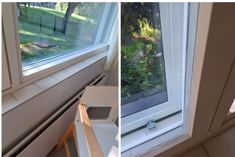
Kuva 8 ja 9. Rakennuksen kivirakenteisissa ulkoseinissä ei havaittu merkkejä kosteuden aiheuttamista vaurioista tai rakenneliittymien epätiiveydestä. Ikkunat ovat uusia ja hyväkuntoisia.
