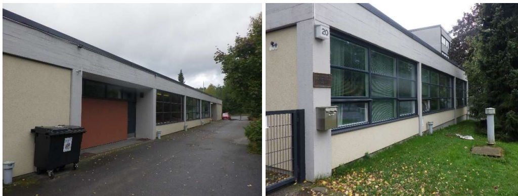
Kuva 2 ja 3. Rakennuksen vierustat ovat kulkuväylien alueella asfaltoituja ja päädyissä nurmialuetta. Pintavedet johdetaan pihan pintavesikaivoihin. Maanpinnanmuodot eivät ohjaa pintavesiä kauemmas rakennuksesta.
