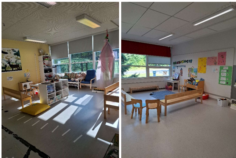
Kuva 6 ja 7. Huonetilojen lattiat on päällystetty muovimatoilla.
