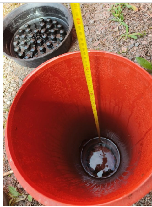
Kuva 10. Salaojat on uusittu.
