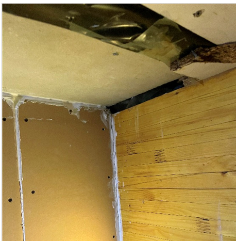
Kuva 20. Yläpohjan höyrynsulkumuoveissa näkyi epätiiviitä limityksiä ja repaleisia höyrynsulkumuoveja.
