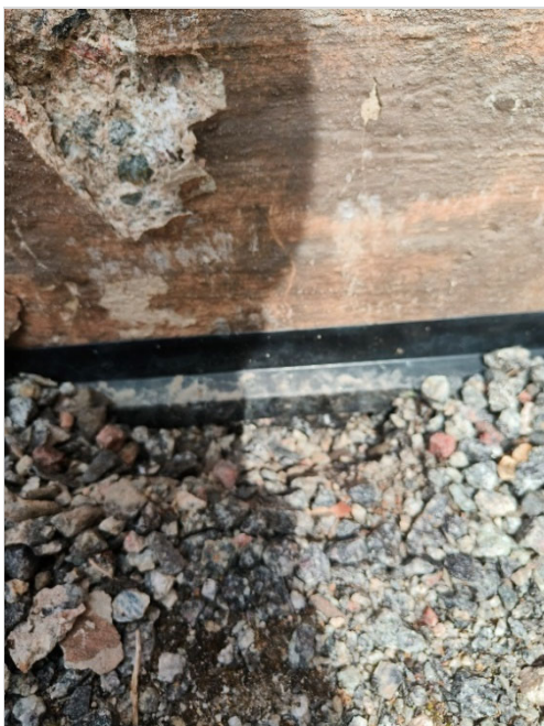
Kuva 9. Sokkelin ulkopintaan on asennettu patolevyt.
