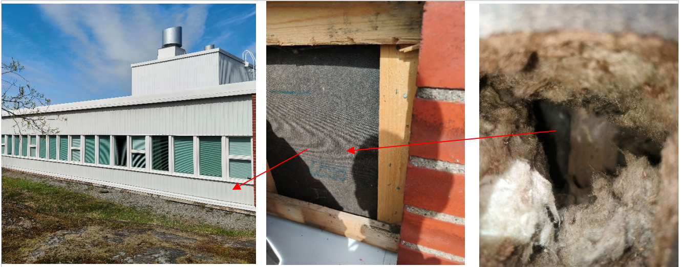
Kuva 6. Eteläseinustalla puurunkoisten seinien julkisivu on peltiverhoiltu (USV2), Laboratorion julkisivut ovat tiiliverhoillut (USV1).
