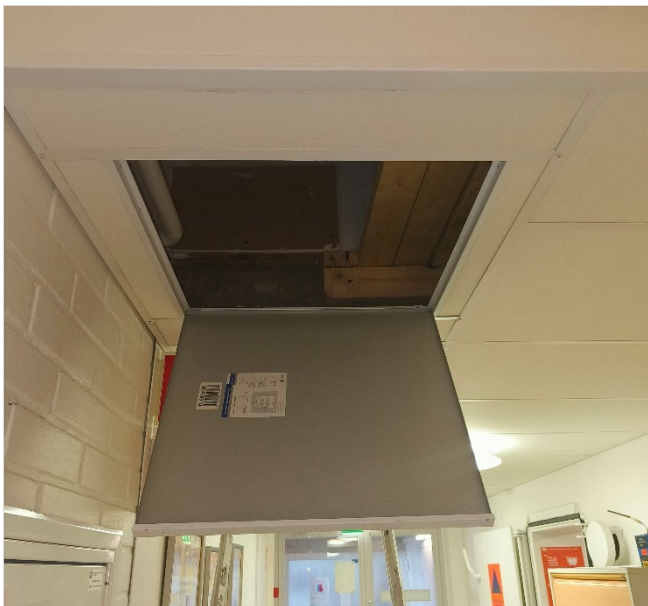
Kuva 14. G-osaa lähimpänä olevasta luukusta tuli selvää mikrobiperäistä hajua.
