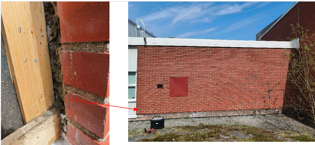
Kuva 8. Väestönsuojan betonirakenteinen ulkoseinä on tiiliverhoilu (USV4).
