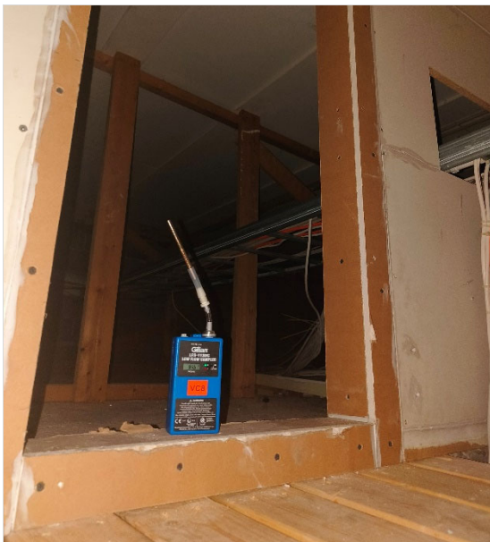
Kuva 27. Kloorianisolinäytteen keräyspaikka alakaton päällä käytävän kohdalla. Samasta luukusta on käynti VSS-tilan päälle.
