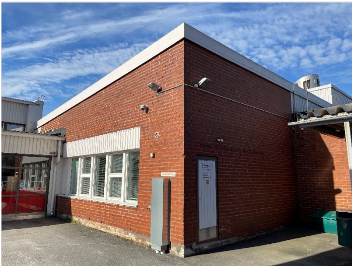
Kuva 7. Laboratorion julkisivut ovat tiiliverhoillut (USV1).
