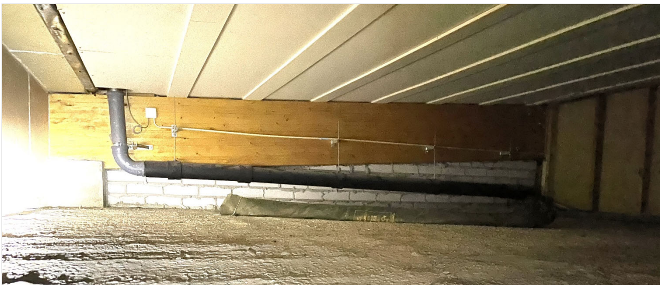
Kuva 16. Yleiskuva yläpohjasta VSS-tilan yläpuolella. Ulkoseinä on kuvan vasemmassa reunassa, käytävän vastainen väliseinä oikealla.
