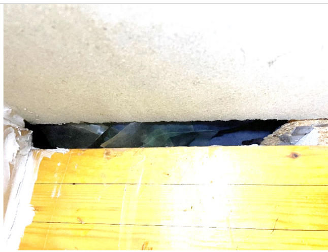
Kuva 20. Yläpohjan höyrynsulkumuoveissa näkyi epätiiviitä limityksiä ja repaleisia höyrynsulkumuoveja.
