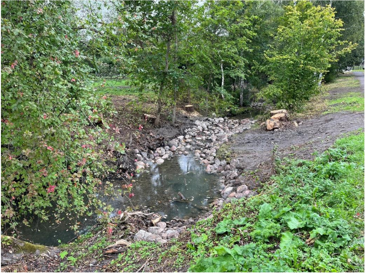
Kuva 2-4. Kovasojan Karjalaiskylän koealan yläpuolinen kunnostettu osuus 10.9.2024.
