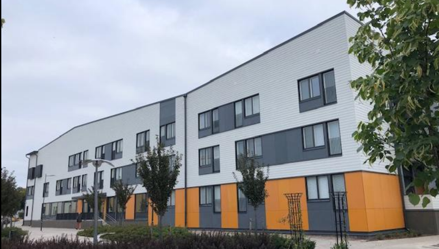
As Oy Turun Linnanherra, palveluasuntoja, Amiraalistonkatu 12 NCC Rakennus Oy ja Schauman Arkkitehdit Oy
