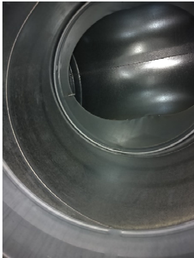
Kuva 6.1. Tuloilmakanavat ja päätelaitteet olivat aistinvaraisesti puhtaita.
