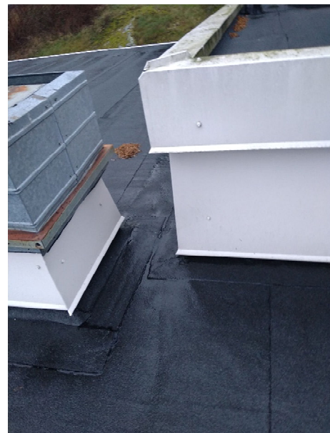
Kuva 5.18. Kattohuopa oli uusittu kauttaaltaan ja saumat sekä läpiviennit olivat hyväkuntoiset.
