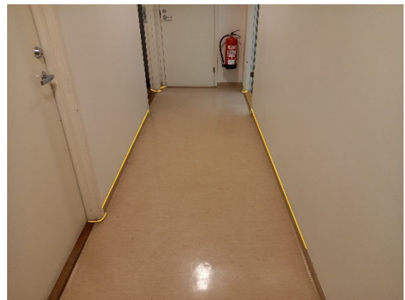
Kuva 5.12. Alapohjalaatan eristetilasta on merkittäviä ilmavuotoja sisäilmaan lattian ja seinän liittymästä ja vähäisiä ilmavuotoja käytävän väliseinien liittymistä.
