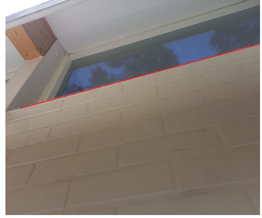
Kuva 5.11. Sokkelieristeestä on merkittäviä ilmavuotoja sisäilmaan lattian ja seinän liittymästä, hyllykiskojen kiinnikkeistä ja sähkökoteloista sekä yläikkunan liittymästä.
