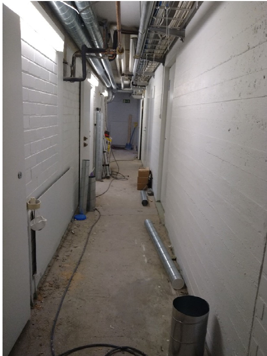
Kuva 5.8. Kellaritiloissa oli tutkimusten aikana menossa remontti eikä tiloissa ollut mm. lattiapäällysteitä.
