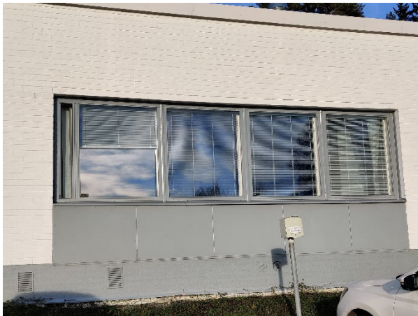
Kuva 5.13. Ulkoseinärakenne on pääosin tiili-villa-tiilirakenteinen. Etelä- ja pohjoissivuilla ikkunoiden alapuolella julkisivu on paikoin puurakenteinen.
