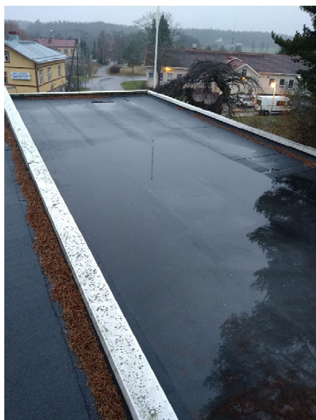
Kuva 5.19. Katokselle YP3 on lammikoitunut vettä puunlehtien aiheuttaman rännitukoksen vuoksi.
