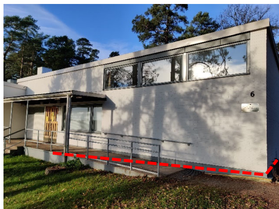
Kuva 5.9. Terveysaseman etelä- ja itäisivuilla ryömintätilan sokkelipalkit ovat kastuneet. Oikeanpuoleinen kuva on ryömintätilan puolelta.
