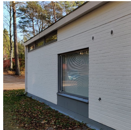
Kuva 5.13. Ulkoseinärakenne on pääosin tiili-villa-tiilirakenteinen. Etelä- ja pohjoissivuilla ikkunoiden alapuolella julkisivu on paikoin puurakenteinen.
