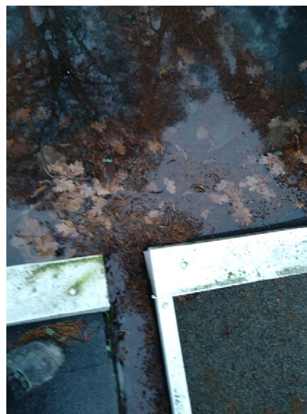
Kuva 5.19. Katokselle YP3 on lammikoitunut vettä puunlehtien aiheuttaman rännitukoksen vuoksi.
