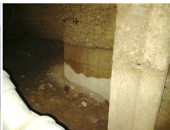
Kuva 5.9. Terveysaseman etelä- ja itäisivuilla ryömintätilan sokkelipalkit ovat kastuneet. Oikeanpuoleinen kuva on ryömintätilan puolelta.
