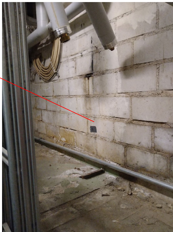
Kuva 5.5. Lämmönjakohuoneessa todettiin kosteuspoikkeamaa maanvastaisissa seinissä sekä lattiapinnoilla, seinien vierustoilla.
