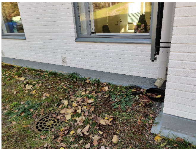
Kuva 5.3. Katon sadevedet on johdettu hallitusti sadevesiviemäriin. Ikkunat on uusittu ja vesipeltien kaadot ovat hyvät.
