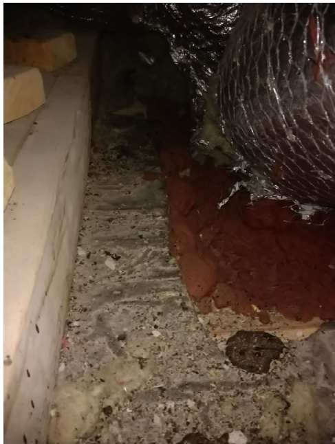
Kuva 5.20. Yläpohjan IV-läpivientien ympäriltä lämmöneristeet puuttuivat kokonaan. Ne on ilmeisesti kasattu yhteen läjään ullakkotilan nurkkaan.
