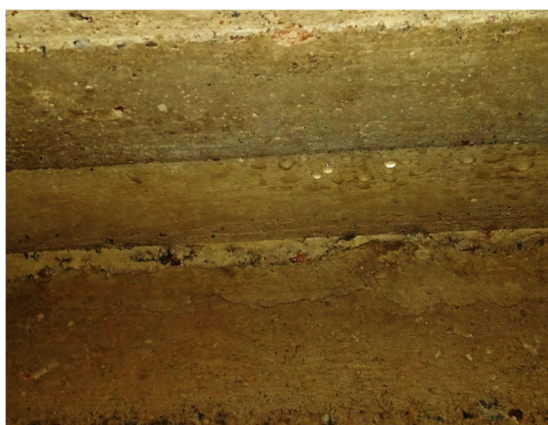
Kuva 5.10. Sokkelipalkin pinnalla on vesipisaroita. Sokkelieristeenä oleva tojalevy on märkää (R32). Tojalevyssä esiintyy mikrobikasvustoa ( M19 )
