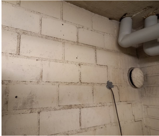
Kuva 5.14. Kellarin sisäpuolisessa kuorimuurauksessa on näkyviä halkeamia ja tiivistämättömiä läpivientejä, joista on merkittäviä ilmavuotoja kellaritiloihin.
