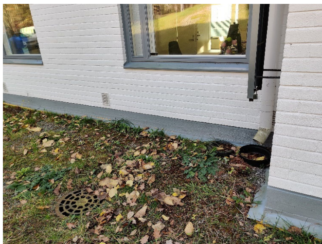
Kuva 3.4. Katon sadevedet on johdettu hallitusti sadevesiviemäriin. Ikkunat on uusittu ja vesipeltien kaadot ovat hyvät.
