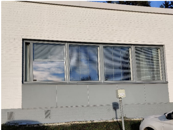
Kuva 4.3. Ulkoseinärakenne on pääosin tiili-villa-tiilirakenteinen. Etelä- ja pohjoissivuilla ikkunoiden alapuolella julkisivu on paikoin levyrakenteinen.
