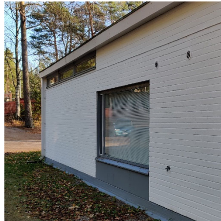
Kuva 4.3. Ulkoseinärakenne on pääosin tiili-villa-tiilirakenteinen. Etelä- ja pohjoissivuilla ikkunoiden alapuolella julkisivu on paikoin levyrakenteinen.
