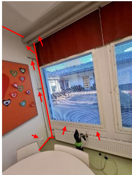
Kuvat 38 ja 39. Syöttöpisteen SP1 vuotokohdat merkittynä kuvaan punaisella viivalla (merkittävä vuoto) ja punaisella nuolella (pistemäinen vuoto).
