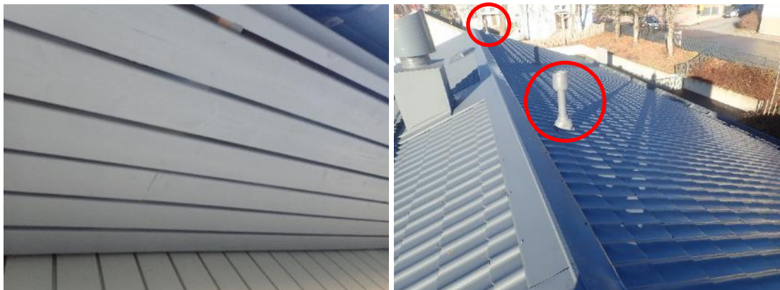
Kuva 135 ja 136. Yläpohjatila tuulettuu räystäältä ja lappeilla olevien alipainetuulettimien (ympyröity) kautta.
