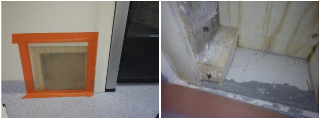
Kuva 119 ja 120. Rakenneavaus R18 tilassa 169. Väliseinä on korjattu rakenne kengittämällä. Rungon puuosissa tai alla olevassa betonissa ei havaittu viitteitä poikkeavasta kosteudesta.
