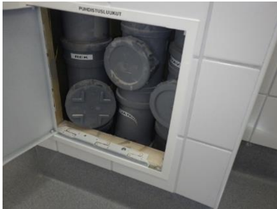
Kuva 123 ja 124. Viemärikoteloinnin avaus R1 wc-tilassa 127. Alapohjan valuun menevien viemäriputkien ympärillä havaittiin solumuovia.
