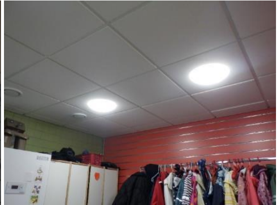
Kuva 147 ja 148. Osastojen märkätilojen alakatot ovat listoille asennettuja levykattoja.
