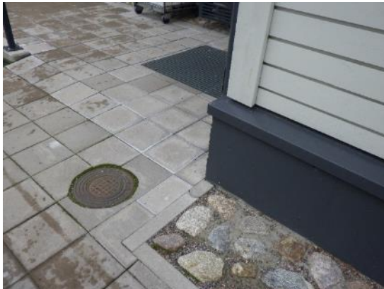
Kuvat 11 ja 12. Rakennuksen vierelle on asennettu kenttäkiveys. Sisäänkäyntien edustat ja kulkuväylät on laatoitettu betonilaatoitin.
