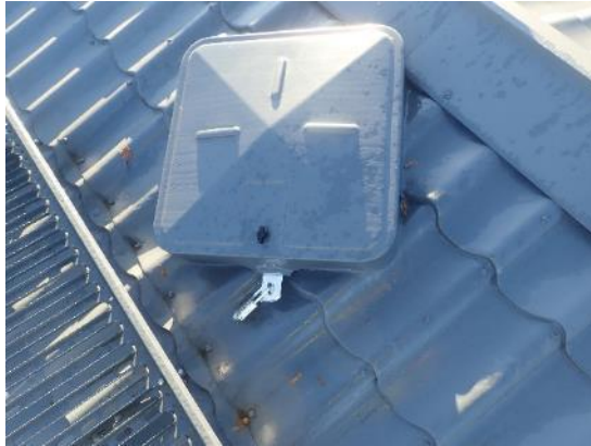
Kuva 137 ja 138. Kulku yläpohjatilaan tapahtuu lukittujen tarkastusluukkujen kautta. Luukuille johtaa kulkusillat.
