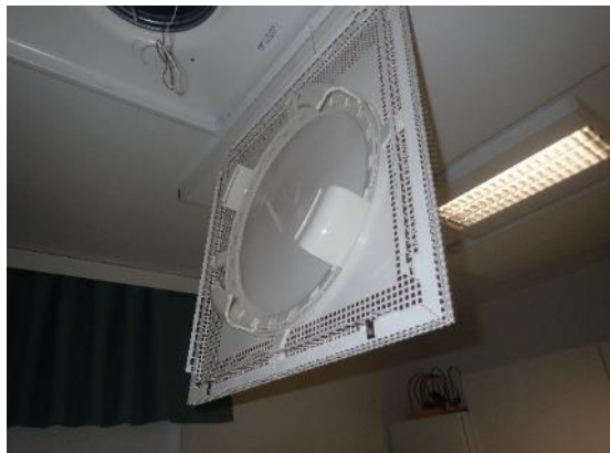
Kuvat 183 ja 184. RHOH-tuloilmahajoitin ja sen tasauslaatikko (ZAEF poistettu kuvauksen aikana).
