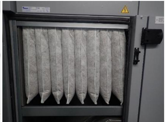
Kuvat 157 ja 158. Tuloilmassa on vesikiertoinen lämmityspatteri. Suodattimet ovat hienosuodattimia ja ne asettuvat tiiviisti kehyksiinsä.
