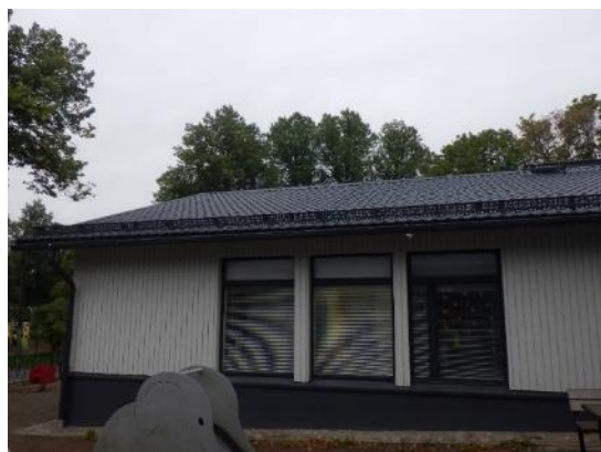
Kuvat 85 ja 86. Ulkoseinien alaosan valesokkelirakenne ulottuu pääosassa rakennusta ikkunoiden alareunan korkeudelle.
