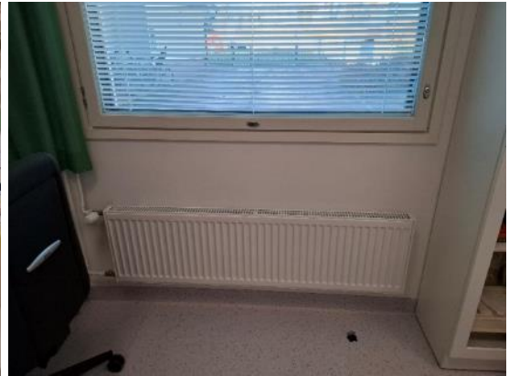
Kuvat 87 ja 88. Ulkoseinien sisäverhous on kuivissa huonetiloiissa maalattua kipsilevyä. Seinäpinnoilla ei havaittu kosteusjälkiä tai merkkejä kosteuden aiheuttamista vaurioista.
