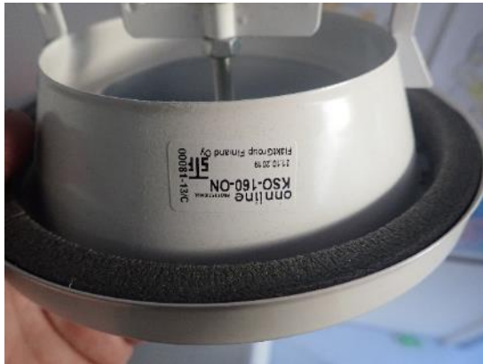
Kuvat 187 ja 188. Pyöreä kartioventtiili KSO160 ja Fläktin EHC-poistolaite.
