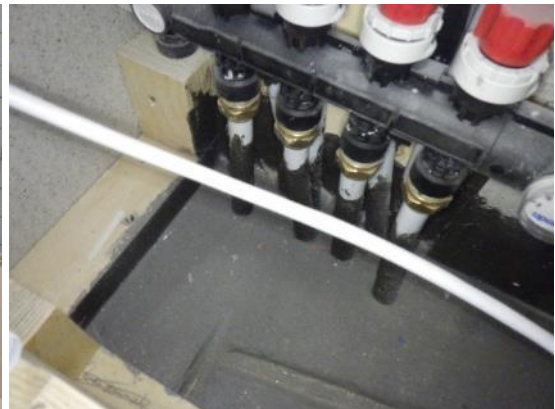
Kuva 125 ja 126. Koteloinnin avaus R5 wc-tilassa 159. Alapohjan läpiviennit on tiivistetty ilmatiivistykseen tarkoitetulla tuotteella.
