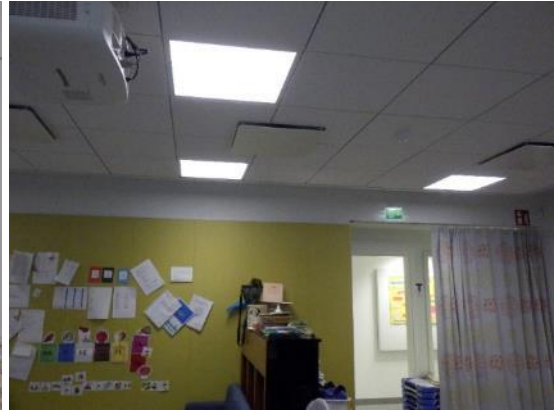
Kuva 109 ja 110. Kuivien tilojen seiniin on asennettu keraamista laatoitusta käsienvesualtaiden alueelle. Salin 155 seinälle on kiinnitetty vihreää ilmoitustauluna toimivaa akustiikkalevytystä.
