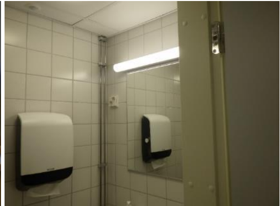
Kuva 149 ja 150. Käytävillä ja wc-tiloissa on listoille asennettu akustiikka-alakatto.
