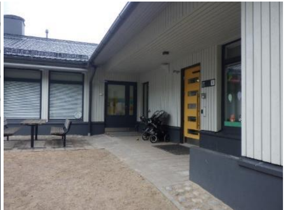
Kuvat 11 ja 12. Rakennuksen vierelle on asennettu kenttäkiveys. Sisäänkäyntien edustat ja kulkuväylät on laatoitettu betonilaatoitin.
