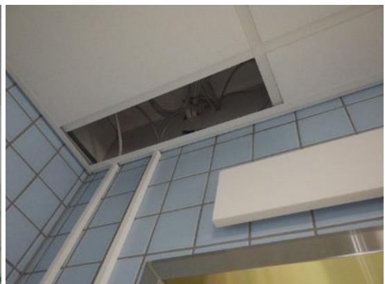
Kuva 151 ja 152. Avauskohdat R2 ja R21 tiloissa 148 ja 159. Alakaton sisällä ei havaittu yläpohjan läpivientejä.
