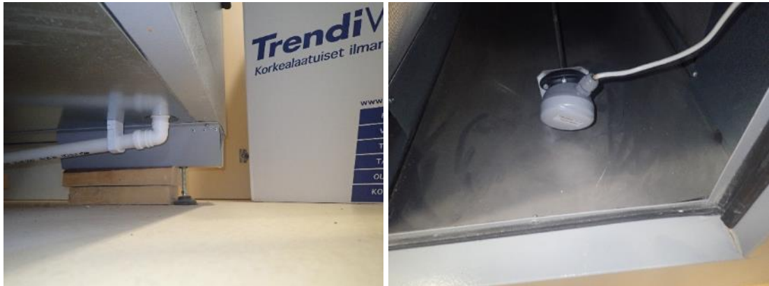
Kuvat 175 ja 176. Kondenssivedet on johdettu vesilukon kautta viemäriin. Pölykertymä koneen pinnoilla on melko pieni.
