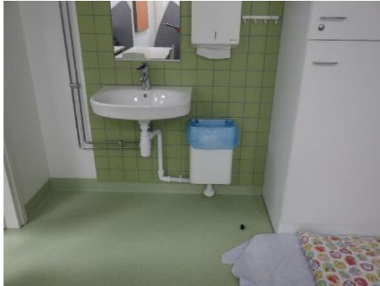
Kuva 109 ja 110. Kuivien tilojen seiniin on asennettu keraamista laatoitusta käsienvesualtaiden alueelle. Salin 155 seinälle on kiinnitetty vihreää ilmoitustauluna toimivaa akustiikkalevytystä.
