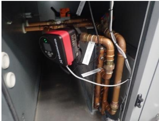
Kuvat 157 ja 158. Tuloilmassa on vesikiertoinen lämmityspatteri. Suodattimet ovat hienosuodattimia ja ne asettuvat tiiviisti kehyksiinsä.
