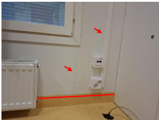
Kuva 69 ja 70. Syöttöpisteen SP2 vuotokohdat perhosten huoneessa 114 merkittynä kuvaan punaisella viivalla (merkittävä vuoto) ja punaisella nuolella (pistemäinen vuoto).
