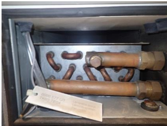
Kuvat 168 ja 169. Tuloilmassa on vesikiertoinen lämmityspatteri. Suodattimet ovat hienosuodattimia ja ne asettuvat tiiviisti kehyksiinsä.
