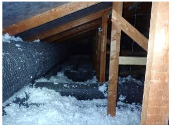
Kuva 139 ja 140. Aluskate oli teipattu kattoluukkuun kiinni. Alipainetuulettimien kohdalla oli aluskatteessa läpivientikappaleet.
