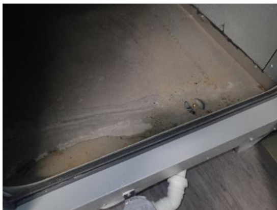
Kuvat 159 ja 160. Kondenssivedet on johdettu vesilukon kanssa viemäriin. Pölykertymä ilmanvaihtokoneen pinnoilla oli pieni.
