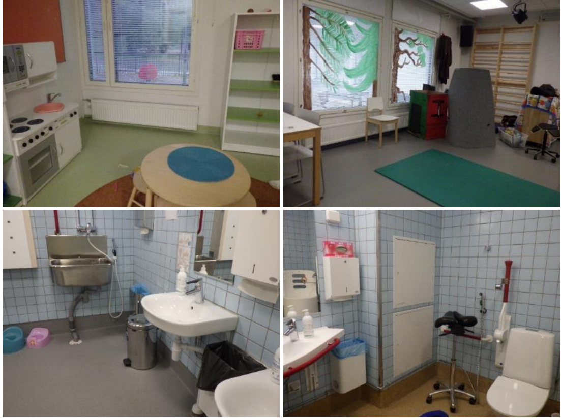
Kuvat 23, 24, 25 ja 26. Kuivissa tiloissa huonetilojen lattiat on päällystetty muovimatoilla. Kosteiden tilojen lattiat ovat akryylipinoitettua betonia. Lattiapäällysteiden reunat on nostettu viereiselle seinäpinnalle. Jumppasalissa on liimatut muovijalkalistat.
