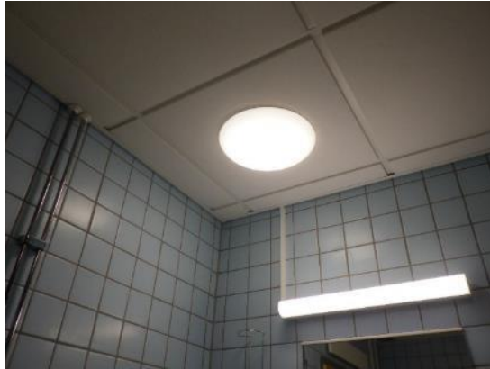
Kuva 147 ja 148. Osastojen märkätilojen alakatot ovat listoille asennettuja levykattoja.
