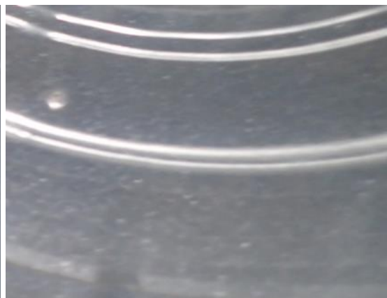
Kuvat 191 ja 192. Pölykertymä tuloilmakanavistossa oli pieni. Esimerkkikuvat Mansikoiden tiloista huoneesta 174 ja 166.
