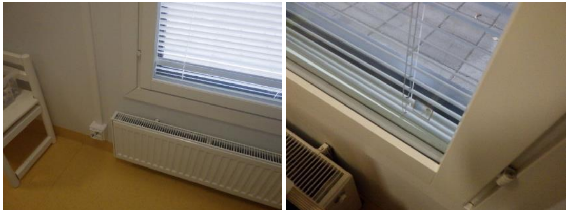
Kuvat 101 ja 102. Rakennuksessa puu-alumiini-ikkunat ovat hyväkuntoisia.
