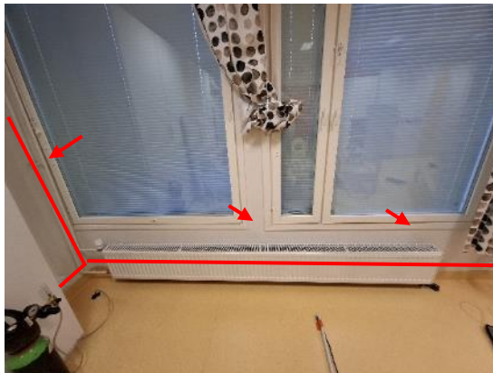
Kuva 67 ja 68. Syöttöpisteen SP1 vuotokohdat perhosten huoneessa 114 merkittynä kuvaan punaisella viivalla (merkittävä vuoto) ja punaisella nuolella (pistemäinen vuoto).
