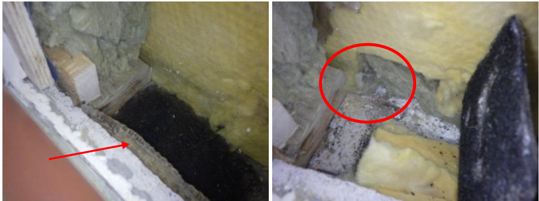
Kuva 93 ja 94. Rakenneavaus R7 tilassa 171. Ulkoseinän alaojhauspuu on selvästi lattiatason alapuolella. Uusitun tuulensuojalevyn alla havaittiin villakaista (ympyrä), jossa todettiin mikrobikasvua. Rungon reunalla havaittiin valukaistana toiminut laajasti tummunut aaltopahvi (nuoli).
