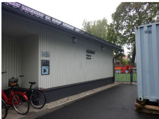
Kuvat 83 ja 84. Rakennuksessa on hyväkuntoinen laudoitettu julkisivu ja maalatut betonisokkelit. Sokkelin ja ulkoverhouksen väliin on asennettu tippapelti. Ikkunoiden vesipeltien kallistuksissa ja kiinnityksissä ei havaittu puutteita.
