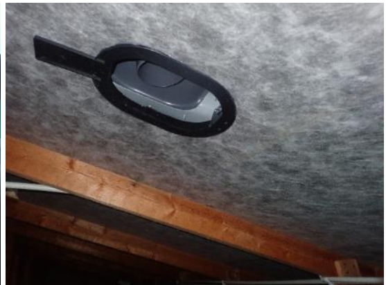
Kuva 139 ja 140. Aluskate oli teipattu kattoluukkuun kiinni. Alipainetuulettimien kohdalla oli aluskatteessa läpivientikappaleet.
