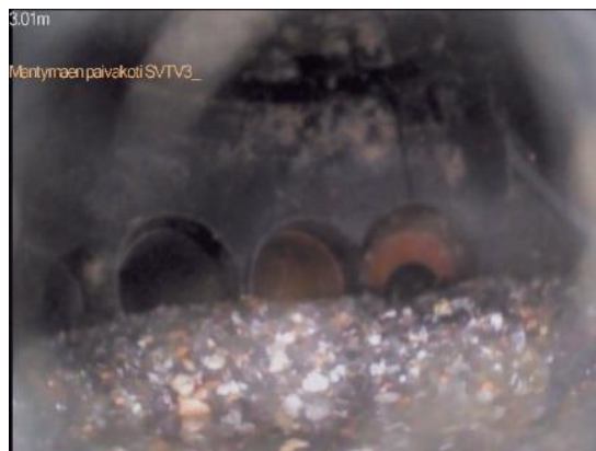
Kuvat 200 ja 201. Oikeanpuoleinen kuva sadevesien keräyskaivon pohjalla olevasta hiekkakertymästä. Vasemmanpuoleinen kuva leikkipihan sadevesien keräyskaivosta.
