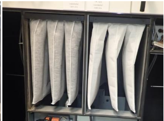
Kuvat 168 ja 169. Tuloilmassa on vesikiertoinen lämmityspatteri. Suodattimet ovat hienosuodattimia ja ne asettuvat tiiviisti kehyksiinsä.
