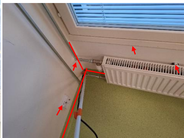
Kuvat 38 ja 39. Syöttöpisteen SP1 vuotokohdat merkittynä kuvaan punaisella viivalla (merkittävä vuoto) ja punaisella nuolella (pistemäinen vuoto).
