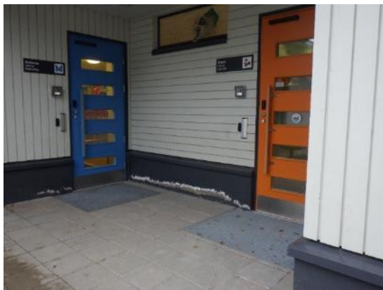
Kuvat 15, 16, 17 ja 18. Sokkeleiden alareunalla havaittiin kalkkihärmettä ja maalipinnan hilseilyä pääsisäänkäynnin, Mansikoiden, Oravien ja Perhosten sisäänkäyntien vierellä. Oravien osastolla sokkelin alareunassa havaittiin laajempaa maalipinnan hilseilyä.
