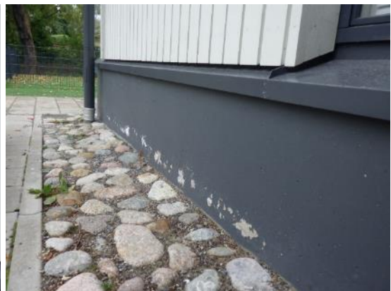
Kuvat 15, 16, 17 ja 18. Sokkeleiden alareunalla havaittiin kalkkihärmettä ja maalipinnan hilseilyä pääsisäänkäynnin, Mansikoiden, Oravien ja Perhosten sisäänkäyntien vierellä. Oravien osastolla sokkelin alareunassa havaittiin laajempaa maalipinnan hilseilyä.
