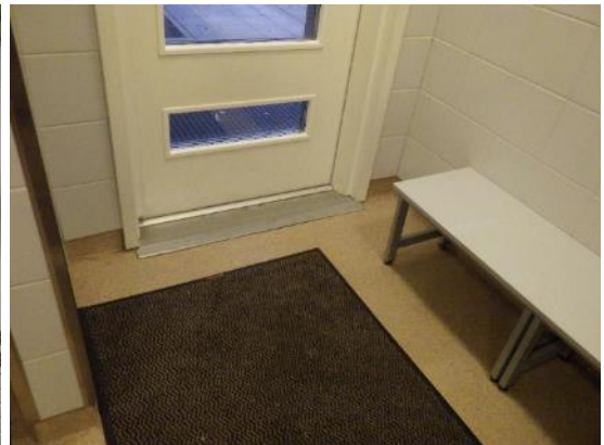
Kuvat 89 ja 90. Märkäeteisten alueella ulkoseinien sisäpinnat on laatoitettu keraamisin laatoin.
