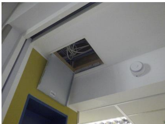
Kuva 151 ja 152. Avauskohdat R2 ja R21 tiloissa 148 ja 159. Alakaton sisällä ei havaittu yläpohjan läpivientejä.
