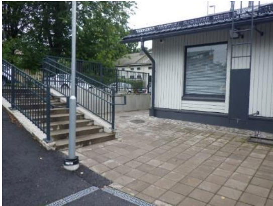
Kuvat 9 ja 10. Rakennuksen pinta- ja kattovedet ohjataan maanalaisiin sadevesijärjestelmiin.
