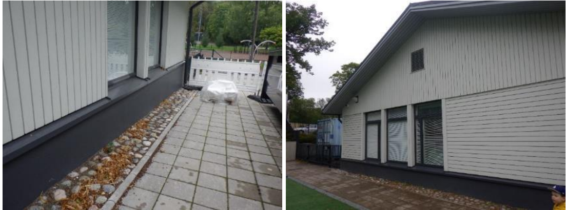
Kuvat 19 ja 20. Vierusmaan pinnanmuodot eivät ohjaa pintavesiä kohti rakennusta eikä rakennuksen vierustalla havaittu painanteita, joihin pintavedet pääsisivät kerääntymään.
