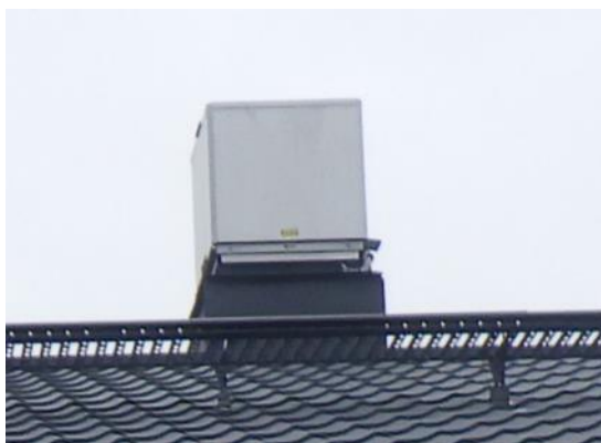
Kuva 182. Keittiön huippuimuri
