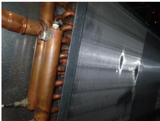
Kuvat 173 ja 174. Tuloilmassa on vesikiertoinen lämmityspatteri, jossa oli pari pientä kolhua. Suodattimet ovat hienosuodattimia ja ne asettuvat tiiviisti kehyksiinsä.
