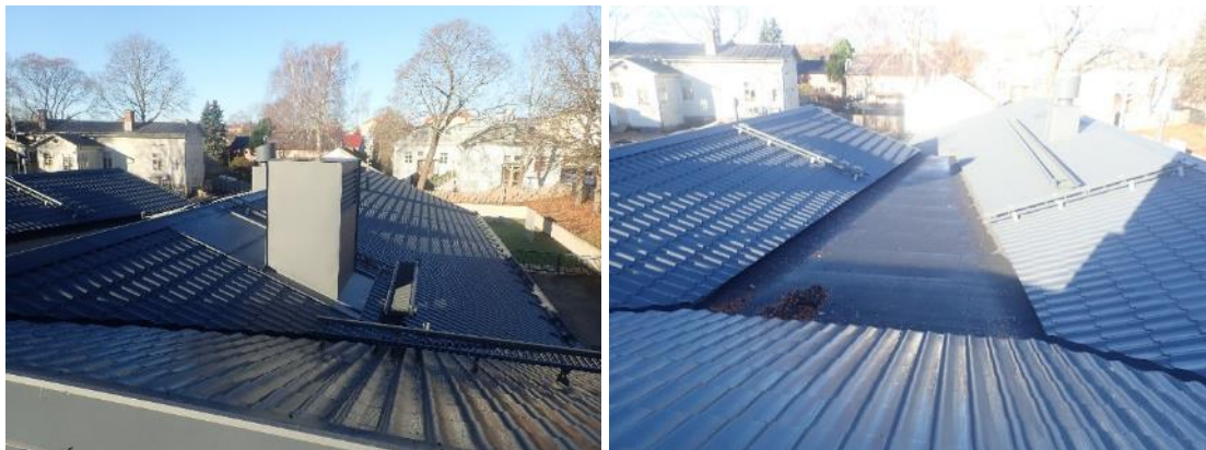
Kuva 131 ja 132. Vesikatto on hyväkuntoinen. Kate on pääasiassa profiilipeltiä, pieneltä osin kermipintaista.
