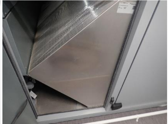
Kuvat 155 ja 156. Puhaltimet ovat suoravetopuhaltimia ja lämmöntalteenotto on toteutettu LTO-kuitiolla.
