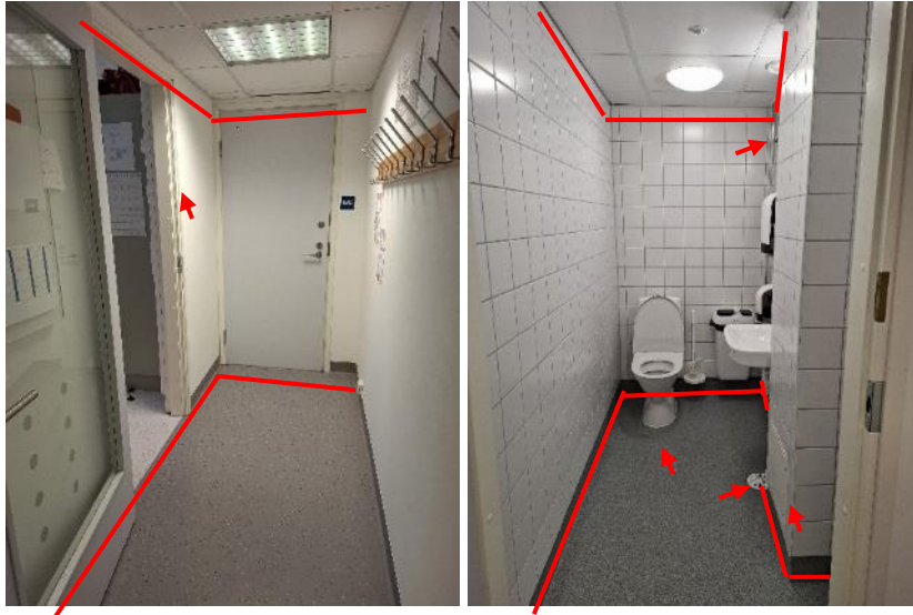
Kuvat 57 ja 58. Syöttöpisteen 4 vuotokohdat henkilökunnan taukutilassa 128 merkittynä kuvaan punaisella viivalla (merkittävä vuoto) ja punaisella nuolella (pistemäinen vuoto).
