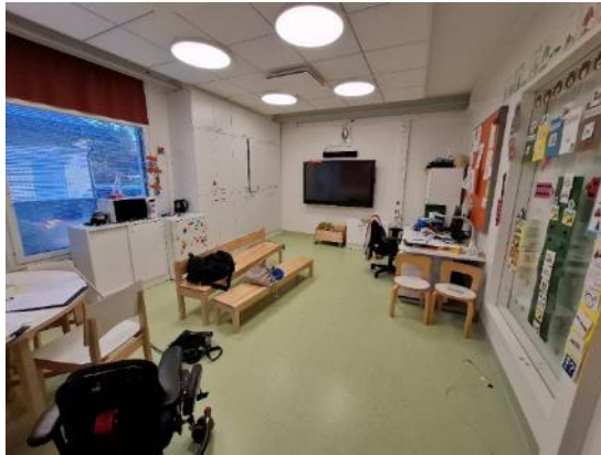
Kuvat 87 ja 88. Ulkoseinien sisäverhous on kuivissa huonetiloiissa maalattua kipsilevyä. Seinäpinnoilla ei havaittu kosteusjälkiä tai merkkejä kosteuden aiheuttamista vaurioista.
