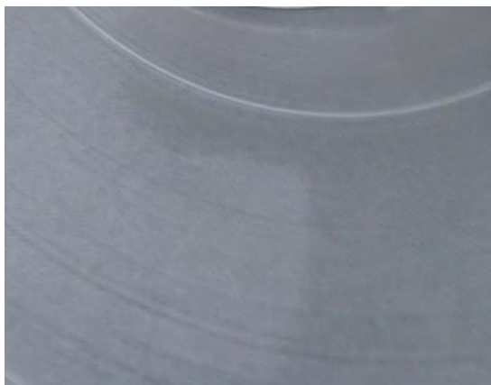
Kuvat 191 ja 192. Pölykertymä tuloilmakanavistossa oli pieni. Esimerkkikuvat Mansikoiden tiloista huoneesta 174 ja 166.
