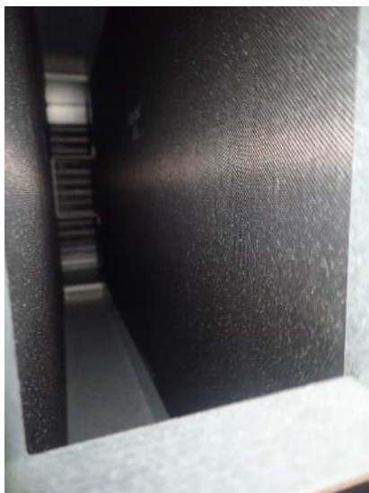
Kuva 181. Äänenvaimennusmateriaalit ovat pinnoitettuja.
