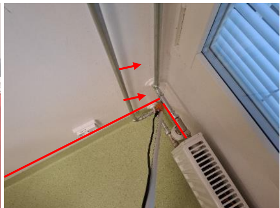
Kuvat 28 ja 29. Syöttöpisteiden SP1 vuotokohdat Mansikoiden pienryhmähuoneessa 171 ja sen vastaisessa tilassa 174 merkittynä kuvaan punaisella viivalla (merkittävä vuoto) ja punaisella nuolella (pistemäinen vuoto).
