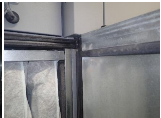
Kuvat 173 ja 174. Tuloilmassa on vesikiertoinen lämmityspatteri, jossa oli pari pientä kolhua. Suodattimet ovat hienosuodattimia ja ne asettuvat tiiviisti kehyksiinsä.
