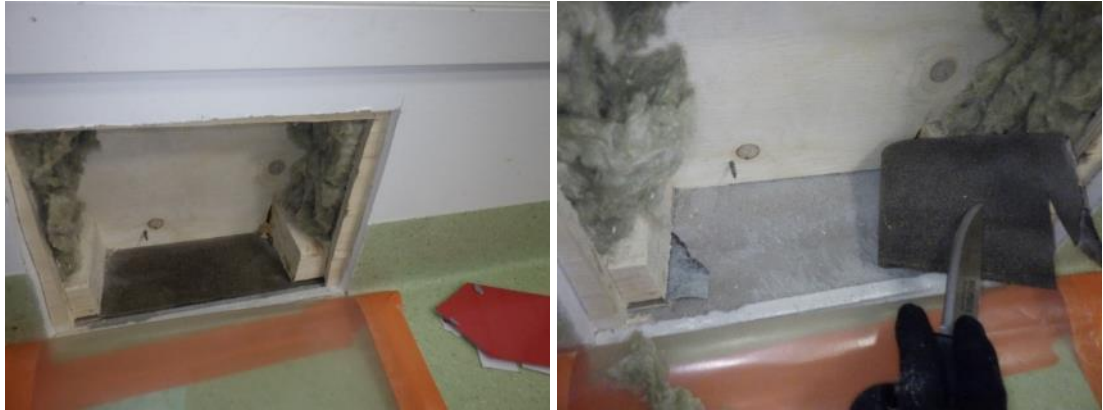
Kuva 121 ja 122. Rakenneavaus R19 tilassa 174. Väliseinä on korjattu rakenne kengittämällä. Rungon puuosissa tai alla olevassa betonissa ei havaittu viitteitä poikkeavasta kosteudesta.
