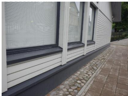
Kuvat 83 ja 84. Rakennuksessa on hyväkuntoinen laudoitettu julkisivu ja maalatut betonisokkelit. Sokkelin ja ulkoverhouksen väliin on asennettu tippapelti. Ikkunoiden vesipeltien kallistuksissa ja kiinnityksissä ei havaittu puutteita.
