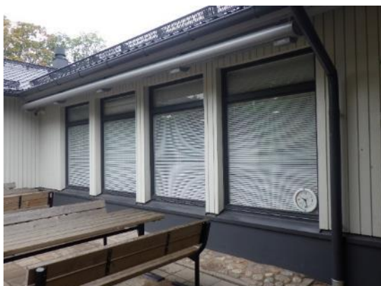
Kuvat 85 ja 86. Ulkoseinien alaosan valesokkelirakenne ulottuu pääosassa rakennusta ikkunoiden alareunan korkeudelle.
