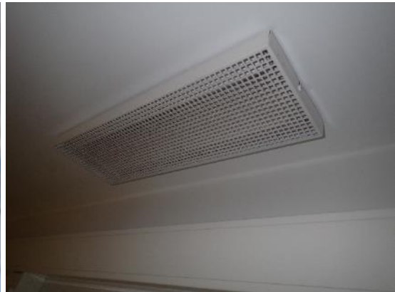
Kuvat 187 ja 188. Pyöreä kartioventtiili KSO160 ja Fläktin EHC-poistolaite.
