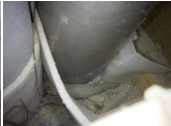
Kuva 123 ja 124. Viemärikoteloinnin avaus R1 wc-tilassa 127. Alapohjan valuun menevien viemäriputkien ympärillä havaittiin solumuovia.
