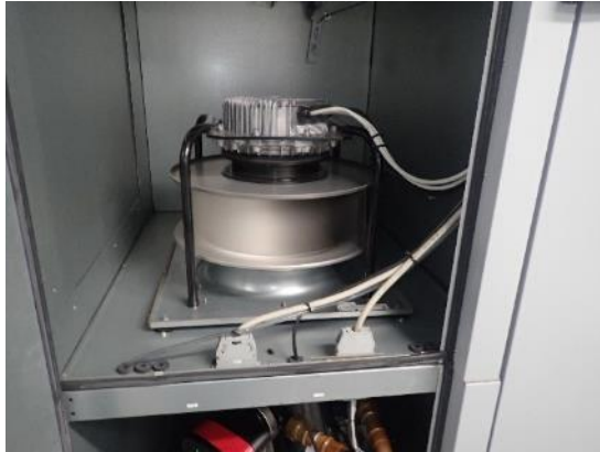
Kuvat 155 ja 156. Puhaltimet ovat suoravetopuhaltimia ja lämmöntalteenotto on toteutettu LTO-kuitiolla.
