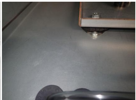
Kuvat 159 ja 160. Kondenssivedet on johdettu vesilukon kanssa viemäriin. Pölykertymä ilmanvaihtokoneen pinnoilla oli pieni.
