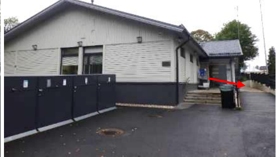
Kuvat 7 ja 8. Kallelankatu sijaitsee selvästi rakennusta korkeammalla. Katu on erotettu piha-alueesta tukimuurilla (nuoli). Keittiön kohdalla piha-alue on asfaltoitu.
