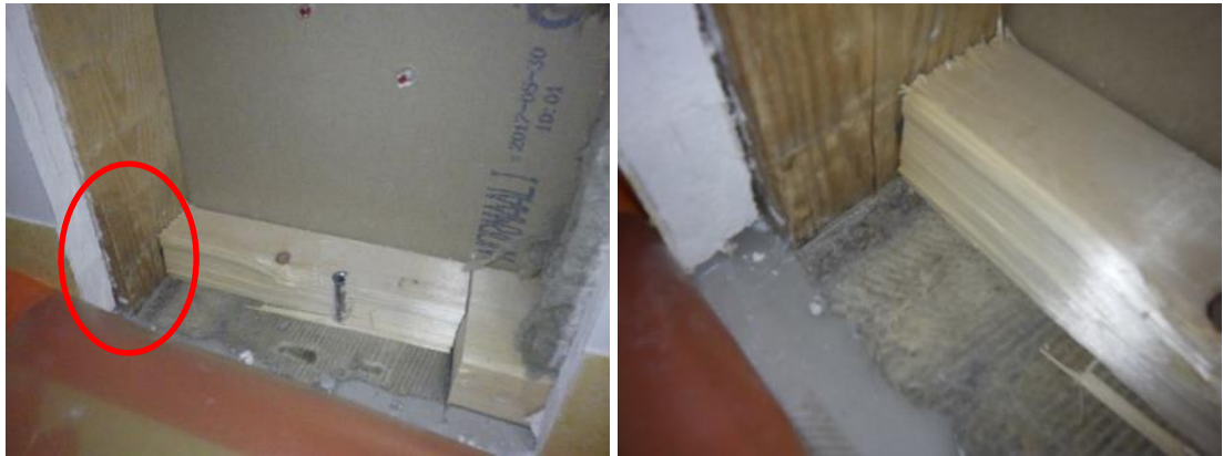
Kuva 112 ja 113. Rakenneavaus R10 tilassa 123. Väliseinän alaohjauspuu on uusittu. Vanhassa run- kotolpassa havaittiin paikallisia, vanhoja kosteusjälkiä (ympyrä). Rakenteissa ei havaittu viitteitä poik- keavasta kosteudesta tai mikrobikasvun aiheuttamista vaurioista.
