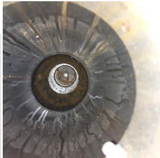
Kuvat 200 ja 201. Oikeanpuoleinen kuva sadevesien keräyskaivon pohjalla olevasta hiekkakertymästä. Vasemmanpuoleinen kuva leikkipihan sadevesien keräyskaivosta.
