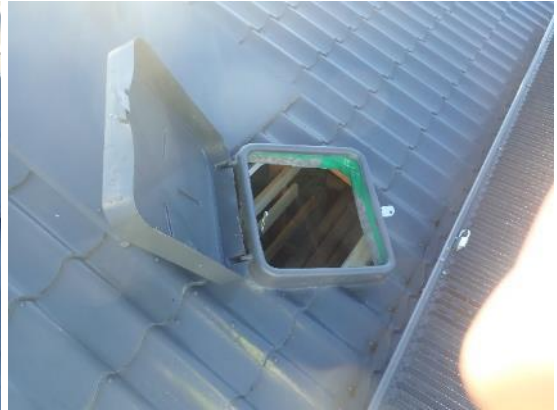
Kuva 137 ja 138. Kulku yläpohjatilaan tapahtuu lukittujen tarkastusluukkujen kautta. Luukuille johtaa kulkusillat.
