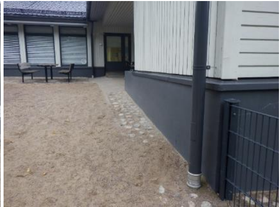
Kuvat 9 ja 10. Rakennuksen pinta- ja kattovedet ohjataan maanalaisiin sadevesijärjestelmiin.
