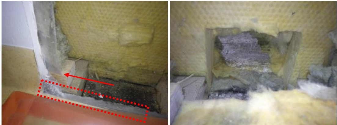
Kuva 99 ja 100. Rakenneavaus R11 tilassa 115. Ulkoseinän alaohjauspuun yläpinta on lattiatasolla. Rakenteen höyrynsulku katkeaa ennen lattiatasoa (nuoli). Puurungon ja lattiavalun välistä rakoa on tiivistetty elastisella massalla ja laastilla (katkoviiva). Valesokkelirakenteen sisäpinta on pintakosteus-tarkastelun mukaan märkä ja betonipinnassa havaittiin kosteuden aiheuttamaa kalkkihärmettä.
