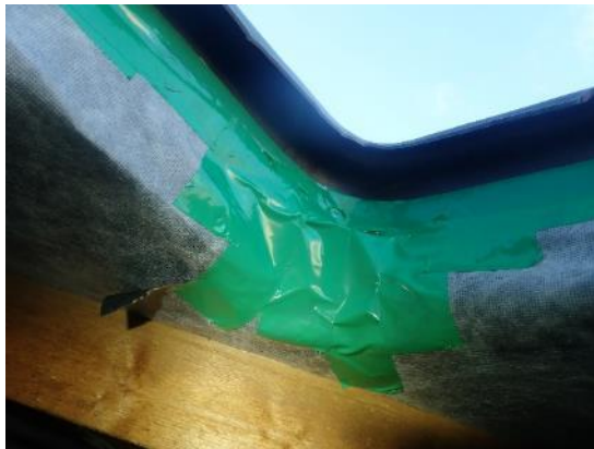
Kuva 139 ja 140. Aluskate oli teipattu kattoluukkuun kiinni. Alipainetuulettimien kohdalla oli aluskatteessa läpivientikappaleet.
