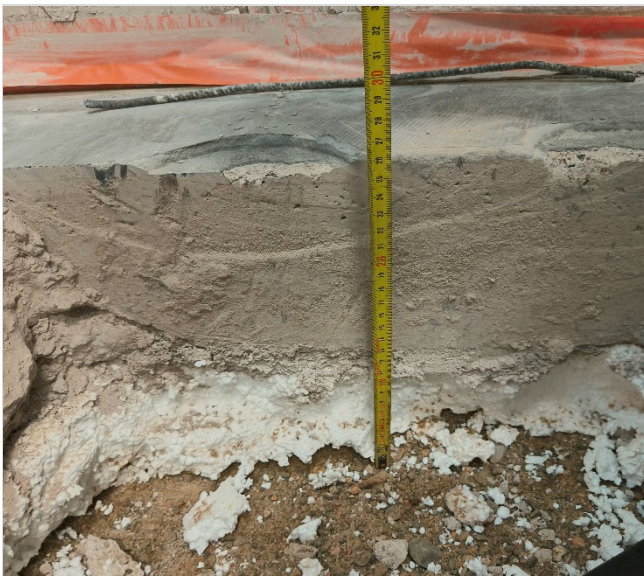
Kuva 4. Alapohjan toteutus vastaa pääosin alkuperäisiä rakennesuunnitelmia. Pohjalaatta on suunniteltua paksumpi.
