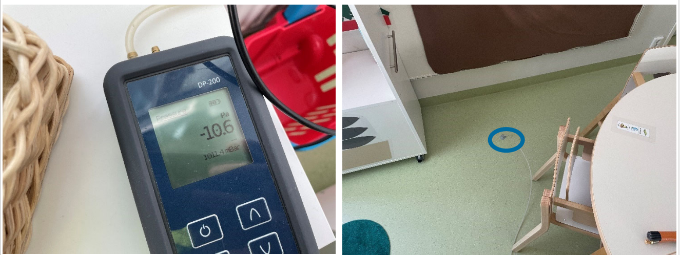
Kuva 8. Tila 102 alipaineistettiin ennen rakenneavauksia -10 Pa (vasen kuva) ja merkkiaine syötettiin alapohjatilaa huoneen 102 lattian läpi (oikea kuva).
