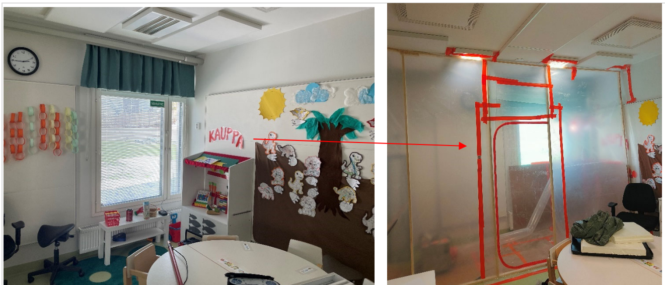
Kuva 3. Tilan 102 ulkoseinän vierusta osastoititiin rakenneavauksen ajaksi.
