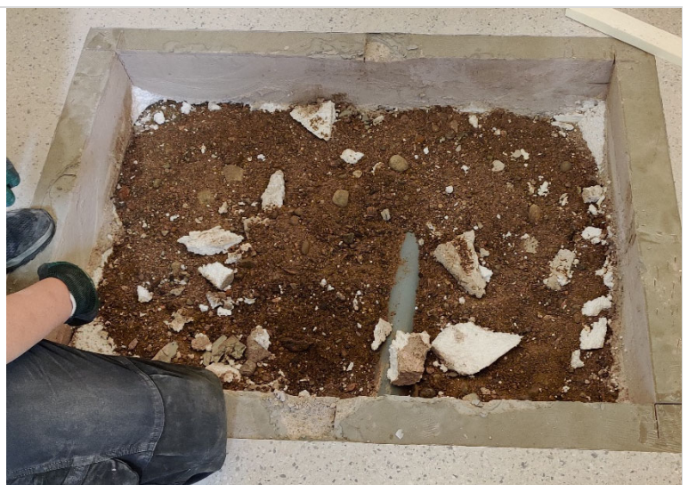
Kuva 8. Varastossa 145 alapohjaan oli tehty n. 0,5 m 2 avaus, josta tar- kasteltiin alapohjan ja anturalinjan toteutusta.
