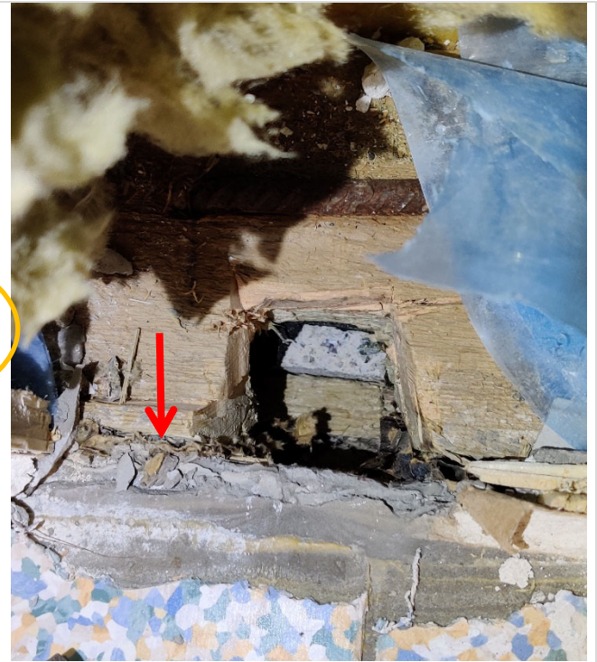
Kuva 11. Tilassa 140 (RA3) ulkoseinälinjalla alaohjauspuu on lattiatason alapuolella. Toinen puu näkyy lisäksi alempana. Sokkelin irrotuskaista oli bitumia, josta on mikrobimateriaalinäyte M-9 . Alapohjalaatan ja ulkoseinän valunerotuspahvista (nuoli) otettiin materiaalinäyte ( M-7 ).
