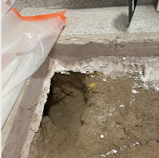
Kuva 4. Alapohjan rakenneavaus tilassa 140. Kantavan teräsbetonilaatan 100 mm alla on eps-eriste 100 mm ja täytönä hiekka.
