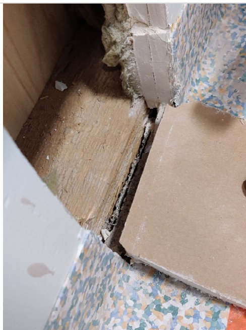
Kuva 13. Väliseinän alaojhauspuiden on suurimmaksi osin lattian pinnan alapuolella, kuten ulkoseinälinjalla avauksessa RA3.
