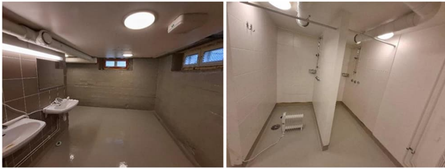
Kuvat 39 ja 40. Kellarikerroksen sosiaalitilojen ja varastojen alueella lattiat on pinnoitettu Kiilto Block tuotteella.
