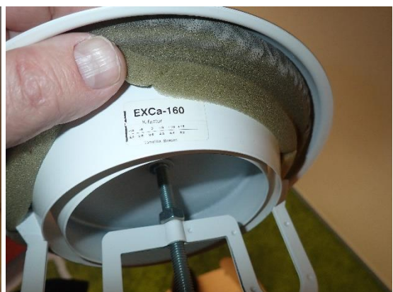
Kuvat 365 ja 366. Yleiskuvat poistoilmaventtiilistä. Tarkasteluiden perusteella venttiilit olivat hyväkuntoisia ja lähes puhtaita.
