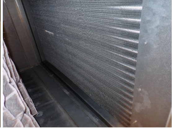
Kuvat 333 ja 334. Yleiskuvat suodatin osan pohjalta ja lto-patterista suodatinosan puolelta. Suodatin osan pohjalla havaittiin vahoja vuotojälkiä ja lto-patterin pinnalla hieman pölyyntymistä.
