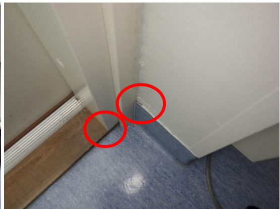
Kuvat 150 ja 151. Merkkiainekoe MA25 iltapäiväkerhon huonetilassa 138. Välipohjan eristetilaan syötettyä merkkiainetta kulkeutuu huoneeseen ovikynnyksen reunoilta sekä ulkoseinäliittymästä, maton noston reunalta. Syöttöpiste on merkattu kuvaan punaisella nuolella ja kynnysalueen merkittävät epätiiveyskohdat punaisilla ympyröillä.
