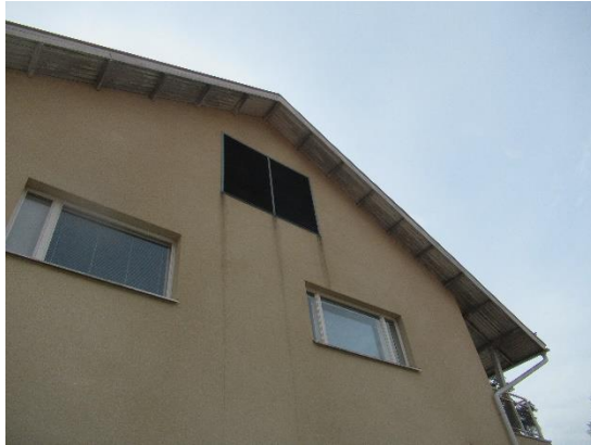
Kuvat 361 ja 362. Yleiskuvat ilmanvaihtokoneiden ulkoilmanotoista, ulkoilmalaitteet ovat tavanomaisia harvalamellisia ulkoilmasäleikköjä.
