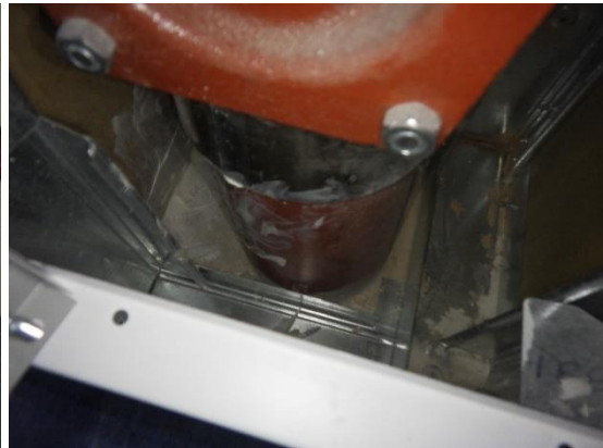
Kuvat 134 ja 135. Opettajanhuoneen 101 keittiötilassa 104 olevasta levykoteloitinnasta virtaa ilmaa tilojen normaalissa ilmanvaihdoissa kellarikerroksen suunnasta huonetiloihin.
