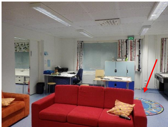
Kuvat 150 ja 151. Merkkiainekoe MA25 iltapäiväkerhon huonetilassa 138. Välipohjan eristetilaan syötettyä merkkiainetta kulkeutuu huoneeseen ovikynnyksen reunoilta sekä ulkoseinäliittymästä, maton noston reunalta. Syöttöpiste on merkattu kuvaan punaisella nuolella ja kynnysalueen merkittävät epätiiveyskohdat punaisilla ympyröillä.
