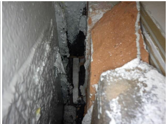
Kuvat 174 ja 175. Saneerauksen yhteydessä kellarin keveät tiiliväliseinät on avattu ulkoseinien vierustoilta. Väliseinäilytysten kohdalla havaittiin jäämiä ulkoseinien sisäpinnoilla olleesta PAH-yhdisteistä vedeneristeestä. Tiloissa havaittiin PAH-yhdisteisiin viittaavaa hajua.
