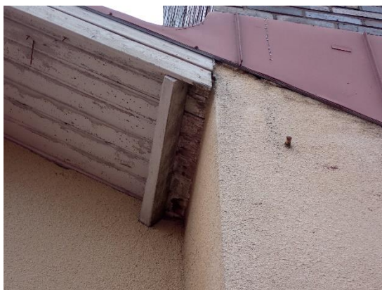
Kuvat 289 ja 290. Korkean osan räystäään aluslaudoituksien maalipinnat ovat kuluneita ja homekasvuston pilkuttamia. Pitkällä sivulla laudoituksen ulkoreunassa tuuletusta varten aukot.
