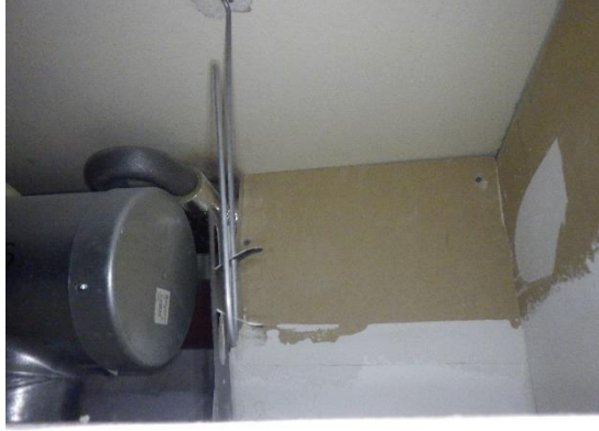
Kuvat 313 ja 314. Alakattoavaukset AK10 ja AK9 luokassa 210. Ulkoseinän lisäeristekerrosta ei ole tiivistetty yläpohjaan ja liittymässä olevasta raosta tapahtuu ilmavirtauksia rakenteen ja alakaton välillä.
