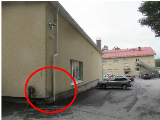
Kuvat 170 ja 171. Rakennuksen pohjoispuolella, ruokasalin kohdalla, ja eteläpuolella luokan 122 kohdalla ulkoseinien alaosien rappauspinnoissa havaittiin kosteuden aiheuttamaksi arvioitua tummentumaa.
