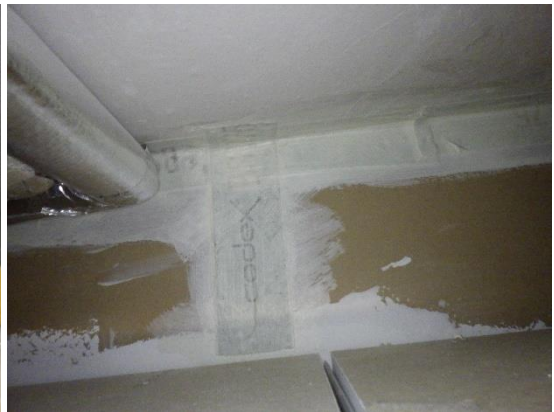
Kuvat 315 ja 316. Alakattoavaus AK16 askarteluvälinevarastossa 117. Avauksen kohdalla yläpohjan liittymä ja läpiviennit ovat tiiviitä.
