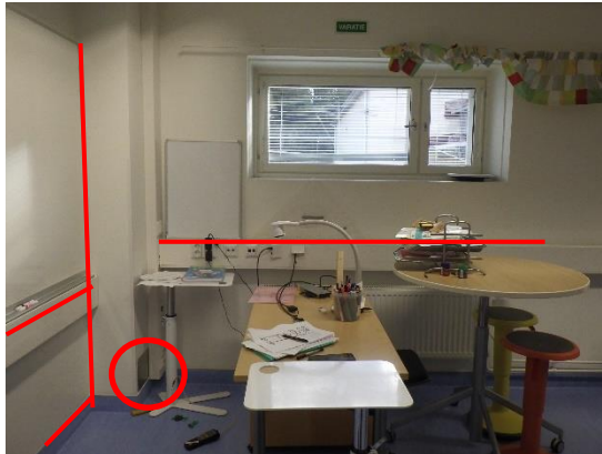
Kuvat 144 ja 145. Merkkiainekokeet MA16 ja MA18 luokassa 109. Kellaritilaan syötettyä merkkiainetta kulkeutuu huoneeseen nurkassa olevasta levykoteloinnin reunoilta ja sisältä sekä ulko- ja väliseinillä olevista sähkölistoista. Eristetilaan syötetty merkkiaine virtaa huonetilaan lattialiittymistä, matonkäänteiden reunoilta sekä ovikynnyksen reunoilta.
