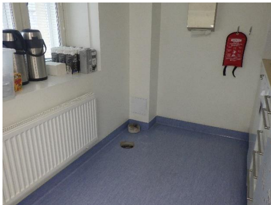
Kuvat 152 ja 153. Rakenneavaus R22 opettajanhuoneen keittiötilassa 104. Koksinkuonalla eristetyin välipohjan sisällä havaittiin vanhoja lämpöjohtoja, joiden suojakuoret ovat todennäköisesti asbestipitoisia. Eristetilasta virtaa ilmaa huonetilan suuntaan huonetilan normaalilla ilmanvaihdoilla.
