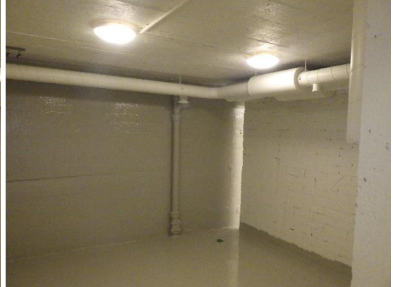
Kuvat 172 ja 173. A-osan kellarikerroksen sosiaalitulojen alaosaan maanvastaisten seinien kuorimuuraukset on poistettu tilojen PAH-saneerauksen yhteydessä. Seinien betonipintoihin on korjaussuunnitelmien mukaan asennettu Kiilto Block pinnoite.
