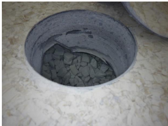
Kuvat 156 ja 157. Välipohjan rakenneavaus R30 luokkatilassa 201. Uusittu välipohja on eristetty vaahtolasilla. Välipohjan eristetilassa ei merkkisavutarkastelussa havaittu ilmavirtaa huonetilaan.
