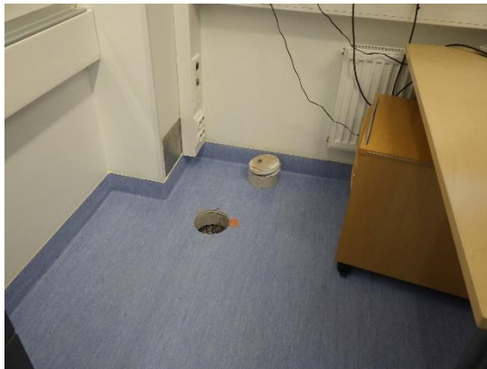
Kuvat 154 ja 155. Välipohjan rakenneavaus R23 luokkatilassa 109. Välipohjan eristeenä on käytetty koksinkuonaa. Eristetilasta virtaa ilmaa kellarikerroksen suuntaan tilan normaalilla ilmanvaihdoilla.
