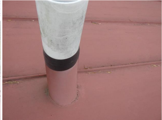
Kuvat 305 ja 306. Rakennuksen eteläpuolella viemärintuuletusputkia on tiivistetty niiden yhteydessä aiemmin havaittujen vesivuotojen takia.
