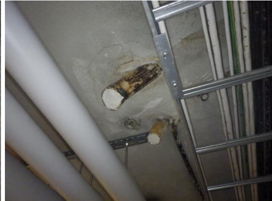
Kuvat 115 ja 116. A-osan kellaritilojen sisäkatoissa havaittiin epätiivittä vanhoja läpivientejä, joiden yhteydessä havaittiin jäämiä putkien pinnalla olleista, todennäköisesti asbestipitoisista suojakuorista.
