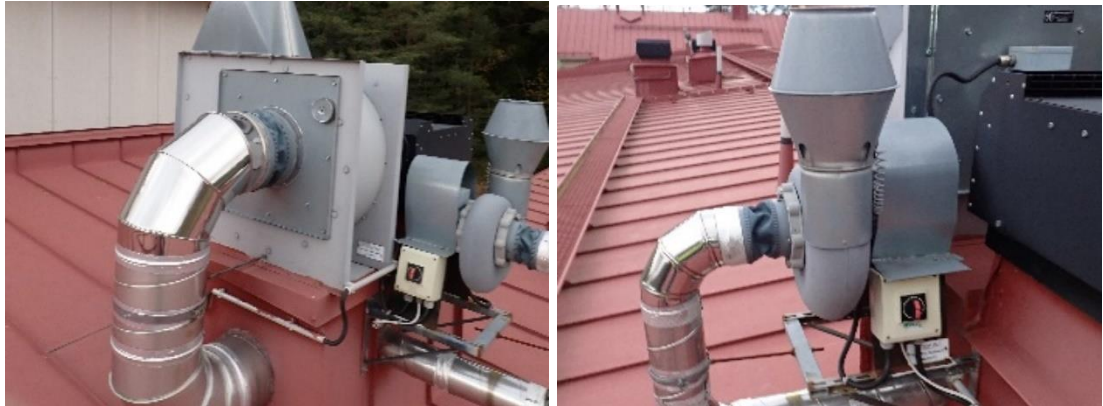
Kuvat 358 ja 359. Yleiskuvat maalauskaapin huippuimurista TK05PF02 (vasen kuva) ja maalikaapin huippuimurista TK05PF03 (oikea kuva).
