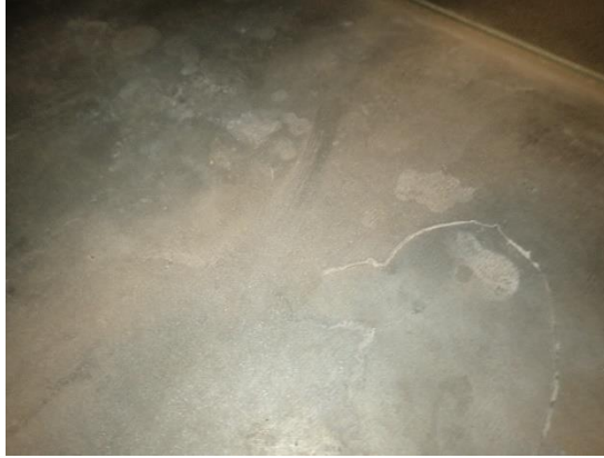
Kuvat 333 ja 334. Yleiskuvat suodatin osan pohjalta ja lto-patterista suodatinosan puolelta. Suodatin osan pohjalla havaittiin vahoja vuotojälkiä ja lto-patterin pinnalla hieman pölyyntymistä.
