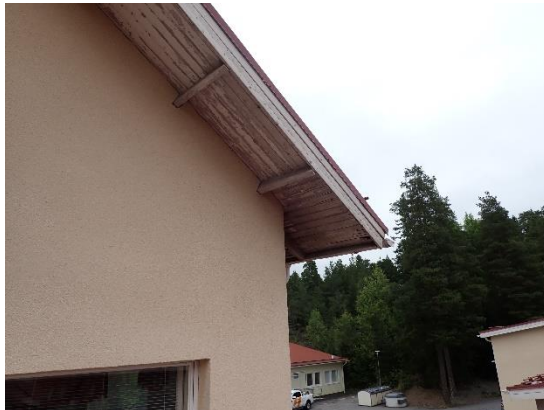
Kuvat 287 ja 288. A-osan räystäään aluslaudoituksien maalipinnat ovat kuluneita, pilkuttuneita sekä nurkassa havaittiin lahoa (nuoli).
