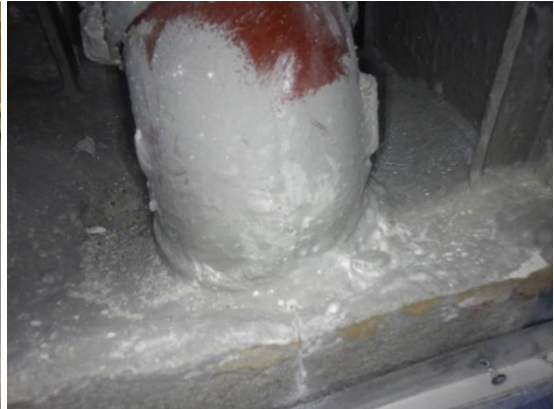
Kuvat 123 ja 124. Viemärikotelo R9 luokassa 125. Kotelo sisällä oleva viemärläpivienti on tiivistetty siveltävällä tiivistemassalla.
