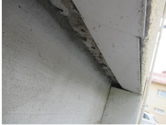
Kuvat 168 ja 169. Julkisivun lämpörappauksen alareunaan asennettu umpinainen metallilista estää eristetilaan kulkeutuvan kosteuden kuivumisen ja lisää ulkoseinien kosteusrasitetta.
