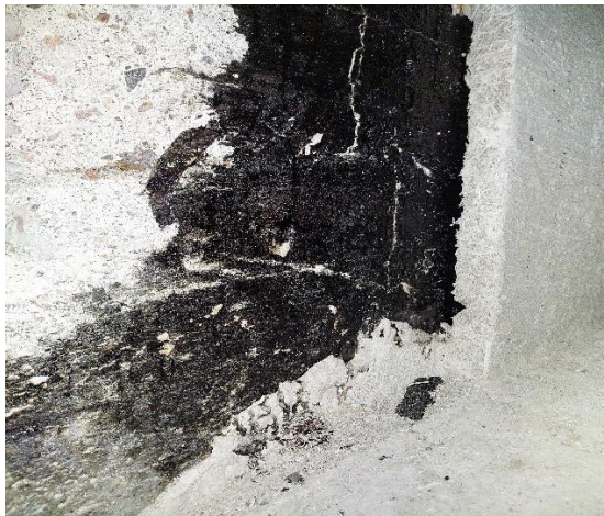
Kuva 68. Putkikanaalin kohdalla havaittiin pikisivelyä, jonka sisäpuolelle on asennettu lastuvillaeriste.
