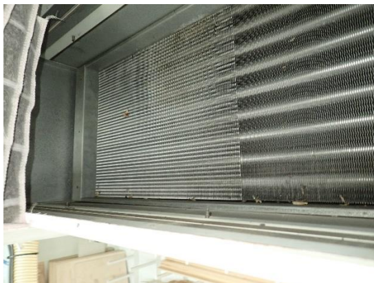
Kuvat 346 ja 347. Yleiskuvat tuloilmakoneen TK05 lämmityspatterista patterin pinnalle on kerääntynyt roskaa ulkoilmasta.
