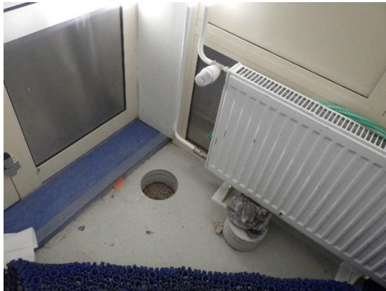
Kuvat 102 ja 103. Alapohjan rakenneavaus R26 tuulikaapissa 118. Alapohjaneristeenä on käytetty lastuvillaa. Eristetilan pinnalla oleva tervapaperi tuoksuu PAH-yhdisteiltä.
