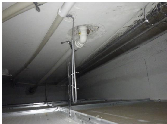
Kuvat 317 ja 318. Alakattoavaukset AK11 ja AK8 luokassa 210 ja kuraattorin huoneessa 202. Pilarin liittymä yläpohjaan on tiivis. Yläpohjassa olevan viemäriläpiviennin yhteydessä ei havaittu merkkejä vesivuodoista. Läpiviennit ei ole tiivistetty.
