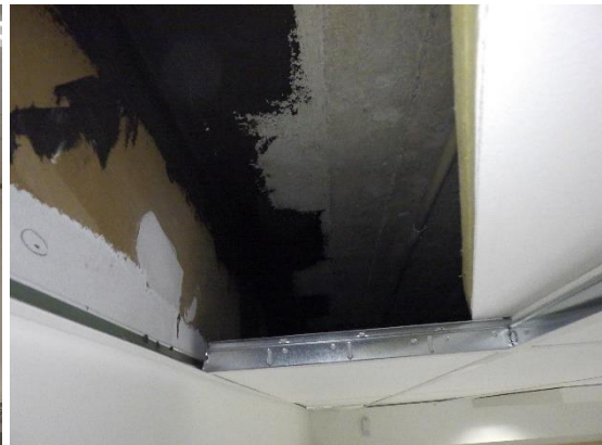
Kuvat 184 ja 185. Luokassa 109 levytetyjen ulkoseinien liittymää välipohjaan on alakaton takana tiivistetty ilmatiivistystuotteella.
