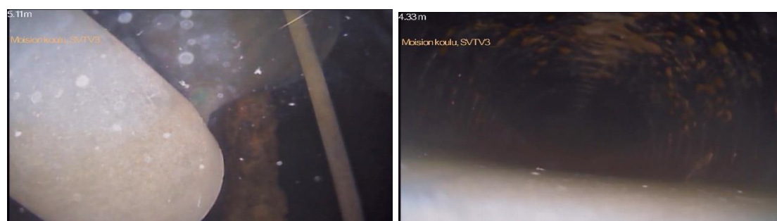
Kuvat 381 ja 382. Vasemmalla kuva SOTV3 linjan lopussa olevasta pumppaamosta. Oikealla kuva SOTV3 puolimetriä ennen linjan loppua.
