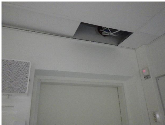
Kuvat 129 ja 130. Alakattoavaus AK4 luokkatilassa 109. Välipohjan alapinnalla ei havaittu epätiiveyskohtia.
