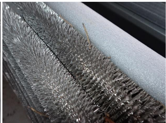
Kuvat 337 ja 338. Yleiskuvat poistoilmapuhaltimesta TK02PF01 ja neulalämmönsiirtimestä. Puhaltimen toiminnassa ei havaittu aistinvaraisesti puutteita ja neulalämmönsiirrin oli silmämääräisesti puhdas yksittäisiä roskia lukuun ottamatta. Roskia havaittiin kerääntyneen poistoilmapuhaltimen koteloimnin "lattiakaivoon". Vastaavat havainnot tehtiin toiselta poistoilmapuhaltimelta TK02PF02.
