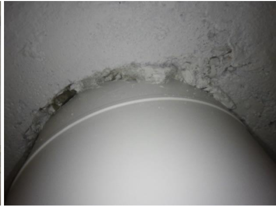
Kuvat 117 ja 118. A-osan kellarissa olevien uudempien ilmanvaihtokanavien välipohjaläpivientien yhteydessä havaittiin mineraalivillalla tehtyjä, epätiivittä läpivientejä.
