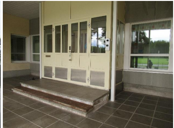
Kuvat 164 ja 165. Rakennuksen ulkoseinät ovat rapattuja. A-osassa sokkelit on laatoitettu luonnonkivilaatoitin. B-osan pääsisäänkäynnin kohdalla olevassa tuulikaapissa 118 ulkoseinät ovat peltikasetteja.
