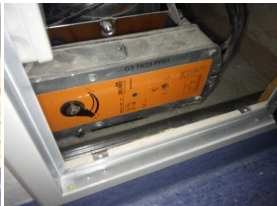
Kuvat 136 ja 137. Opettajanhuoneen 101 varastotilassa 105 olevasta kotelosta virtaa ilmaa tilojen normaalissa ilmanvaihdoissa kellarikerroksen suunnasta huonetiloihin.
