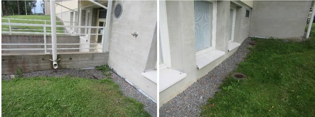
Kuvat 30 ja 31. Rakennuksen eteläreunalla havaittiin ulkopuolisia vedeneristekerroksia. Kellarikerroksen luokkatilojen kohdalla patolevytys on jäänyt paikoin vierusmaan sorapinnan alle.
