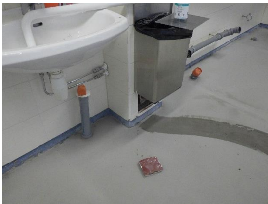
Kuvat 119 ja 120. Viemärikoteloinnin avaus R4 luokassa 108. Kipsilevykoteloinnin sisällä havaittiin runsaasti laastia. Välipohjaläpiviennin yhteydessä ei havaittu ilmanliikettä merkkinä.
