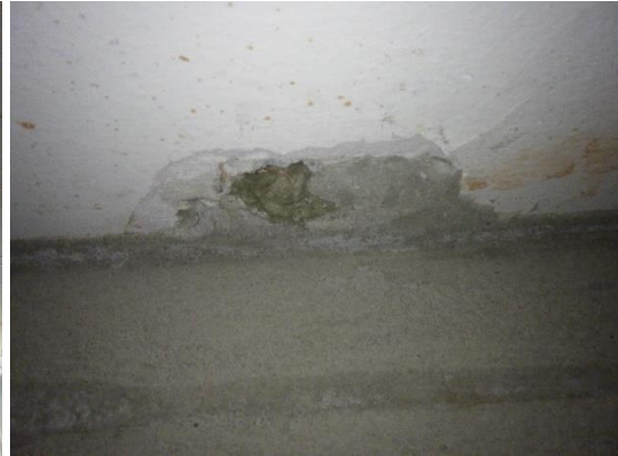
Kuvat 127 ja 128. Alakattoavaus AK1 opettajanhuoneessa 101. Välipohjan alapinnalla havaittiin mineraalivillalla tilkitty vanha läpivienti, jonka kohdalla ei merkkisavutarkastelussa havaittu tapahtuvan ilmanliikettä.
