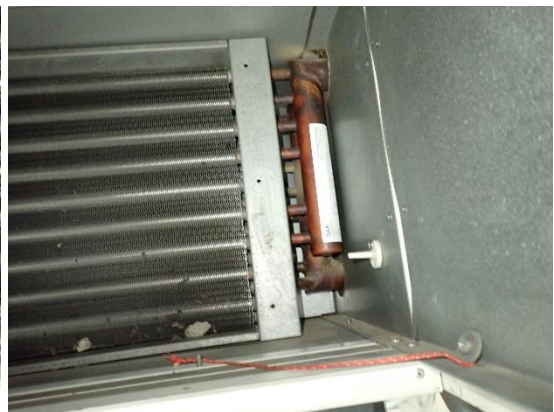
Kuvat 346 ja 347. Yleiskuvat tuloilmakoneen TK05 lämmityspatterista patterin pinnalle on kerääntynyt roskaa ulkoilmasta.
