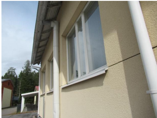
Kuvat 252 ja 253. Ikkunoiden vesipeltien kallistuksissa tai kiinnityksissä ei havaittu puutteita. Kellarikerroksen huonetilan 013 kohdalla ikkunan vesipelti on maantasolla.
