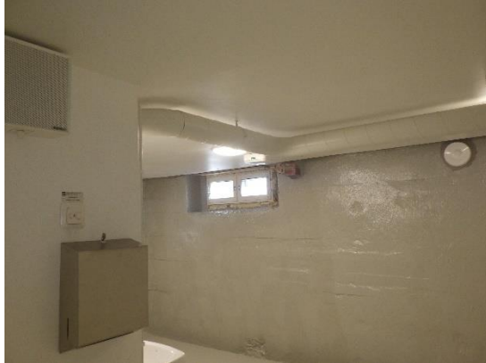
Kuvat 172 ja 173. A-osan kellarikerroksen sosiaalitulojen alaosaan maanvastaisten seinien kuorimuuraukset on poistettu tilojen PAH-saneerauksen yhteydessä. Seinien betonipintoihin on korjaussuunnitelmien mukaan asennettu Kiilto Block pinnoite.
