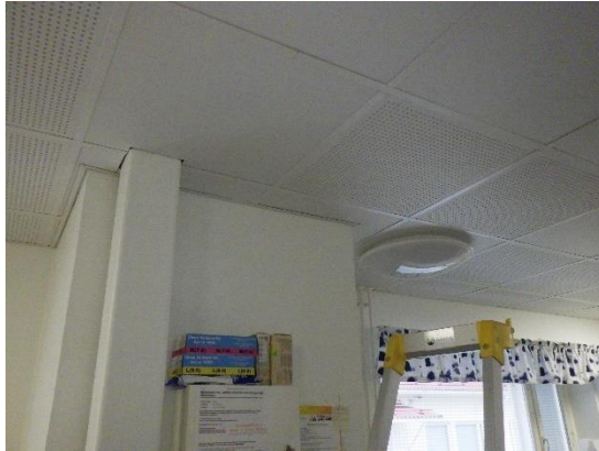
Kuvat 127 ja 128. Alakattoavaus AK1 opettajanhuoneessa 101. Välipohjan alapinnalla havaittiin mineraalivillalla tilkitty vanha läpivienti, jonka kohdalla ei merkkisavutarkastelussa havaittu tapahtuvan ilmanliikettä.
