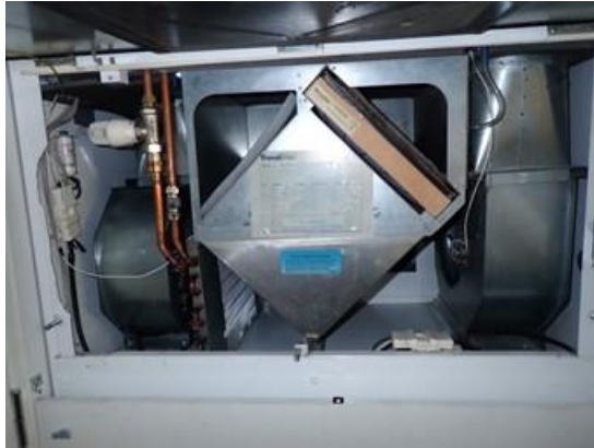
Kuvat 348 ja 349. Yleiskuvat ilmanvaihtokoneesta ja sen lämmityspatterista Ito-kuution puolelta. Kone oli sisäosiltaan siistikuntoinen.
