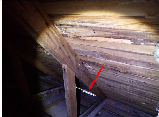
Kuvat 285 ja 286. Korkean osan katon laudoituksessa sekä muissa puurakenteissa havaittiin vanhoja kosteusjälkiä mutta ei tarkastushetkestä poikkeavaa kosteutta pistokoemaisesti piikkikosteusmittarilla tehdyssä tarkastuksessa. Vintti tuulettuu räystäällä olevien tuuletusrakojen kautta (nuoli).
