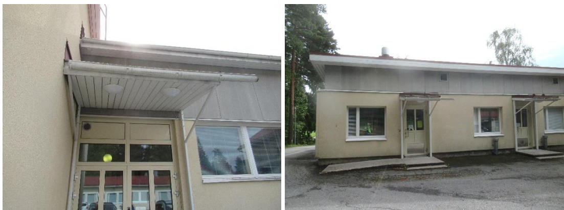
Kuvat 18 ja 19. Ovikatosten kattovedet johdetaan ilman syöksytorvia katosten viereen.
