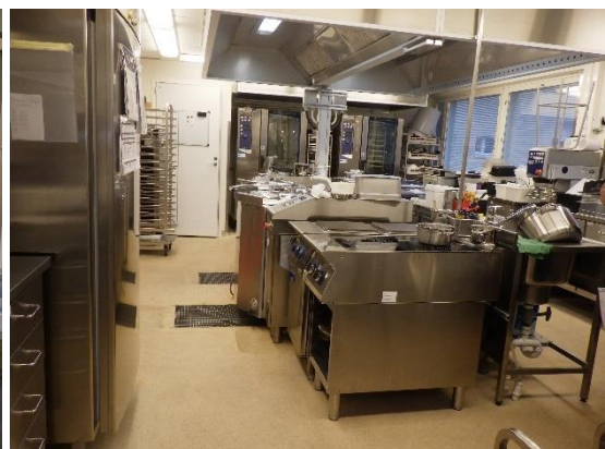
Kuvat 57 ja 58. Keittiön ja sen aputilojen lattiat on pinnoitettu akryylimassalla.
