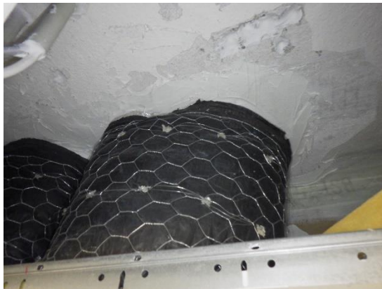
Kuvat 315 ja 316. Alakattoavaus AK16 askarteluvälinevarastossa 117. Avauksen kohdalla yläpohjan liittymä ja läpiviennit ovat tiiviitä.
