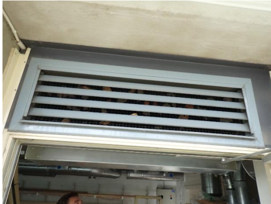
Kuvat 344 ja 345. Yleiskuvat tuloilmakoneen TK04 ulkoilmasäleiköstä ja tuloilmapuhaltimesta. Ulkoilmasäleikön sisäiseen metalliverkkoon on tarttunut useita lehtipuuja lehtiä. Puhallin oli silmämääräisesti arvioituna siistikuntoinen. TK04 ja TK05 puhaltimissa ei havaittu toiminnallisia puutteita aistinvaraisesti.
