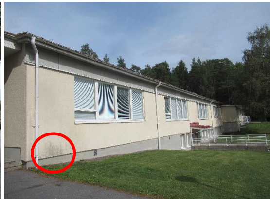
Kuvat 170 ja 171. Rakennuksen pohjoispuolella, ruokasalin kohdalla, ja eteläpuolella luokan 122 kohdalla ulkoseinien alaosien rappauspinnoissa havaittiin kosteuden aiheuttamaksi arvioitua tummentumaa.
