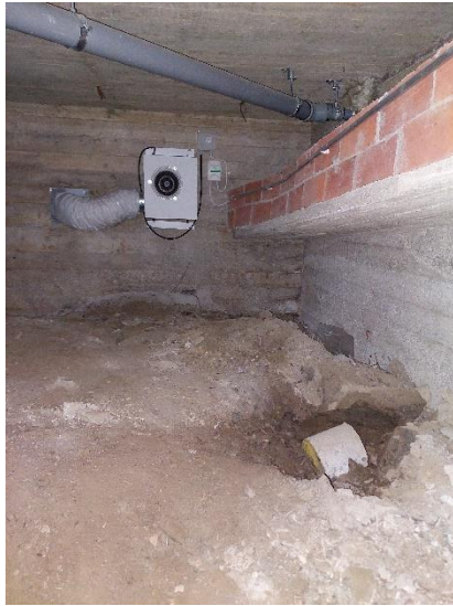
Kuvat 64 ja 65. Ryömintätilaan on asennettu tuuletusta tehostava poistopuhallin. Tilaan tuotujen viemäriputkien kohdalla laatan alle on asennettu uretaanieristettä. Levyjen paperipinnoissa havaittiin kosteusjälkiä.
