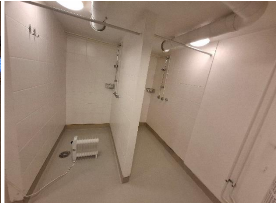
Kuvat 39 ja 40. Kellarikerroksen sosiaalitilojen ja varastojen alueella lattiat on pinnoitettu Kiilto Block tuotteella.
