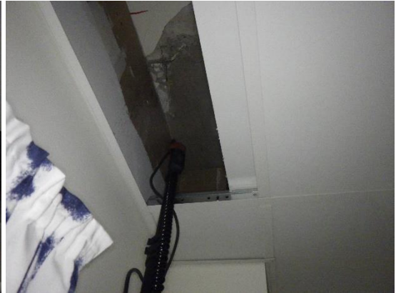
Kuvat 180 ja 181. Alakattoavaus AK1 opettajanhuoneessa 101. Ulkoseinien lisäeristekerros ei ole tiivis.
