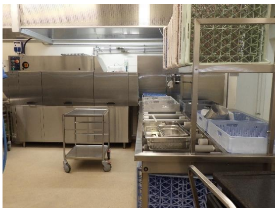
Kuvat 57 ja 58. Keittiön ja sen aputilojen lattiat on pinnoitettu akryylimassalla.
