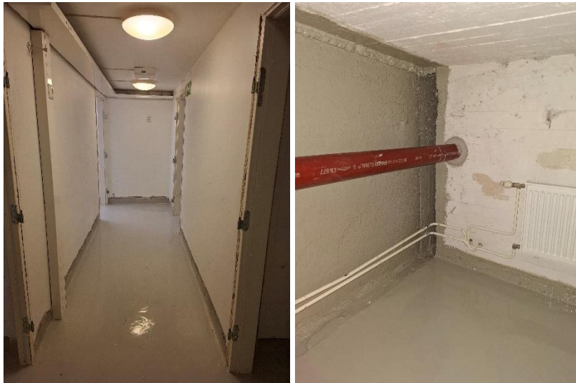
Kuvat 258 ja 259. A-osan kellarissa on tasoitettut tai slammatut kiviaineiset väliseinät.
