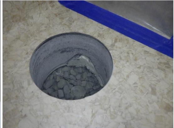
Kuvat 100 ja 101. Ilmanvastaisen alapohjan rakenneavaus R31 luokassa 201. Uusitun rakenteen eristeenä on käytetty vaahtolasia. Eristetilan pinnalle on asennettu teräksinen ohutlevy. Eristetila on ilmayhteydessä ulkoseinien lisäeristekerrokseen.
