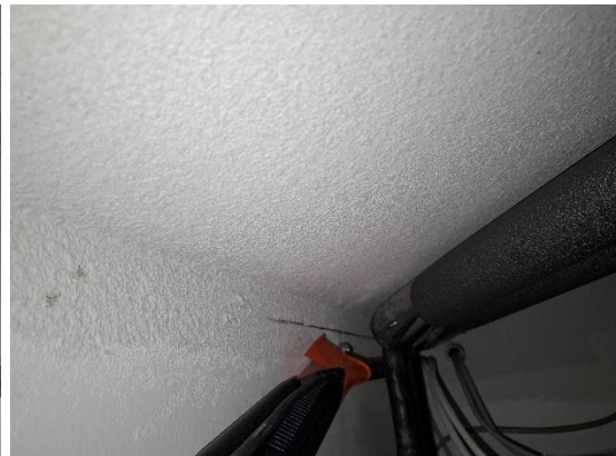
Kuvat 327 ja 328. Yläpohjan merkkiainekoe MA15 huoneessa 121. Alakattotilaan kulkeutuu yläpohjasta peräisin olevaa ilmavuotoa ulkoseinän yläosassa olevista käytöstä poistetuista kiinnityskohdista ja huoneen nurkassa olevasta sähköjohtojen läpiviennistä.
