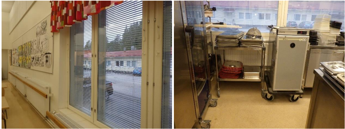
Kuvat 186 ja 187. Ruokasalin kohdalla kiviaineisen ulkoseinän sisäpinta on tasoitettu ja maalattu. Keittiössä ulkoseinän sisäpinta on laatoitettu keraamisilla laatoilla.
