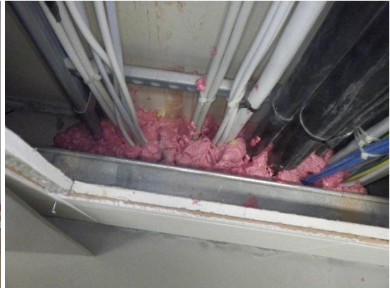
Kuvat 121 ja 122. Tekniikkakotelo R5 luokassa 108. Kipsilevykotelo sisällä olevat sähköjohtojen läpiviennit on tiivistetty palouretaanilla. Läpiviennin yhteydessä ei havaittu selkeää ilmavirtaa luokan ja kellarin välillä.
