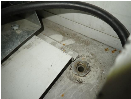
Kuvat 350 ja 351. Yleiskuvat ilmanvaihtokoneen TK06 kondenssiviemäröinnistä. Kondenssiviemäröinti on johdettu letkulla tilan lattiakaivoon.
