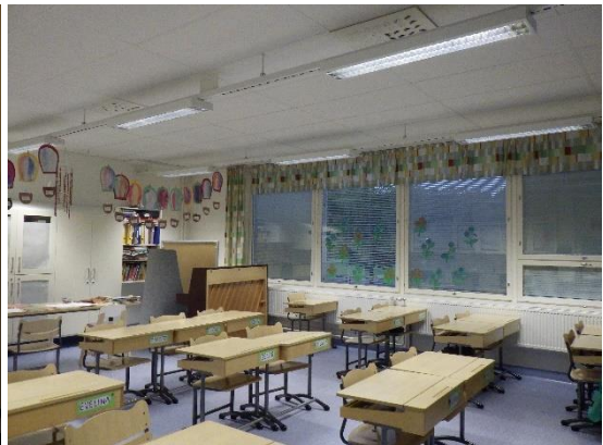
Kuvat 240 ja 241. Puu-alumiini-ikkunat on varustettu tuuletusluukuilla.
