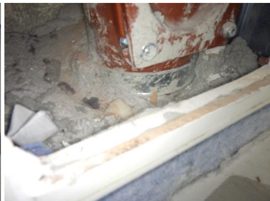
Kuvat 119 ja 120. Viemärikoteloinnin avaus R4 luokassa 108. Kipsilevykoteloinnin sisällä havaittiin runsaasti laastia. Välipohjaläpiviennin yhteydessä ei havaittu ilmanliikettä merkkinä.
