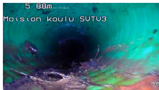
Kuvat 379 ja 380. Vasemmalla kuva SVTV3 linjan pohjalla olevasta likakertymästä. Oikealla kuva SVTV5 esimerkkipiirros linjan aaltoilusta (kuvassa maltillinen).
