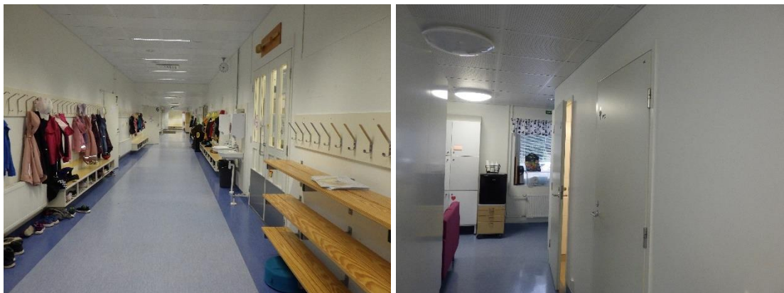
Kuvat 260 ja 261. Kuivien huonetilojen väliseinät ovat pääosin tasoitettua betonia tai tiiltä.
