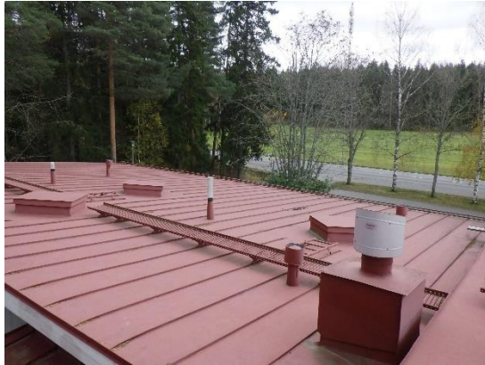
Kuvat 305 ja 306. Rakennuksen eteläpuolella viemärintuuletusputkia on tiivistetty niiden yhteydessä aiemmin havaittujen vesivuotojen takia.
