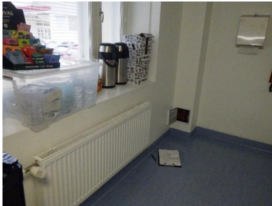
Kuvat 134 ja 135. Opettajanhuoneen 101 keittiötilassa 104 olevasta levykoteloitinnasta virtaa ilmaa tilojen normaalissa ilmanvaihdoissa kellarikerroksen suunnasta huonetiloihin.
