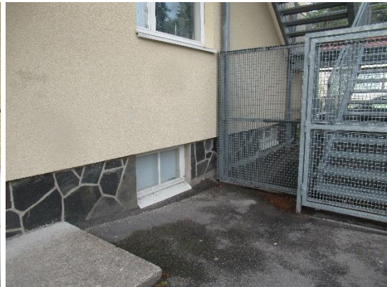
Kuvat 252 ja 253. Ikkunoiden vesipeltien kallistuksissa tai kiinnityksissä ei havaittu puutteita. Kellarikerroksen huonetilan 013 kohdalla ikkunan vesipelti on maantasolla.
