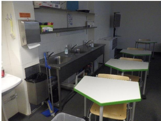
Kuvat 262 ja 263. Luokkien käsienvesialtoiden ja vesipisteiden yhteyteen on asennettu keraamista laatoitusta. Wc-tilojen alueella väliseinät on laatoitettu.
