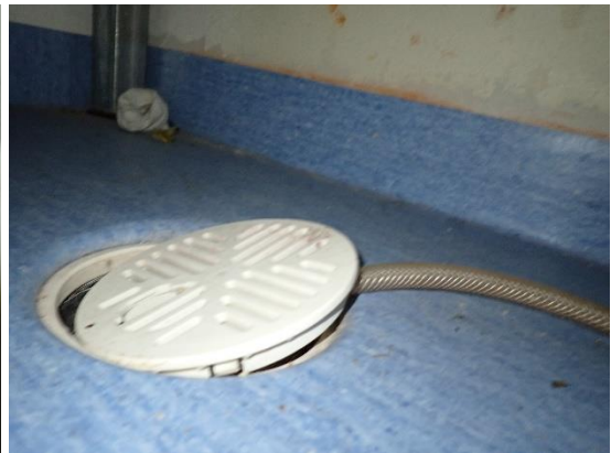
Kuvat 350 ja 351. Yleiskuvat ilmanvaihtokoneen TK06 kondenssiviemäröinnistä. Kondenssiviemäröinti on johdettu letkulla tilan lattiakaivoon.
