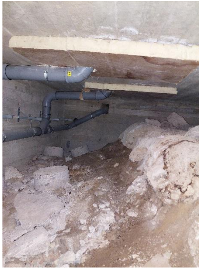
Kuvat 64 ja 65. Ryömintätilaan on asennettu tuuletusta tehostava poistopuhallin. Tilaan tuotujen viemäriputkien kohdalla laatan alle on asennettu uretaanieristettä. Levyjen paperipinnoissa havaittiin kosteusjälkiä.
