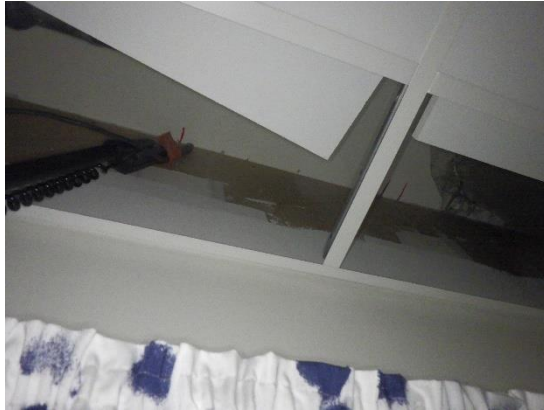
Kuvat 180 ja 181. Alakattoavaus AK1 opettajanhuoneessa 101. Ulkoseinien lisäeristekerros ei ole tiivis.
