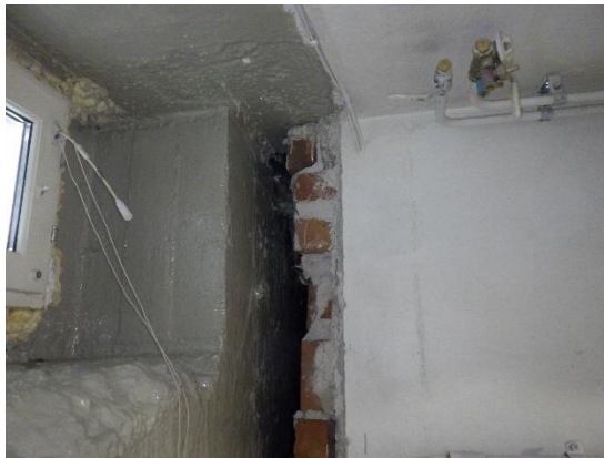
Kuvat 174 ja 175. Saneerauksen yhteydessä kellarin keveät tiiliväliseinät on avattu ulkoseinien vierustoilta. Väliseinäilytysten kohdalla havaittiin jäämiä ulkoseinien sisäpinnoilla olleesta PAH-yhdisteistä vedeneristeestä. Tiloissa havaittiin PAH-yhdisteisiin viittaavaa hajua.
