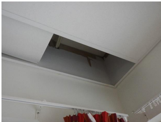
Kuvat 182 ja 183. Alakattoavaus AK9 luokassa 210. Ulkoseinien lisäeristekerros ei ole tiivis. Höyrynsulkumuovin leikattu reuna (nuolet) kiertyy esiin levytyksen ja kiviaineisen yläpohjan välissä olevasta raosta.
