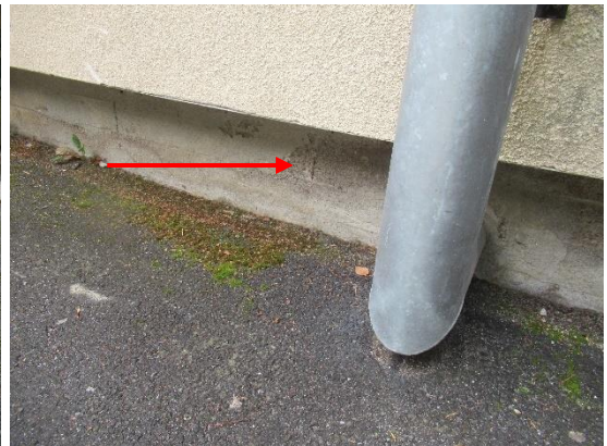
Kuvat 12 ja 13. Iltaapäiväkerhon sisäänkäynnin edustalla asfalttipinnalla havaittiin laajaa sammalkasvustoa ja sokkelissa uudempiä paikkauskohtia. Ruokalan ulkoseinällä, ryömintätilan tuuletusputken vierellä, sokkelissa havaittiin yksittäinen paljastunut raudoitus (nuoli) sekä pinnan rapautumista.
