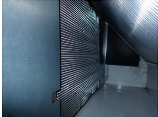
Kuvat 348 ja 349. Yleiskuvat ilmanvaihtokoneesta ja sen lämmityspatterista Ito-kuution puolelta. Kone oli sisäosiltaan siistikuntoinen.
