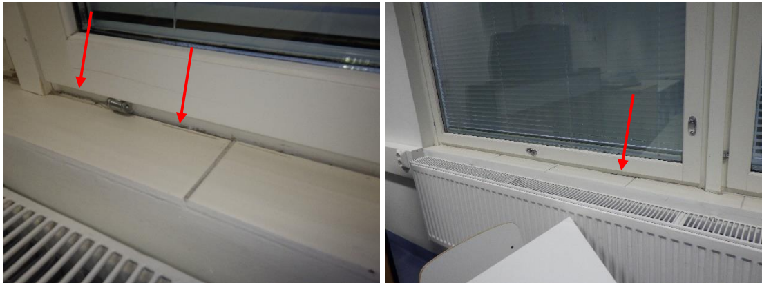
Kuvat 188 ja 189. B-osan luokkatiloissa ikkunoiden liittymät ovat epätiivait. Liittymistä havaittiin merkkisavutarkastelussa ilmanliikettä huonetilan ja rakenteen välillä (nuolet).
