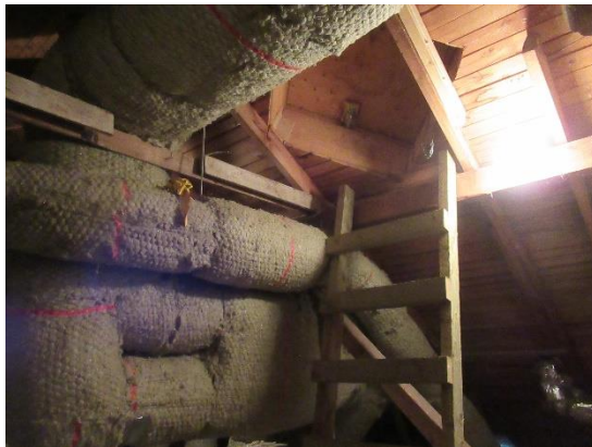
Kuvat 363 ja 364. Yleiskuvat ilmanvaihtokanavista ullakkotilasta ja ilmanvaihtokonehuoneesta. Lähötietojen ja silmämääräisten havaintojen perusteella kanavat ovat pyöreää kierresaumaa kanavaa. Ullakkotilassa kanavat ovat paloeristetty.
