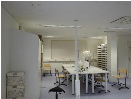
Kuvat 311 ja 312. A-osan luokkatilojen yläpohjaan rajautuvat sisäkatot ovat listoille asennettua akustiikka-alakattoja. B-osan korkeassa ruokasalissa akustiikkalevytys on asennettu kattopintaan.
