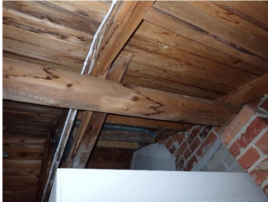
Kuvat 285 ja 286. Korkean osan katon laudoituksessa sekä muissa puurakenteissa havaittiin vanhoja kosteusjälkiä mutta ei tarkastushetkestä poikkeavaa kosteutta pistokoemaisesti piikkikosteusmittarilla tehdyssä tarkastuksessa. Vintti tuulettuu räystäällä olevien tuuletusrakojen kautta (nuoli).
