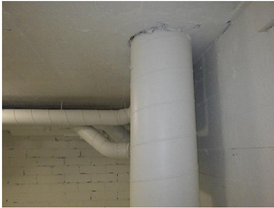
Kuvat 117 ja 118. A-osan kellarissa olevien uudempien ilmanvaihtokanavien välipohjaläpivientien yhteydessä havaittiin mineraalivillalla tehtyjä, epätiivittä läpivientejä.
