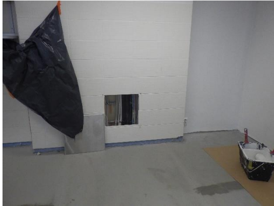
Kuvat 121 ja 122. Tekniikkakotelo R5 luokassa 108. Kipsilevykotelo sisällä olevat sähköjohtojen läpiviennit on tiivistetty palouretaanilla. Läpiviennin yhteydessä ei havaittu selkeää ilmavirtaa luokan ja kellarin välillä.
