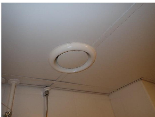
Kuvat 365 ja 366. Yleiskuvat poistoilmaventtiilistä. Tarkasteluiden perusteella venttiilit olivat hyväkuntoisia ja lähes puhtaita.
