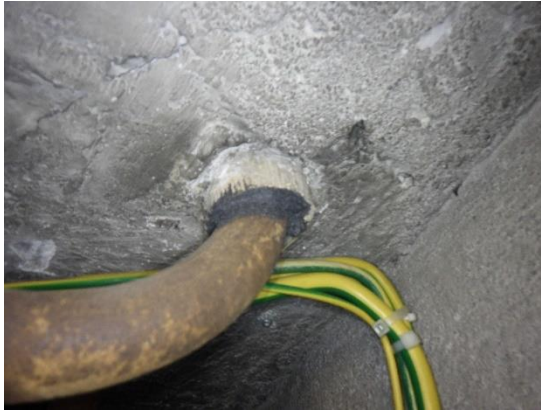
Kuvat 115 ja 116. A-osan kellaritilojen sisäkatoissa havaittiin epätiivittä vanhoja läpivientejä, joiden yhteydessä havaittiin jäämiä putkien pinnalla olleista, todennäköisesti asbestipitoisista suojakuorista.
