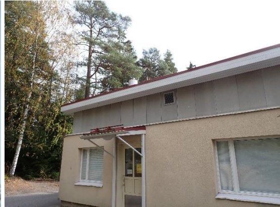
Kuvat 361 ja 362. Yleiskuvat ilmanvaihtokoneiden ulkoilmanotoista, ulkoilmalaitteet ovat tavanomaisia harvalamellisia ulkoilmasäleikköjä.
