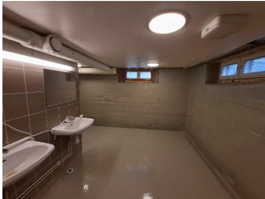
Kuvat 39 ja 40. Kellarikerroksen sosiaalitilojen ja varastojen alueella lattiat on pinnoitettu Kiilto Block tuotteella.
