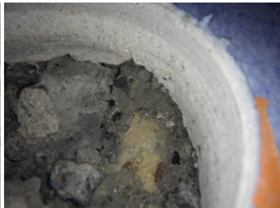
Kuvat 152 ja 153. Rakenneavaus R22 opettajanhuoneen keittiötilassa 104. Koksinkuonalla eristetyin välipohjan sisällä havaittiin vanhoja lämpöjohtoja, joiden suojakuoret ovat todennäköisesti asbestipitoisia. Eristetilasta virtaa ilmaa huonetilan suuntaan huonetilan normaalilla ilmanvaihdoilla.
