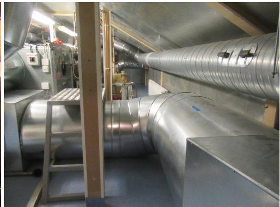
Kuvat 363 ja 364. Yleiskuvat ilmanvaihtokanavista ullakkotilasta ja ilmanvaihtokonehuoneesta. Lähötietojen ja silmämääräisten havaintojen perusteella kanavat ovat pyöreää kierresaumaa kanavaa. Ullakkotilassa kanavat ovat paloeristetty.
