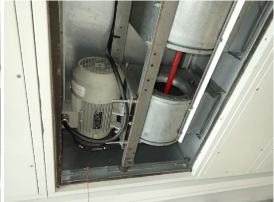
Kuvat 344 ja 345. Yleiskuvat tuloilmakoneen TK04 ulkoilmasäleiköstä ja tuloilmapuhaltimesta. Ulkoilmasäleikön sisäiseen metalliverkkoon on tarttunut useita lehtipuuja lehtiä. Puhallin oli silmämääräisesti arvioituna siistikuntoinen. TK04 ja TK05 puhaltimissa ei havaittu toiminnallisia puutteita aistinvaraisesti.
