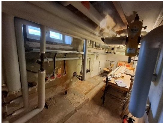
Kuvat 43 ja 44. A-osan teknisten tilojen alueella maanvastaiset lattiat ovat maalaamatonta betonia.
