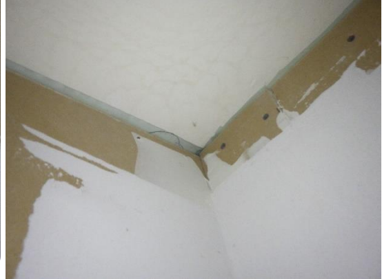
Kuvat 313 ja 314. Alakattoavaukset AK10 ja AK9 luokassa 210. Ulkoseinän lisäeristekerrosta ei ole tiivistetty yläpohjaan ja liittymässä olevasta raosta tapahtuu ilmavirtauksia rakenteen ja alakaton välillä.
