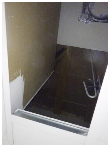
Kuvat 321 ja 322. Alakattoavaus AK12 luokassa 136. Alakaton takana havaittiin korkea ilmatila ja kattorakenteiden betonipalkkeja ja lappeensuuntaisen yläpohjan levytystä.
