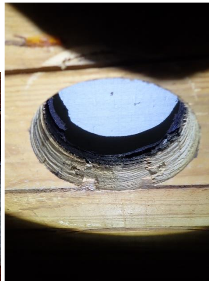
Kuvat 283 ja 284. Korkean osan vesikaton puurakenteet ovat pääosin vanhoja. Katteen alla olevan umpilaudoituksen päälle on jätetty vanha aluskermi. Kermin takana havaittiin uuden vesikatteen alla olevaa uutta aluskatetta.
