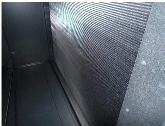
Kuvat 335 ja 336. Yleiskuvat lämmityspatterista ja tuloilmapuhaltimesta. Lämmityspatterin pinnalla havaittiin hieman pölyyntymistä ja puhallin oli siistikuntoinen.
