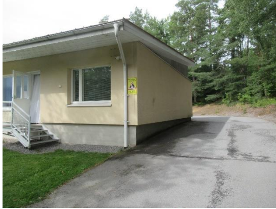
Kuvat 10 ja 11. Itäpäädyssä huoltotien ja -pihan kohdalla rakennuksen vierusta on asfaltoitu. Asfalttipinnoilla ja sokkeleissa, sekä osittain myös rapattujen julkisivujen alaosissa havaittiin kosteuden aiheuttamaa tummentumaa sekä levä- ja sammalkasvua.
