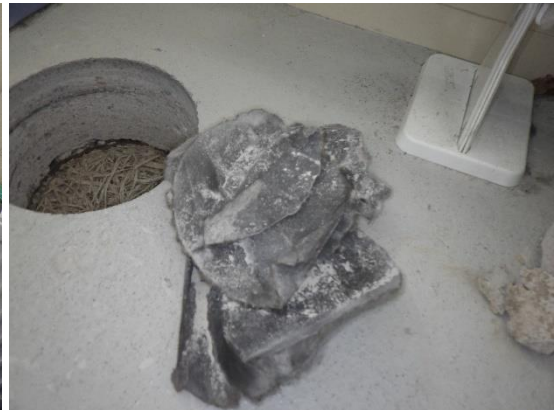
Kuvat 102 ja 103. Alapohjan rakenneavaus R26 tuulikaapissa 118. Alapohjaneristeenä on käytetty lastuvillaa. Eristetilan pinnalla oleva tervapaperi tuoksuu PAH-yhdisteiltä.
