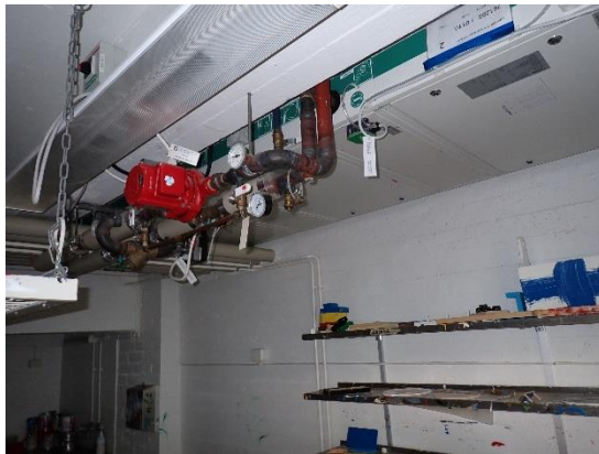
Kuva 343. Yleiskuva tuloilmakoneesta TK05. Ilmanvaihtokone TK04 on vastaavanlainen kattoasenteinen tuloilmakone.
