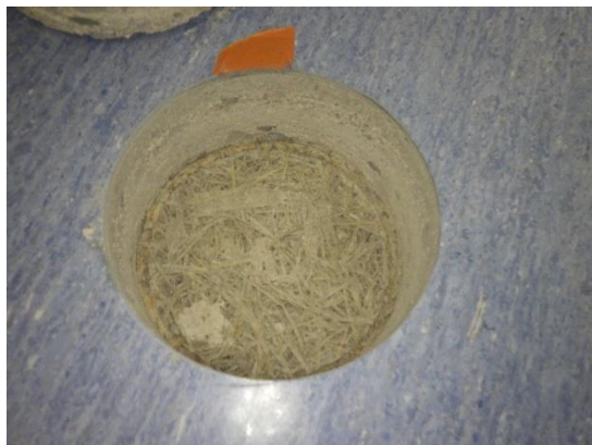
Kuvat 158 ja 159 . Välipohjan rakenneavaus R29 luokkatilassa 136. Väli-pohjan eristeenä on käytetty lastuvillaa. Eristeen pinnalla olevan tervapaperin yhteydessä todettiin PAH-yhdisteisiin viittaavaa tuoksua.
