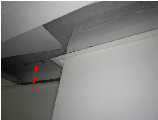
Kuvat 319 ja 320. Alakatonavaus AK15 tilassa 142. Avauksen kohdalla olevan pilarin liittymä yläpohjaan on tiivis. Ulkoseinän sisäkuoren liittymässä yläpohjaan havaittiin merkittävää epätiiveyttä (nuolet).
