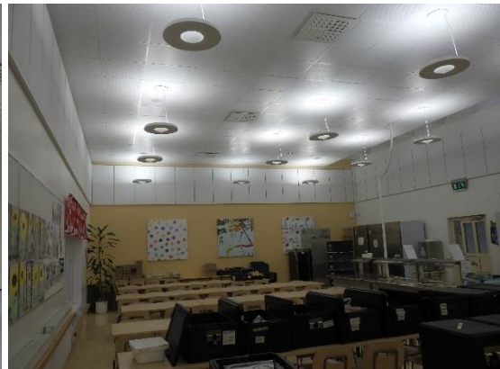
Kuvat 311 ja 312. A-osan luokkatilojen yläpohjaan rajautuvat sisäkatot ovat listoille asennettua akustiikka-alakattoja. B-osan korkeassa ruokasalissa akustiikkalevytys on asennettu kattopintaan.
