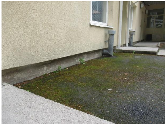
Kuvat 12 ja 13. Iltaapäiväkerhon sisäänkäynnin edustalla asfalttipinnalla havaittiin laajaa sammalkasvustoa ja sokkelissa uudempiä paikkauskohtia. Ruokalan ulkoseinällä, ryömintätilan tuuletusputken vierellä, sokkelissa havaittiin yksittäinen paljastunut raudoitus (nuoli) sekä pinnan rapautumista.
