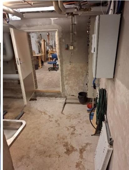
Kuvat 43 ja 44. A-osan teknisten tilojen alueella maanvastaiset lattiat ovat maalaamatonta betonia.
