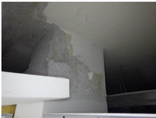
Kuvat 317 ja 318. Alakattoavaukset AK11 ja AK8 luokassa 210 ja kuraattorin huoneessa 202. Pilarin liittymä yläpohjaan on tiivis. Yläpohjassa olevan viemäriläpiviennin yhteydessä ei havaittu merkkejä vesivuodoista. Läpiviennit ei ole tiivistetty.
