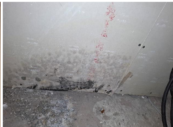
Kuvat 266 ja 267. A-osan kellarin sähköpääkeskuksen seinä on puurunkoinen. Keskukseen sisällä kipsilevytyksen alareunassa havaittiin mikrobikasvun aiheuttama vaurio.
