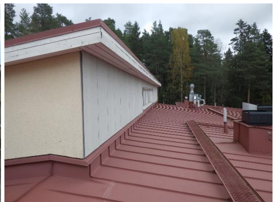
Kuvat 166 ja 167. B-osassa ulkoseinien yläpohjaan rajautuvat alueet ja ruokasalin yläikkunoiden kohdalla oleva ulkoseinä on levytetty julkisivusta kuitusementtilevyin.
