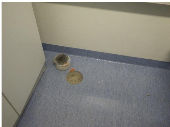
Kuvat 158 ja 159 . Välipohjan rakenneavaus R29 luokkatilassa 136. Väli-pohjan eristeenä on käytetty lastuvillaa. Eristeen pinnalla olevan tervapaperin yhteydessä todettiin PAH-yhdisteisiin viittaavaa tuoksua.
