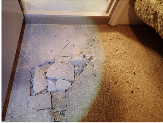
Kuvat 309 ja 310. A-osan vintin lattia (yläpohja) on eristetty orgaanisella eristeellä.
