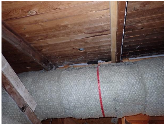
Kuvat 283 ja 284. Korkean osan vesikaton puurakenteet ovat pääosin vanhoja. Katteen alla olevan umpilaudoituksen päälle on jätetty vanha aluskermi. Kermin takana havaittiin uuden vesikatteen alla olevaa uutta aluskatetta.
