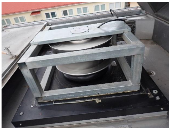
Kuvat 337 ja 338. Yleiskuvat poistoilmapuhaltimesta TK02PF01 ja neulalämmönsiirtimestä. Puhaltimen toiminnassa ei havaittu aistinvaraisesti puutteita ja neulalämmönsiirrin oli silmämääräisesti puhdas yksittäisiä roskia lukuun ottamatta. Roskia havaittiin kerääntyneen poistoilmapuhaltimen koteloimnin "lattiakaivoon". Vastaavat havainnot tehtiin toiselta poistoilmapuhaltimelta TK02PF02.
