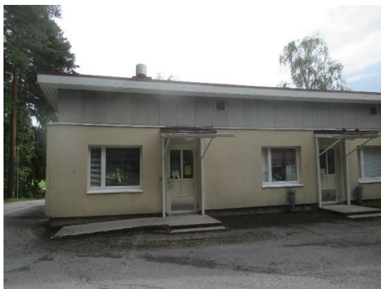
Kuvat 166 ja 167. B-osassa ulkoseinien yläpohjaan rajautuvat alueet ja ruokasalin yläikkunoiden kohdalla oleva ulkoseinä on levytetty julkisivusta kuitusementtilevyin.
