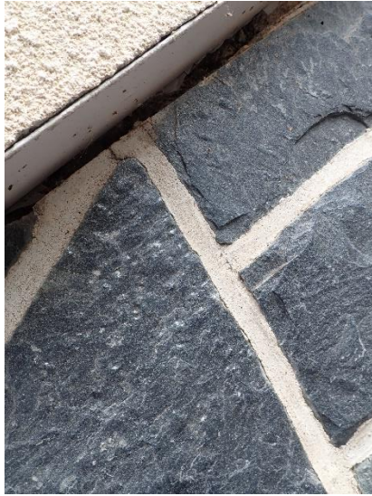
Kuvat 168 ja 169. Julkisivun lämpörappauksen alareunaan asennettu umpinainen metallilista estää eristetilaan kulkeutuvan kosteuden kuivumisen ja lisää ulkoseinien kosteusrasitetta.
