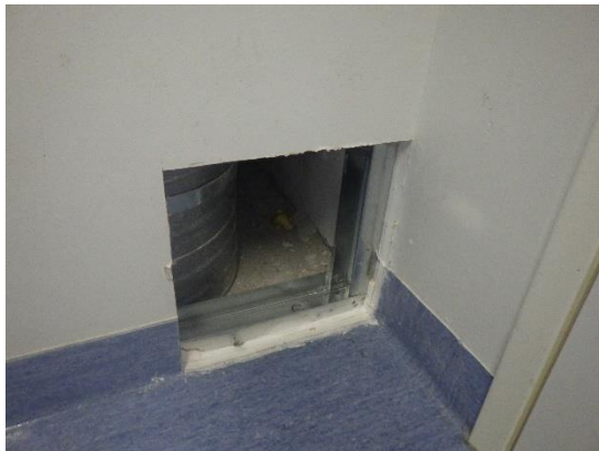
Kuvat 125 ja 126. Tekniikkakotelo R10 luokassa 132. Kipsilevykotelo sisällä oleva ilmanvaihtokanavan läpivienti on tiivis.
