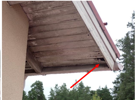
Kuvat 287 ja 288. A-osan räystäään aluslaudoituksien maalipinnat ovat kuluneita, pilkuttuneita sekä nurkassa havaittiin lahoa (nuoli).
