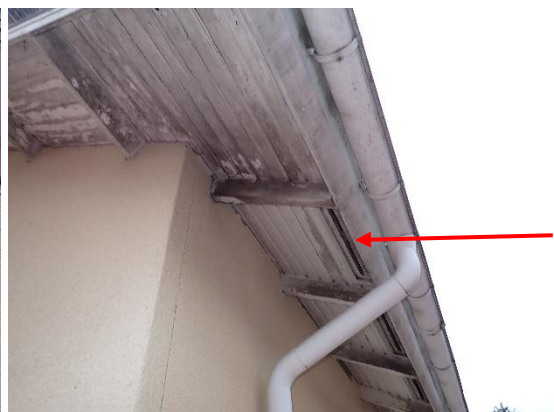
Kuvat 289 ja 290. Korkean osan räystäään aluslaudoituksien maalipinnat ovat kuluneita ja homekasvuston pilkuttamia. Pitkällä sivulla laudoituksen ulkoreunassa tuuletusta varten aukot.
