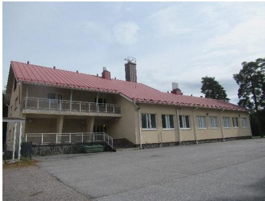
Kuvat 164 ja 165. Rakennuksen ulkoseinät ovat rapattuja. A-osassa sokkelit on laatoitettu luonnonkivilaatoitin. B-osan pääsisäänkäynnin kohdalla olevassa tuulikaapissa 118 ulkoseinät ovat peltikasetteja.
