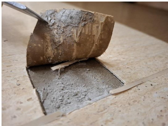
Kuvat 74 ja 75. Puutyöluokan varaston 036 viiltomittauksessa V3 ja vertailumittauksessa V4 suhteellinen kosteus oli koholla lattiapäällysteen alla. Viillossa V3 liima oli tummentunut. Molemmissa viilloissa havaittiin poikkeavaa kemiallista hajua.
