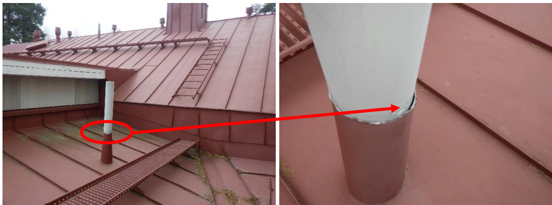
Kuvat 303 ja 304. Rakennuksen pohjoisreunalla olevien viemärintuuletusputkien yhteydessä havaittiin epätiivelysalueita.
