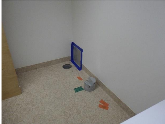
Kuvat 100 ja 101. Ilmanvastaisen alapohjan rakenneavaus R31 luokassa 201. Uusitun rakenteen eristeenä on käytetty vaahtolasia. Eristetilan pinnalle on asennettu teräksinen ohutlevy. Eristetila on ilmayhteydessä ulkoseinien lisäeristekerrokseen.
