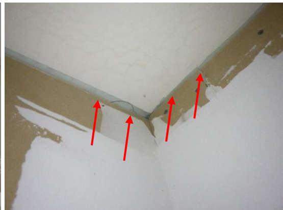
Kuvat 182 ja 183. Alakattoavaus AK9 luokassa 210. Ulkoseinien lisäeristekerros ei ole tiivis. Höyrynsulkumuovin leikattu reuna (nuolet) kiertyy esiin levytyksen ja kiviaineisen yläpohjan välissä olevasta raosta.
