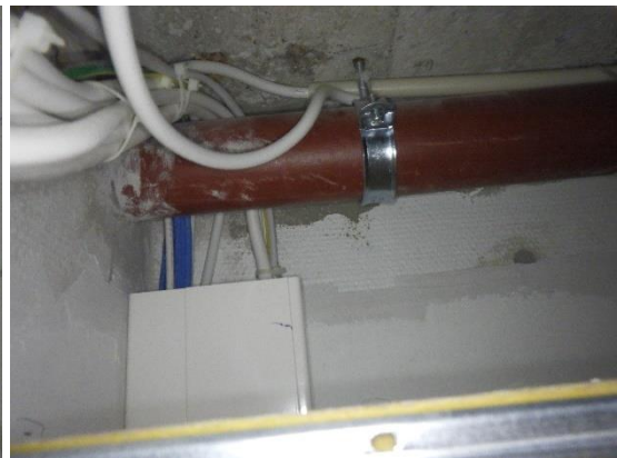
Kuvat 129 ja 130. Alakattoavaus AK4 luokkatilassa 109. Välipohjan alapinnalla ei havaittu epätiiveyskohtia.
