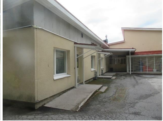
Kuvat 10 ja 11. Itäpäädyssä huoltotien ja -pihan kohdalla rakennuksen vierusta on asfaltoitu. Asfalttipinnoilla ja sokkeleissa, sekä osittain myös rapattujen julkisivujen alaosissa havaittiin kosteuden aiheuttamaa tummentumaa sekä levä- ja sammalkasvua.
