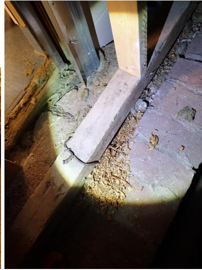
Kuvat 309 ja 310. A-osan vintin lattia (yläpohja) on eristetty orgaanisella eristeellä.
