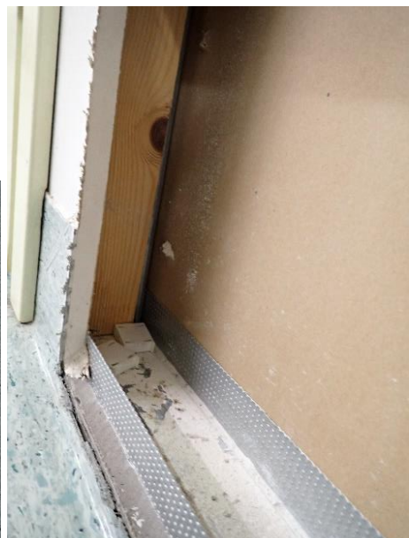
Kuvat 97, 98, 99 ja 100. Rakenneavaus R10 pukuhuoneen 123 ja wc:n 124 välisessä seinässä. Avauskohta oli siisti eikä siinä havaittu aistinvaraisesti viitteitä vaurioista.
