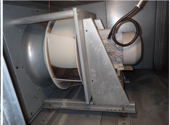
Kuvat 143 ja 144. Yleiskuvat lto:n ja lämmityspatterin välisestä osasta ja tuloilmapuhaltimesta. Lto:n ja lämmityspatterin välissä ei havaittu merkkejä kerääntyneestä kosteudesta ja tuloilmapuhallin oli siistikuntoinen.
