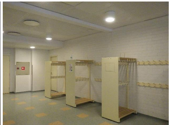
Kuvat 89 ja 90. Väliseinät ovat pääasiassa maalattuja tiiliväliseiniä.
