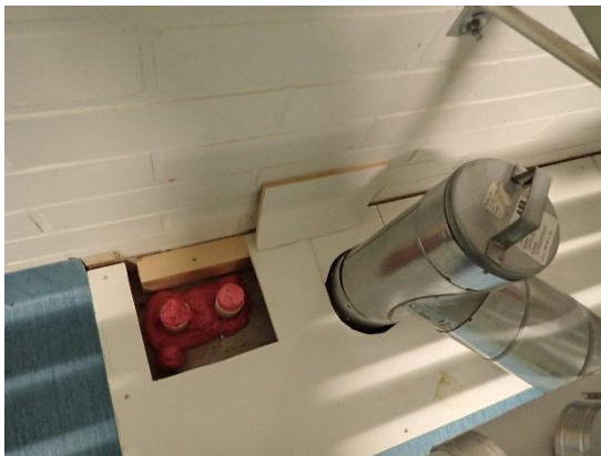
Kuvat 77 ja 78. Välipohjan läpivientejä on tiivistetty palouretaanilla, näkyvillä olleissa läpivienneissä ei havaittu merkittäviä puutteita.
