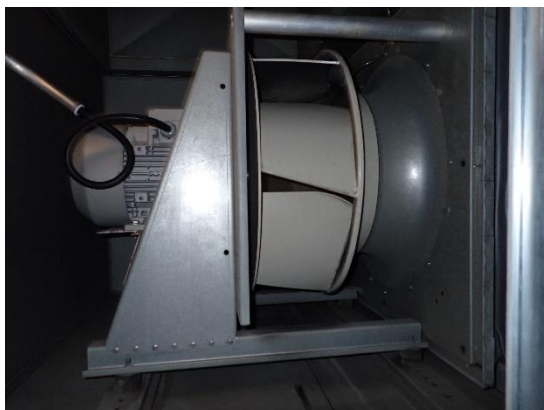
Kuvat 147 ja 148. Yleiskuvat poistoilmapuhaltimesta ja poistopuolen äänenvaimennuskaseteista. Puhallin oli hieman pölyyntynyt ja äänenvaimentimet olivat keränneet pölyä pinnoille. Silmämääräisen arvion perusteella äänenvaimennusmateriaali on kangaspinnoitettu mineraalivilla.
