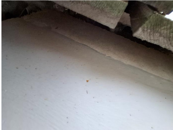
Kuvat 48 ja 49. Laudoitettu julkisivu tuulettuu seinän alaosan ilmaraon kautta. Vaneriverhotuilla osuuksilla julkisivu tuulettuu vanerilevyjen alareunassa olevien tuuletusrakojen kautta. Länsipäädyssä vaneriverhotun julkisivun pellityksessä havaittiin yksittäinen mekaaninen vaurio (ympyröity).
