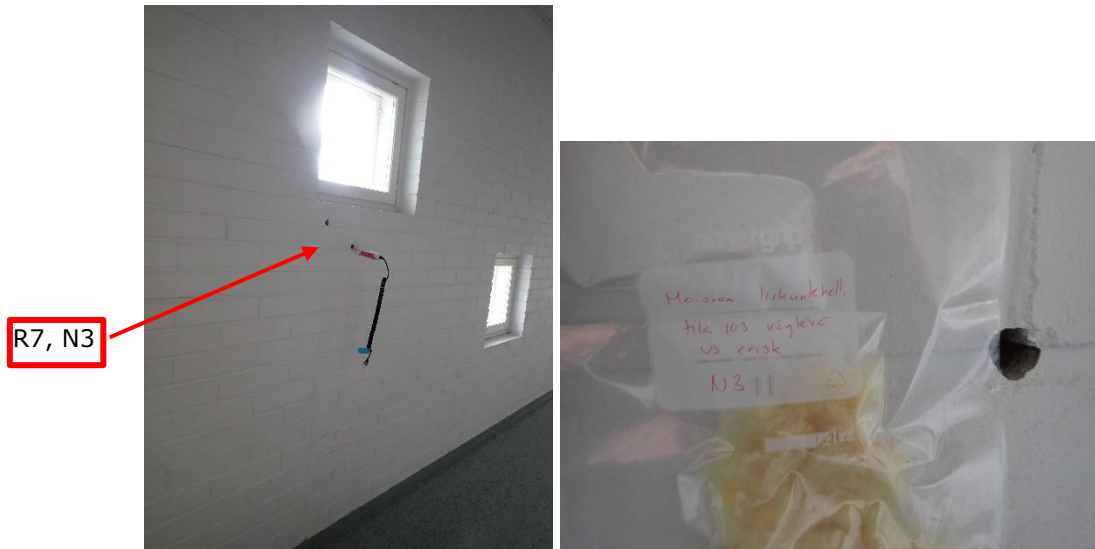
Kuvat 68 ja 69. Rakenneavaus R7, käytävä 103. Avauskohdasta otettiin ulkoseinän eristeestä näyte mikrobianalyysia varten (N3).
