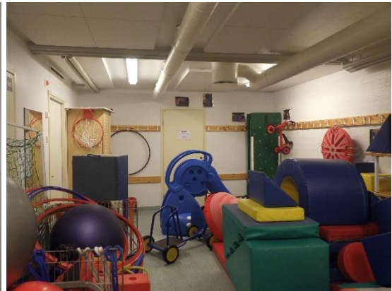
Kuvat 136 ja 137. Väestönsuojatiloissa olevien pukuhuoneitten sisäkattoon on asennettu akustiikkalevytystä. Levyjen yhteydessä ei havaittu avoimia mineraalivillapintoja.
