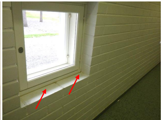
Kuvat 56 ja 57. Merkkisavutarkastelussa tiiliverhottujen ulkoseinien liittymissä ja seiniin asennettujen pistorasioitten reunoilla havaittiin ilmavirtausta rakenteesta huonetilojen suuntaan.
