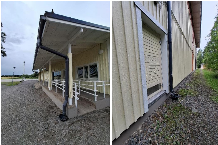
Kuvat 11 ja 12. Rakennuksen kattovedet johdetaan sadevesikourujen ja syöksytorvien avulla maanalaaiseen sadevesijärjestelmään. Sadevesijärjestelmissä ei havaittu puutteita.
