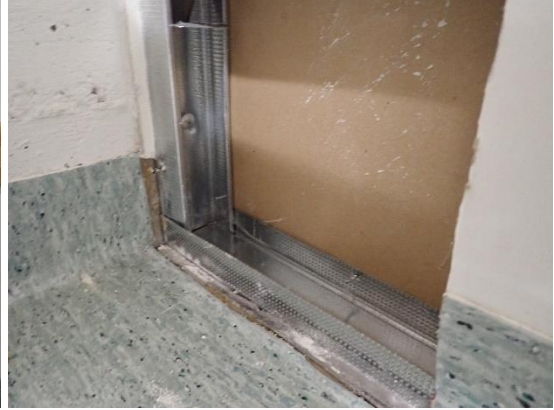
Kuvat 103 ja 104. Rakenneavaus R12 pukuhuoneen 123 ja suihkuhuoneen 126 välisessä seinässä. Avauskohta oli siisti eikä siinä havaittu aistinvaraisesti viitteitä vaurioista.
