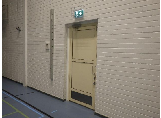
Kuvat 52 ja 53. Terveystilojen työskentelytiloissa ja liikuntasalissa ulkoseinien sisäpinnat ovat maalattua tiiltä. Seinäpinoilla ei havaittu viitteitä kosteuden aiheuttamista vaurioista.
