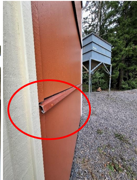
Kuvat 48 ja 49. Laudoitettu julkisivu tuulettuu seinän alaosan ilmaraon kautta. Vaneriverhotuilla osuuksilla julkisivu tuulettuu vanerilevyjen alareunassa olevien tuuletusrakojen kautta. Länsipäädyssä vaneriverhotun julkisivun pellityksessä havaittiin yksittäinen mekaaninen vaurio (ympyröity).
