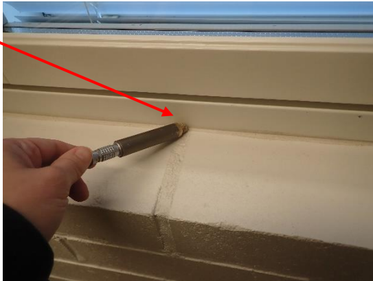
Kuvat 31 ja 32. Vuotokohtia havaittiin ikkunan ja ulkoseinän liittymistä, ikkunan nurkka-alueilta sekä sisäkuoren tiilimuurauksen saumojen kohdilta.
