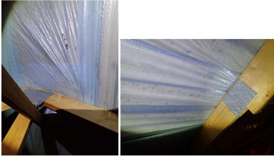
Kuvat 124 ja 125. Vesikaton puuosissa tai eristeenä olevassa puhallusvillassa ei havaittu puutteita tai merkkejä katteen vesivuodoista. Yläpohjassa kulkevat ilmanvaihtokanavat on lämpöeristetty mineraalivillalla. Yläpohja tuulettuu räystäällä olevien rakojen kautta.
