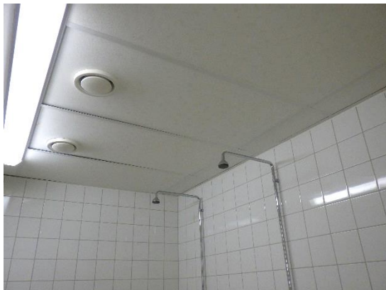
Kuvat 138 ja 139. Keskiosan pesutilojen ja pukuhuoneitten sisäkatot ovat listoille asennettua akustiikkalevyä. Levyissä havaittiin kosteusjälkiä ja sisäilman runsaan kosteuden aiheuttamia pintamuutoksia.
