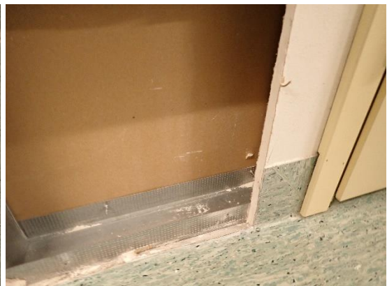
Kuvat 105, 106, 107 ja 108. Rakenneavaus R13 pukuhuoneen 127 ja wc:n 128 välisessä seinässä. Avauskohta oli siisti eikä siinä havaittu aistinvaraisesti viitteitä vaurioista.
