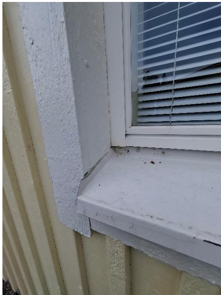
Kuvat 50 ja 51. Ikkunoiden alle ja haalausovien yhteyteen asennettujen vesi- ja kynnyspeltien kallistus on riittävä, eikä peltien reunoilla havaittu merkittäviä epätiiveysalueita.
