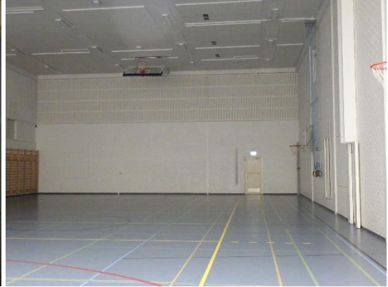
Kuvat 134 ja 135. Liikuntasalin sisäkattoon on asennettu akustiikkalevytystä. Levyt ovat ehjiä ja niiden saumat peitetty listoilla.
