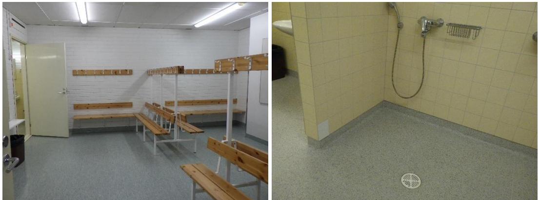
Kuvat 20 ja 21. Pukuhuoneissa lattiaan asennetun muovimaton reuna on nostettu viereiselle seinäpinnalle. Pesutilojen lattiaan on asennettu kostean tilan muovimatto hitsatuin saumoin.
