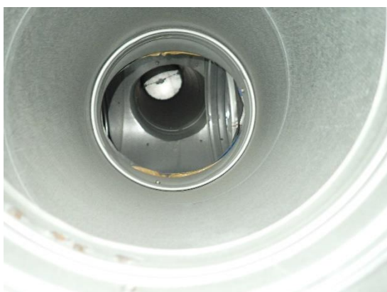
Kuvat 161 ja 162. Yleiskuvat tuloilmakanavasta (vasen kuva) ja poistoilmakanavasta (oikea kuva). Tuloilmakanava on lähes puhdas ja poistoilmakanavassa on hieman pölyyntymistä.
