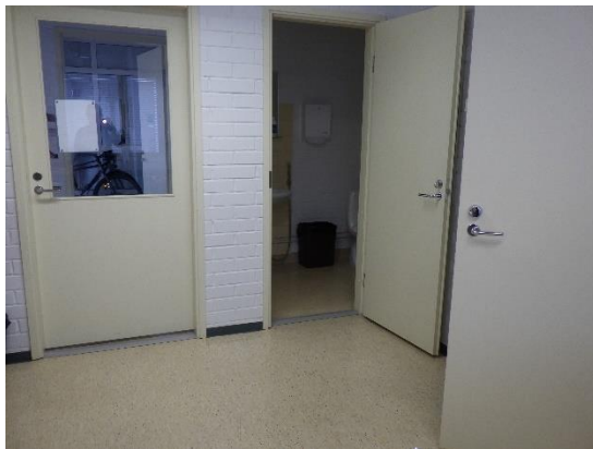
Kuvat 89 ja 90. Väliseinät ovat pääasiassa maalattuja tiiliväliseiniä.
