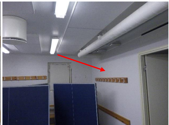
Kuvat 91 ja 92. Pukuhuoneitten kohdalla olevat väliseinät ovat rakennuksen keskiosalla maalattua tiiltä ja itäreunan väestönsuojatilojen kohdalla kipsilevyä (nuoli).
