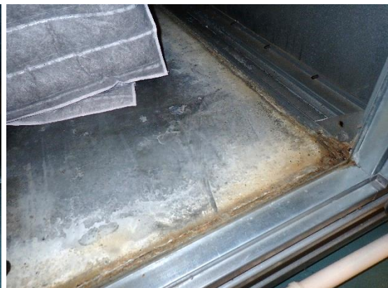
Kuvat 141 ja 142. Yleiskuvat ulkoilmakammion alta ja tuloilman suodatinosasta. Ulkoilmakammio on varustettu viemäröinnillä, mutta lattialla on vanhoja vuotojälkiä. Suodatin osan pohjalla on laajalti vanhoja vuotojälkiä ja hitsausseamat ovat alkaneet ruostumaan.
