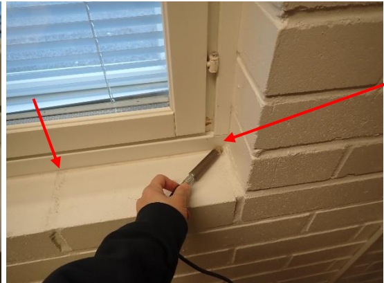
Kuvat 31 ja 32. Vuotokohtia havaittiin ikkunan ja ulkoseinän liittymistä, ikkunan nurkka-alueilta sekä sisäkuoren tiilimuurauksen saumojen kohdilta.
