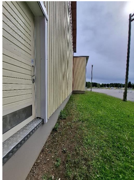
Kuvat 50 ja 51. Ikkunoiden alle ja haalausovien yhteyteen asennettujen vesi- ja kynnyspeltien kallistus on riittävä, eikä peltien reunoilla havaittu merkittäviä epätiiveysalueita.
