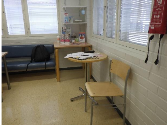
Kuvat 52 ja 53. Terveystilojen työskentelytiloissa ja liikuntasalissa ulkoseinien sisäpinnat ovat maalattua tiiltä. Seinäpinoilla ei havaittu viitteitä kosteuden aiheuttamista vaurioista.
