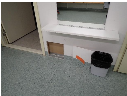
Kuvat 101 ja 102. Rakenneavaus R11 pukuhuoneen 123 ja pesuhuoneen 125 välisessä seinässä. Avauskohta oli siisti eikä siinä havaittu aistinvaraisesti viitteitä vaurioista.
