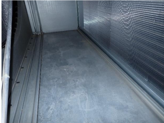
Kuvat 143 ja 144. Yleiskuvat lto:n ja lämmityspatterin välisestä osasta ja tuloilmapuhaltimesta. Lto:n ja lämmityspatterin välissä ei havaittu merkkejä kerääntyneestä kosteudesta ja tuloilmapuhallin oli siistikuntoinen.
