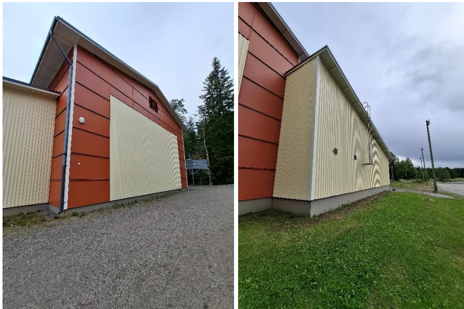
Kuvat 44 ja 45. Rakennuksen ulkoverhous on laudoitettu tai verhottu vanerilevyin.
