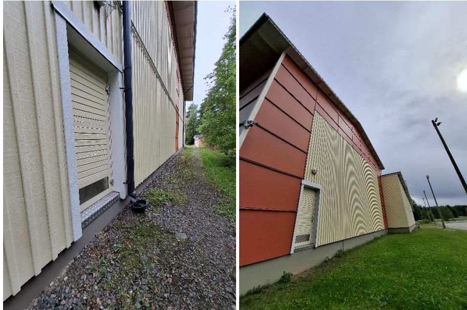
Kuvat 85 ja 86. Rakennuksen huolto-ovet ovat puupaneloituja. Ovien yhteydessä ei havaittu puutteita.
