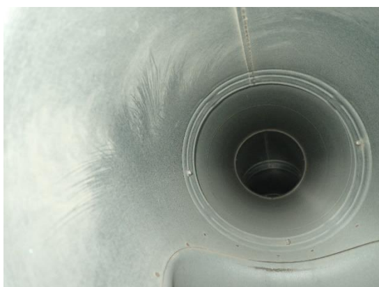
Kuvat 161 ja 162. Yleiskuvat tuloilmakanavasta (vasen kuva) ja poistoilmakanavasta (oikea kuva). Tuloilmakanava on lähes puhdas ja poistoilmakanavassa on hieman pölyyntymistä.
