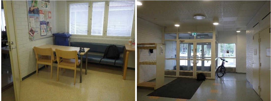
Kuvat 18 ja 19. Terveystietäjän odotustilan ja aulan lattioihin on asennettu muovimatto. Jalkalistoina on käytetty liimaamalla kiinnitettyä muovilistaa.
