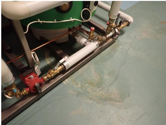
Kuvat 75 ja 76. Vesisäiliön alle vuotanut hiukan vettä. Ympäristössä ei havaittu pintakosteuskartoituksessa poikkeavia lukemia. Välipohjan läpivientien kohdalla mattoa uusittu osittain.
