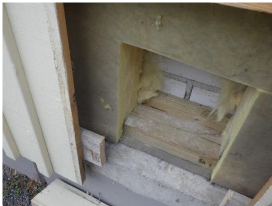
Kuvat 58 ja 59. Rakenneavaus R1 terveydenhoitajan työhuoneen 132 kohdalla. Ulkoverhouslautojen taustoissa havaittiin kosteusjälkiä ja värimuutoksia. Verhouslautojen kosteus oli kosteusjälkien alueella korkeampi kuin lautojen ylemmissä osissa, ja laudat olivat selvästi pehmenneitä muutosalueen kohdalta.
