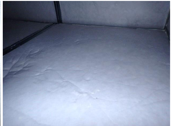
Kuvat 145 ja 146. Yleiskuvat äänenvaimennuskaseteista ja äänenvaimennetusta kammio-osasta. Äänenvaimennusmateriaalit olivat hyväkuntoiset ja mahdollisesti uusitut koneeseen (poistopuolella eri materiaalia). Silmämääräisen arvion perusteella äänenvaimennusmateriaali on polyesterikuitu.
