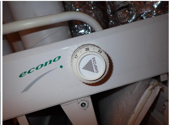
Kuvat 153 ja 154. Yleiskuvat lämmityspatterista ja lämmönsäätimestä. Patteri on hieman likainen ja lämmitystehoa säädetään käsitermostaatilla.
