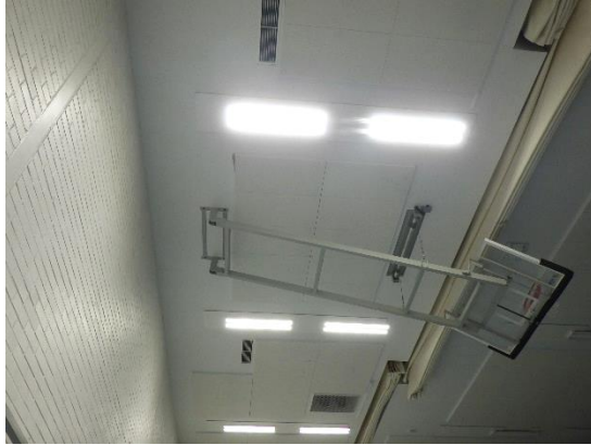
Kuvat 134 ja 135. Liikuntasalin sisäkattoon on asennettu akustiikkalevytystä. Levyt ovat ehjiä ja niiden saumat peitetty listoilla.
