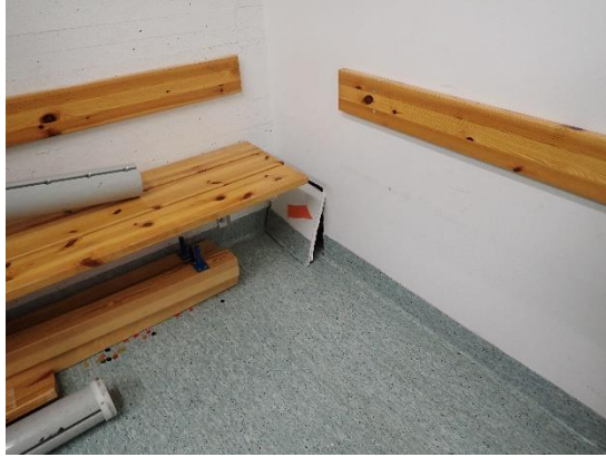
Kuvat 103 ja 104. Rakenneavaus R12 pukuhuoneen 123 ja suihkuhuoneen 126 välisessä seinässä. Avauskohta oli siisti eikä siinä havaittu aistinvaraisesti viitteitä vaurioista.
