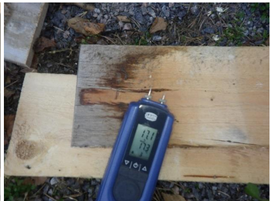
Kuvat 58 ja 59. Rakenneavaus R1 terveydenhoitajan työhuoneen 132 kohdalla. Ulkoverhouslautojen taustoissa havaittiin kosteusjälkiä ja värimuutoksia. Verhouslautojen kosteus oli kosteusjälkien alueella korkeampi kuin lautojen ylemmissä osissa, ja laudat olivat selvästi pehmenneitä muutosalueen kohdalta.
