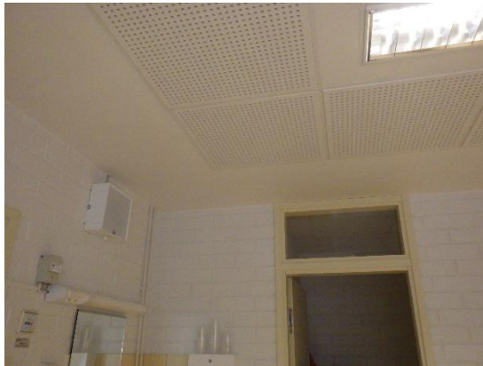
Kuvat 130 ja 131. Huonetilojen ja käytävien sisäkatot ovat kipsilevyä. Osa kattopinnoista on toteutettu akustiikkakipsilevyillä.
