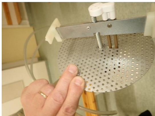
Kuvat 157 ja 158. Yleiskuvat tuloilmahajottajasta ja sen mittaus-/säätöosasta.
