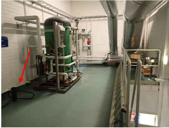
Kuvat 73 ja 74. IV-konehuoneen yleisilme on siisti. Konehuoneessa olevan lämminvesisäiliön alla lattia kastuu vuotovedestä. Laitteelta tulevan viemäroinnin kallistus on puutteellinen (nuoli).
