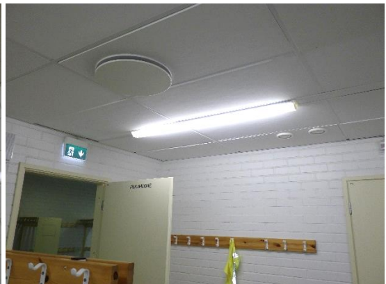
Kuvat 138 ja 139. Keskiosan pesutilojen ja pukuhuoneitten sisäkatot ovat listoille asennettua akustiikkalevyä. Levyissä havaittiin kosteusjälkiä ja sisäilman runsaan kosteuden aiheuttamia pintamuutoksia.
