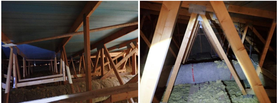
Kuvat 122 ja 123. Vesikaton puuosissa tai eristeenä olevassa puhallusvillassa ei havaittu puutteita tai merkkejä katteen vesivuodoista. Yläpohjassa kulkevat ilmanvaihtokanavat on lämpöeristetty mineraalivillalla. Yläpohja tuulettuu räystäällä olevien rakojen kautta.
