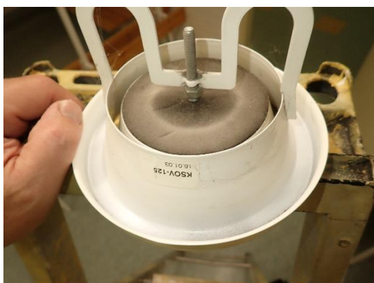
Kuvat 159 ja 160. Yleiskuvat poistoilmaventtiileistä. Venttiileissä on tiiviste renkaat, mutta se jäi kuvan ottamisessa asennuskaulukseen.
