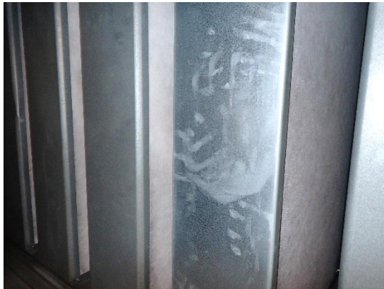
Kuvat 145 ja 146. Yleiskuvat äänenvaimennuskaseteista ja äänenvaimennetusta kammio-osasta. Äänenvaimennusmateriaalit olivat hyväkuntoiset ja mahdollisesti uusitut koneeseen (poistopuolella eri materiaalia). Silmämääräisen arvion perusteella äänenvaimennusmateriaali on polyesterikuitu.
