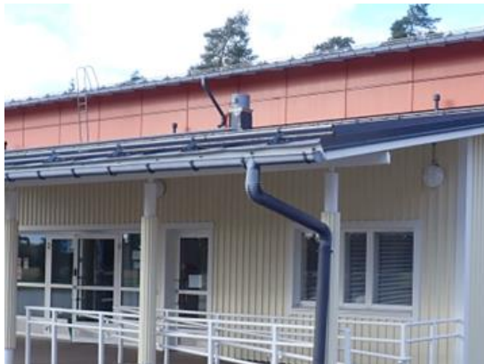
Kuvat 155 ja 156. Huippuimuri sijaitsee rakennuksen matalan osan vesikatolla. Silmämääräisen arvioon perusteella se on samalta vuodelta ilmanvaihtokoneen kanssa (2002).
