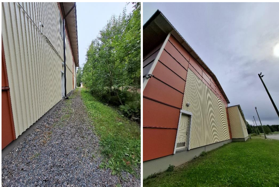
Kuvat 46 ja 47. Rakennuksen ulkoverhous on laudoitettu tai verhottu vanerilevyin.
