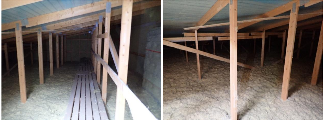
Kuvat 120 ja 121. Yläpohjaan on asennettu pitkittäin kulkevat kulkusillat. Yläpohjatilassa ei havaittu merkkejä katteen vesivuodoista tai puutteellisesta tuuletuksesta. Yläpohjan eristeenä on käytetty puhallusvillaa.
