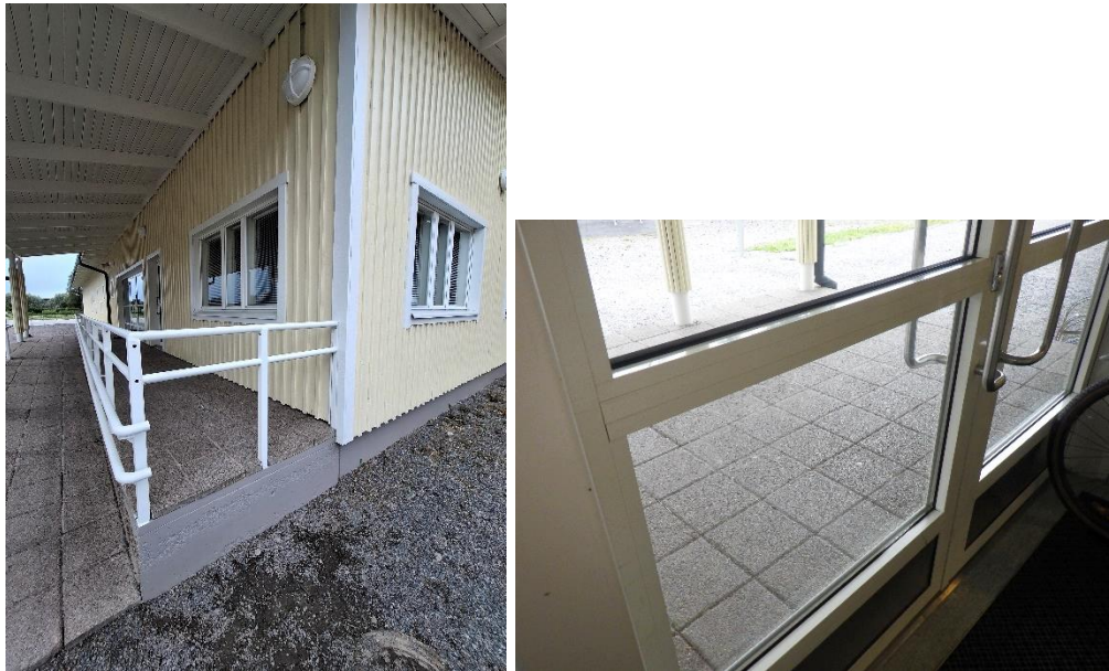
Kuvat 83 ja 84. Pääsisäänkäynnin yhteydessä olevien metallisten ulko-ovien yhteydessä ei havaittu merkittäviä puutteita.
