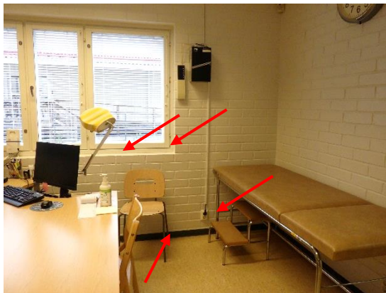
Kuvat 56 ja 57. Merkkisavutarkastelussa tiiliverhottujen ulkoseinien liittymissä ja seiniin asennettujen pistorasioitten reunoilla havaittiin ilmavirtausta rakenteesta huonetilojen suuntaan.
