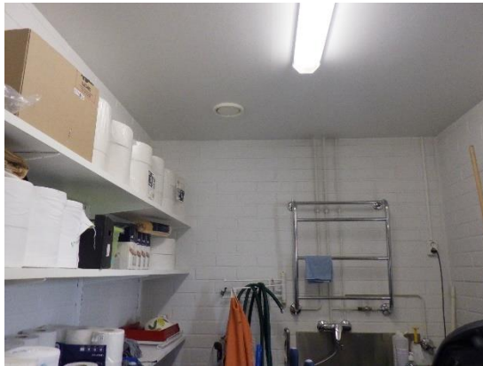
Kuvat 132 ja 133. Siivouskeskuksen sisäkatto on kipsilevyä. Opettajien pukuhuoneessa katon keskiosa on toteutettu akustiikkakipsilevyillä.
