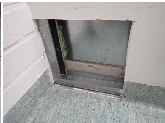
Kuvat 93, 94, 95 ja 96. Pukuhuonetilan 110 hormin avaus, R9. Hormi on siisti, pinnoilla ei havaittu viitteitä vaurioista.
