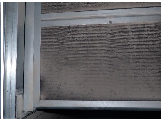
Kuvat 147 ja 148. Yleiskuvat poistoilmapuhaltimesta ja poistopuolen äänenvaimennuskaseteista. Puhallin oli hieman pölyyntynyt ja äänenvaimentimet olivat keränneet pölyä pinnoille. Silmämääräisen arvion perusteella äänenvaimennusmateriaali on kangaspinnoitettu mineraalivilla.
