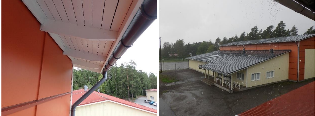
Kuvat 116 ja 117. Räystäskouruissa, syöksytorvissa tai räystäslaudoituksissa ei havaittu puutteita. Yläpohjatilat tuulettuvat räystäslautojen raoista. Sadevesi poistuu katteilta maanalaiseen sadevesijärjestelmään.
