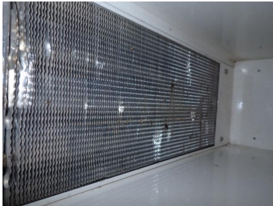
Kuvat 153 ja 154. Yleiskuvat lämmityspatterista ja lämmönsäätimestä. Patteri on hieman likainen ja lämmitystehoa säädetään käsitermostaatilla.
