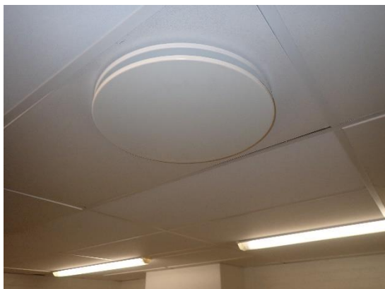
Kuvat 157 ja 158. Yleiskuvat tuloilmahajottajasta ja sen mittaus-/säätöosasta.
