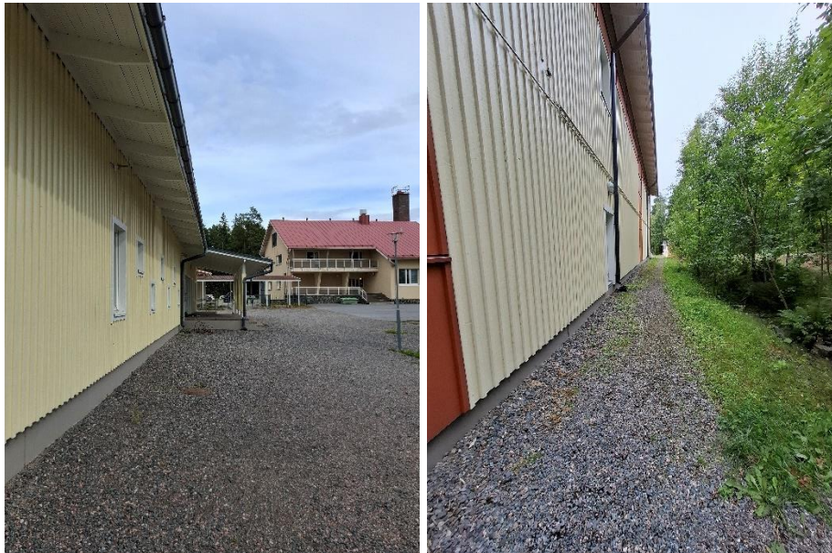
Kuvat 7 ja 8. Sorastettu vierusmaa kallistaa pintavedet kauemmas rakennuksesta. Sokkelipinnoilla ei havaittu merkkejä kastumisesta tai runsaan kosteuden aiheuttamista vaurioista.
