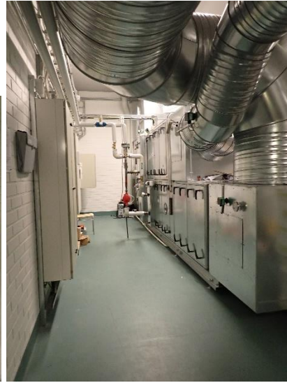
Kuvat 73 ja 74. IV-konehuoneen yleisilme on siisti. Konehuoneessa olevan lämminvesisäiliön alla lattia kastuu vuotovedestä. Laitteelta tulevan viemäroinnin kallistus on puutteellinen (nuoli).
