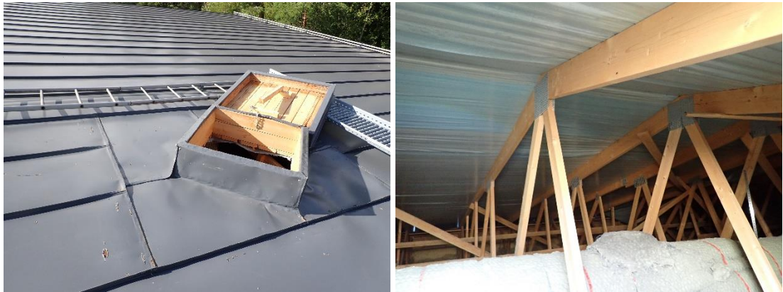
Kuvat 126 ja 127. Ylemmällä kattotasolla on kaksi huoltoluukku, joista molemmista tarkasteltiin yläpohjan kuntoa. Kummastakaan kohdasta vesikaton alusrakenteissa ei havaittu merkittäviä puutteita tai jälkiä katteen vesivuodoista.
