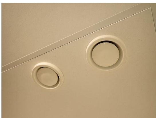
Kuvat 159 ja 160. Yleiskuvat poistoilmaventtiileistä. Venttiileissä on tiiviste renkaat, mutta se jäi kuvan ottamisessa asennuskaulukseen.
