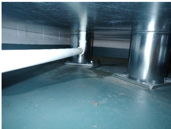
Kuvat 141 ja 142. Yleiskuvat ulkoilmakammion alta ja tuloilman suodatinosasta. Ulkoilmakammio on varustettu viemäröinnillä, mutta lattialla on vanhoja vuotojälkiä. Suodatin osan pohjalla on laajalti vanhoja vuotojälkiä ja hitsausseamat ovat alkaneet ruostumaan.
