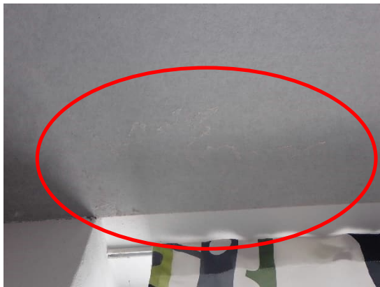
Kuvat 128 ja 129. Ruokalan ja sen yhteyteen rakennetun iltapäiväkerhon tilan kattojen akustiikkalevyissä havaittiin runsaasti kosteusjälkiä ulko- ja väliseinälinjoilla.
