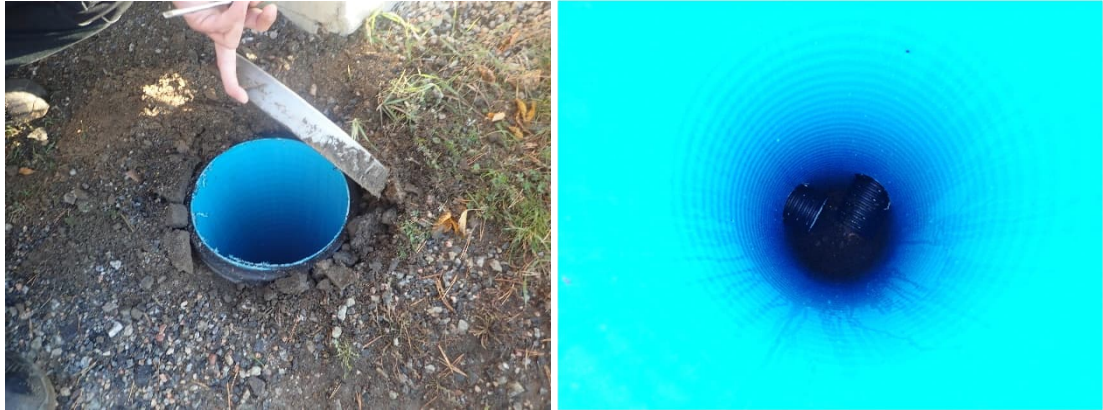
Kuvat 12 ja 13. A-osan lounaiskulman salaojakaivon pohjalla oli hieman sepeliä. Kaivossa ei ollut vettä. B-osan eteläpuolelta avattiin kaksi salaojakaivoa, joiden kummankin pohjalla oli niin paljon sepeliä, että salaojaputket olivat peitossa.
