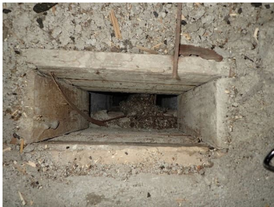
Kuva 347 ja 348. A-osan ison vinttitilan yläpohjan katkaistu hormi, josta virtasi ilmaa vinttiin ja yläpohjan läpiviennit, joiden kautta ilmaa virtasi pois päin vintistä alakerran huonetilojen suuntaan.
