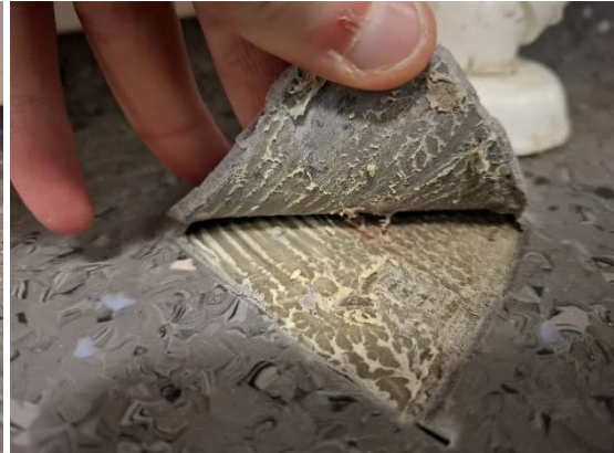
Kuvat 55 ja 56. Ruokalan käytävän viiltomittaukset MP1 ja MP2. Mittapisteessä MP1 havaittiin mikrobiperäistä hajua ja poikkeavaa kemiallista hajua. Mittapisteessä MP2 liima oli nestemäistä ja muovimaton alla havaittiin hieman poikkeavaa kemiallista hajua.
