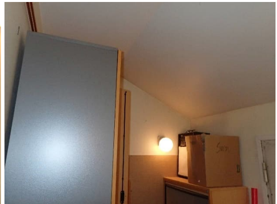
Kuva 362 ja 363. Puurunkoisten yläpohjien sisäkatot ovat havaintojen mukaan pääosin kipsilevyä, mutta lisäksi havaittiin joissain tiloissa kuitusementtilevyä, joka saattaa sisältää asbestia (kuten oikeanpuoleisen kuvan A-osan tila 224).
