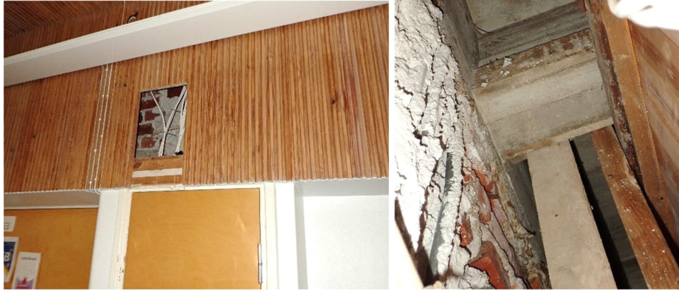
Kuvat 307 ja 308. Avaus R46 tehtiin käytävän 306 väliseinällä olevaan koteloointiin. Koteloinnin yläosa rajautuu yläpohjaan, jossa oli paikallaan muottilaudat.
