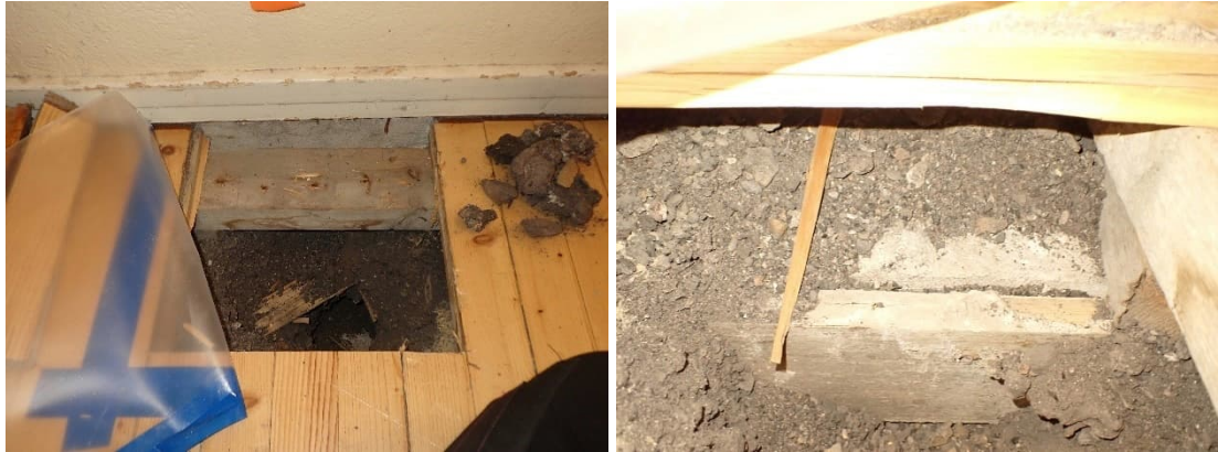
Kuvat 150 ja 151. Liikuntasalin eteisen 142 lattian avaus R18. Kohdassa oli muista avauksista poiketen eristeenä koksinkuonaa.
