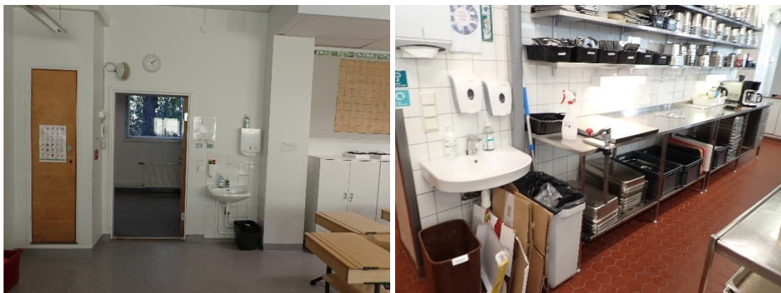
Kuvat 271 ja 272. Luokkahuoneen väliseinää, joka on pääosin rapattua ja maalattua, laatoitusta on käsiensuualtaan takana. Keittiön laatoitettu kiviaineinen väliseinä.
