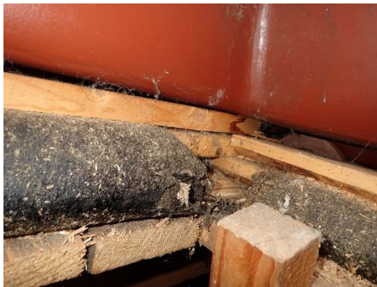
Kuvat 323 ja 324. B-osan korkean vesikaton alusrakenteita ja yläpohjan eristeenä kevytbetonia.
