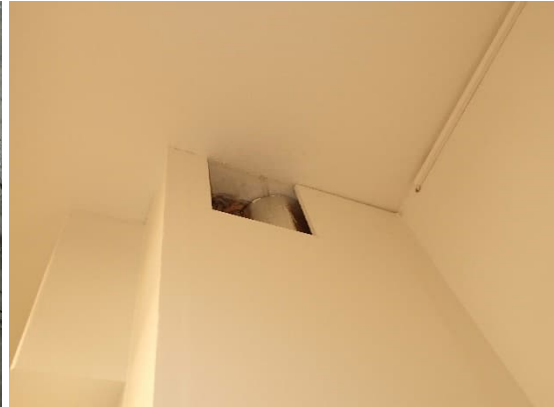
Kuvat 170 ja 171. Kirjastosalin 102 toisen koteloinnin avauksessa R27 ilmaa virtasi kirjaston suuntaan sekä lattian että katon läpivienneistä, joissa oli mineraalivillatilkettä.
