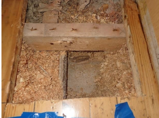
Kuva 34. Teknisentyön luokan puurakenteinen lattia betonilaatan päällä, avaus R2.
