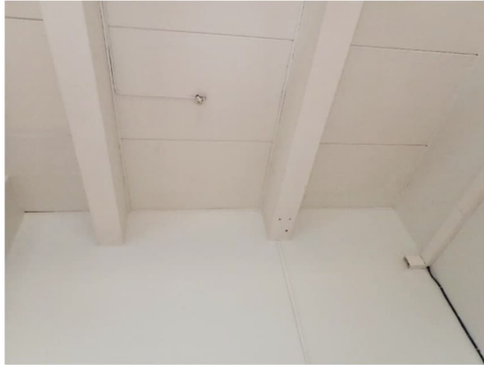
Kuva 360 ja 361. Osassa luokkatiloista on näkyvillä yläpohjan palkit, joiden välissä on alkuperäinen puukuitulevytytys. Uusitut akustiikkamineraalivilla-alakatot on asennettu palkkien alapuolelle, oikeanpuoleinen kuva.
