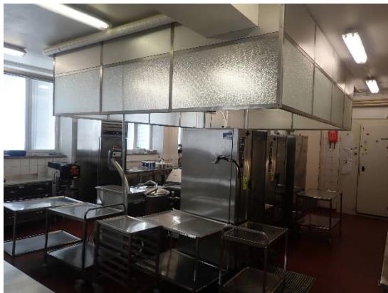
Kuvat 413 ja 414. Keittiön ruuanvalmistuspisteen huuva ja rasvasuodatin.
