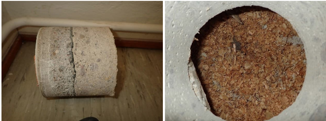
Kuvat 101 ja 102. Kirjastosalin välipohja, avaus R25.
