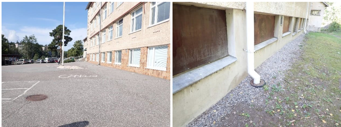
Kuvat 2 ja 3. Etupihan puolella rakennuksen vierusta on pääosin asfalttia, muutoin pääosin nurmea. Takapihalla rakennuksen vierustalla on osin nurmettunut sorakaista.
