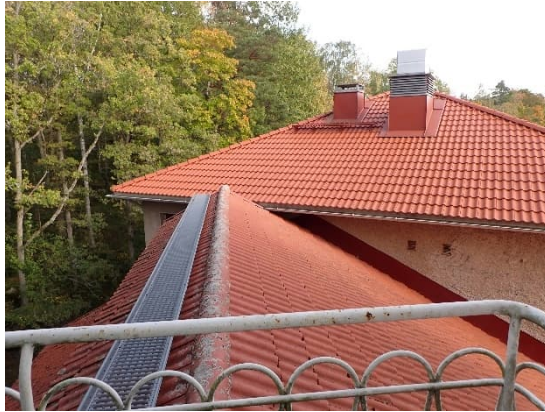
Kuva 335 ja 336. B-osan matalan osan tiilikatteella oli jonkin verran sammalta.
