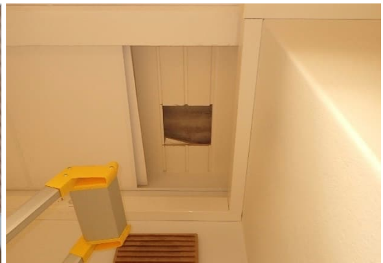
Kuvat 122 ja 123. Alkuperäistä sormipaneelialakattoa käytävällä. Oikeanpuoleisessa kuvassa uusi akustiikka-alakatto, jonka yläpuolella on alkuperäinen paneelikatto palkkien välissä.
