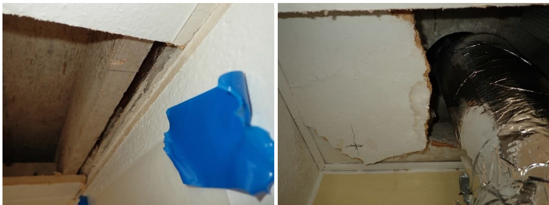
Kuva 369 ja 370. B-osan luokahuoneen 302 (35) yläpohjaan rajautuvan alakaton ja koteloinnin avaukset R47 ja R48. Alakaton takana ei havaittu merkkejä vuodoista, koteloinnin läpiviennin kohdalla havaitut kosteusjäljet olivat todennäköisesti peräisin timanttiorauksesta.
