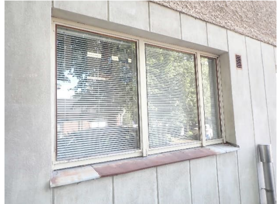
Kuvat 256 ja 257. Eteläisivun uusimattomien ikkunoiden maalipinnat ovat huonossa kunnossa ja länsipäädyn ikkuna vesipelti on ruosteessa.
