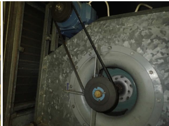
Kuvat 379 ja 380. Keittiötä ja ruokasalia palveleva ilmanvaihtokone TK1 sijaitsee teknisessä tilassa katonrajassa. Puhallin on kiilahihnavetoinen.
