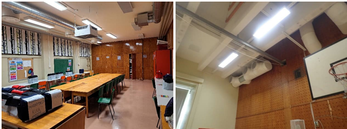
Kuvat 407 ja 408. Voimistelusalisiiiven ilmanvaihtokanavat on osittain uusittu vuonna 2003.
