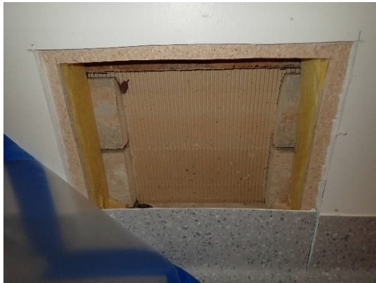
Kuvat 194 ja 195. Toisen kerroksen puurakenteinen sivuvinttiin rajautuva ulkoseinä, avaus R40.
