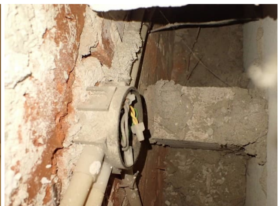
Kuvat 312 ja 313. Ensimmäisen kerroksen käytävän kiviaineinen kotelointi, jonka sisällä oli sähköjohtoja, avaus R24. Koteloinnin pohjalla oli runsaasti kiviaineista rakennusjätettä.
