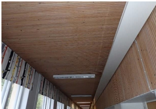
Kuvat 122 ja 123. Alkuperäistä sormipaneelialakattoa käytävällä. Oikeanpuoleisessa kuvassa uusi akustiikka-alakatto, jonka yläpuolella on alkuperäinen paneelikatto palkkien välissä.
