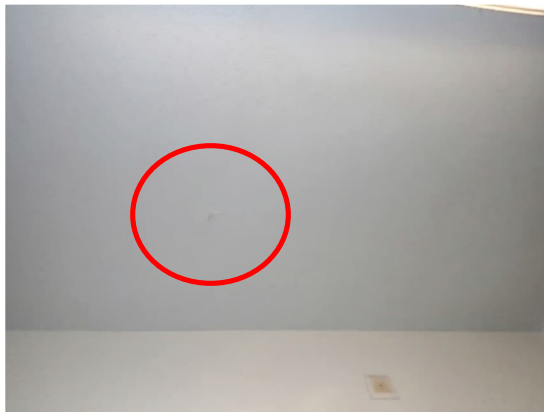
Kuvat 126 ja 127. Keittiön katon kupruava tasoite- ja maalipinta sekä keittiön takana olevan kellarin käytävän kattoa, jossa todettiin laajemmin maali- ja tasoitepinnan epätasaisuutta.
