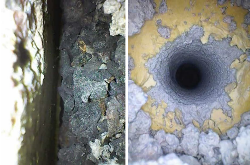
Kuvat 109 ja 110. Luokan 13 (119) välipohja, poraus P21, eristeenä koksinkuona. Luokan 21 (205) välipohja, poraus P19, eristeenä kevytbetoni.
