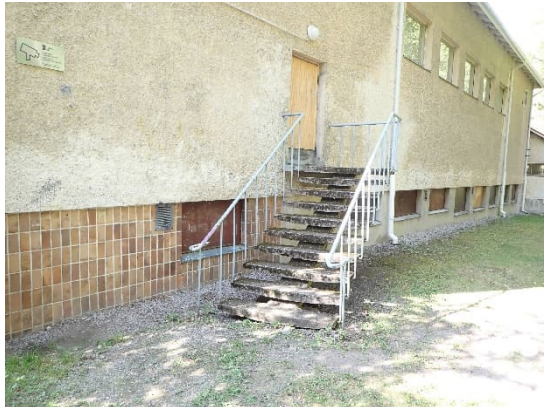
Kuvat 19 ja 20. C-osan takapihan betoniportaissa havaittiin halkeamia ja betonin rapautumista.
