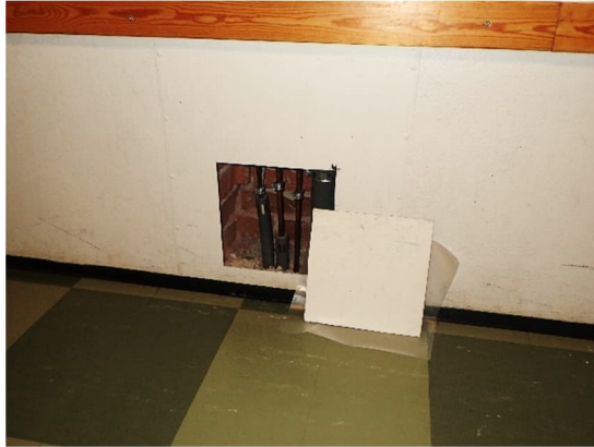
Kuvat 74 ja 75. Ruokalan väliseinässä olevan hormin pellityksen avaus R9. Alapohjaan / putkikanaaliin vievät läpiviennit ovat epätiivitä ja läpivienneissä on tilkkeenä mineraalivillaa.
