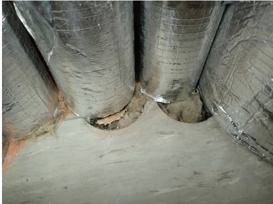
Kuvat 170 ja 171. Kirjastosalin 102 toisen koteloinnin avauksessa R27 ilmaa virtasi kirjaston suuntaan sekä lattian että katon läpivienneistä, joissa oli mineraalivillatilkettä.
