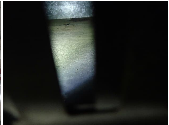
Kuvat 409 ja 410. Ruokalan tuloilmakanavassa havaittiin runsaasti karkeaa pölyä.
