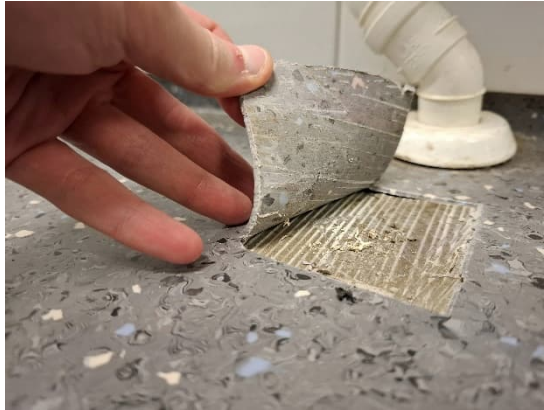
Kuvat 55 ja 56. Ruokalan käytävän viiltomittaukset MP1 ja MP2. Mittapisteessä MP1 havaittiin mikrobiperäistä hajua ja poikkeavaa kemiallista hajua. Mittapisteessä MP2 liima oli nestemäistä ja muovimaton alla havaittiin hieman poikkeavaa kemiallista hajua.
