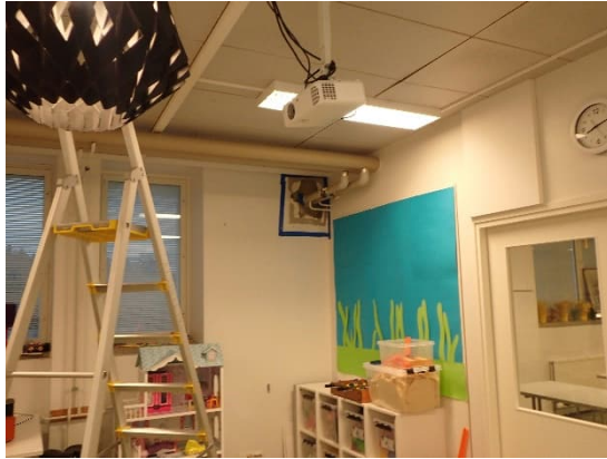
Kuvat 245 ja 246. Iltapäiväkerhon ulkoseinällä olevan hormin pellityksen avaus R8. Hormin läpiviennit oli tilkitty mineraalivillalla ja hormin takaseinässä oli pikisively. Hormista virtaava ilma haisi PAH-yhdisteille.
