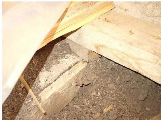
Kuvat 112 ja 113. Liikuntasalin lattian avaus R19, välipohjan eristeenä kutterinlastu, ja salin takaetisen avaus R18, eristeenä koksinkuona.
