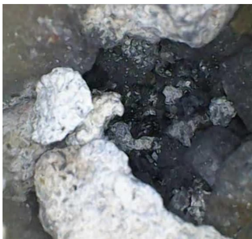
Kuvat 32 ja 33. Poikien pukuhuoneen alapohja kanaalin kohdalla ja keskemällä huonetta, poraukset P27 ja P28. Kanaalin kohdalla etisteenä on koksinkuonaa (P27) ja keskemällä kevytbetonia (P28).
