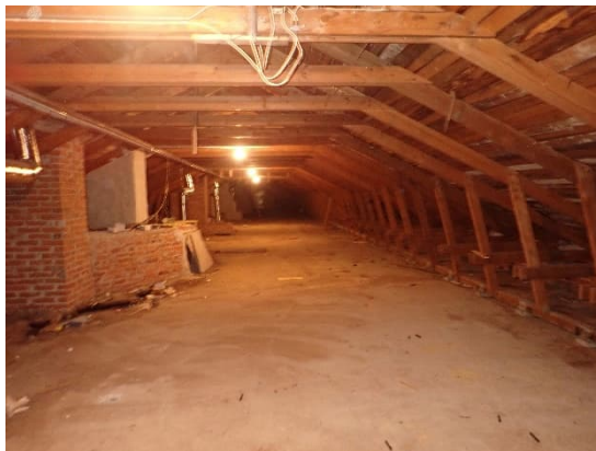
Kuva 354 ja 355. B-osan isoa vinttitilaa ja epätiivis aluskatekermin liittymä kattoluukun kohdalla.
