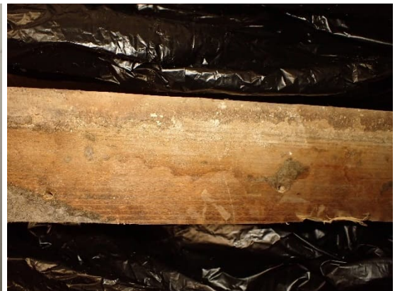
Kuvat 148 ja 149. Entisen asunnon lattiaan väliseinän viereen tehty avaus R16. Lattialaudoissa havaittiin kosteusjälkiä.
