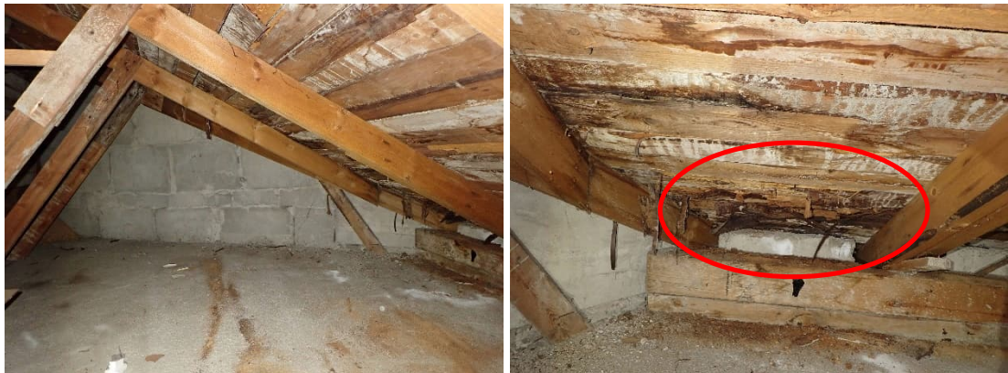
Kuva 358 ja 359. B-osa pieni sivuvintti. Vintin lattialla oli jonkin verran purua ja ulkonurkassa aiemmin kastuneita aluslautoja (ympyrä).
