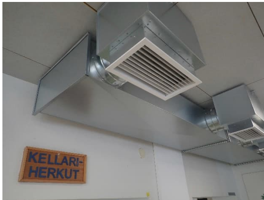
Kuvat 411 ja 412. Ruokalan poistoilmasäleikköön on kertynyt hieman pölyä.
