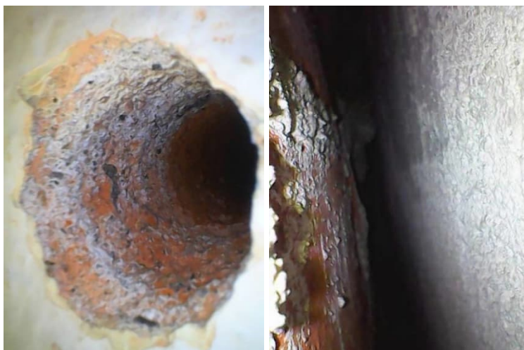
Kuvat 192 ja 193. Toisen kerroksen ulkoseinä, poraus P5. Tiilimuurauksen ja ilmavälin jälkeen kevytbetonia.
