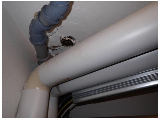
Kuvat 132 ja 133. C-osan kellarissa sijaitsevan teknistentyön luokan maalaushuoneen takahuoneen katon ja putkien kosteusjälkiä.
