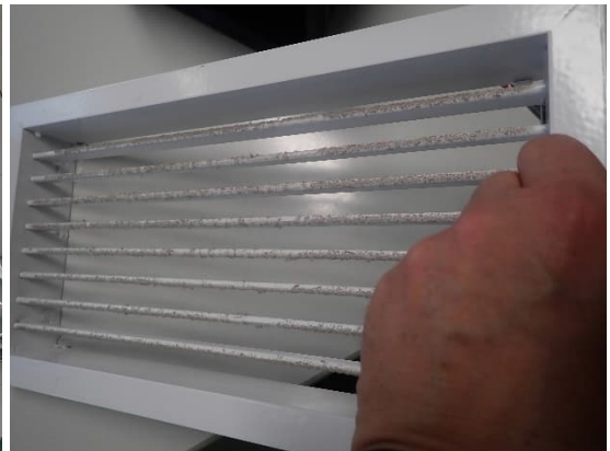
Kuvat 411 ja 412. Ruokalan poistoilmasäleikköön on kertynyt hieman pölyä.
