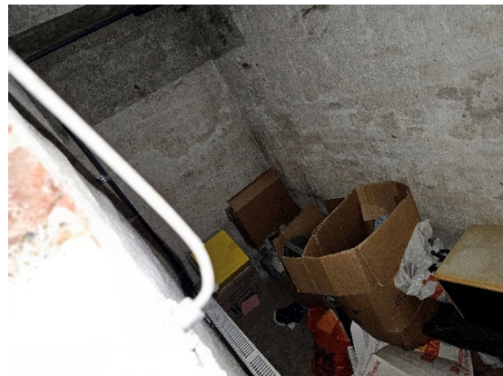
Kuvat 96 ja 97. Putkikanaalin seinässä havaittiin viemäriputkea varten tehty reikä, josta on yhteys yhteen kellaritilojen varastuhuoneeseen.
