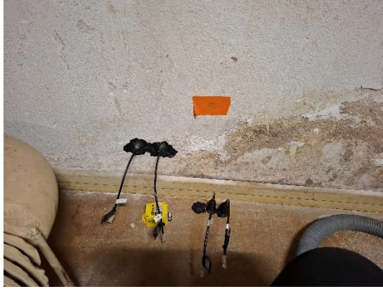
Kuva 59. Lautavaraston alapohjan kosteusmittauskohta MP13.
