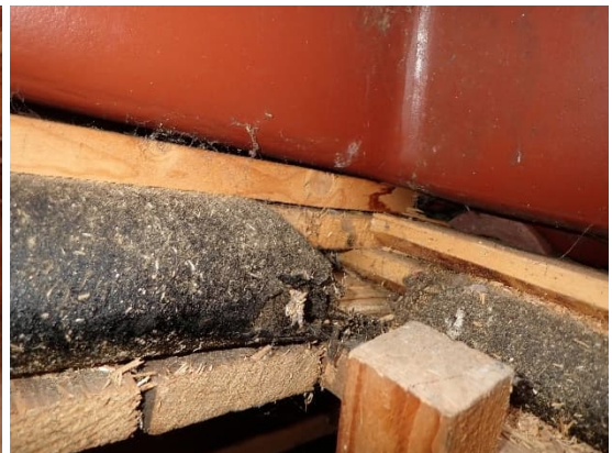
Kuva 354 ja 355. B-osan isoa vinttitilaa ja epätiivis aluskatekermin liittymä kattoluukun kohdalla.
