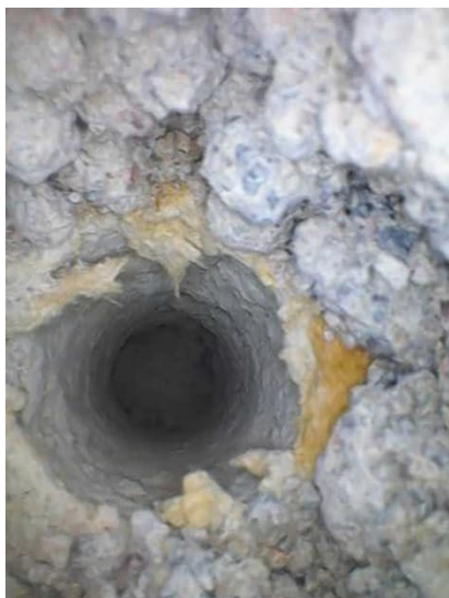
Kuva 111. Luokan 31 (305) välipohja, poraus P4, eristeenä kevytbetoni.
