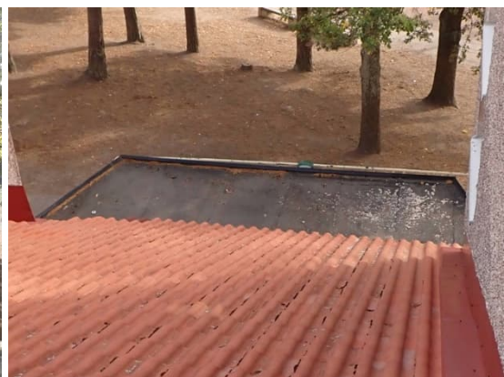
Kuva 338 ja 339. B-osan pääsisäänkäynnin katoksen päälle oli kertynyt jonkin verran roskaa ja kate oli hieman sammaloitunut.
