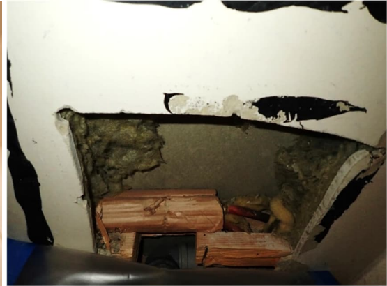
Kuvat 172 ja 173. Kirjaston taikotilan wc-tilan 111 väliseinässä oleva pelti avattiin, avaus R28. Pellin läpiviennistä virtasi ilmaa wc-tilan suuntaan. Takana oli paljasta mineraalivillaa ja rikottu kuitusementtilevy.
