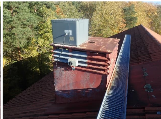
Kuva 333 ja 334. B-osan viemärin tuuletusputken yläreuna on lohkeillut. Piippujen pellitykset ovat heikkokuntoisia ja pellit ovat paikoin ruosteisia.
