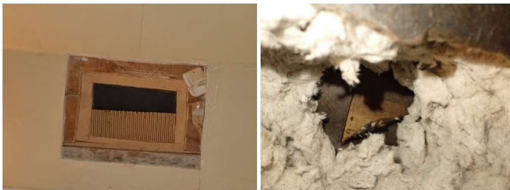
Kuvat 321 ja 322. B-osan matalan osan puurunkoinen yläpohja avauksesta R31.
