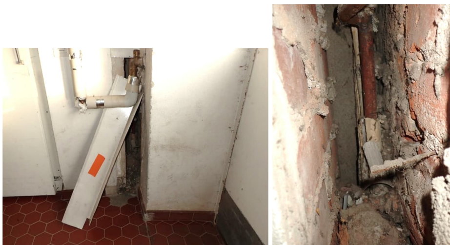
Kuvat 301 ja 302. Keittiön eteisen väliseinän pellityksen avaus R14. Takana oli tekniikkahormi, jonka taustalla näkyi kuitusementtilevyä.
