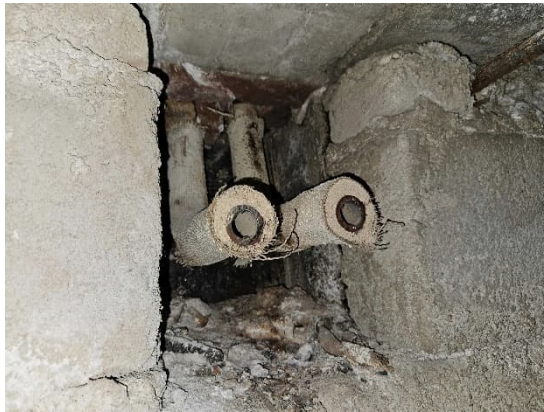
Kuvat 86 ja 87. Vanhoja katkaistuja lämpöjohtoja. Vasemmanpuoleisen kuvan putkieriste sisältää todennäköisesti asbestia.
