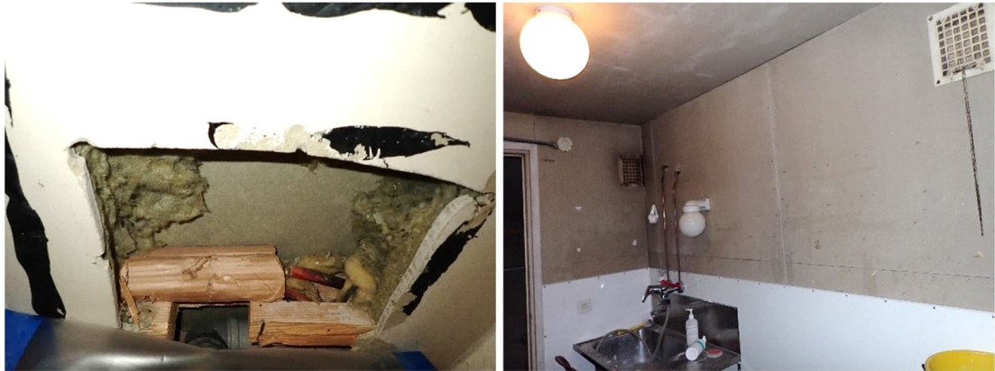
Kuvat 284 ja 285. Kuitusementtilevyseinää A-osan kirjaston henkilökunnan wc-tilassa ja tiloissa 222-223.
