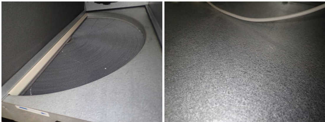
Kuvat 397 ja 398. Lämmöntalteenottokennot ja koneiden pinnat olivat melko puhtaita.
