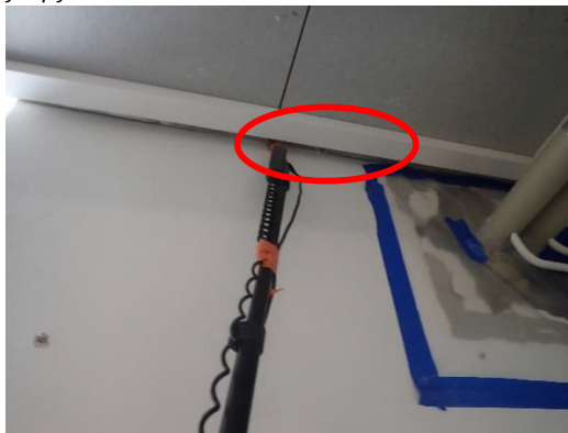
Kuvat 179 ja 180. Kellarin iltaapäiväkerhon tilan ulkoseinän ja välipohjan liittymän esimerkkipuotokohda. Kellarin kerhotilan ikkunasyvennyksen nurkkien puotokohdia.
