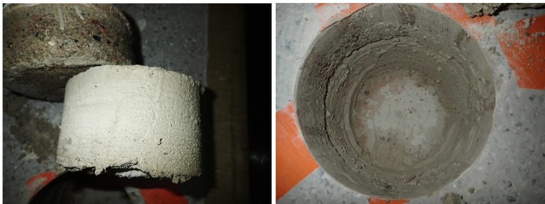
Kuvat 103 ja 104. Luokan 231 (29), avaus R44.
