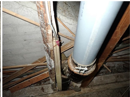
Kuva 347 ja 348. A-osan ison vinttitilan yläpohjan katkaistu hormi, josta virtasi ilmaa vinttiin ja yläpohjan läpiviennit, joiden kautta ilmaa virtasi pois päin vintistä alakerran huonetilojen suuntaan.
