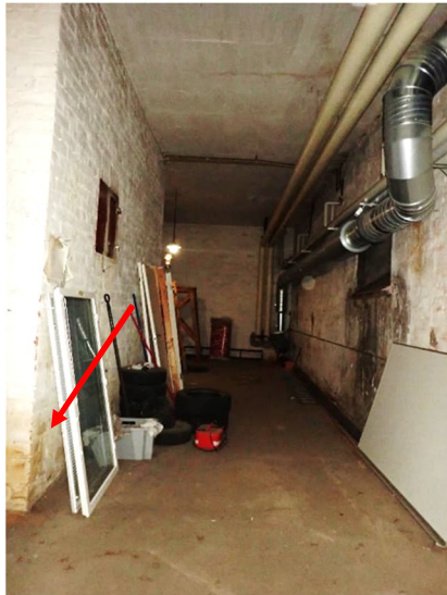
Kuvat 277 ja 278. Vanhan polttoainevaraston seinien alaosien värjäytymiä, jotka viittaavat kosteuden lisäksi mahdollisesti myös vanhoihin polttoaineisiin. Oikeanpuoleisessa kuvassa ilmanvaihtokonehuoneen kastunutta väliseinää.
