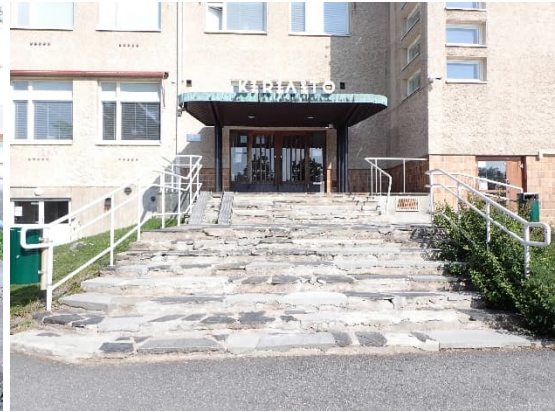
Kuvat 17 ja 18. Kirjaston takapihanpuoleisten portaiden sivussa on kosteusjälkiä ja etupihaanpuolen portaiden irronneita liuskekiviä on paikattu betonilla.
