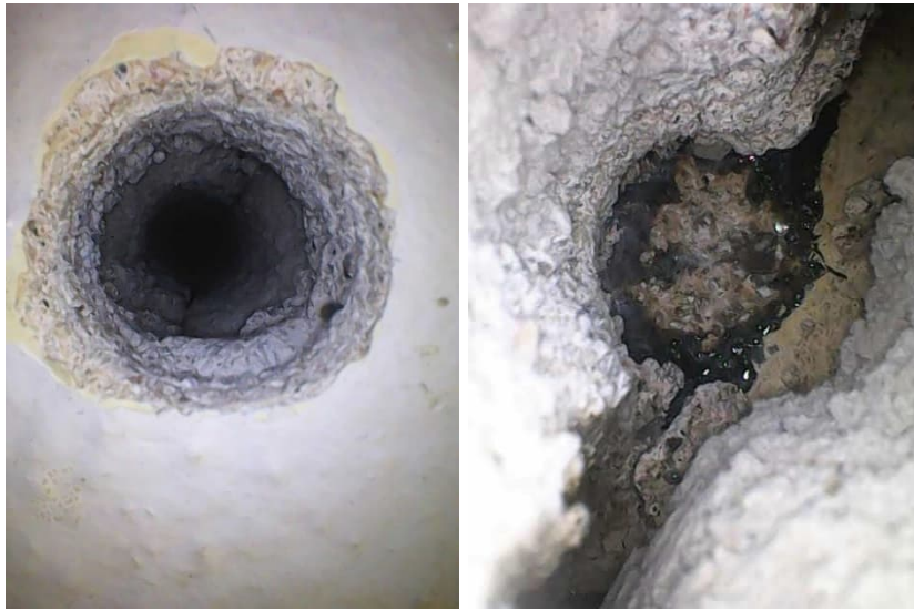
Kuvat 196 ja 197. Kellarikerroksen maanvastaisen ulkoseinän ja ulkoseinän lämmöneristeenä on kevytbetonia ja takana pikisively. Kuvat ovat maanvastaisen seinän porauksesta P12.
