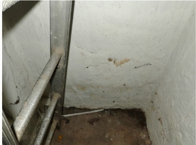
Kuvat 277 ja 278. Vanhan polttoainevaraston seinien alaosien värjäytymiä, jotka viittaavat kosteuden lisäksi mahdollisesti myös vanhoihin polttoaineisiin. Oikeanpuoleisessa kuvassa ilmanvaihtokonehuoneen kastunutta väliseinää.
