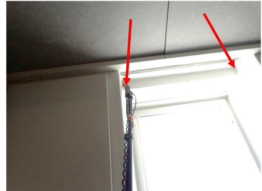
Kuvat 179 ja 180. Kellarin iltaapäiväkerhon tilan ulkoseinän ja välipohjan liittymän esimerkkipuotokohda. Kellarin kerhotilan ikkunasyvennyksen nurkkien puotokohdia.
