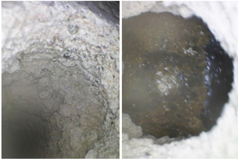
Kuvat 198 ja 199. Kellarikerroksen maanvastaisen ulkoseinän ja ulkoseinän lämmöneristeenä on kevytbetonia ja takana pikisively. Kuvat maanvastaisen seinän porauksesta P22.
