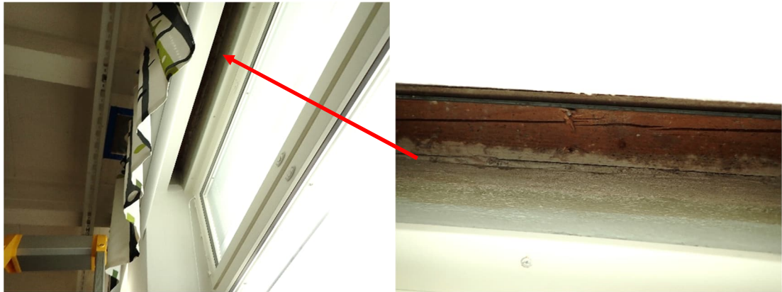
Kuvat 214 ja 215. Ikkunoiden yläpuolella on syvennykset, joiden pohjalla on lauta. Kohdassa on ollut verhokiskot.
