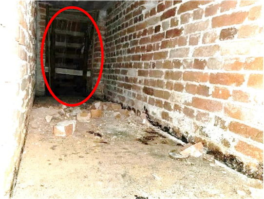
Kuvat 94 ja 95. A-osan kellaritilojen portaikkojen alla on tyhjää tilaa, jonka pohjalla on hiekkaa ja tiiliä. Molempien portaiden alla olevat vanhat muottilaudat ovat purkamatta (korostettu punaisella ympyrällä).
