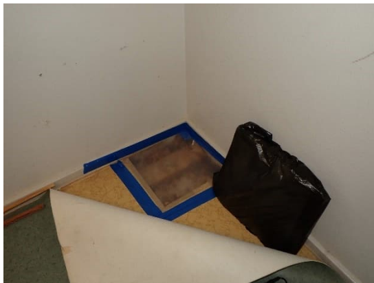
Kuvat 148 ja 149. Entisen asunnon lattiaan väliseinän viereen tehty avaus R16. Lattialaudoissa havaittiin kosteusjälkiä.
