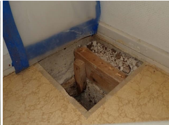
Kuvat 99 ja 100. Entisen asunnon välipohja, avaukset R16 ja R17.
