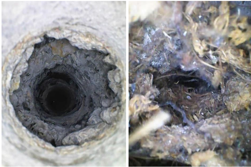
Kuvat 105 ja 106. Luokan 218 välipohjan poraus P31. Eristeenä turvetta.
