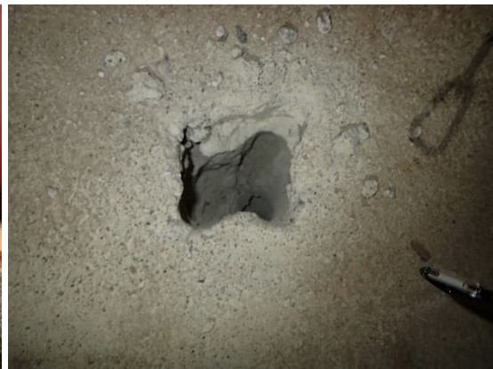
Kuvat 323 ja 324. B-osan korkean vesikaton alusrakenteita ja yläpohjan eristeenä kevytbetonia.
