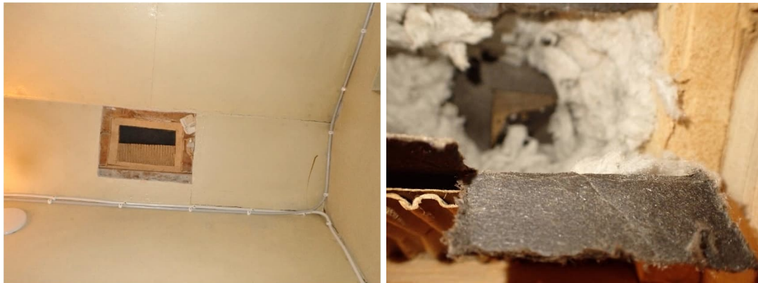
Kuva 375 ja 376. B-osan matalan osan käytävän 209 yläpohjan avaus R31. Rakenteissa oli voimakas PAH-yhdisteiden haju ja eristeen molemmin puolin oli tervapahvia.
