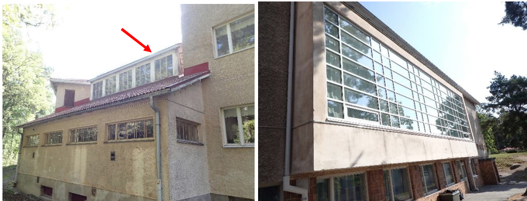
Kuvat 203 ja 204. B-osan itäpäädyssä on pienellä osalla lautaverhottua ulkoseinää (nuoli) ja liikuntasalissa erkkerin kohdalla uusittua lasiseinää.
