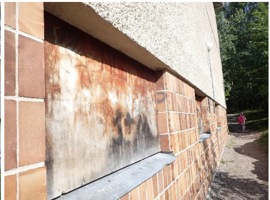
Kuvat 258 ja 259. Takapihan puolella alkuperäiset ikkunat ovat tyydyttävässä kunnossa. C-osan päädyn ja takapihan puoleisia ikkunoita on levytetty umpeen ilkeillä vuoksi.
