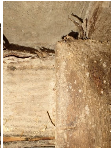
Kuvat 136 ja 137. Opettajienhuoneen 123 välipohjan avaus R22. Puurakenteissa havaittiin värimuutoksia.
