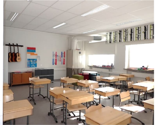
Kuva 360 ja 361. Osassa luokkatiloista on näkyvillä yläpohjan palkit, joiden välissä on alkuperäinen puukuitulevytytys. Uusitut akustiikkamineraalivilla-alakatot on asennettu palkkien alapuolelle, oikeanpuoleinen kuva.
