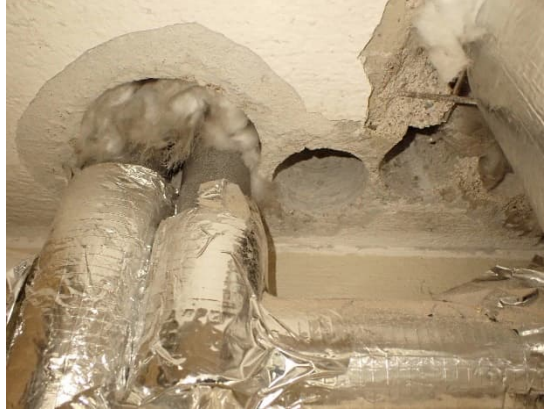
Kuvat 168 ja 169. Kirjastosalin 102 lainaustiskin vieressä olevan koteloinnin avaus R26. Yläpuolen läpiviennit olivat epätiivisiä ja niissä oli mineraalivillatilkettä.
