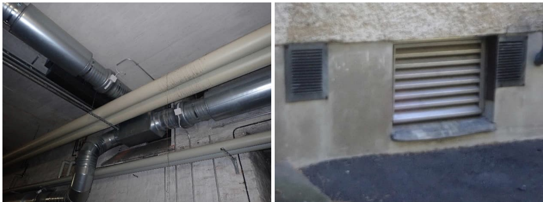
Kuvat 403 ja 404. Kanavapuhaltimet poistavat ilmaa kellarin tiloista ulkoilmaan yhteisen kammion ja ulospuhallusritilän kautta.
