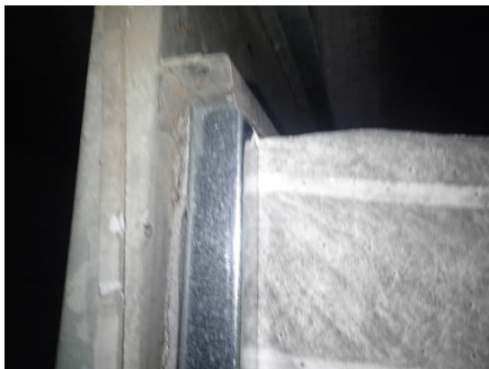
Kuvat 381 ja 382. Suodattimien kehys ei ole tiivis. Lämmityskennolle on kertynyt suodattimen ohi päässyttä epäpuhtautta.
