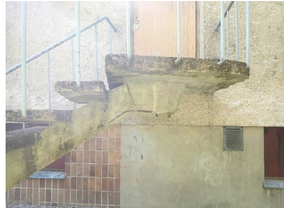
Kuvat 19 ja 20. C-osan takapihan betoniportaissa havaittiin halkeamia ja betonin rapautumista.
