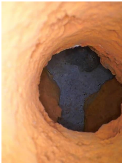
Kuva 200. Liikuntasalin ulkoseinä patterisyvennyksestä, poraus P1. Eristeenä kevytbetoni.
