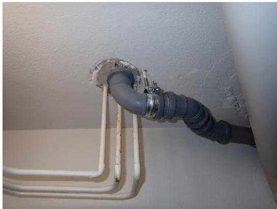
Kuvat 132 ja 133. C-osan kellarissa sijaitsevan teknistentyön luokan maalaushuoneen takahuoneen katon ja putkien kosteusjälkiä.
