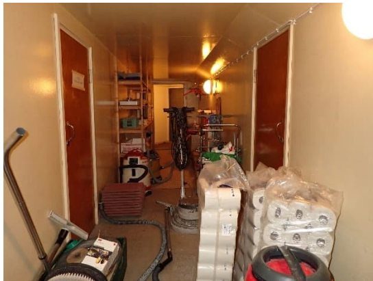
Kuva 362 ja 363. Puurunkoisten yläpohjien sisäkatot ovat havaintojen mukaan pääosin kipsilevyä, mutta lisäksi havaittiin joissain tiloissa kuitusementtilevyä, joka saattaa sisältää asbestia (kuten oikeanpuoleisen kuvan A-osan tila 224).
