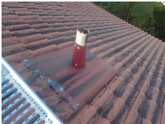
Kuva 333 ja 334. B-osan viemärin tuuletusputken yläreuna on lohkeillut. Piippujen pellitykset ovat heikkokuntoisia ja pellit ovat paikoin ruosteisia.
