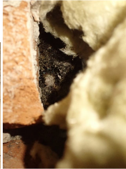
Kuvat 245 ja 246. Iltapäiväkerhon ulkoseinällä olevan hormin pellityksen avaus R8. Hormin läpiviennit oli tilkitty mineraalivillalla ja hormin takaseinässä oli pikisively. Hormista virtaava ilma haisi PAH-yhdisteille.
