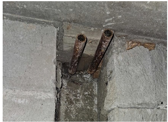
Kuvat 86 ja 87. Vanhoja katkaistuja lämpöjohtoja. Vasemmanpuoleisen kuvan putkieriste sisältää todennäköisesti asbestia.
