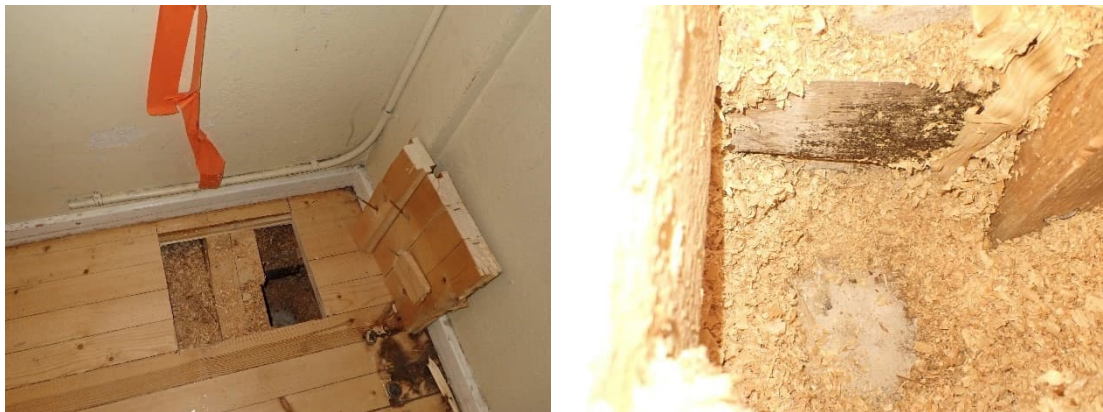
Kuvat 152 ja 153. Liikuntasalin 139 lattian avaus R19 erkkerin kohdalla. Tumentumaa puurungossa.
