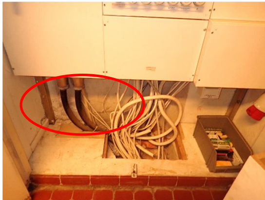
Kuvat 76 ja 77. Keittiön kohdalla sijaitsevan sähkökeskuksen ohjan avaus R10. Kaapeliläpiviennit olivat epätiivitä ja seinien alaosissa havaittiin aiempaan kastumiseen viittaavia suoloja (ympyrä).
