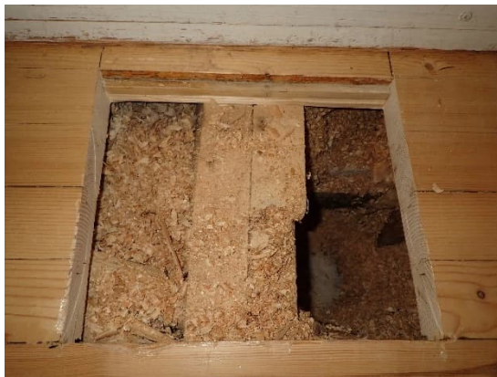
Kuvat 112 ja 113. Liikuntasalin lattian avaus R19, välipohjan eristeenä kutterinlastu, ja salin takaetisen avaus R18, eristeenä koksinkuona.
