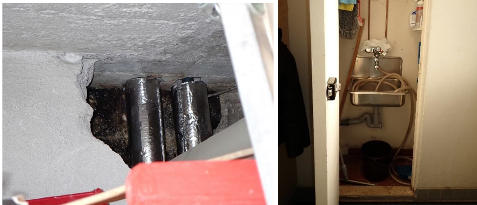
Kuvat 243 ja 244. C-osan kellarikerroksen lautavaraston ulkoseinän iso läpivienti lämpöjohtojen ja rakenteissa näkyvä pikisively sekä poikien ulkokautta kuljettavan wc-tilan siivouskomero.
