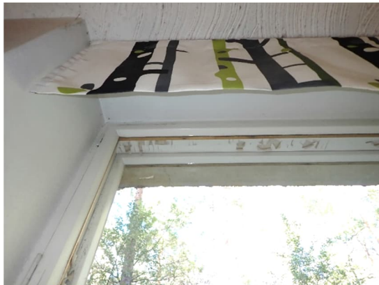
Kuvat 260 ja 261. Alkuperäisen ikkunoiden lasivälien maalit hilseilevät yleisesti.
