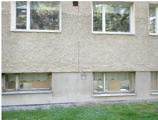
Kuvat 258 ja 259. Takapihan puolella alkuperäiset ikkunat ovat tyydyttävässä kunnossa. C-osan päädyn ja takapihan puoleisia ikkunoita on levytetty umpeen ilkeillä vuoksi.
