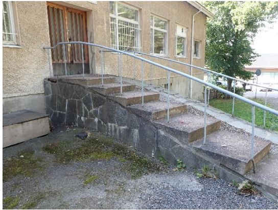
Kuvat 17 ja 18. Kirjaston takapihanpuoleisten portaiden sivussa on kosteusjälkiä ja etupihaanpuolen portaiden irronneita liuskekiviä on paikattu betonilla.
