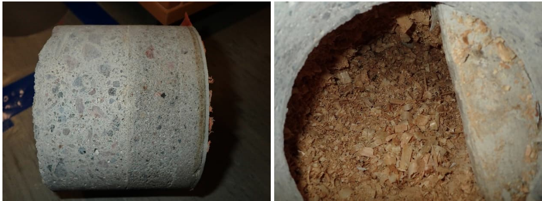
Kuvat 107 ja 108. Opettajienhuoneen eteisen 127 välipohja, avaus R22.
