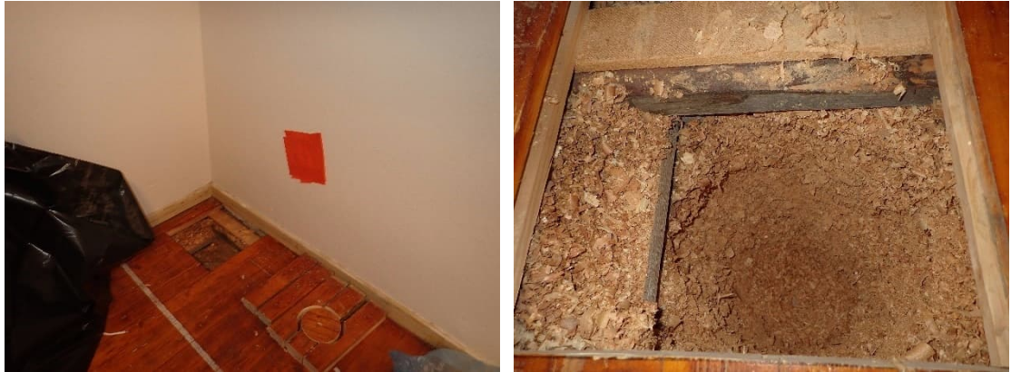
Kuvat 154 ja 155. Liikuntasalin varaston 141 lattian avaus R20. Eriste oli hieman tummunut alaosaan.
