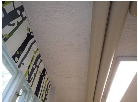
Kuvat 124 ja 125. Kaksoislaattarakenteisen välipohjan rapattu alapinta.
