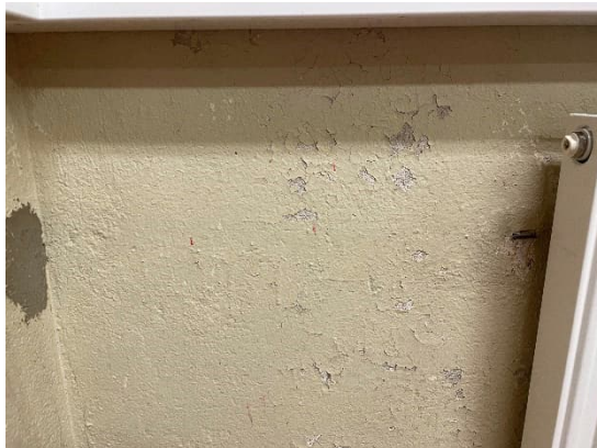
Kuvat 222 ja 223. Maanvastaisten seinien pinnat hilseilevät paikoitellen, mutta seinissä ei todettu rakennekosteutta. Vasemmanpuoleinen kuva tekstiilityön luokasta. Oikeanpuoleinen kuva on lautavarastossa, jossa seinän alaosassa havaittiin vanhoja kosteusjälkiä ja mikrobikasvuun viittaavaa värimuutosta.
