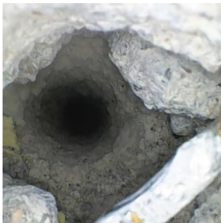
Kuva 30. Lautavaraston alapohja, poraus P23. Eristeenä on kevytbetonia.
