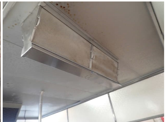
Kuvat 413 ja 414. Keittiön ruuanvalmistuspisteen huuva ja rasvasuodatin.
