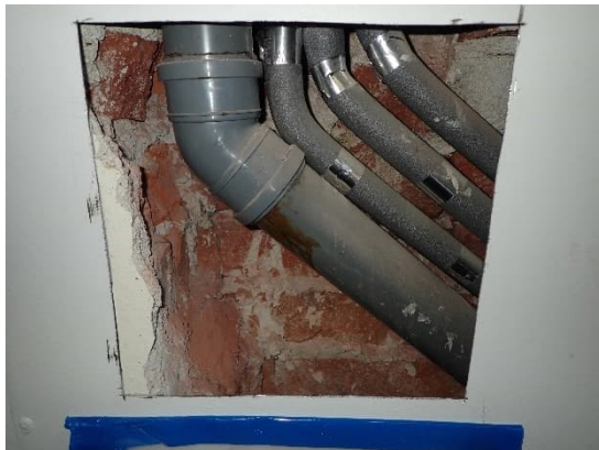
Kuvat 174 ja 175. Käytävän 206 väliseinällä oleva hormi avauksessa R32. Hormista virtasi ilmaa käytävän suuntaan.
