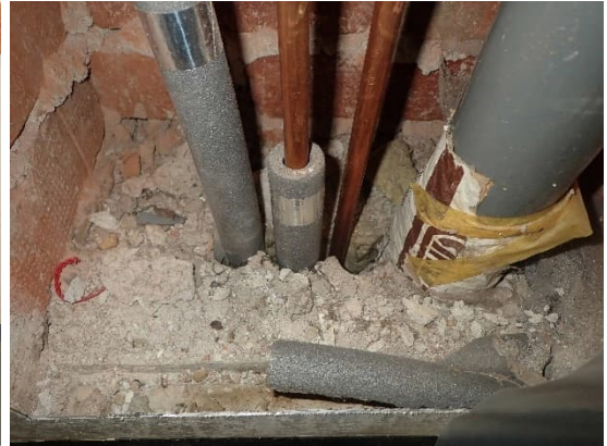
Kuvat 74 ja 75. Ruokalan väliseinässä olevan hormin pellityksen avaus R9. Alapohjaan / putkikanaaliin vievät läpiviennit ovat epätiivitä ja läpivienneissä on tilkkeenä mineraalivillaa.
