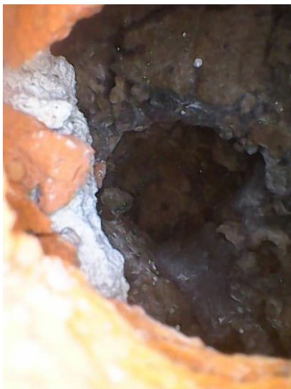
Kuva 189. Kellarikerroksen maanvastainen ulkoseinä takapihapuoleisen entisen asunnon kohdalla, poraus P16. Seinän eristeenä on ohut kerros korkkia.
