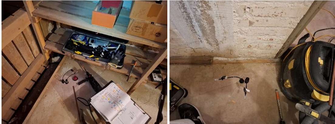
Kuvat 48 ja 49. Alimman kellaritilan alapohjan kosteusmittauspisteet MP8 ja MP9.
