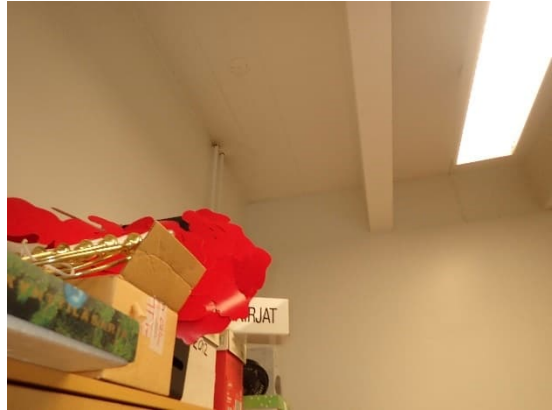
Kuvat 130 ja 131. Kirjaston taukotilan 112 katossa havaittiin kosteusjäljet lämpöjohtojen läpivientien kohdalla.
