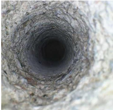
Kuva 24. Henkilökunnan pukuhuoneen alapohja, poraus P30. Rakenteessa ei ole lämmöneristettä.
