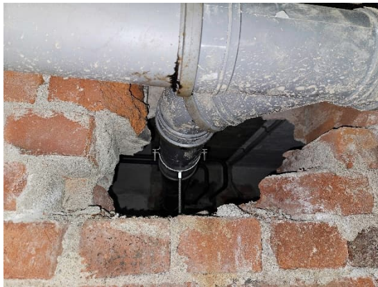
Kuvat 96 ja 97. Putkikanaalin seinässä havaittiin viemäriputkea varten tehty reikä, josta on yhteys yhteen kellaritilojen varastuhuoneeseen.
