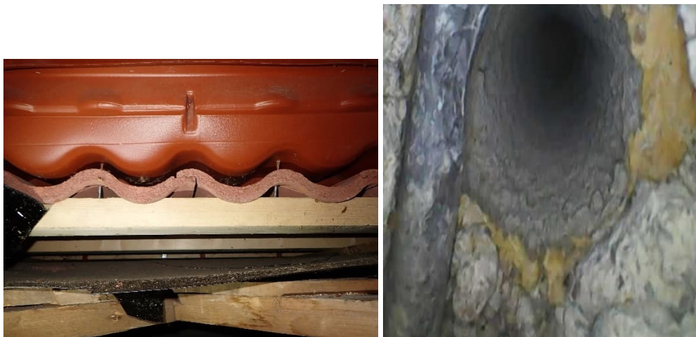
Kuvat 317 ja 318. A-osan korkean osan vesikaton alusrakenteita ja yläpohjan poraus P32, eristeenä kevytbetonia.
