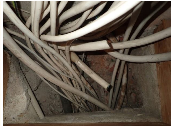
Kuvat 76 ja 77. Keittiön kohdalla sijaitsevan sähkökeskuksen ohjan avaus R10. Kaapeliläpiviennit olivat epätiivitä ja seinien alaosissa havaittiin aiempaan kastumiseen viittaavia suoloja (ympyrä).
