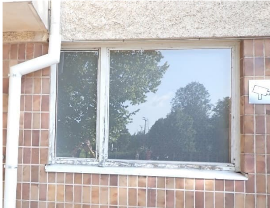
Kuvat 256 ja 257. Eteläisivun uusimattomien ikkunoiden maalipinnat ovat huonossa kunnossa ja länsipäädyn ikkuna vesipelti on ruosteessa.
