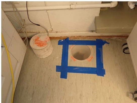
Kuvat 136 ja 137. Opettajienhuoneen 123 välipohjan avaus R22. Puurakenteissa havaittiin värimuutoksia.
