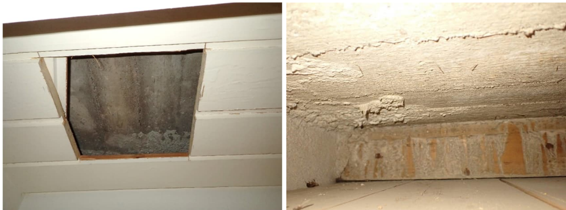
Kuvat 160 ja 161. Luokan 202 (24) alakaton avaus R35. Alkuperäinen paneelikatto on kiinnitetty muottilautoihin.
