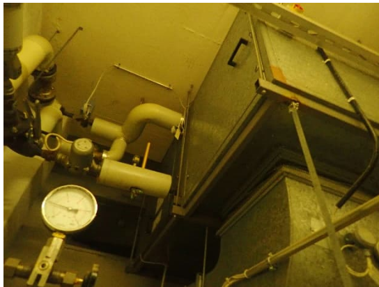
Kuvat 379 ja 380. Keittiötä ja ruokasalia palveleva ilmanvaihtokone TK1 sijaitsee teknisessä tilassa katonrajassa. Puhallin on kiilahihnavetoinen.
