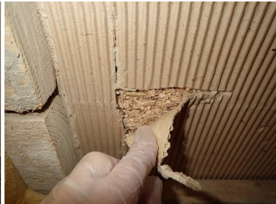
Kuvat 194 ja 195. Toisen kerroksen puurakenteinen sivuvinttiin rajautuva ulkoseinä, avaus R40.
