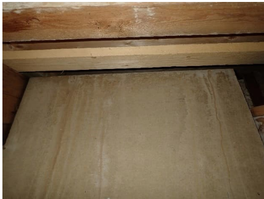
Kuvat 232 ja 233. Varaston 221 ja luokan 218 ulkoseinän kastunutta kuitusementtilevyä kylmän sivuvintin puolelta vasemmanpuoleisessa kuvassa ja varaston 221 vastaavan seinän yläosan avaus R40.
