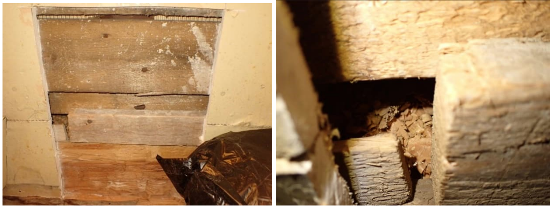
Kuvat 201 ja 202. Toisen kerroksen puurunkoinen sivuvinttiin rajatutava ulkoseinä, avaus R30. Eristeenä kutterinlastua.
