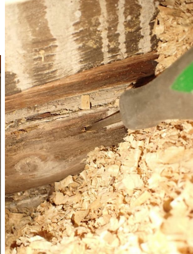
Kuvat 134 ja 135. Opettajien huoneen eteisen 127 välipohjan avaus R21. Palkin muottilaudan alaosassa havaittiin lahoa. Avauksessa aistittiin hieman mikrobiperäistä hajua.
