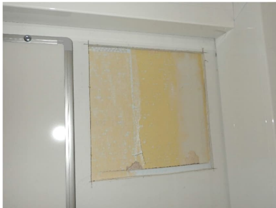
Kuva 236. Luokan 218 sivuvinttiin rajautuva seinä oli kivirakenteinen, avaus R42.
