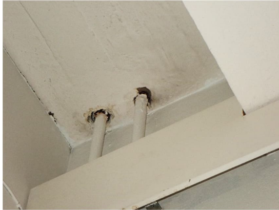
Kuvat 130 ja 131. Kirjaston taukotilan 112 katossa havaittiin kosteusjäljet lämpöjohtojen läpivientien kohdalla.
