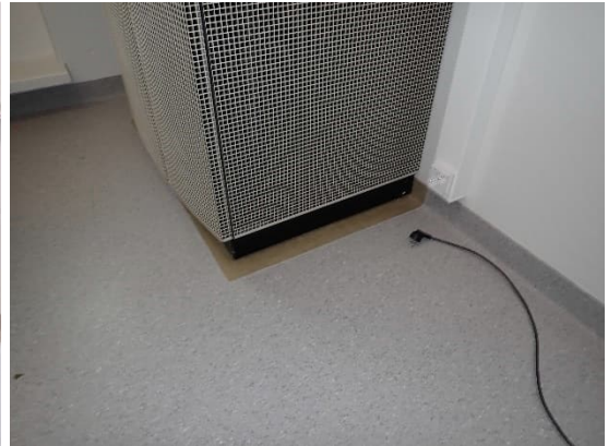
Kuvat 119 ja 120. Luokan 305 lattiaa, jossa on muovimattoja ja luokan etuosan koroke. Muutoin vanhalla muovimattoa havaittiin pääosin ilmanvaihtokoneiden alla.
