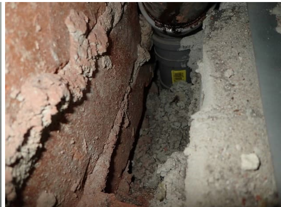
Kuvat 174 ja 175. Käytävän 206 väliseinällä oleva hormi avauksessa R32. Hormista virtasi ilmaa käytävän suuntaan.
