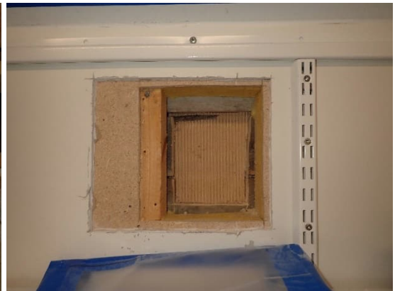
Kuvat 232 ja 233. Varaston 221 ja luokan 218 ulkoseinän kastunutta kuitusementtilevyä kylmän sivuvintin puolelta vasemmanpuoleisessa kuvassa ja varaston 221 vastaavan seinän yläosan avaus R40.
