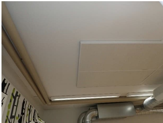
Kuvat 124 ja 125. Kaksoislaattarakenteisen välipohjan rapattu alapinta.
