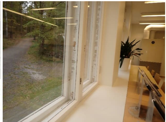
Kuvat 260 ja 261. Alkuperäisen ikkunoiden lasivälien maalit hilseilevät yleisesti.
