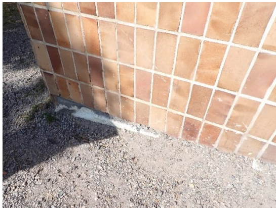
Kuvat 8 ja 9. C-osan päädyssä rakennuksen vierellä näkyvä EPS-eristettä.
