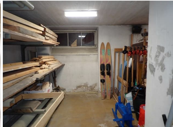
Kuvat 222 ja 223. Maanvastaisten seinien pinnat hilseilevät paikoitellen, mutta seinissä ei todettu rakennekosteutta. Vasemmanpuoleinen kuva tekstiilityön luokasta. Oikeanpuoleinen kuva on lautavarastossa, jossa seinän alaosassa havaittiin vanhoja kosteusjälkiä ja mikrobikasvuun viittaavaa värimuutosta.
