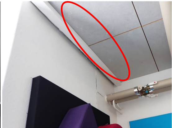
Kuvat 128 ja 129. Ruokalan ja sen yhteyteen rakennetun iltapäiväkerhon tilan kattojen akustiikkalevyissä havaittiin runsaasti kosteusjälkiä ulko- ja väliseinälinjoilla.
