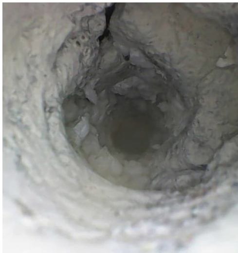
Kuva 25. Entisen asunnon uusittu alapohjan rakenne porauksesta P11. Uutena eristeenä on EPS.
