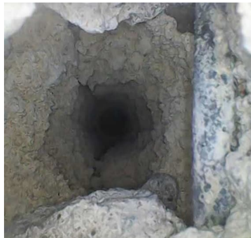
Kuvat 32 ja 33. Poikien pukuhuoneen alapohja kanaalin kohdalla ja keskemällä huonetta, poraukset P27 ja P28. Kanaalin kohdalla etisteenä on koksinkuonaa (P27) ja keskemällä kevytbetonia (P28).
