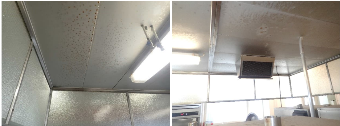
Kuvat 415 ja 416. Huuviin on kertynyt runsaasti epäpuhtauksia.
