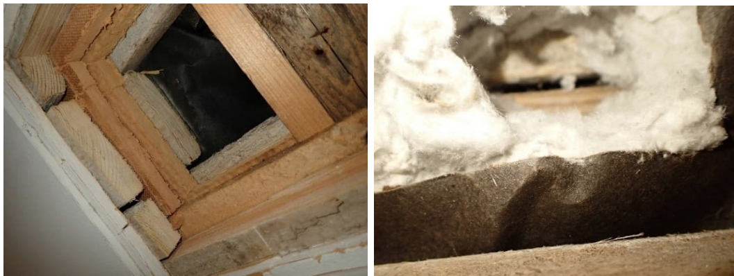
Kuvat 319 ja 320. A-osan 2. kerroksen puurakenteinen yläpohja (matala osa), kuvat avauksista R43 ja R41.
