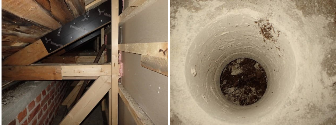
Kuvat 315 ja 316. A-osan matalan osan sivuvinttiä ja sen yläpohjaa avauksesta R49. Yläpohjan eristeenä on kevytbetonia ja turvetta.
