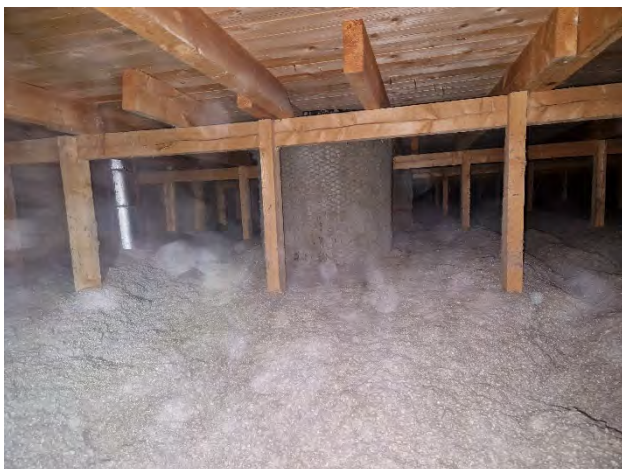
Kuva 214. Lämmöneristettyjä putkia yläpohjatilassa.
