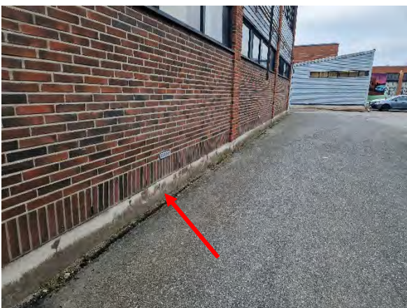
Kuva 36. Sokkelissa on kosteuden aiheuttamaa tummentumaa.
