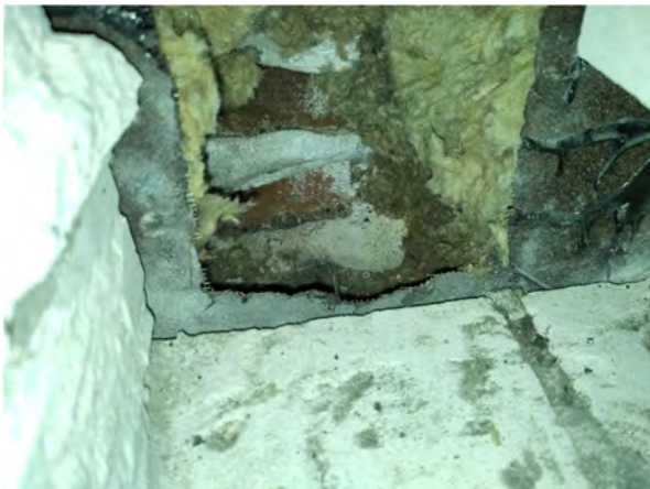
Kuva 68. Rakenneavaus US4, tiilimuurauksen takana bitumikermi sekä mineraalivilla. Julkisivutiilissä on reilut laastipurseet taustapinnalla.
