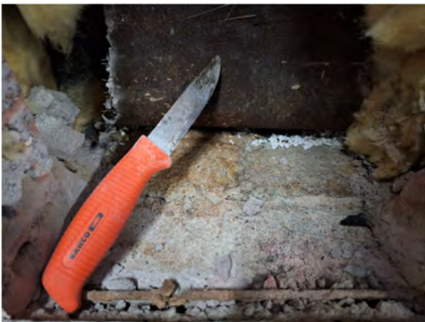
Kuva 134. VS2, sokkelinhalkaisussa mineraalivilla
