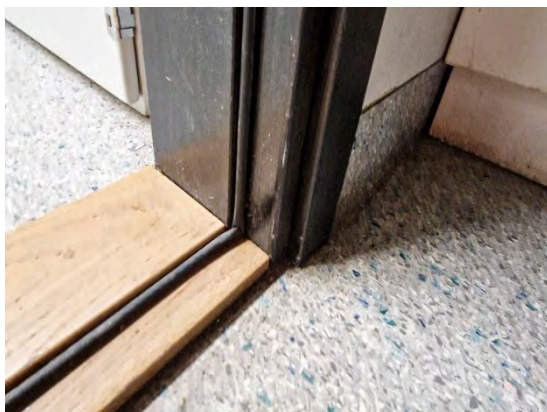
Kuva 250. B2018 tilassa pelkkä poisto, ilman ohjattua korvausilman saantia. Ovi on lisäksi tiivistetty.
