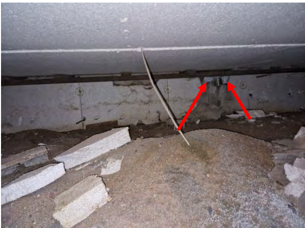
Kuva 12. Työsalin B162 kohdalla olevien alapohjan korvausilma-putkien pintaan on muodostunut jätettä.
