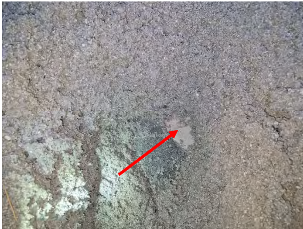
Kuva 208. Puhallusvillan alapuolella on ontelolaatta.
