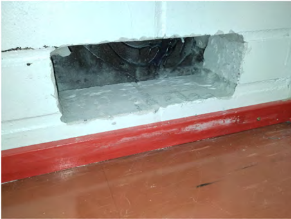
Kuva 69. US4, kahitiilen takana bitumikermi.
