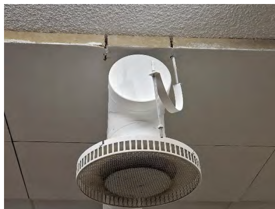
Kuva 243. Tuloilmakanavan kannatinsanka irti. Kyljestään pinnoittamattomat akustiikkalevyt ovat mahdollisia kuitulähteitä.
