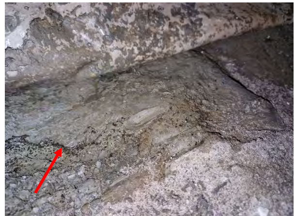
Kuva 12. Työsalin B162 kohdalla olevien alapohjan korvausilma-putkien pintaan on muodostunut jätettä.
