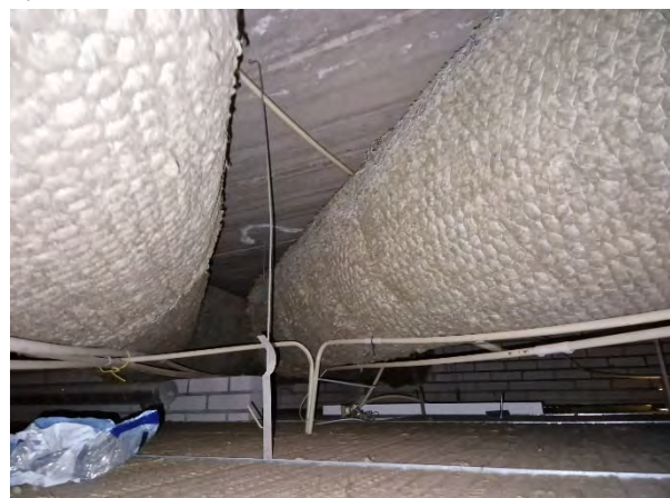
Kuva 163. Alkuperäisen osan alakattotilaa.
