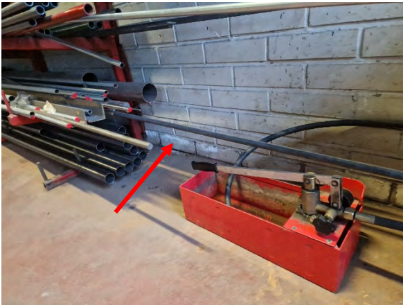
Kuva 122. Tilan B152 ja viereisen porraskäytävän välisessä olevaa kosteusjälkeä.
