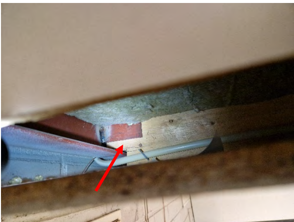
Kuva 130. Työsalin parven välipohja on puu- ja teräsrunkoinen.
