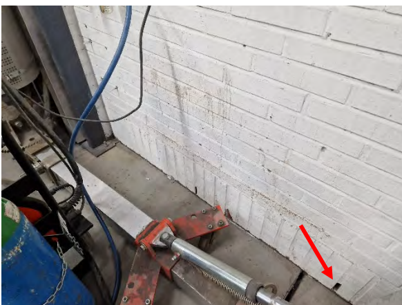
Kuva 120. Laajennuksen ja alkuperäisen osan välisessä seinässä on avoimena aiemman ulkoseinän tuuletusraot.
