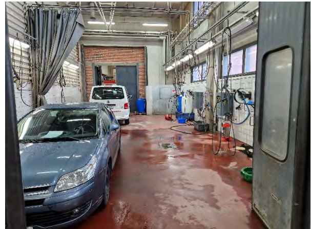
Kuva 123. Pesutilan viereisissä seinärakenteissa on paikoin kohonneita pintakosteusarvoja.
