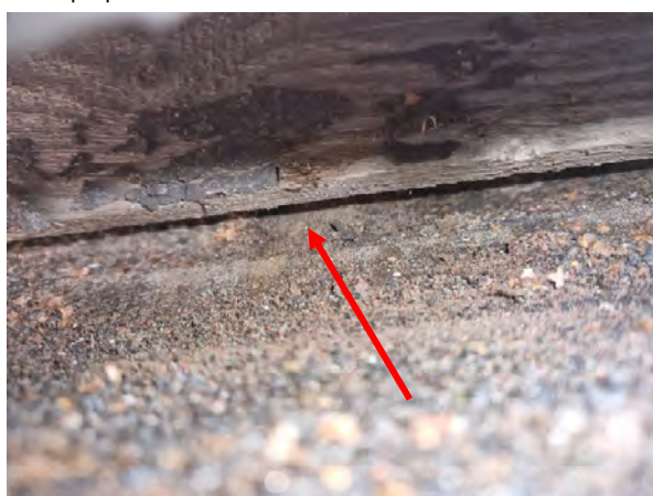
Kuva 145. Kermi on nostettu ulkoseinää vasten edellisen kuvan läpivientien vierellä olevassa kohdassa.
