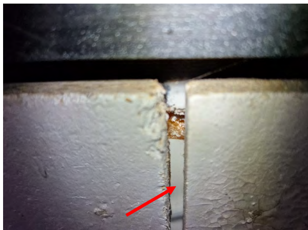
Kuva 56. Työsalien parvella olevien seinärakenteiden sisäverhouksen olevan lastulevyn takana on muovikalvo höyrysulkukerrosena.
