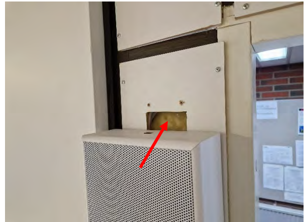
Kuva 125. Tilan B054 oven viereisen tekniikkakotelon kohdalla on avointa mineraalivillaa.
