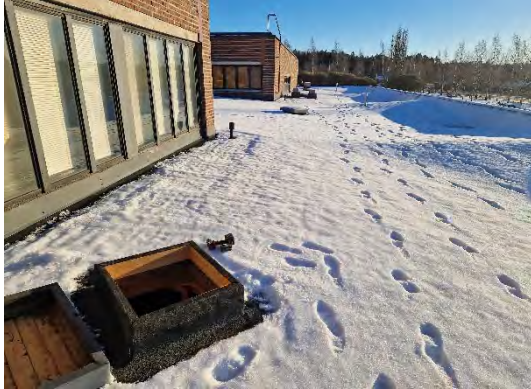
Kuva 179. TP2 sijainti, n. käytävän B009 kohdalla.
