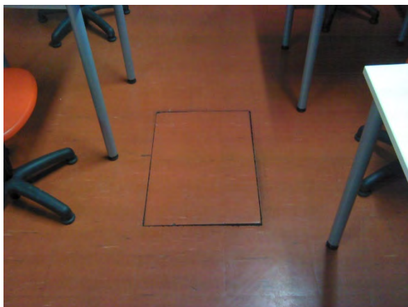
Kuva 27. Alapohjan huolto-/käyntiluukku.
