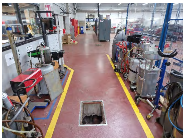
Kuva 4. Alapohjan ryömintätilan luukku.
