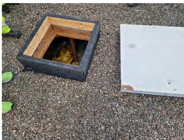
Kuva 151. Yläpohjatilaan johtaa useita kattoluukkuja.
