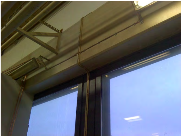
Kuva 94. Ikkunoiden välissä oleva levykotelointi.
