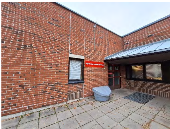
Kuva 228. Erään sisäänkäynnin betonilaatoitusta.
