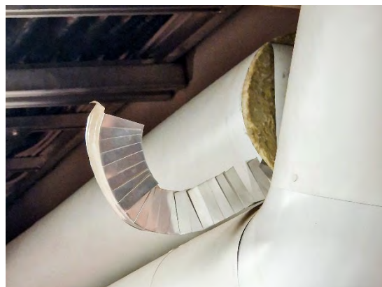
Kuva 241. Putkieristeen eriste näkyvissä.
