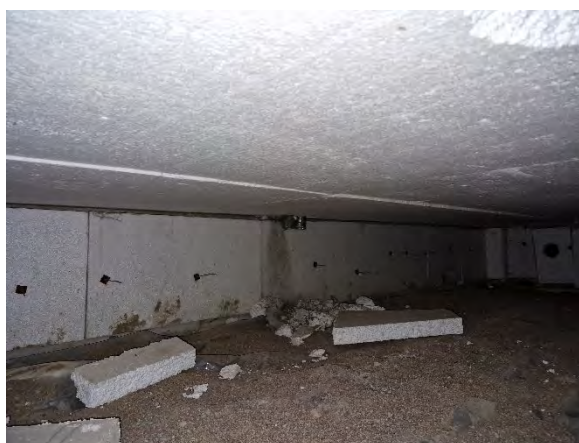
Kuva 5. Yleiskuva ryömintätilasta. Alapohjan alapinnassa on 70 mm EPS-eriste.
