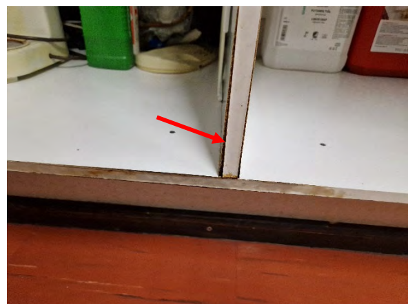
Kuva 125. Tilan B054 oven viereisen tekniikkakotelon kohdalla on avointa mineraalivillaa.
