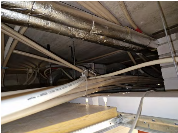
Kuva 164. Yleiskuva laajennusosan alakattotilasta.
