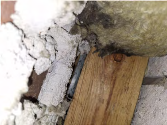
Kuva 65. US1, pystypuun takana nähtävissä selkeä tuuletusväli.
