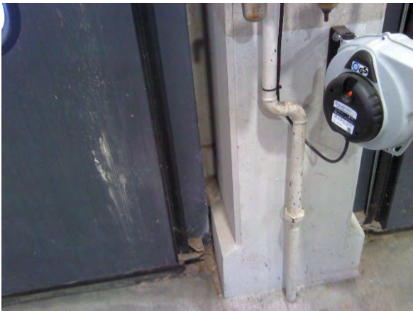
Kuva 102. Laajennusosan tilan B1002 ulkoseinän rakennetta oven vierellä.
