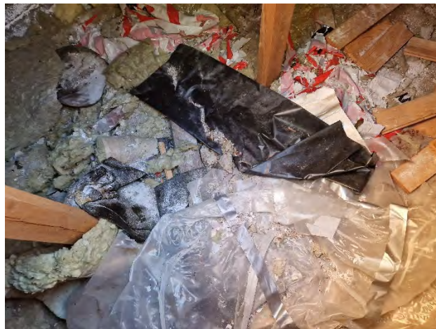
Kuva 186. Rakennusjätteitä yläpohjatilassa.
