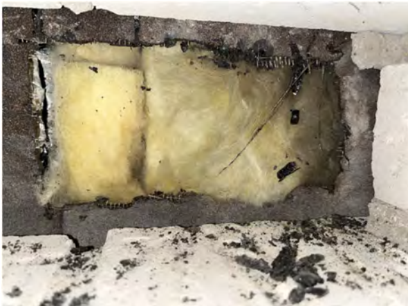
Kuva 75. Rakenneavaus US7, tiilimuurauksen takana bitumikermi sekä mineraalivilla.
