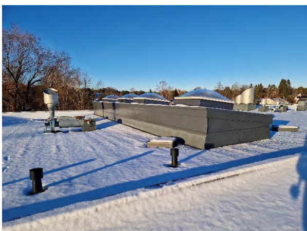
Kuva 150. Kattoikkunarakenteet on uusittu.
