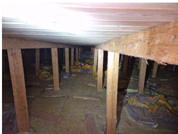
Kuva 178. Yleiskuva matalammasta osasta räystästä kohden.
