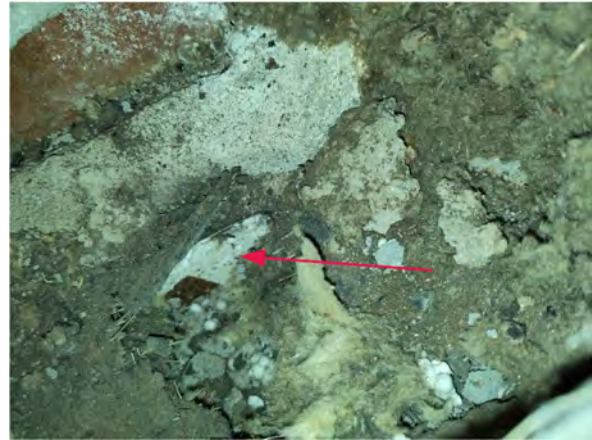
Kuva 70. US4, EPS-eriste sokkelihalkaisussa.
