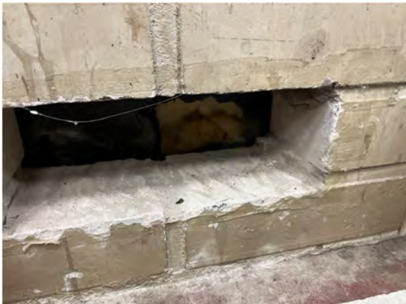
Kuva 66. Rakennearaus US3, tiilimuurauksen takana bitumikermi sekä mineraalivilla.
