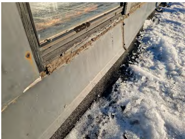
Kuva 148. Ikkunoiden kohdalla olevia pellityksiä on tiivistetty massausten avulla.
