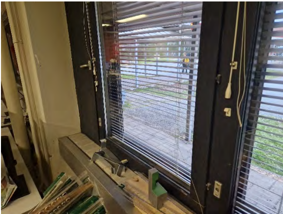
Kuva 44. Yleiskuva alkuperäisen osan ikkunasta.
