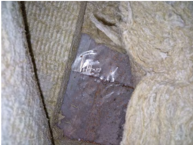
Kuva 197. Ontelolaatan yläpinnalla on muovikalvo.
