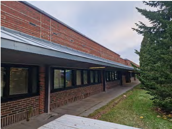
Kuva 40. Laajennuksen yhteydessä lisätty katosrakenne.
