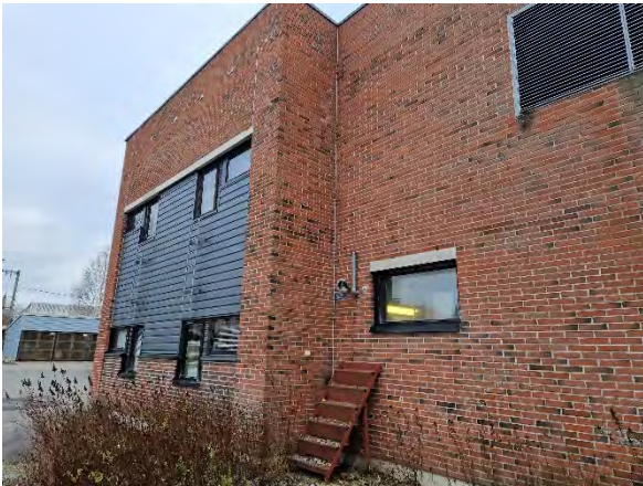
Kuva 32. Yleiskuva julkisivusta. Julkisivu on pääosin tiili-muurattu, mutta paikoin on myös peltipintaa.
