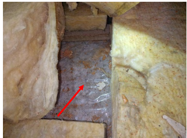
Kuva 174. Ontelolaatan yläpinnassa olevaa muovikalvoa.
