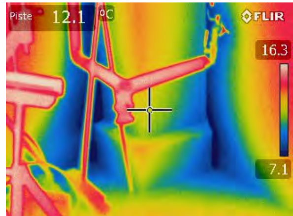
Kuva 101. Edellisen kuvan pilarin ympärillä olevia ilma-/lämpövuotoja.
