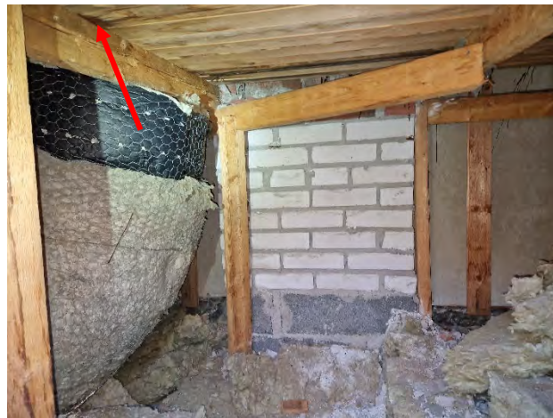
Kuva 191. Ulkoseinän rakenteita yläpohjatilassa ja märkä kohta läpiviennin vierellä.
