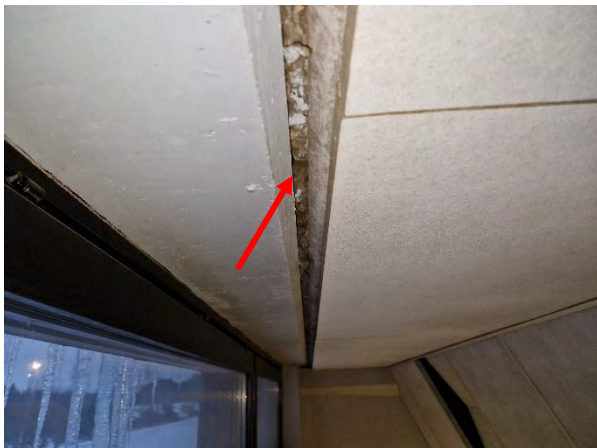
Kuva 166. Yläpohjan ontelolaattojen ja kantavan rungon be- tonipalkkien väli on tiivistetty mineraalivillalla.
