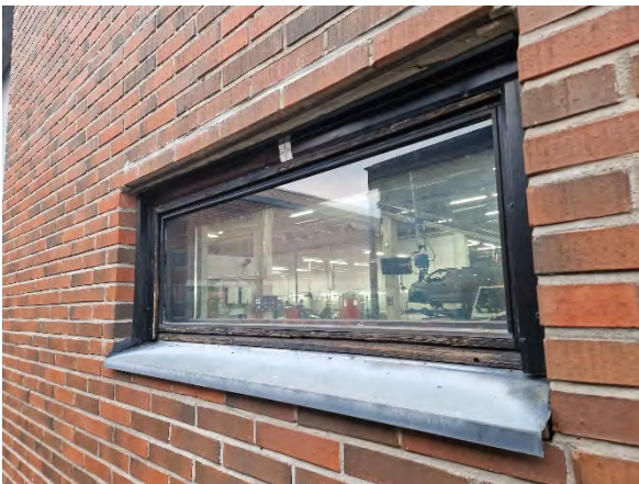
Kuva 46. Yleiskuva alkuperäisen osan ikkunasta.
