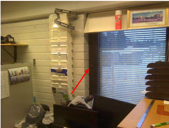
Kuva 88. Tiilimuurauksen ja peitelistöituksen kohdalla on näkyvissä lämmöneristevillaa tilassa B052.
