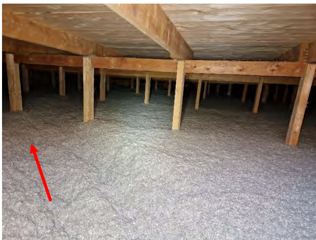
Kuva 216. Yleiskuva yläpohjatilasta. Julkisivumuurauksen tuuletusaukko.
