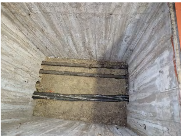
Kuva 14. Käytävällä B008 olevassa kytkentäsyvennyksessä ei havaittu kosteutta tai poikkeavia hajuja.
