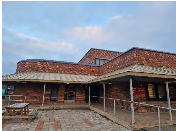
Kuva 227. Erään sisäänkäynnin betonilaatoitusta.
