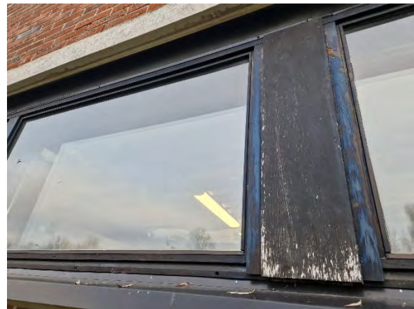
Kuva 47. Yleiskuva laajennusosan ikkunasta.
