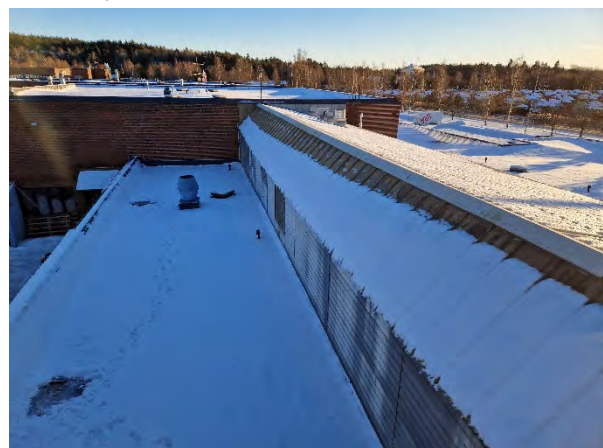
Kuva 157. Kattorakenteita ilmanvaihtokonehuoneen kohdalla.
