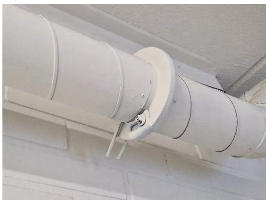
Kuva 236. Iris-säätöpelti ylimaalattu.
