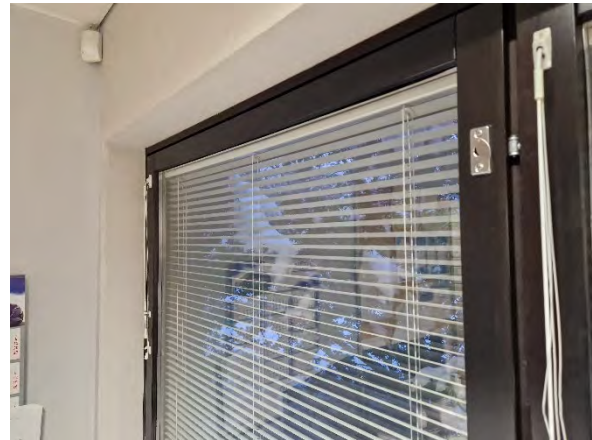
Kuva 45. Yleiskuva laajennusosan ikkunasta.
