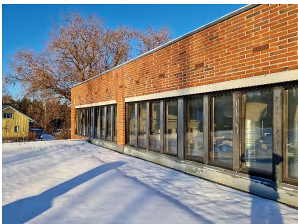
Kuva 156. Yleiskuva laajennusosan vesikatolta.
