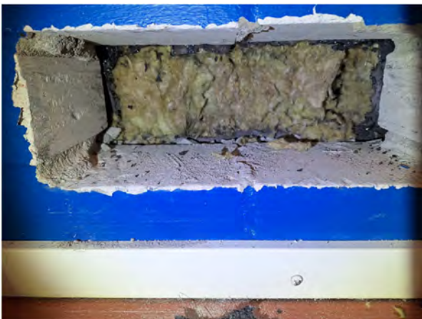
Kuva 60. US1, kahitiilen takana bitumihuopa sekä mineraalivilla.
