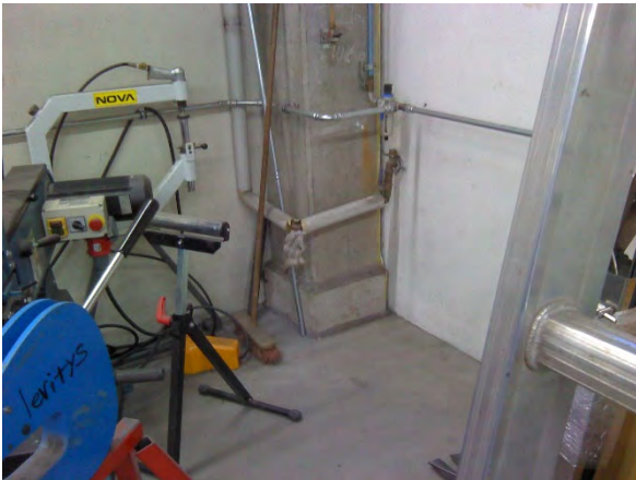
Kuva 100. Laajennusosan tilan B1020 ulkoseinän rakennetta.
