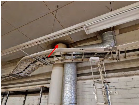
Kuva 221. Työsalin B143 parvella oleva putkiläpivienni yläpohjaan.
