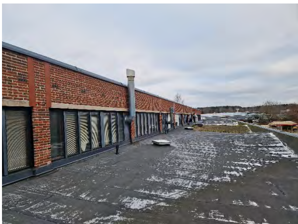
Kuva 142. Yleiskuvaa luokkatilojen vesikatolta.
