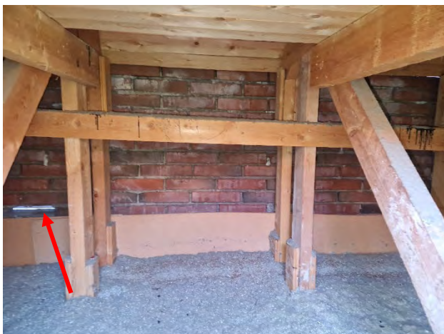
Kuva 210. Yleiskuva yläpohjatilasta. Julkisivumuurauksen tuuletusaukko.
