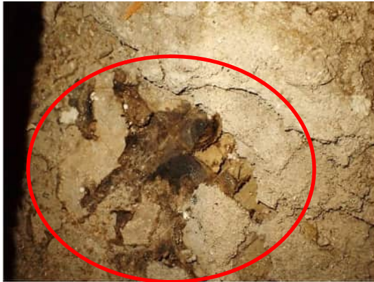
Kuva 218. Liikuntasalin A123 lattian avauskohdassa R51 havaittiin mustapintaista paperia välipohjan valun sisällä. Paperi ei sisältänyt asbestia.
