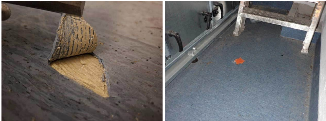
Kuvat 193 ja 194. Ilmanvaihtokonehuoneen D301 viiltomittaus V13.
