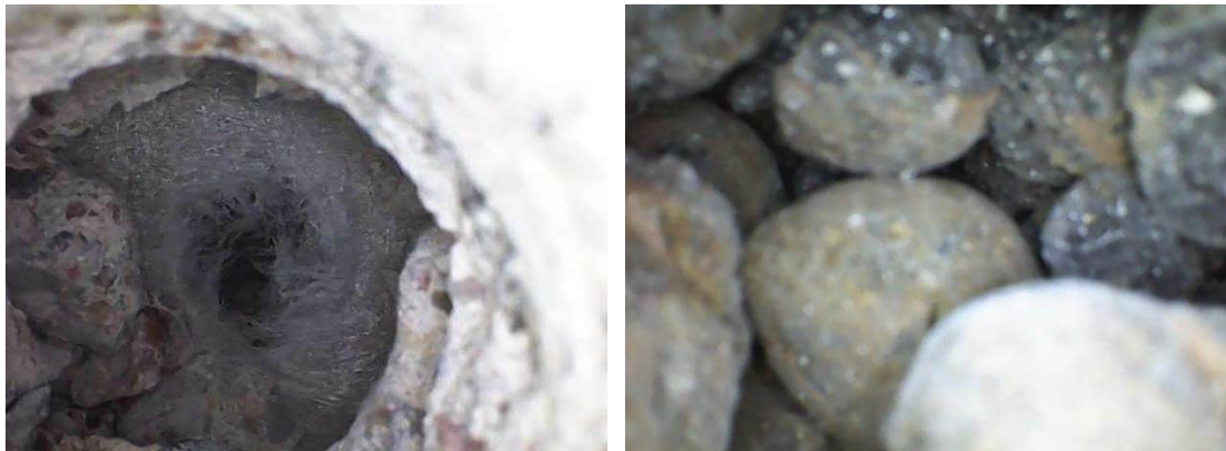
Kuvat 22 ja 23. Pukuhuoneen A012 uusitun alapohjan eristeenä on kevytsoraa ja sen päällä suodatinkangas, poraus P4.
