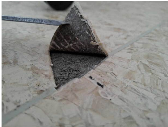
Kuva 192. Yhdyskäytävän C201 viiltomittaus V12.
