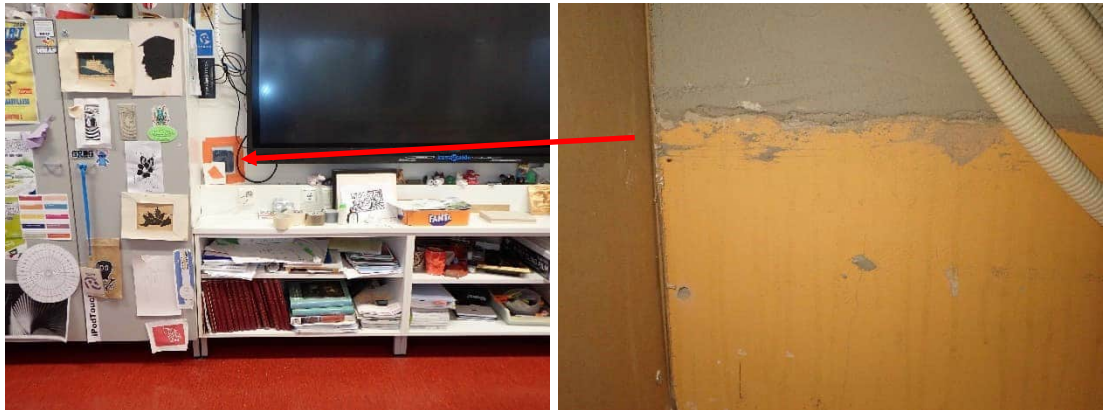
Kuvat 437 ja 438. Luokan B013 väliseinän koteloinnin avauksen takana oli todennäköisesti alaosassa vanhaa ulkoseinää ja oranssia julkisivua ja ylempänä tasoitettua uudempaa kahi-tiilimuurausta.
