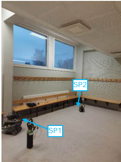
Kuva 155. Pukuhuoneen A028 merkkiainekokeessa MA19 ei todettu ilmavuotoja alapohjan eristetilasta. Merkkiainekaasun syöttöpisteet (SP) on merkitty sinisillä nuolilla.
