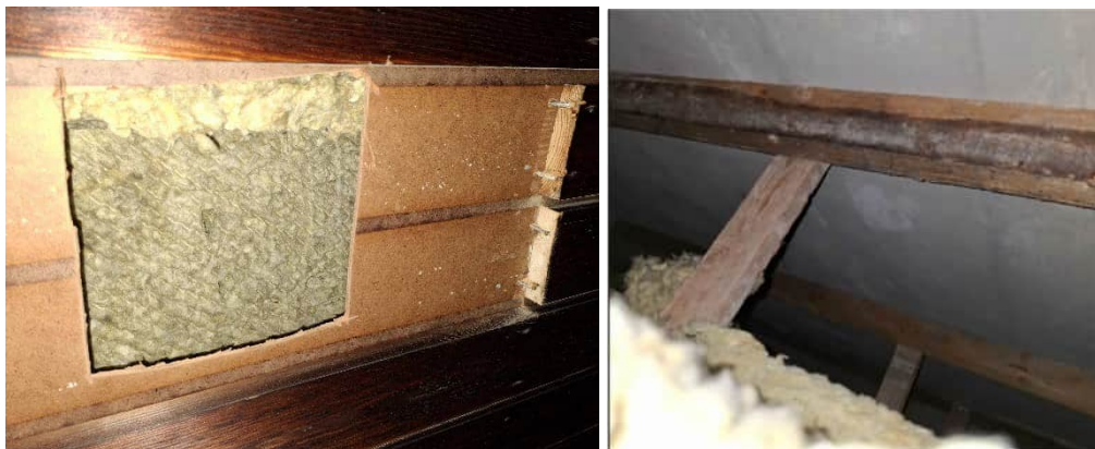
Kuvat 121 ja 122. B-osan ilmanvastaisen alapohjan rakenneavaus R91.
