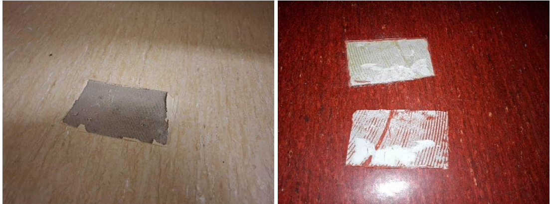
Kuvat 103 ja 104. BULK3 näytteenotto kohta pukuhuoneessa A008 (keltainen muovimatto). BULK4 näytteenotto kohta luokassa B013. Näytteet BULK4-BULK6 ovat vastaavasta punaisesta muovimatosta kuin BULK4.
