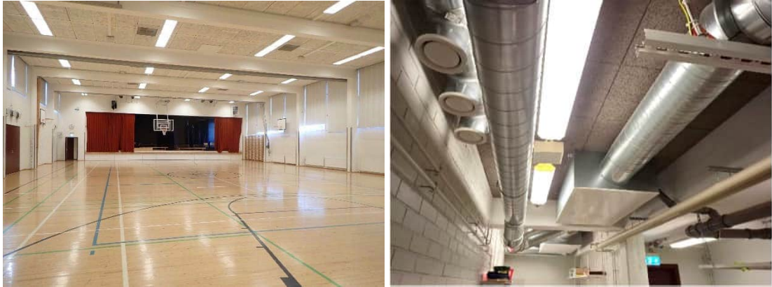
Kuvat 184 ja 185. Lastuvillalevykattoa liikuntasalissa A124 ja teknisen työn luokassa D127.
