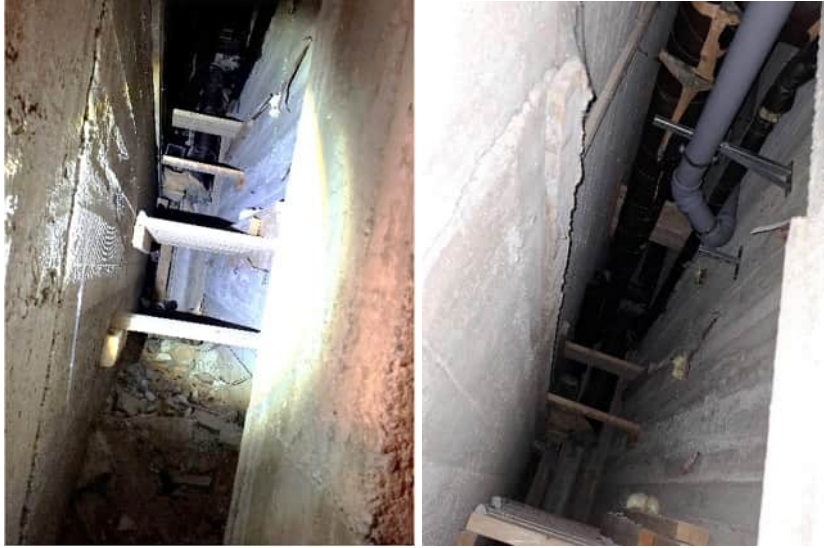
Kuvat 72 ja 73. C- ja B-osan välissä on kapea korkea tila, jossa oli puurakenteita, talotekniikkaa ja runsaasti rakennusjätettä. Tila jatkuu todennäköisesti C-osan yläpohjan eli ensimmäisen kerroksen katon korkeudelle.
