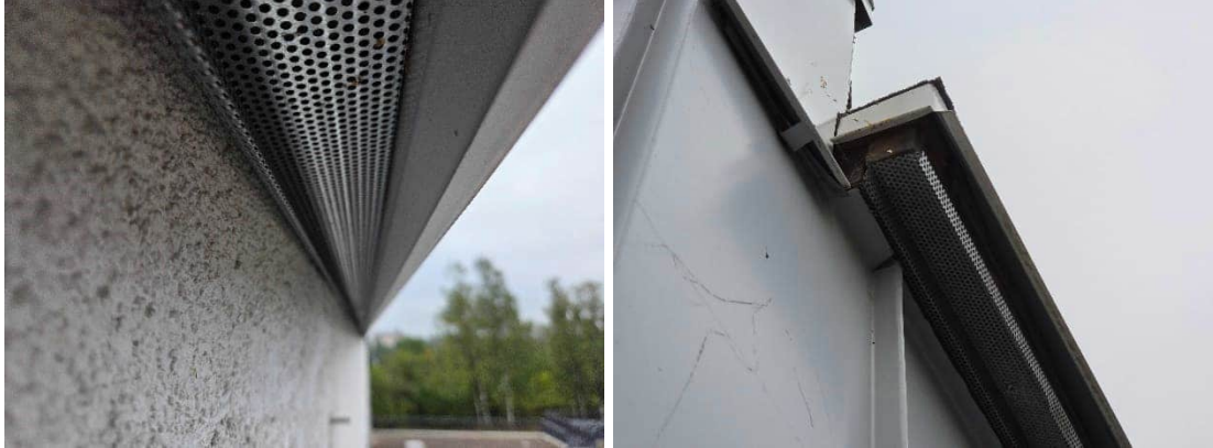
Kuvat 499 ja 500. Räystäiden tuuletusaukot oli suojattu suunnitelmien mukaisesti reikäpellityksillä. Oikeanpuoleisessa kuvassa IV-konehuoneen räystäspellitystä.
