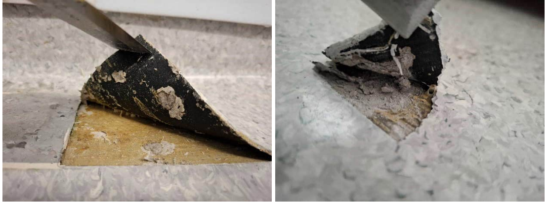
Kuvat 190 ja 191. Luokan D107 viiltomittaus V10 ja teknologia luokan D111 viiltomittaus V11. Kummassakin kohdassa on mustapohjainen sähköä johtava muovimatto.
