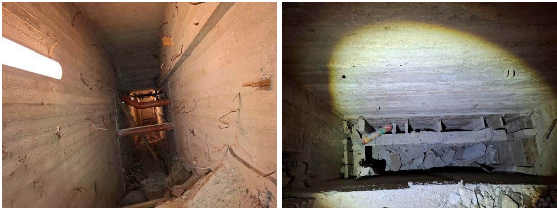
Kuvat 70 ja 71. Alustatilan C015 pohjalla on kalliota ja kiveä sekä sekalaista materiaalia. B-osan puoleisessa päädyssä on syvämpi kohta, jossa oli muottilaudat paikallaan.
