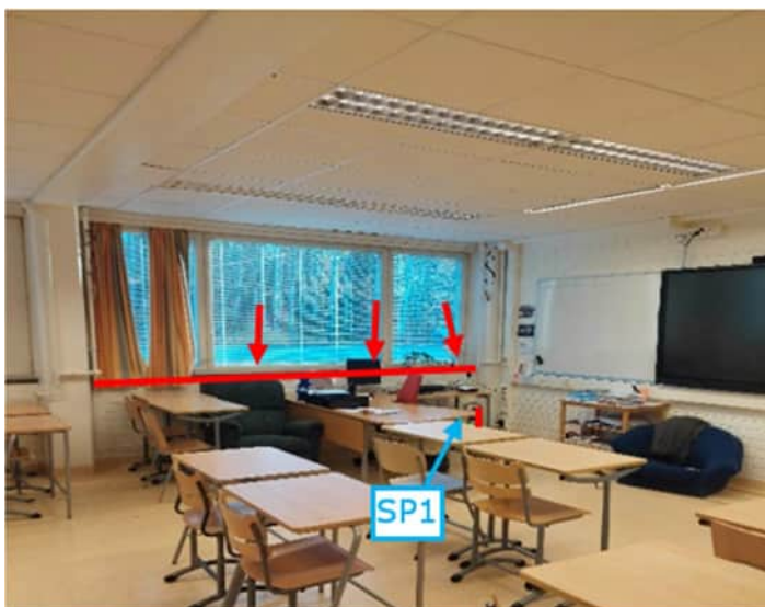
Kuva 376. Luokkahuoneen D012 ulkoseinän merkkiainekokeessa MA2 havaitut pistemäiset ilmavuodot on esitetty kuvassa punaisilla nuolilla ja punaisella viivalla on esitetty merkittävät vuodot. Kaasun syöttöpiste (SP) on merkitty sinisellä nuolella.
