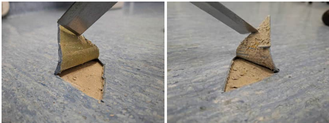
Kuvat 98 ja 99. Tekstiilityön luokan C101 viiltomittaukset V7 ja V8.
