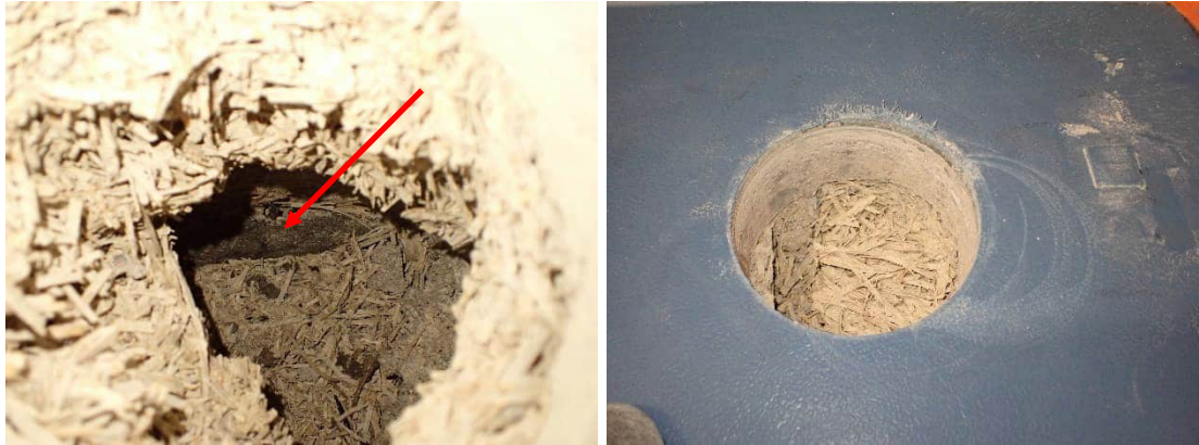
Kuvat 107 ja 108. Liikuntasalin A023 alapohjan avaukset R6 ja R7. Avauksen R6 kohdalla oli muista poiketen ilmatilaa eristeen alla ja ulkoseinän vierustalla lastuvillalevyä pystysuunnassa. Lastuvillalevyä vasten oli myös pikisivelyä (nuoli), joka ei sisältänyt asbestia.
