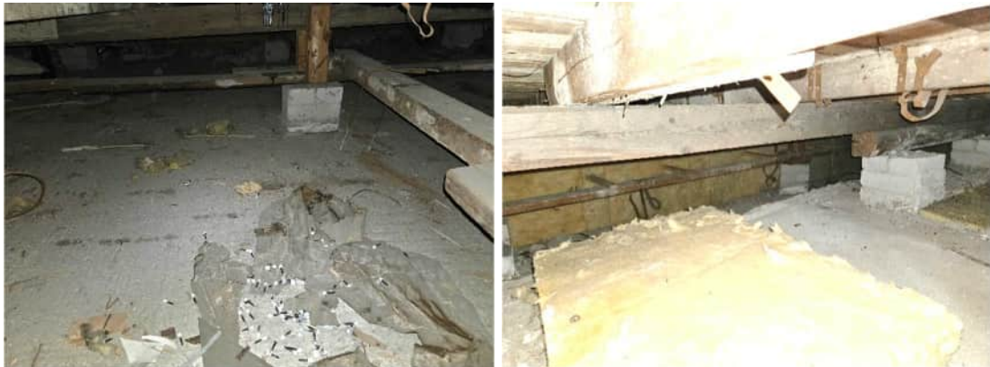
Kuvat 523 ja 524. A-osan alemman tason yläpohjatilassa havaittiin pieniä määriä rakennusjätettä ja mineraalivillalla eristettyjä kanavia.
