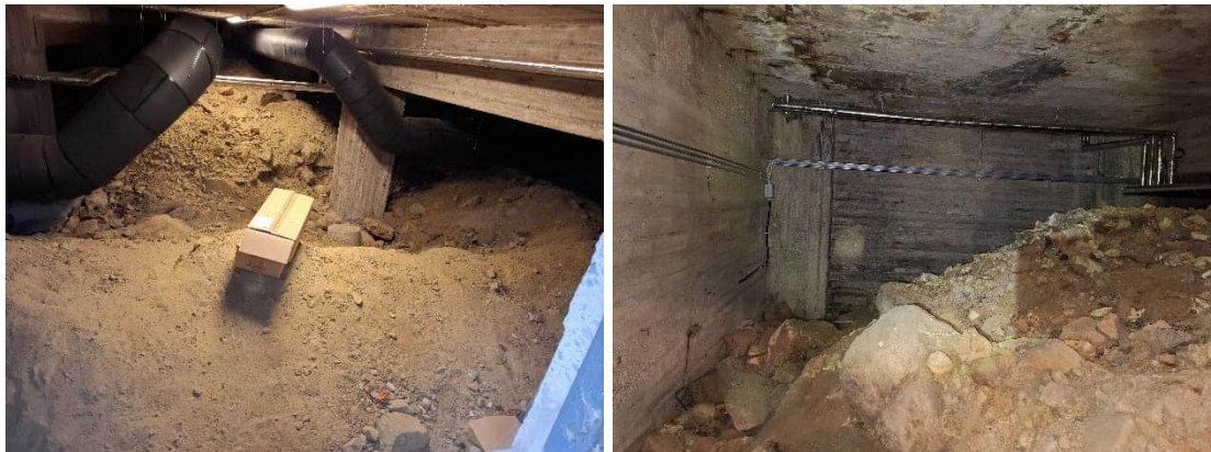
Kuvat 66 ja 67. Kuvaamataidon luokan B013 alla sijaitsevan alustatilan pohjalla on kalliota, hiekkaa ja kiveä, muut pinnat ovat betonia.
