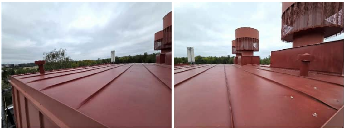
Kuvat 489 ja 490. IV-konehuoneen vesikaton maalipinta on pääosin hyvässä kunnossa.
