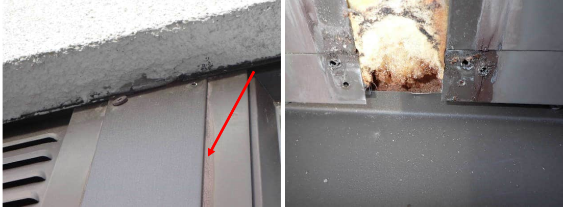
Kuvat 326 ja 327. Ikkunoiden välinen ulkopuolen pellitys, jonka takana oli uretaanivaahdotusta. Pellityksen reunoilla oli ohuelti massaa, joka oli hapertunut (nuoli). Kuvat ovat avauksesta R76.
