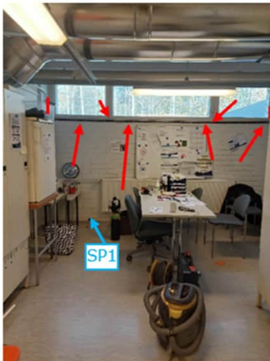
Kuva 377. Merkitseminen kokeessa MA6 havaitut pistemäiset ilmavuotopaikat on merkitty punaisilla nuolilla. Kaasun syöttöpiste (SP) on merkitty sinisellä nuolella.
