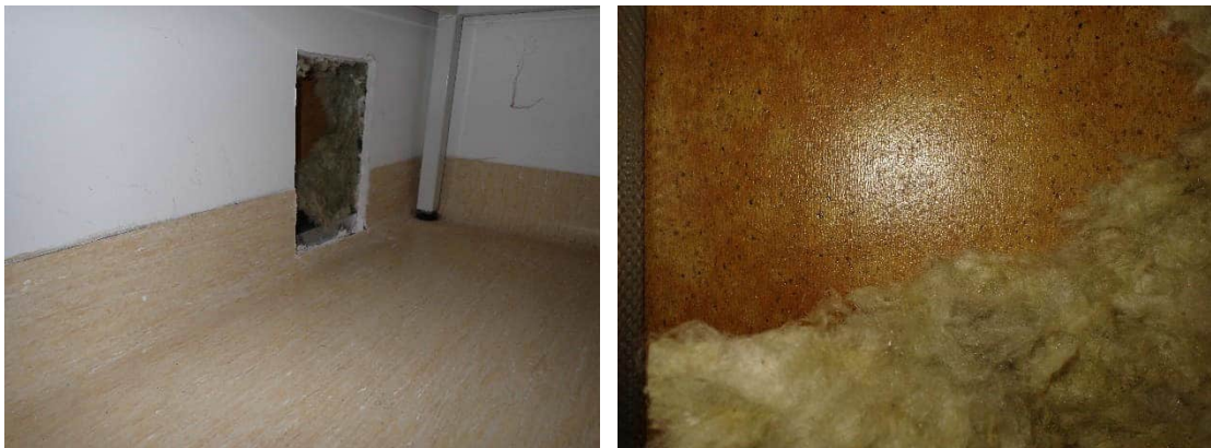
Kuvat 426 ja 427. Pukuhuoneen A004 väliseinän avaus R5. Suihkutilanpuoleinen levy oli märkätalalevyä.
