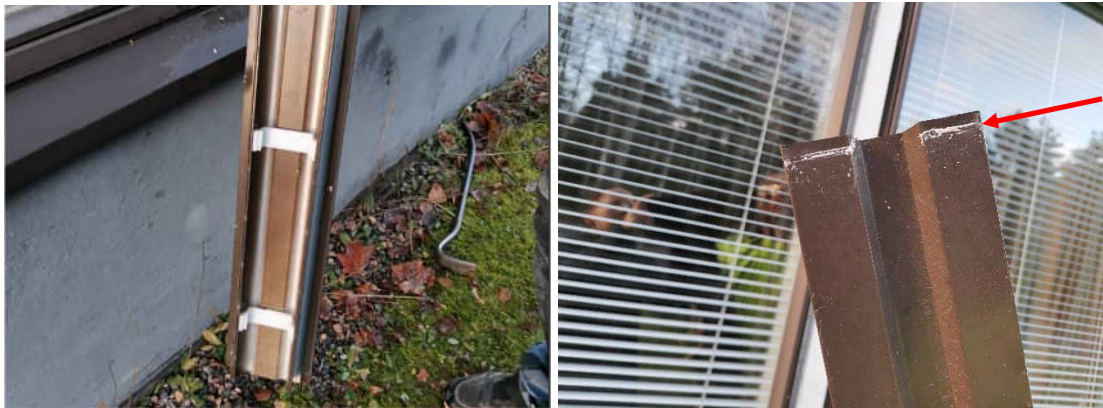
Kuvat 328 ja 329. Ikkunoiden ulkopuolen peitelista on kiinnitetty muovisilla kiinnikkeillä. Yläreunasta lista menee hieman julkisivun ulkokuoren taakse (nuoli). Kuvat ovat avauksesta R77.
