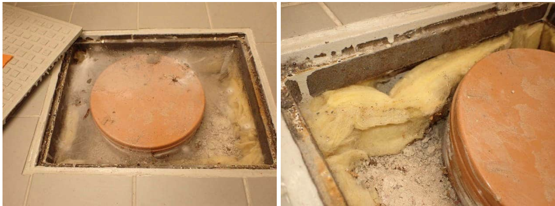
Kuvat 123 ja 124. Musiikkiluokan varaston A042 viemärintarkastusluukun avaus R12.
