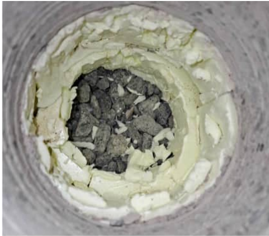
Kuva 114. Pukuhuonetilojen A004 ja A008 alapohjat on uusittu ja XPS-lämmöneriste on sijoitettu uuden betonilaatan alle. Kuva tilan A008 avauksesta R2.
