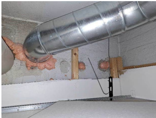
Kuva 450. Auditorion D021 väliseinien läpiviennit on tilkitty uretaanivaahdolla. Kuvat ovat avauksesta R56.
