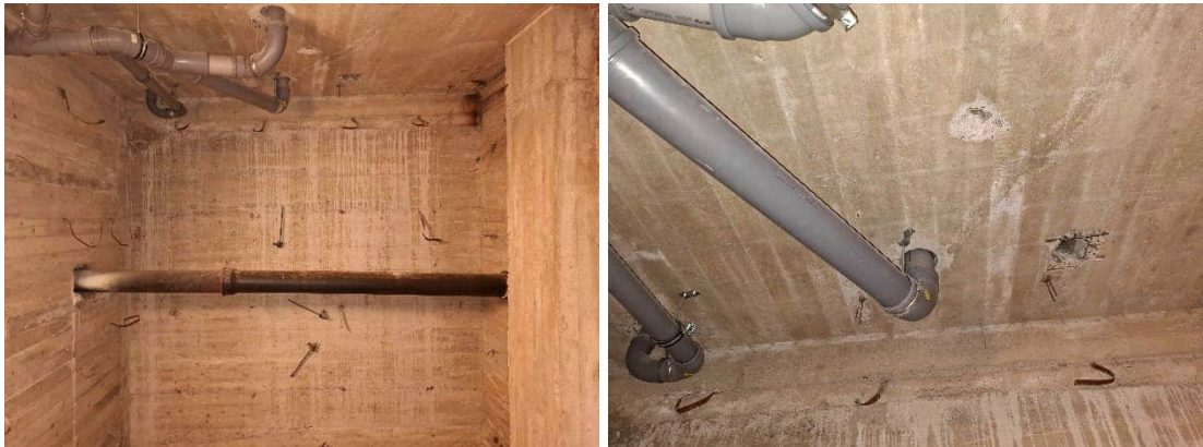
Kuvat 53 ja 54. Tilassa on viemäreitä ja sähköjohtoja. Näiden läpivientejä oli katossa ja käytävän väliseinässä.
