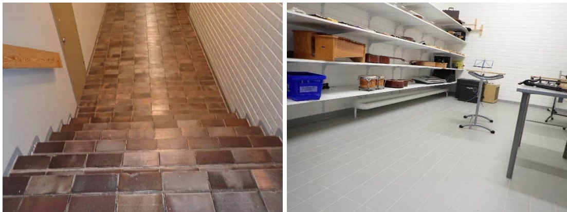
Kuvat 78 ja 79. Kupittaa Saven vanhaa keraamista laattaa käytävällä A025 ja uudempaa keraamista laattaa musiikkiluokan varastossa A042.
