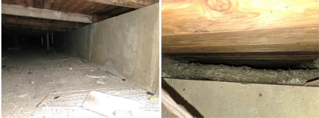
Kuvat 528 ja 529. B-osan yläpohjatilan keskilinjalla on talotekniikkakotelo, joka on eristetty mineraalivillalla ja rajattu kuitusementtilevyillä.
