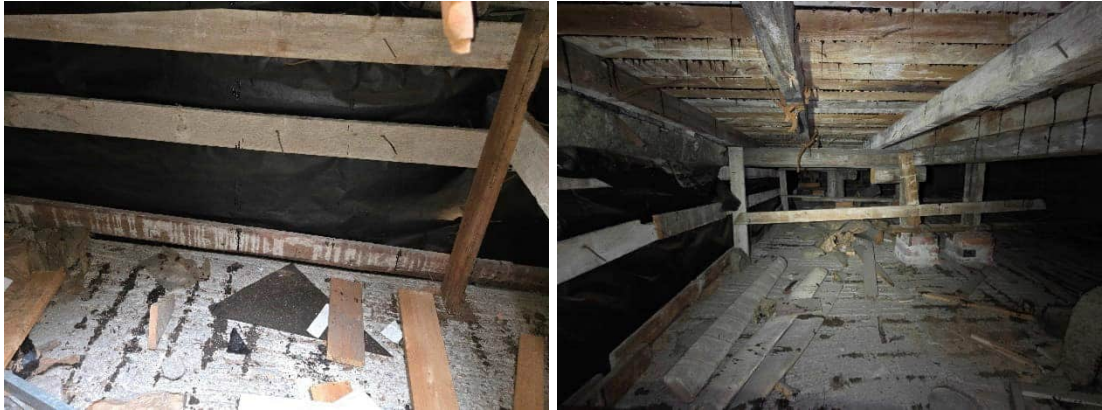
Kuvat 515 ja 516. Lounaispäädyn yläpohjatila on rajattu muusta tilasta harvalaudoituksella, tuulensuojapaperilla ja mineraalivillalla.
