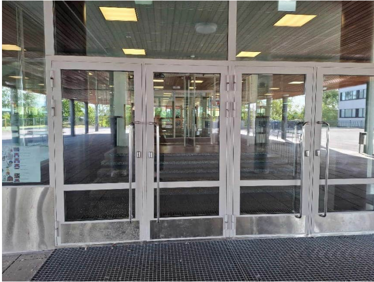
Kuva 398. Pääsisäänkäynnin vuonna 2016 uusitut ulko-ovet.
