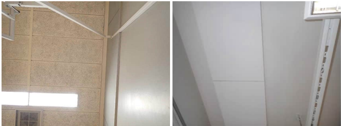
Kuvat 544 ja 545. Liikuntasalin A115 katossa on lastuvillalevyä ja B-osan 3. kerroksen luokissa paikoin maalattua betonia, johon on liimattu mineraalivillaiset akustiikkalevyt.
