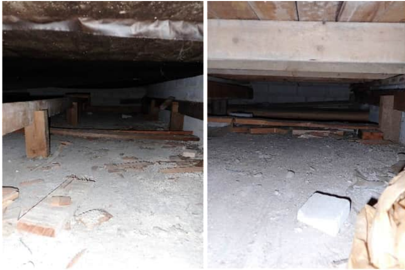
Kuvat 209 ja 210. D-osan väestönsuojien yläpuolelle välipohjiin tehdyt avaukset R47 ja R48. Rakenteissa on paikoitellen muottilautoja ja laatan alla tervapaperia.
