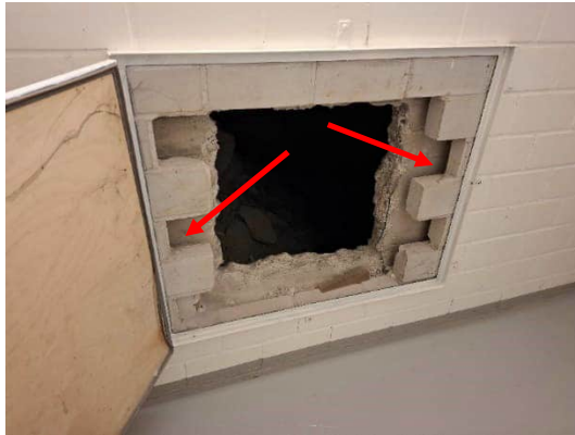
Kuva 138. A-osan alustatilan luukun kohdalta on ilmayhteys alustasta tiilikuorimuurauksen ja betoniseinän väliin.
