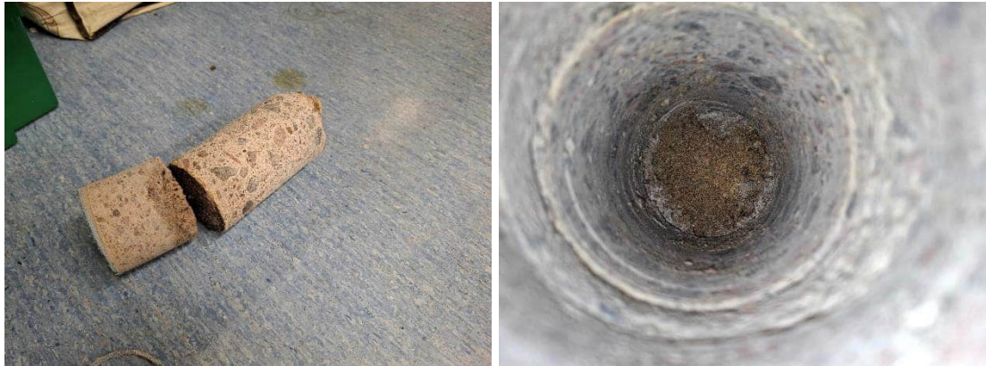
Kuvat 119 ja 120. Luokan C101 lämmöneristämättömän alapohjan avaus R58.
