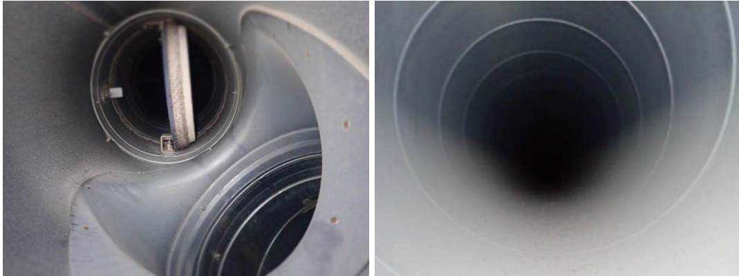
Kuvat 705 ja 706. Yleiskuvat poistoilmakanavien sisäpuolelta. Vasen kuva on D-osan poistoilman kokoojakanavasta ja oikean puolen kuva B-osalta poistoilmalaitteen kokoojakanavasta. Kanavissa oli hieman likaa.
