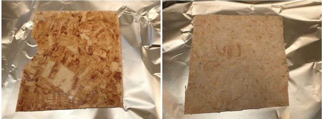
Kuvat 195 ja 196. BULK1 käytävän D123 vertailunäyte ja BULK2 käytävän D123 auringon vioittamasta kohdasta otettu näyte (vaalean ruskea muovimatto).
