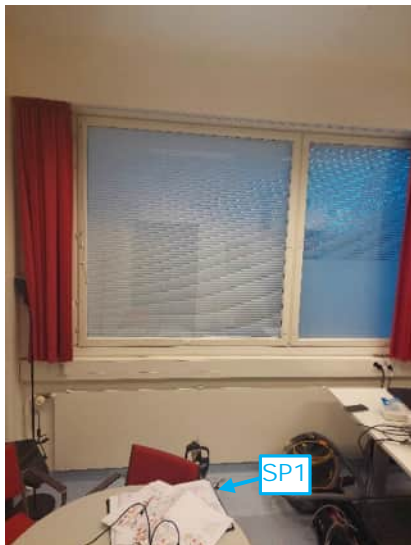
Kuva 156. Työhuoneen A102 merkkiainekokeessa MA11 ei todettu ilmavuotoja alapohjan eristetilasta. Merkkiainekaasun syöttöpisteet (SP) on merkitty sinisellä nuolella.
