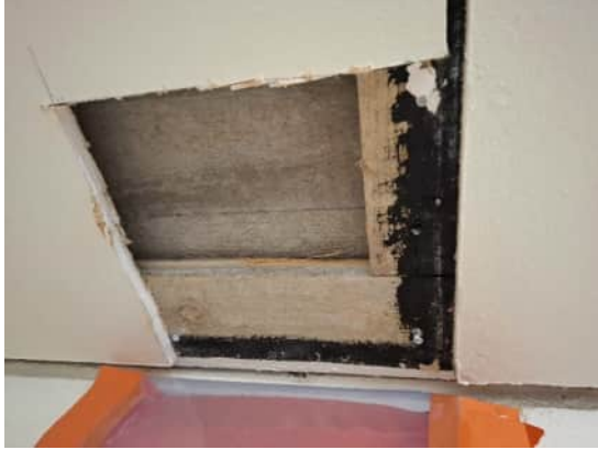
Kuva 233. Keittiön B215 kipsilevyalakaton avaus R70. Avauksessa ei havaittu viitteitä kosteudesta.
