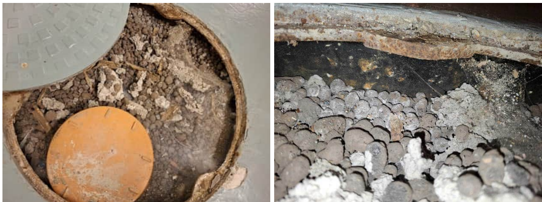
Kuvat 129 ja 130. Käytävän B006 alapohjassa olevan luukun avaus R80. Peltisen luukun takaa havaittiin ilmavirtausta käytävän suuntaan.
