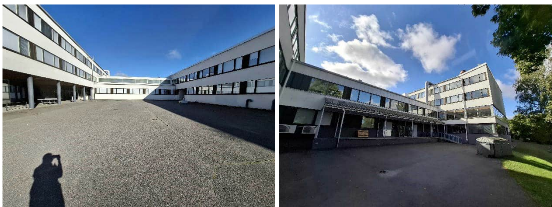
Kuvat 262 ja 263. Julkisivut ovat pääosin rapattuja. Välituntipihaan puolella ikkunoiden alla ensimmäisessä kerroksessa on ruiskubetonointi. Ikkunoiden välissä on levytyksiä.
