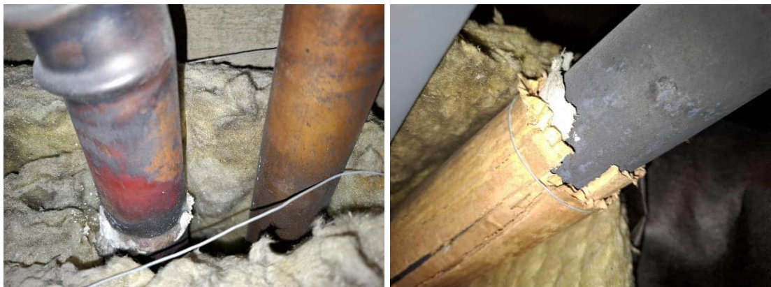
Kuvat 74 ja 75. Läpivienneissä oli mineraalivillaa, niiden kohdalla ei havaittu tarkastetuilta osin ilmavirtausta merkkisavulla. Tilan putkissa havaittiin asbestipitoista eristettä.
