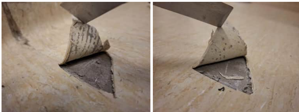
Kuvat 94 ja 95. Teknisetilan A007 ja pukuhuoneen A008 viiltomittaukset V5 ja V6.
