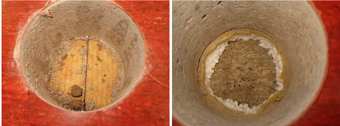
Kuvat 117 ja 118. Kuvat kuvaamataidon luokan B013 alapohjan avauksista R21 ja R22.
