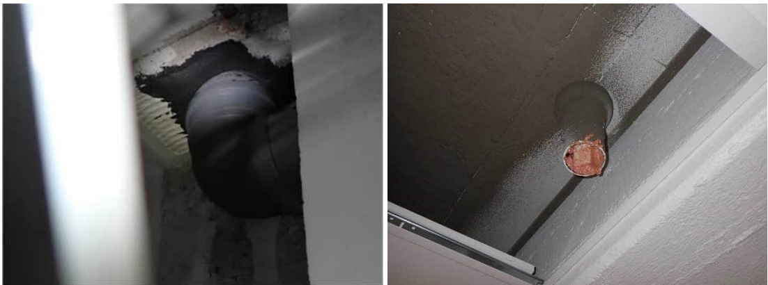
Kuvat 567 ja 568. Luokan D206 avauksessa R98 oli uusitun viemäri­n yläpohjaläpivienti, liittymä vaikutti aistinvaraisesti tiiviiltä. Luokan D213 avauksessa R63 oli vanha katkaistu viemäri, joka oli tukittu uretaanilevyllä ja uretaanivaahdolla.
