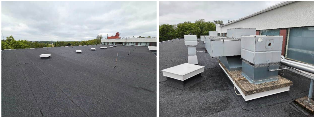
Kuvat 474 ja 475. A-osan katoilla oli runsaasti yläpohjan tarkastusluukkuja ja IV-laitteita.
