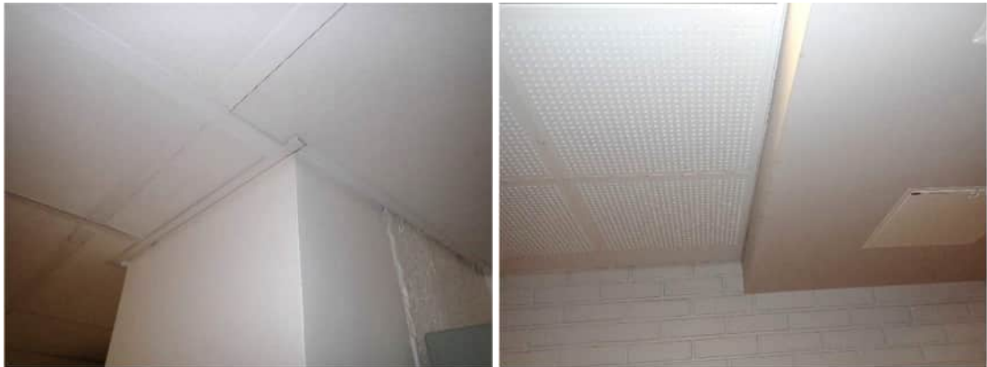
Kuvat 542 ja 543. Alakatot ovat yleisimmin avattavaa akustiikkalevyä, pääosin mineraalivillaa ja osin kipsilevyä.
