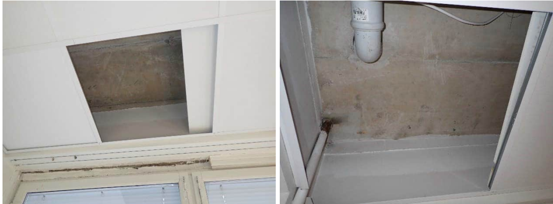
Kuvat 229 ja 230. Luokan B226 alakaton avaukset R84 ja R85. Alakattojen takana ei ollut viitteitä kosteudesta. Avauksessa R85 läpivientien alapinnat olivat epätiivittä.
