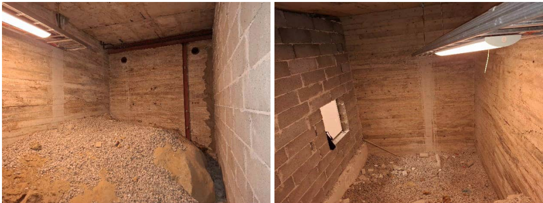
Kuvat 57 ja 58. Alustan B014 pohjalla on kalliota ja sepelitäyttö. Käytävän seinä on kevytsoraharkkoa, jonka alareunassa on betonisokkeli, kermi ja EPS-eriste.
