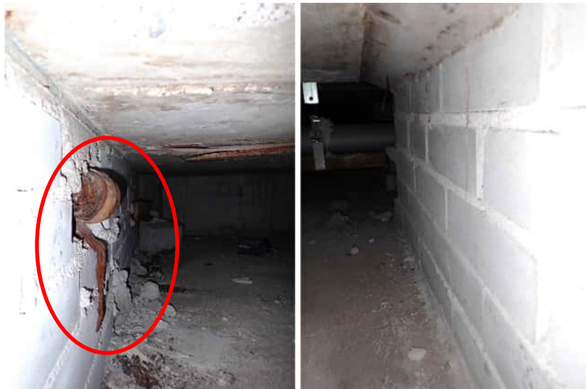
Kuvat 207 ja 208. A-osan väestönsuojan yläpuolelle välipohjaan tehty avaus R60. Ilmatilassa oli todennäköisesti vanha valurautaviemäri (soikio) ja etäämmällä uusi muoviviemäri.
