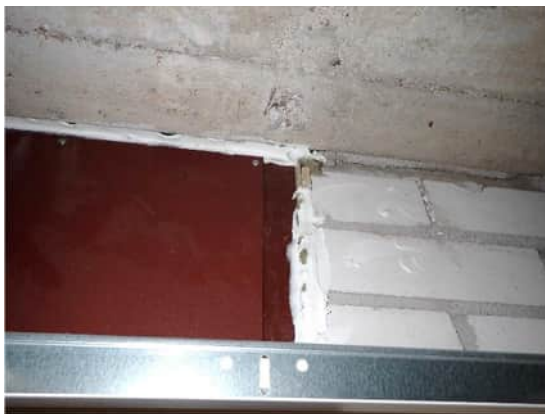
Kuva 453. Luokan B221 alakaton avauksesta R69 havaittiin, että väliovien ja väliseinien välissä on tilkkeenä mineraalivillaa, jonka pinta on ainakin osin massattu.
