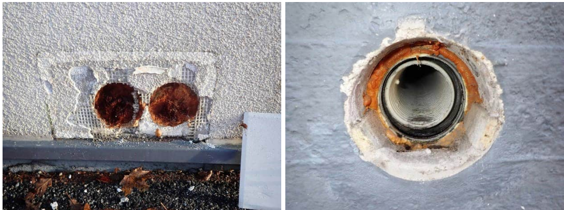
Kuvat 321 ja 322. A-osan avauksen R72 uretaanivaahdolla tukitut vanhat läpiviennit ja avauksen R73 seinän sisällä olevat viemäriputket.
