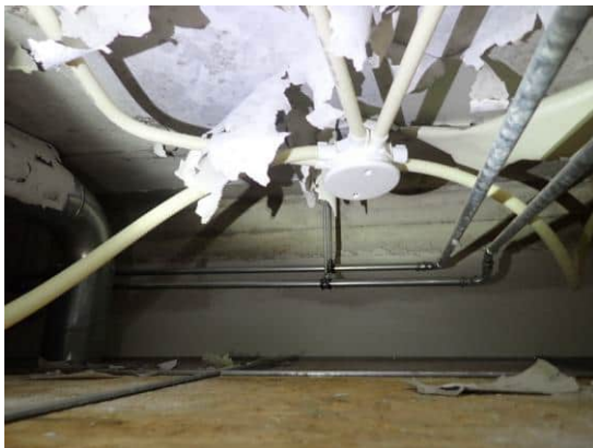
Kuvat 13 ja 14. B-osan keittiön kylmiöiden alapuolella välipohjarakenteen alapinnassa oli silmin havaittavia maali- ja tasoitepintojen vaurioita sekä mikrobikasvustoa. Välipohjarakenteessa ei todennäköisesti ole lämmöneristettä tai se on puutteellinen.
