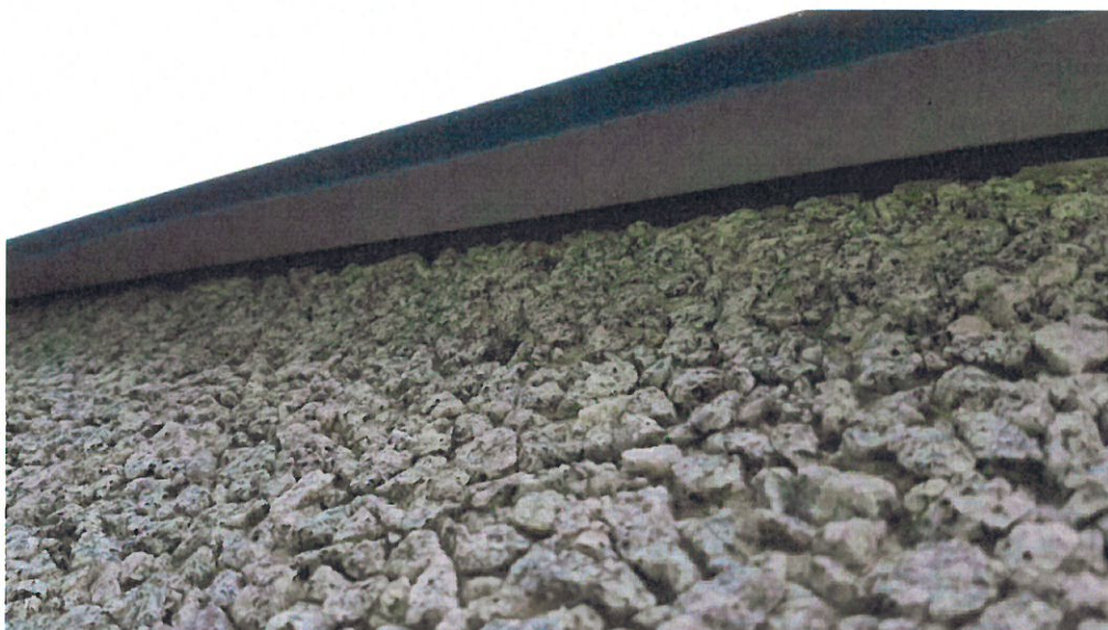
2. Räystäällä ei havaittu myrskypeltiä.
