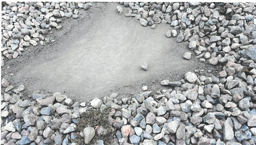
3. Kermin pinnassa ei havaittu hapertumista tai murtumista.
