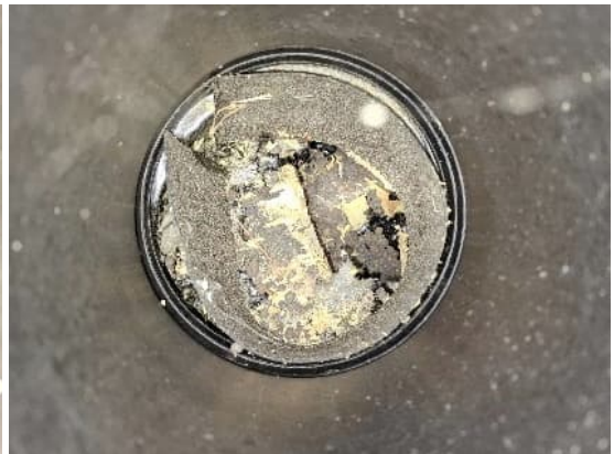
Kuvat 124 ja 125. Alipainetuulettimien kohdalla kermikatetta oli aukotettu vaihtelevasti ja yläpohjassa oli näkyvillä mineraalivillaa, leca-soraa ja puuta.
