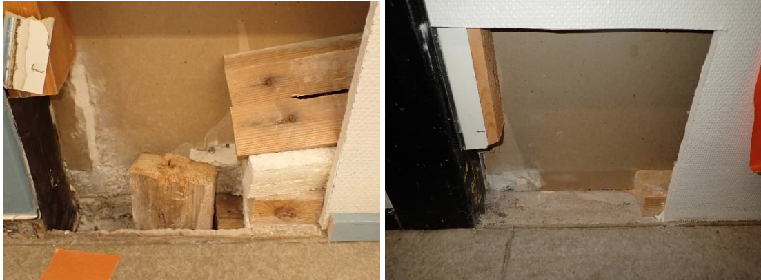
Kuvat 95 ja 96. Vasemmanpuoleisessa kuvassa monitoimitilan C25 avaus R20, jossa väliseinän alajuoksu sijaitsee alapohjan sisällä. Oikeanpuoleisessa kuvassa ryhmähuoneen A06 avaus R5, jossa alajuoksu on alapohjan päällä.
