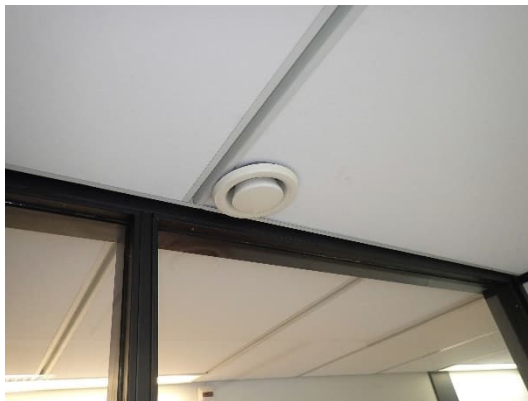
Kuvat 171 ja 172. Yleiskuva alkuperäisestä poistoilmaventtiilistä ja sen kytchentäkanavasta. Kanava on hieman pölyinen. Alkuperäisen kanaviston osalta havaittiin, että kulmaosia oli tehty mekaanisin taitoksia ("rypyttämällä").
