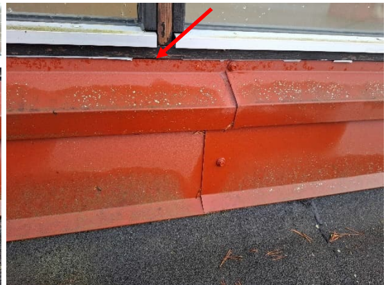
Kuvat 128 ja 129. Kattolyhytön pellitysten liittymien viimeistelyssä on huolimattomuutta ja puutteita. Ikkunoiden alla on rako pellin ja karmien välissä. Rakoa on massattu, mutta massaukset ovat irtoilleet (nuoli).
