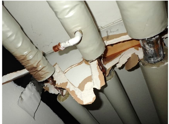
Kuvat 142 ja 143. Ryhmätilan C19 alakaton avaus R14. Palkin ja yläpohjan liittymästä ei todettu ilmavirtausta (ylempi nuoli) ja palkin ja ulkoseinän liittymästä todettiin paikoitellen pientä ilmavirtausta huoneen suuntaan (alempi nuoli). Alakaton taakse oli jätetty hieman purettua väliseinää ja sen kohdalla oli avointa mineraalivillapintaa putkieristeissä.
