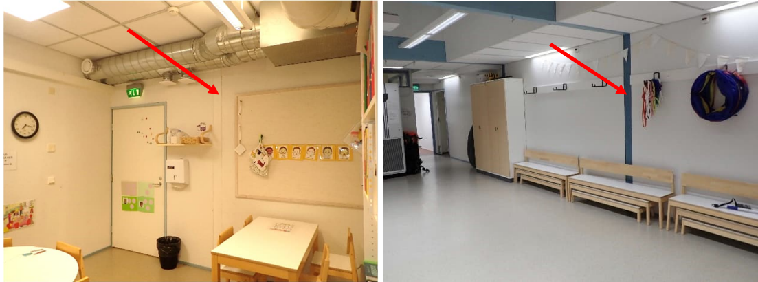
Kuvat 98 ja 99. Liimapuupilarit ovat näkyvillä myös väliseinissä (nuolet).
