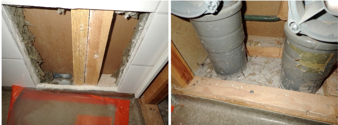
Kuvat 103 ja 104. Wc-tilan C09 väliseinän ja koteloinnin avaus R8. Avauksissa ei havaittu kosteusjälkiä.
