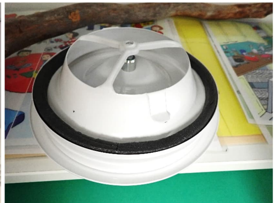
Kuvat 177 ja 178. Yleiskuva B1/B2-osan tuloilmaventtiileistä. Venttiilit olivat puhtaat ja lähes uuden veroisessa kunnossa, mutta niiden avauksen asentoa ei ollut lukittu.
