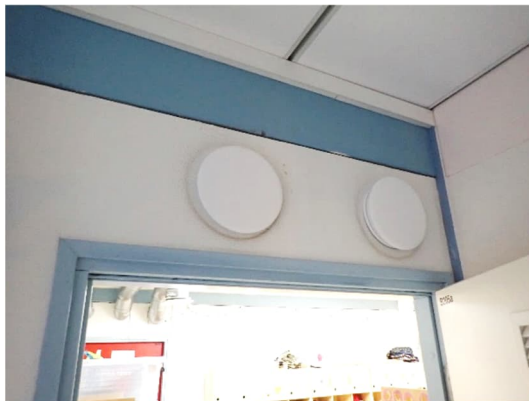
Kuvat 177 ja 178. Yleiskuva B1/B2-osan tuloilmaventtiileistä. Venttiilit olivat puhtaat ja lähes uuden veroisessa kunnossa, mutta niiden avauksen asentoa ei ollut lukittu.
