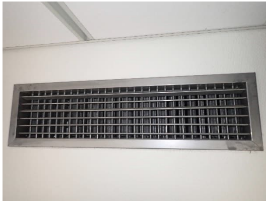
Kuvat 169 ja 170. Yleiskuva alkuperäisestä tuloilmasäleiköstä ja sen kytchentäkanavasta. Kanavassa on käsiautopelti ja sen pohja on hieman pölyinen.
