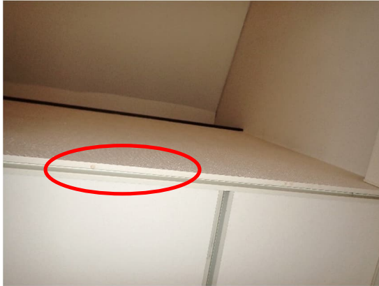
Kuvat 144 ja 145. Monitoimitilan C25 alakaton avaus R33 kattolyhdyn alla. Kattolyhdyn alla seinäkeessä havaittiin pieniä kosteusjälkiä (ympyrä). Alakaton takana ei havaittu jälkiä kosteudesta.
