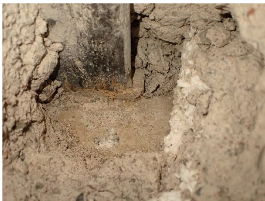
Kuvat 13 ja 14. Alapohjarakenne avauksissa R30 ja R28. Avauksessa R28 alapohjan rakenne vastasi lähtötietoja. Avauksen R30 vasemmalla puolella rakenne vastasi lähtötietoja ja oikealla puolella betoni-laatan paksuus oli 150 mm.
