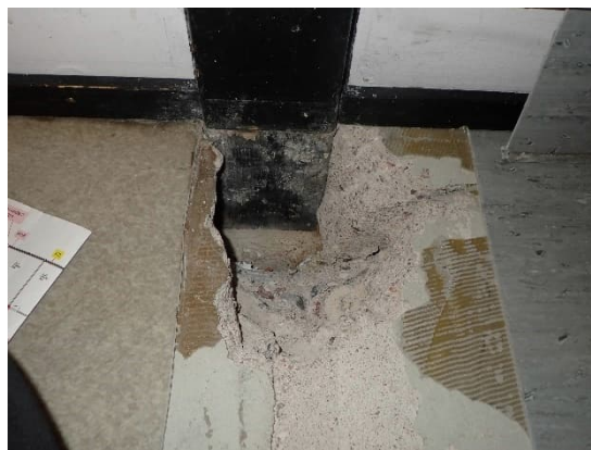
Kuvat 13 ja 14. Alapohjarakenne avauksissa R30 ja R28. Avauksessa R28 alapohjan rakenne vastasi lähtötietoja. Avauksen R30 vasemmalla puolella rakenne vastasi lähtötietoja ja oikealla puolella betoni-laatan paksuus oli 150 mm.
