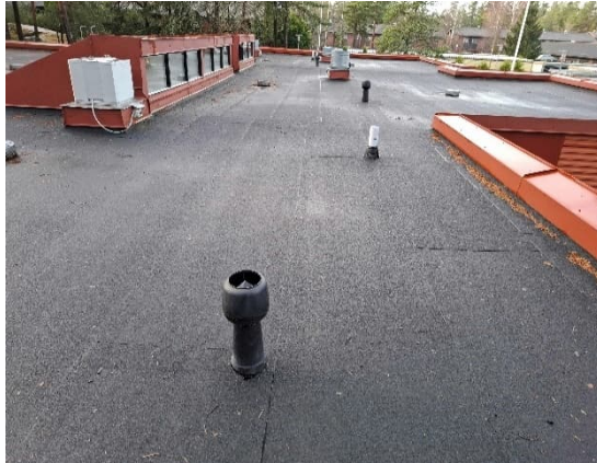
Kuvat 126 ja 127. Vesikatolla on kattolyhyt. Kattolyhytön ikkunat ovat huonossa kunnossa.
