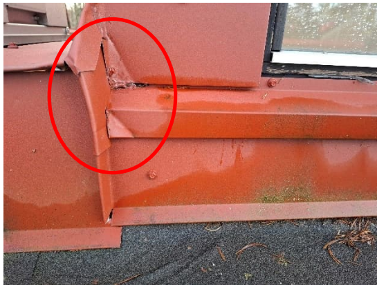
Kuvat 128 ja 129. Kattolyhytön pellitysten liittymien viimeistelyssä on huolimattomuutta ja puutteita. Ikkunoiden alla on rako pellin ja karmien välissä. Rakoa on massattu, mutta massaukset ovat irtoilleet (nuoli).
