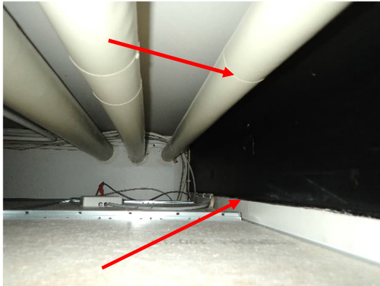
Kuvat 142 ja 143. Ryhmätilan C19 alakaton avaus R14. Palkin ja yläpohjan liittymästä ei todettu ilmavirtausta (ylempi nuoli) ja palkin ja ulkoseinän liittymästä todettiin paikoitellen pientä ilmavirtausta huoneen suuntaan (alempi nuoli). Alakaton taakse oli jätetty hieman purettua väliseinää ja sen kohdalla oli avointa mineraalivillapintaa putkieristeissä.
