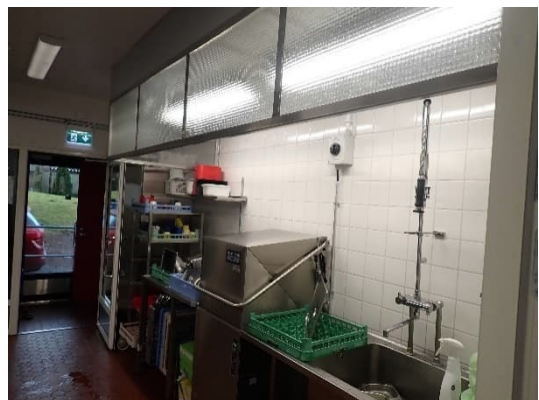
Kuvat 173 ja 174. Yleiskuvia keittiön rasvahuuvasta (vasen) ja kondenssihuuvasta (oikea).
