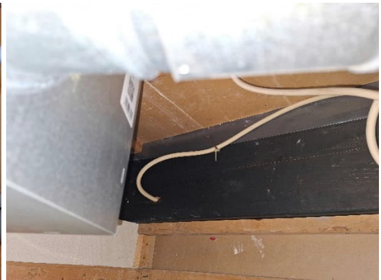
Kuvat 146 ja 147. Väliseinän läpiviennit olivat yleisesti tiivistämättä. Käytävän C18 kohdalla yläpohjan höyrinsulku taittuu yläpohjan palkkia vasten (avaus R32).
