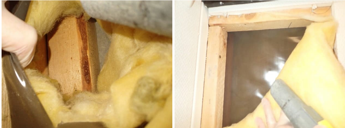
Kuvat 80 ja 81. Ryhmähuoneen B106 ulkoseinän avaus R17 ja ryhmähuoneen B205b avaus R22.
