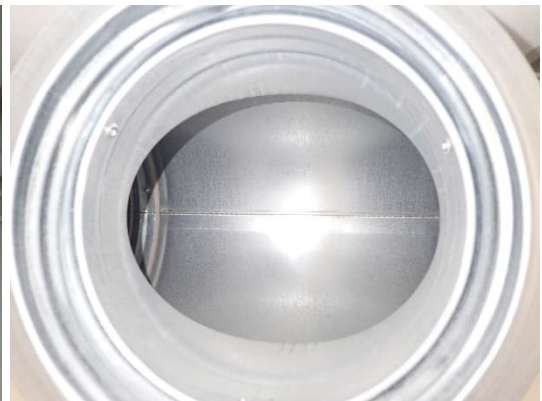
Kuvat 179 ja 180. Yleiskuva B1/B2-osan poistoilmaventtiileistä. Venttiilit olivat puhtaat ja lähes uuden veroisessa kunnossa. Myös poistoilmakanavat olivat siistit ja pölyisyys oli vähäistä.
