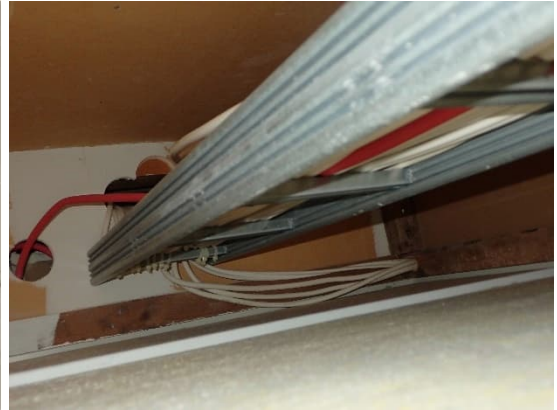
Kuvat 144 ja 145. Monitoimitilan C25 alakaton avaus R33 kattolyhdyn alla. Kattolyhdyn alla seinäkeessä havaittiin pieniä kosteusjälkiä (ympyrä). Alakaton takana ei havaittu jälkiä kosteudesta.
