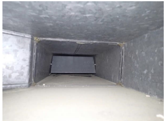
Kuvat 169 ja 170. Yleiskuva alkuperäisestä tuloilmasäleiköstä ja sen kytchentäkanavasta. Kanavassa on käsiautopelti ja sen pohja on hieman pölyinen.
