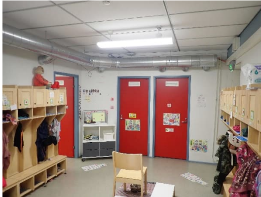
Kuvat 175 ja 176. Yleiskuva pinta-asenteisesta ilmastointikanavasta B1-osalla. Tuloilmakanavat olivat silmämääräisten havaintojen perusteella siistit ja pölyisyys oli vähäistä.
