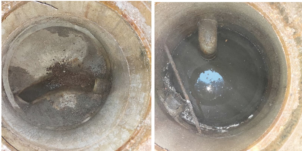
Kuva 189 ja 190. Vasemmalla kuva rakennuksen keittiön edustalla olevasta sadevesikaivosta ja oikealla kuva leikkipihan sadevesien keräyskaivosta.
