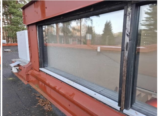
Kuvat 126 ja 127. Vesikatolla on kattolyhyt. Kattolyhytön ikkunat ovat huonossa kunnossa.
