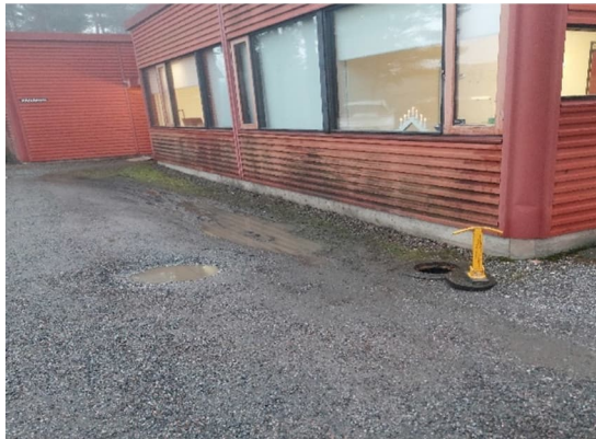
Kuvat 8 ja 9. Länsipäädyssä henkilökunnan taukotilan C05 kohdalla sijaitsevan salaojakaivon vedenpinnan todettiin olevan salaojaputkien yläpuolella.
