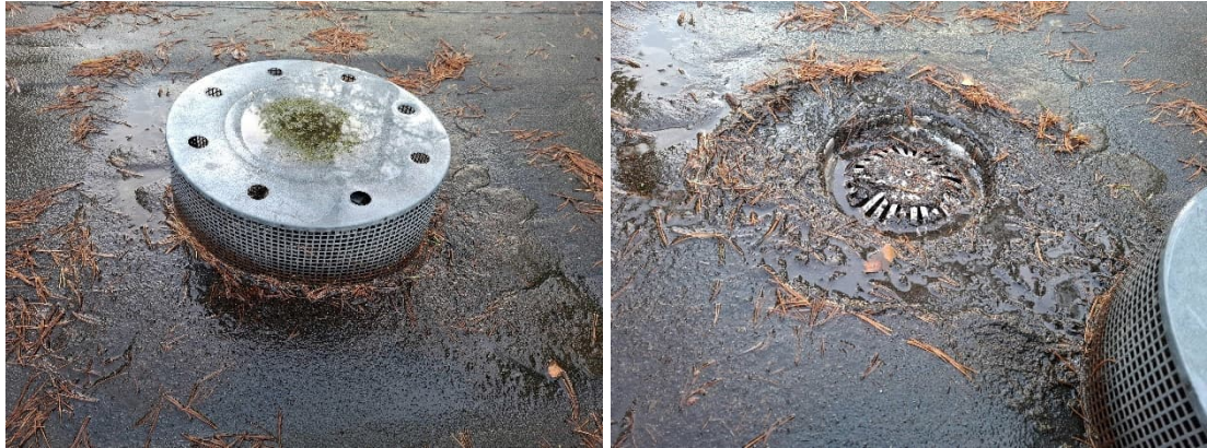
Kuvat 119 ja 120. Kattokaivojen roskasidit olivat irrallisia ja kaivoihin oli kertynyt hieman roskaa.
