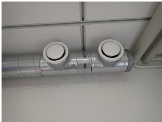
Kuvat 179 ja 180. Yleiskuva B1/B2-osan poistoilmaventtiileistä. Venttiilit olivat puhtaat ja lähes uuden veroisessa kunnossa. Myös poistoilmakanavat olivat siistit ja pölyisyys oli vähäistä.
