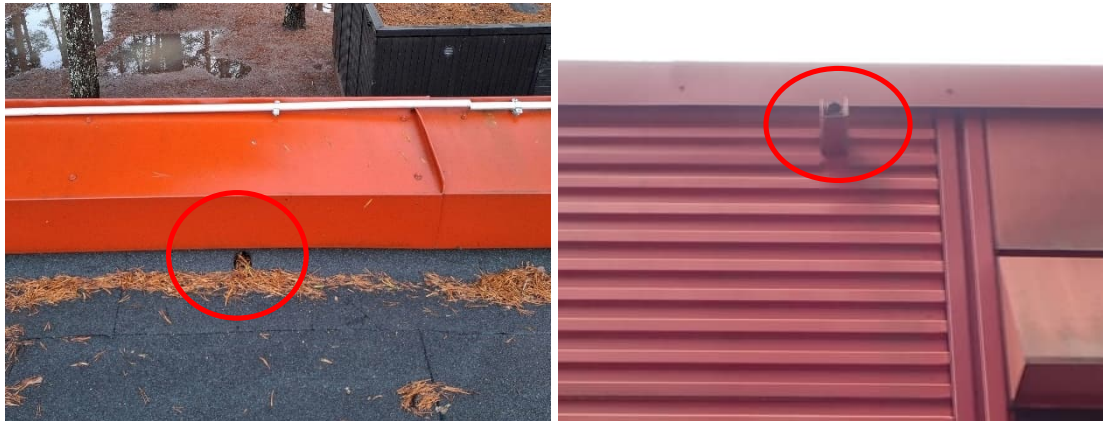
Kuvat 121 ja 122. Räystäällä on tulvatilanteiden varalle ulosheittäjät. Ulosheittäjiin oli kertynyt jonkun verran neulasia.
