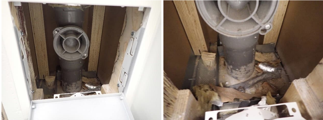
Kuvat 41 ja 42. Ryhmätilan C19 koteloinnin avauksessa R31 todettiin alapohjan läpiviennin olevan tiivis merkisavulla tarkastettuna.
