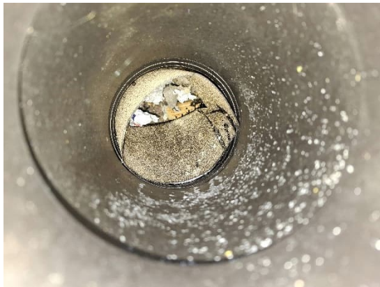
Kuvat 124 ja 125. Alipainetuulettimien kohdalla kermikatetta oli aukotettu vaihtelevasti ja yläpohjassa oli näkyvillä mineraalivillaa, leca-soraa ja puuta.
