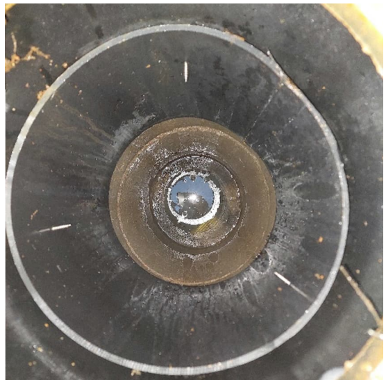
Kuvat 8 ja 9. Länsipäädyssä henkilökunnan taukotilan C05 kohdalla sijaitsevan salaojakaivon vedenpinnan todettiin olevan salaojaputkien yläpuolella.
