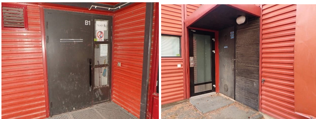
Kuvat 92 ja 93. Alkuperäisten ulko-ovien maalipinnat ovat hieman kuluneet. Uusitut ovet ovat hyväkuntoisia (oikeanpuoleisessa kuvassa tilan C19 ulko-ovi).
