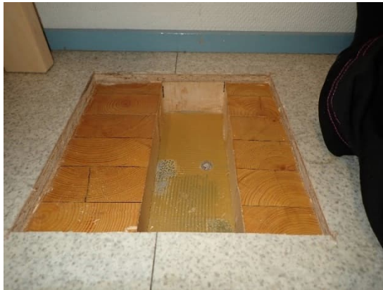
Kuva 36. Toimistohuoneen C24 lattian avaus R15. Muovimaton alla oli lastulevy ja vanha puulattia, jonka alla betonia.
