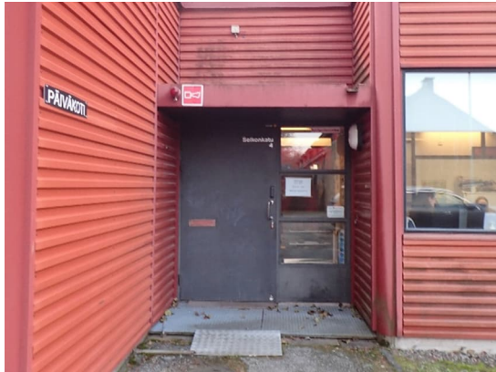
Kuvat 6 ja 7. Katosten vedet on johdettu alas ulosheittäjillä.
