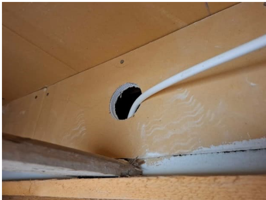
Kuvat 146 ja 147. Väliseinän läpiviennit olivat yleisesti tiivistämättä. Käytävän C18 kohdalla yläpohjan höyrinsulku taittuu yläpohjan palkkia vasten (avaus R32).
