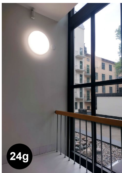
Bild 24g En bra lösning: ljuskällan gömd i armaturen så att den inte orsakar störande bländning. (Universitetsgatan 27, Åbo)
