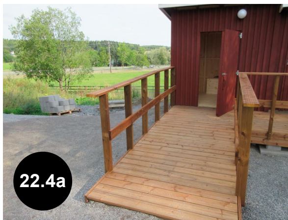
Bild 22.4a En bra lösning: Den tillgängliga toaletten har en bred och flack ramp samt en bred dörr utan tröskel. Dåligt: Ledstänger på båda sidor saknas vid rampen. (Kurala bybacke, Åbo)
