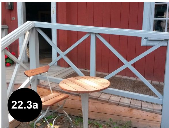
Bild 22.3a Entrén har en ramp. (Apoteksmuseet, Åbo). Rampen saknar ledstänger på båda sidor.
