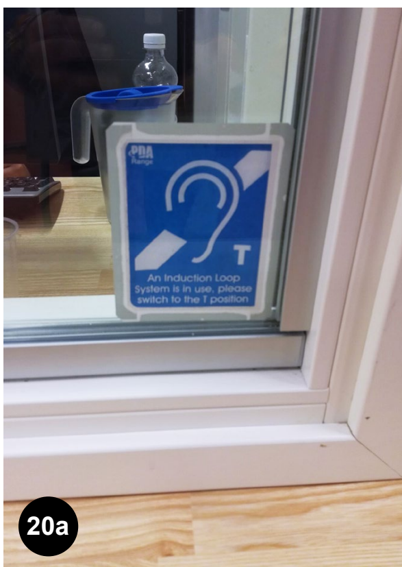
Bild 20a En bra lösning: Servicepunkten har en induktionsslinga (slinga i serviceutrymmen) och detta meddelas med en symbol enligt SFS-EN 60118-4. (Rådgivningen om utkomststöd, Åbo stad, Åbo)
