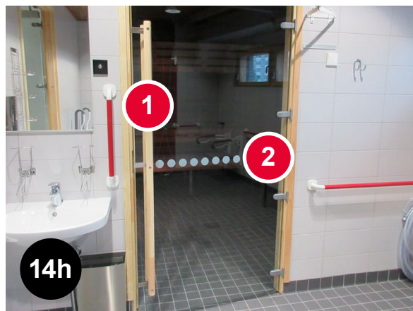
Bild 14h En bra lösning: Bastudörren har [1] ett trähandtag och [2] en kontrastmarkering. (Kulkurin Valssi KOY, Åbo)
