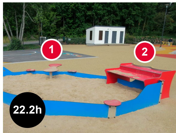
Bild 22.2h En bra lösning: [1] Sandlådan har en magbräda på vilken barnet kan ligga och nå sanden. [2] Man kommer fram till sandbordet med rullstol. (Uittamo tillgängliga lekplats, Åbo)
