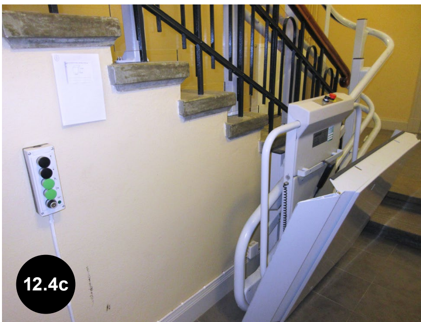
Bild 12.4c Trapphissarna är ofta svåra att använda och ur funktion. Användning av dem rekommenderas inte. (Topeliuksen koulu, Packaregatans enhet, Åbo)
