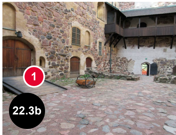
Bild 22.3b [1] Den tillgängliga entrén har byggts separat, eftersom det var omöjligt att göra huvudentrén tillgänglig. (Åbo slott, Åbo)
