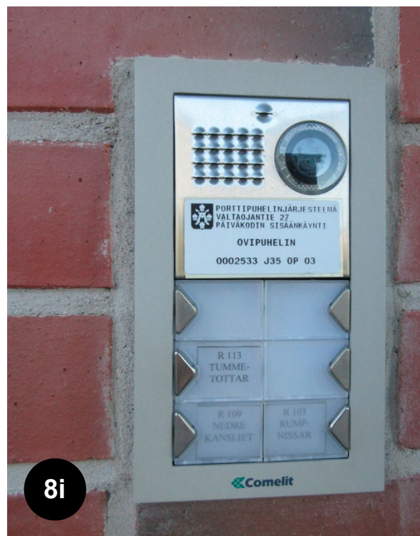
Bild 8i En bra lösning: Dörrtelefonen har en ljussignal. (Braheskolan, Åbo) Texterna/skyltarna är dock för små och otydliga med tanke på tillgänglig användning.
