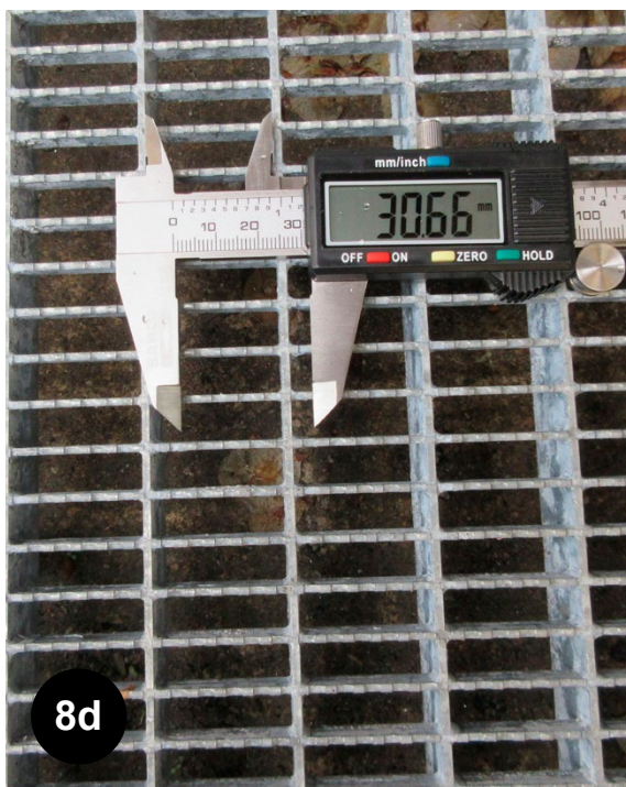
Bild 8d En bra lösning: Gallrets hål är 30 mm långt. (Åbo finska samskola, Åbo). Godtagbar och rekommenderad storlek på gallret är också 11 mm x 33 mm eller 17 x 75 mm.
