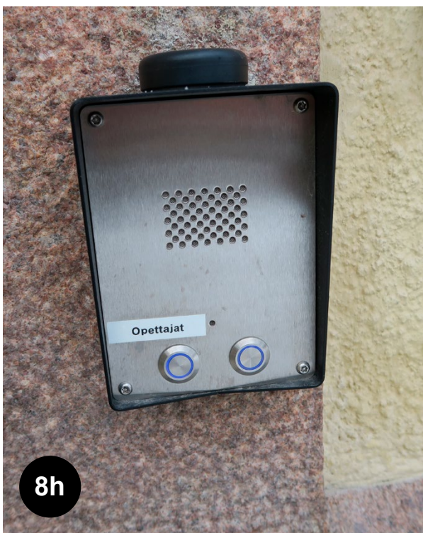
Bild 8h En bra lösning: Dörrtelefonens knappar är belysta. (Puolalan koulu, Åbo). Informationstexten är dock för liten.
