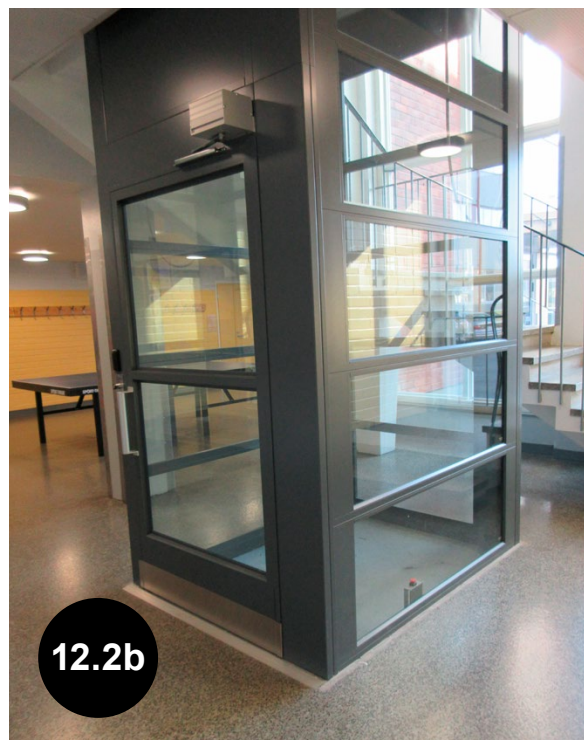
Bild 12.2b Lätthiss (Puopellon koulu, Smedsgatan 11, Åbo)
