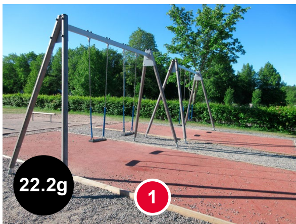
Bild 22.2g En bra lösning: [1] Under gungorna finns ett säkerhetsunderlag som avgränsar området med färg- och känselkontrast (underlaget är förhöjt och underlagets material avviker från sin omgivning). (Pansion koulu, Åbo)
