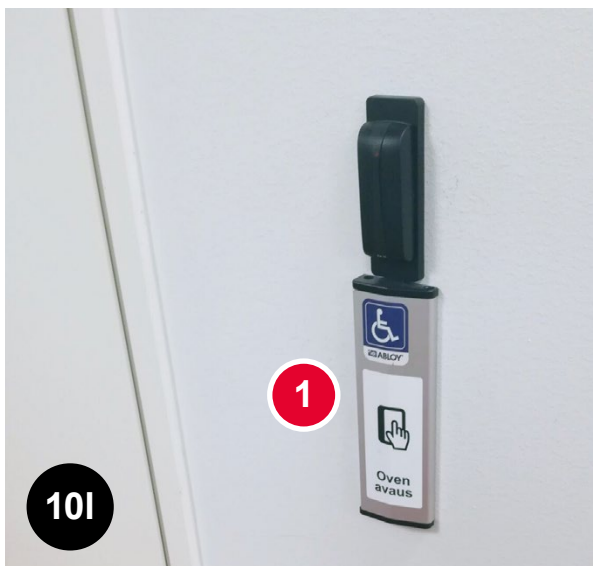
Bild 10l En bra lösning: [1] Dörröppningsanordningarna är lätta att upptäcka och de är grupperade så att man inte behöver förflytta sig mellan dem. (Rådgivningen om utkomststöd, Åbo).
