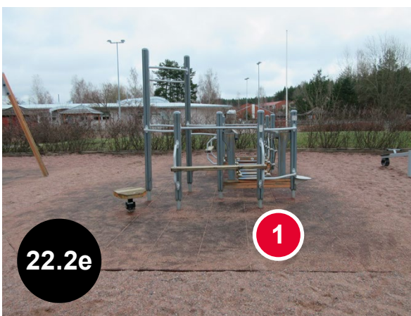
Bild 22.2e En bra lösning: [1] Det finns ett säkerhetsunderlag under klätterställningen. (Nummenpakan koulu, Hallis enhet, Åbo)
