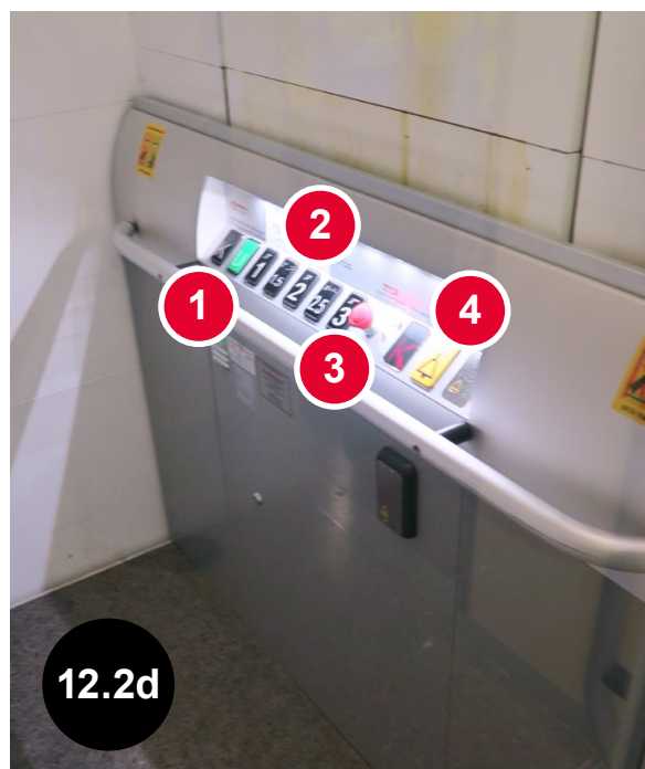
Bild 12.2d En bra lösning: [1] Knappen till entréväningen urskiljs tydligt från de övriga knapparna. [2] Knapparna har relieffigurer och punktskrift som man kan känna. [3] Nödstoppsknappen och [4] larmknappen urskiljs väl. (Puolala skola, Trädgårdsgatans enhet, Åbo)
