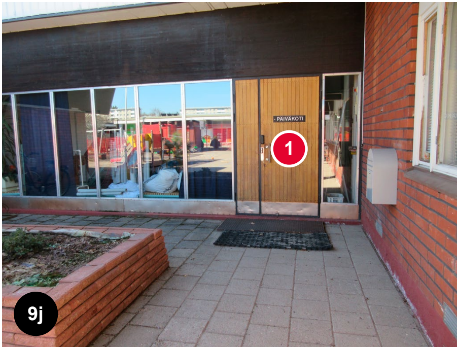
Bild 9j En bra lösning: [1] Entrén urskiljs väl från resten av fasaden. (Dagvårdsenheten i Ilpois, Åbo)
