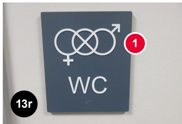
Bild 13r Ett bra exempel: Toaletten är märkt med en skylt som har stora kontraster och bilder och innehåller även punktskrift. (Åbo finska samskola, Åbo)
