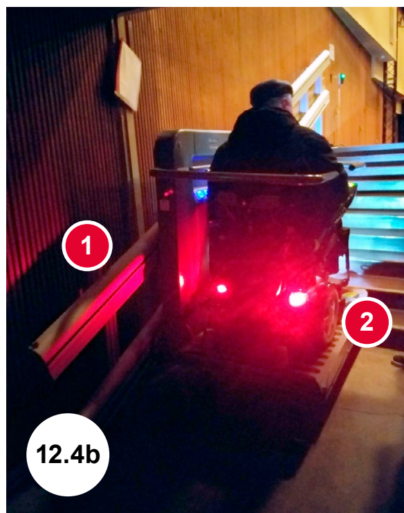
Bild 12.4b En dålig lösning: [1] Trapphissen är inte fäst direkt vid väggen utan på egna stolpar. Detta förhindrar att lyftanordningen fungerar med hela sin kapacitet: stolparna böjer sig och [2] trapphissen fastnar i trapporna och man kommer inte bort från hissen ens tillbaka nedåt. (Biografen Domino, Åbo)
