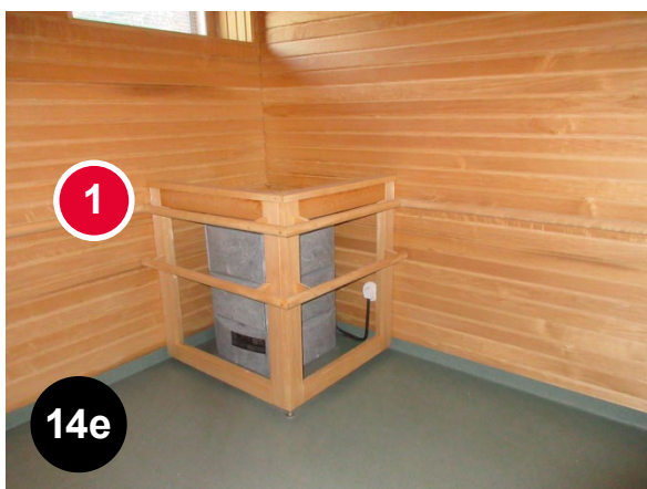
Bild 14e En bra lösning: [1] Bastuugnen är skyddad i hela sin höjd. (Kaskenlinna sjukhus, Åbo)
