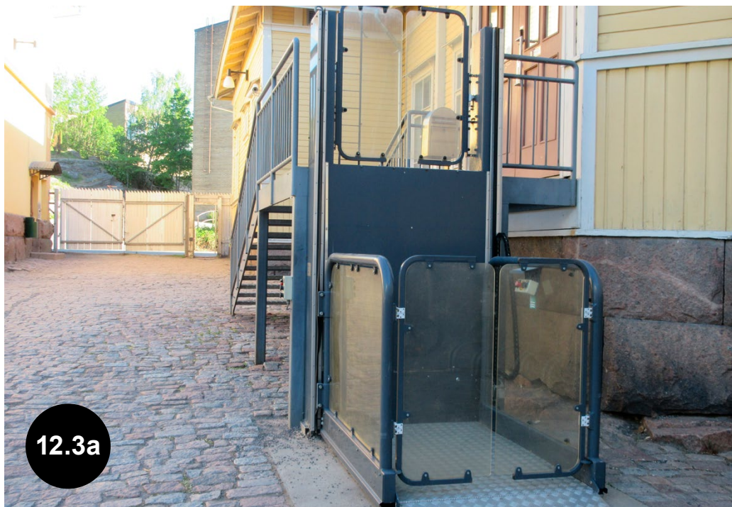
Bild 12.3a Lyftplattform (Topeliuksen koulu, Packaregatans enhet, Åbo)
