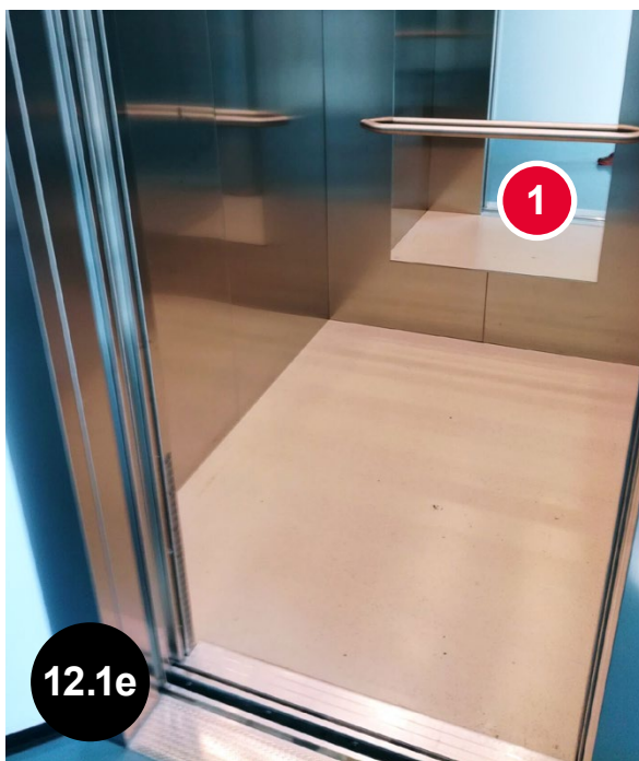
Bild 12.1e En bra lösning: [1] En spegel på hisskorgens bakre vägg gör det lättare för rullstolsanvändare att lämna hissen i en situation där hissen inte är genomgående. (Rådgivningen om utkomststöd, Åbo stad, Åbo)
