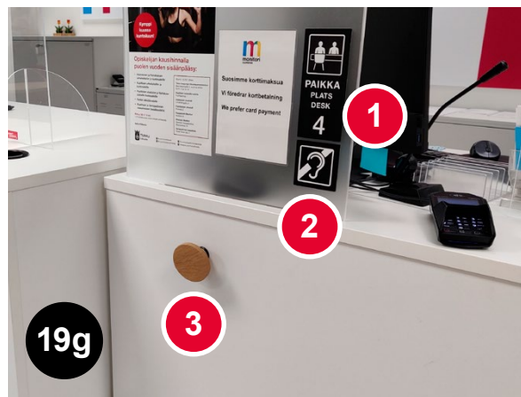
Bild 19g Hyvä ratkaisu: Palvelupisteen paikanumero ilmoitetaan myös palvelupisteen yhteydessä [1]. Palvelupisteessä on induktiosilmukka, ja siitä ilmoitetaan SFS-EN 60118-4 mukaisella symbolilla [2]. Palvelupiste on varustettu vaatekoukulla [3]. (Kauppatorin Monitori, Turun kaupunki, Turku)
