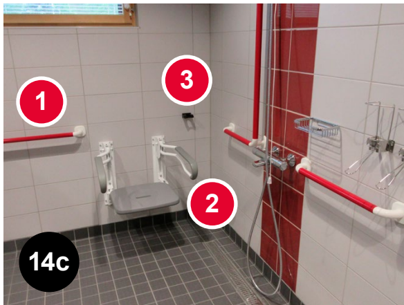
Bild 14c En bra lösning: I tvätttrummet finns [1] stödhandtag, [2] en fällbar sits och armstöd för den. [3] Det finns ett käppställ bredvid sitsen. I tvätttrummet finns också bra kontraster mellan duschen, handtagen, golvet och väggen. (Kulkurin Valssi KOY, Åbo)
