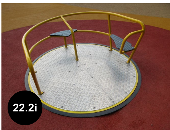
Bild 22.2i En bra lösning: Man kan åka den tillgängliga karusellen även med rullstol. (Uittamo tillgängliga lekplats, Åbo)
