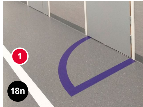
Bild 18n En bra lösning: [1] Det finns en färgkontrastrand i förbindelseleden. (ÅUCS, Åbo)
