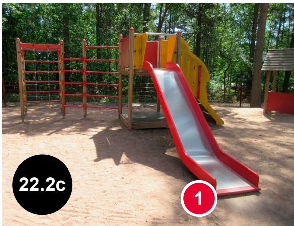
Bild 22.2c En bra lösning: [1] Rutschbanan slutar på mindre än 100 mm höjd över markytan. (Parolanpolun päivähöito, Åbo)
