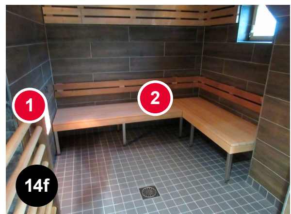
Bild 14f En bra lösning: [1] Bastuugnen är skyddad i hela sin höjd. [2] Bastuns lavar har en sitt höjd på 520 mm. Dessutom finns det gott om utrymme för en rullstol i bastun. (Kulkurin Valssi KOY)
