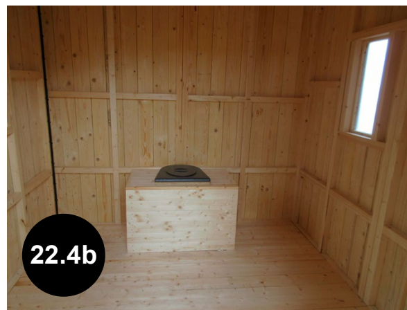
Bild 22.4b En bra lösning: Den tillgängliga utomhustoaletten har en tillräckligt stor vändcirkel och gott om utrymme. Det finns plats för en rullstol på båda sidor av sitsen.
