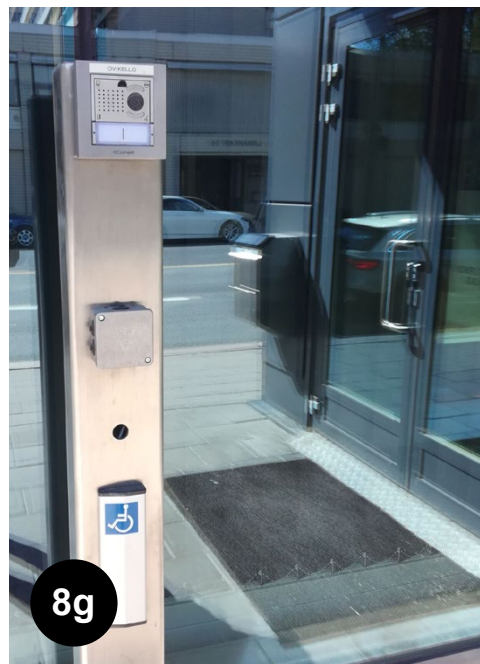
Bild 8g En bra lösning: Dörröppningsanordningarna (både dörrtelefonen och öppningsknappen) är placerade i en grupp, så man behöver inte förflytta sig från en plats till en annan när man använder dem. (Rådgivningen om utkomststöd, Åbo).
