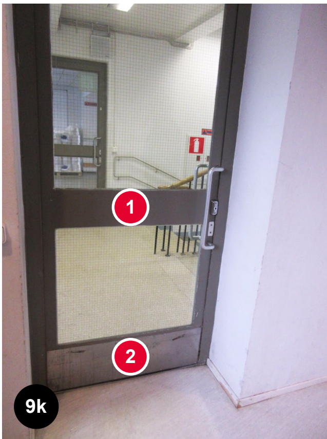
Bild 9k En bra lösning: [1] Dörren har en kontrastmarkering. [2] I dörrens nedre kant finns en över 300 mm hög sparkplåt. (Nummenpakan koulu, Nummis enhet, Åbo)
