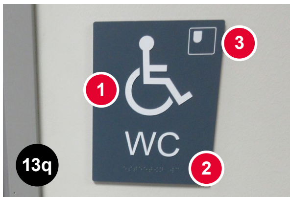
Bild 13q En bra lösning: Den tillgängliga toaletten är märkt med en skylt som har stora kontraster och bilder [1] och som också innehåller [2] punktskrift. [3] Dessutom kan den tillgängliga toaletten endast användas från höger sida, vilket har markerats i övre högra hörnet. [4] Markering för könsneutral toalett. (Åbo finska samskola, Åbo)
