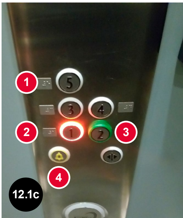
Bild 12.1c En bra lösning: Hissens knappar urskiljs väl från väggen eftersom de har relieffigurer, [1] punktskrift och [2] ljussignal. Relieffigurer som man kan känna är obligatoriska i hissar. Punktskrift utöver dessa rekommenderas starkt. [3] Knappen till entréväningen kan urskiljas från de övriga i höjd och färg. [4] Hissen har en larmknapp som urskiljs tydligt. (Rieskalähdén koulu, Åbo)
