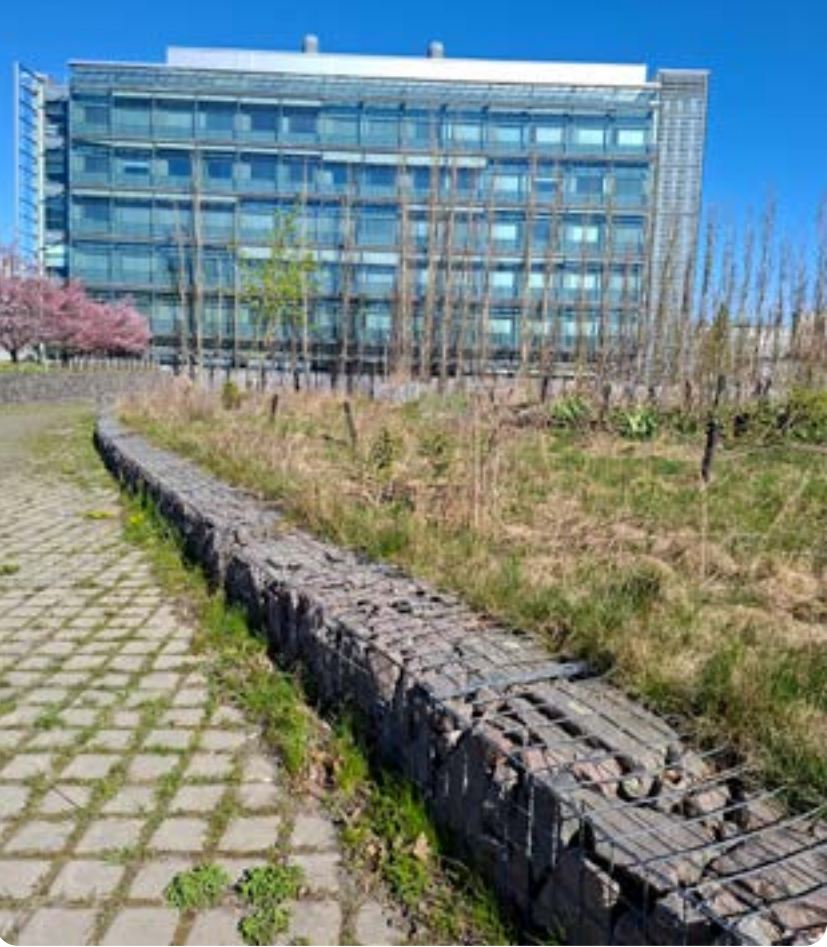
Kivigabionit ovat helppohoitaisia, säänkestäviä ja pitkäikäisiä ratkaisuja. Kuvan kivigabioni sijaitsee Helsingin Viikissä. Kuva: Hilja Kurkinen
