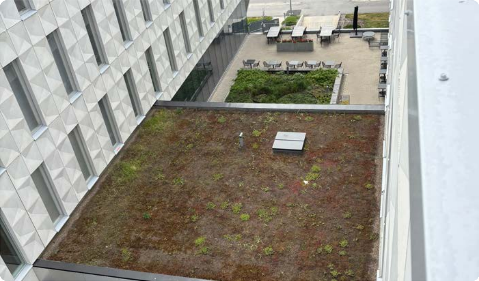
Turun Teknologiakiinteistöt on toteuttanut Infracityn katoilla pienen maksaruohokaton. Kuva: Turku Energia
