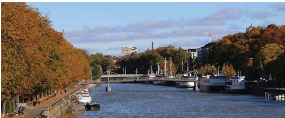
Kuva 6.6. Jokivarren näkymät ovat Turun ikonisia kuvia, ja siksi niihin kohdistuvia muutoksia on aina harkittava tarkoin. Etäälläkin joesta sijaitseva rakennus voi vaikuttaa jokinäkymiin. Esim. 13-kerroksinen U-sairaala näkyy Myllysilältä ja kauempaakin.
