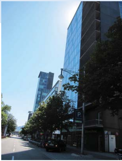
Kuva 4.17. Freiburg im Breisgau, Saksa (220 000 as.). Kaupungissa on jonkin verran uusia ympäristöään korkeampi rakennuksia. Ne on sijoitettu tiiviisti rautatieaseman lähetyville historiallisen keskustan ulkopuolelle.
