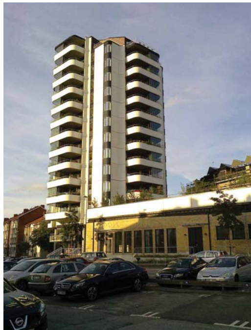
Kuva 3.1. Malmön Augustenborgin kaupungin-osan uudistuksen yhteydessä alueen keskelle on rakennettu uusi, ympäristöään selvästi korkeampi asuinrakennus.
