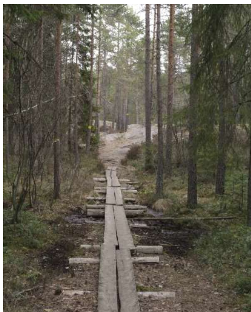
Polkujen kuljettavuutta voidaan parantaa asentamalla pitkospuuta märimpiin maastonkohtiin.
