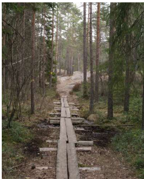
Polkujen kuljettavuutta voidaan parantaa asentamalla pitkospuita märimpiin maastonkohtiin.
